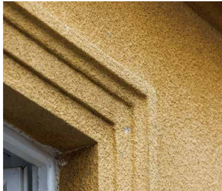
Zapadno pročelje Profilacija prozorskog okvira u visokom prizemlju
