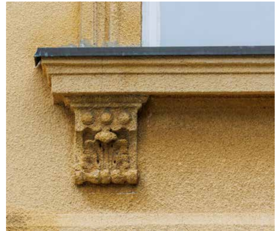
Sjeverno, stražnje pročelje Konzola prozorske klupčice prozora prvog kata
