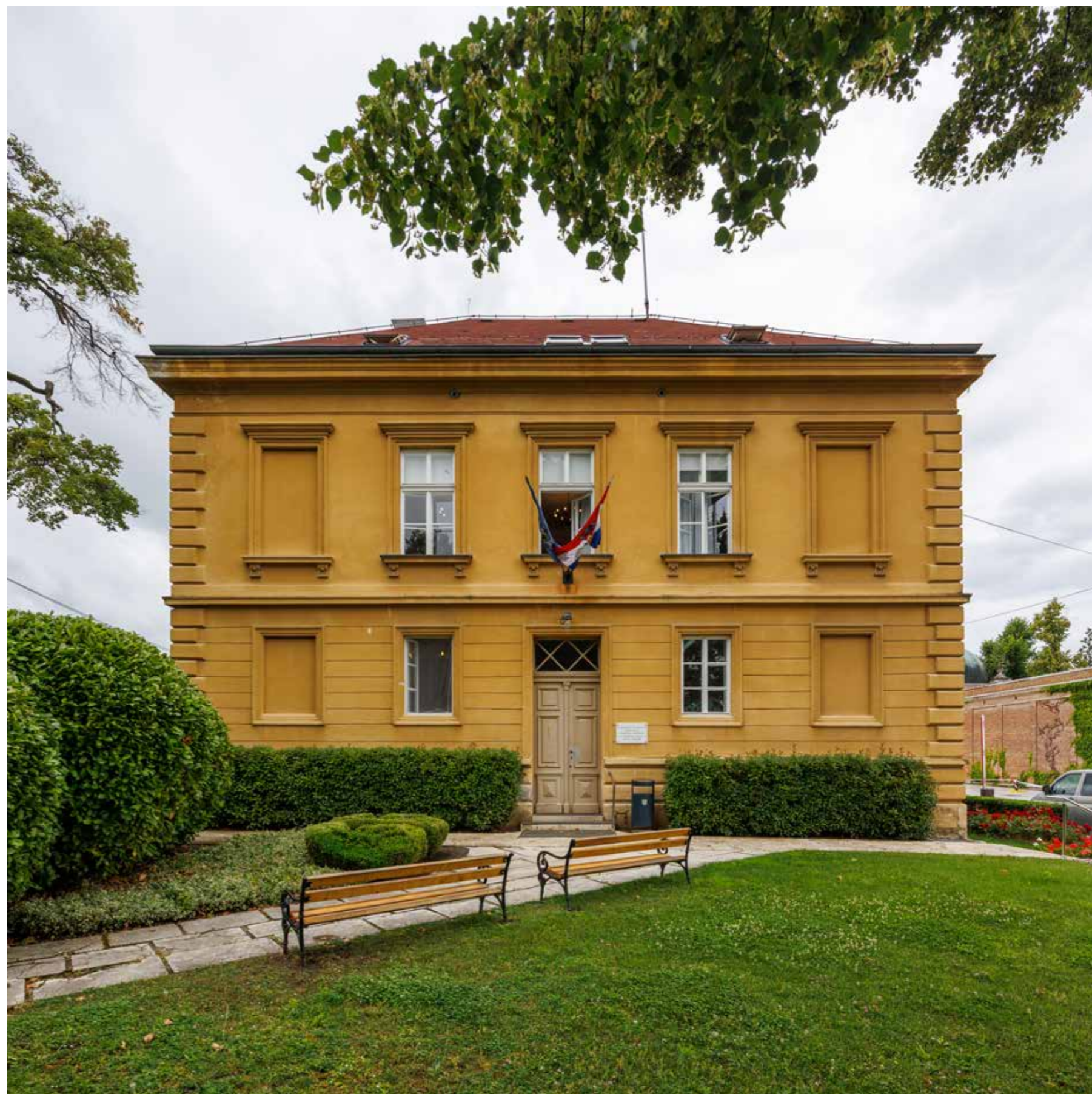
Južno, glavno pročelje
