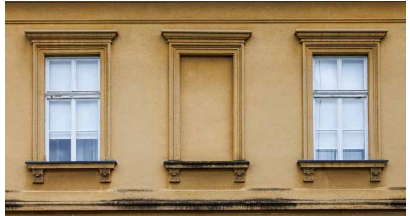
Prozori prvog kata istočnog pročelja
