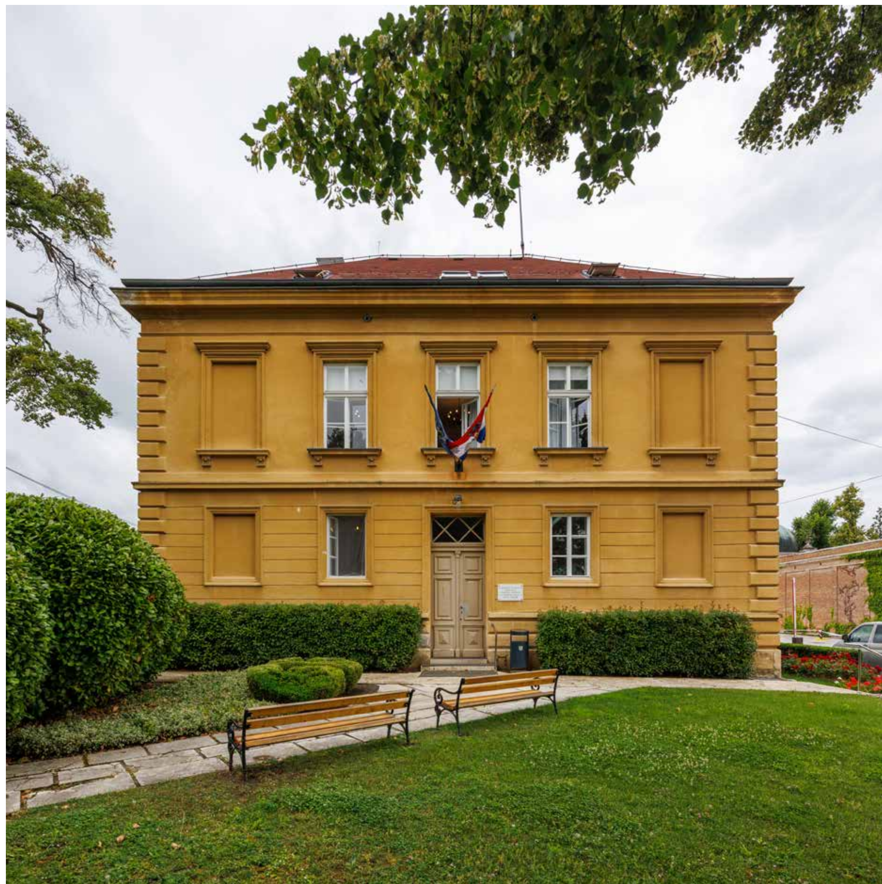
Južno, glavno pročelje
