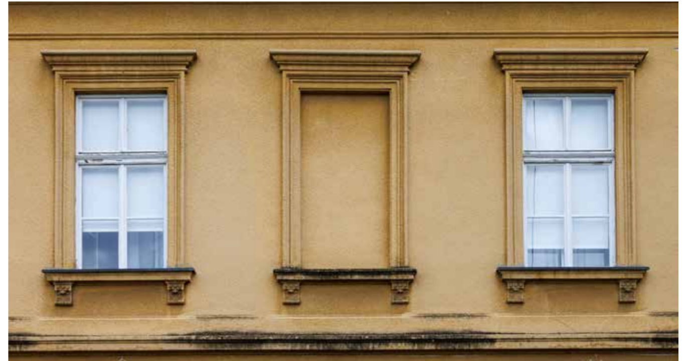
Prozori prvog kata istočnog pročelja
