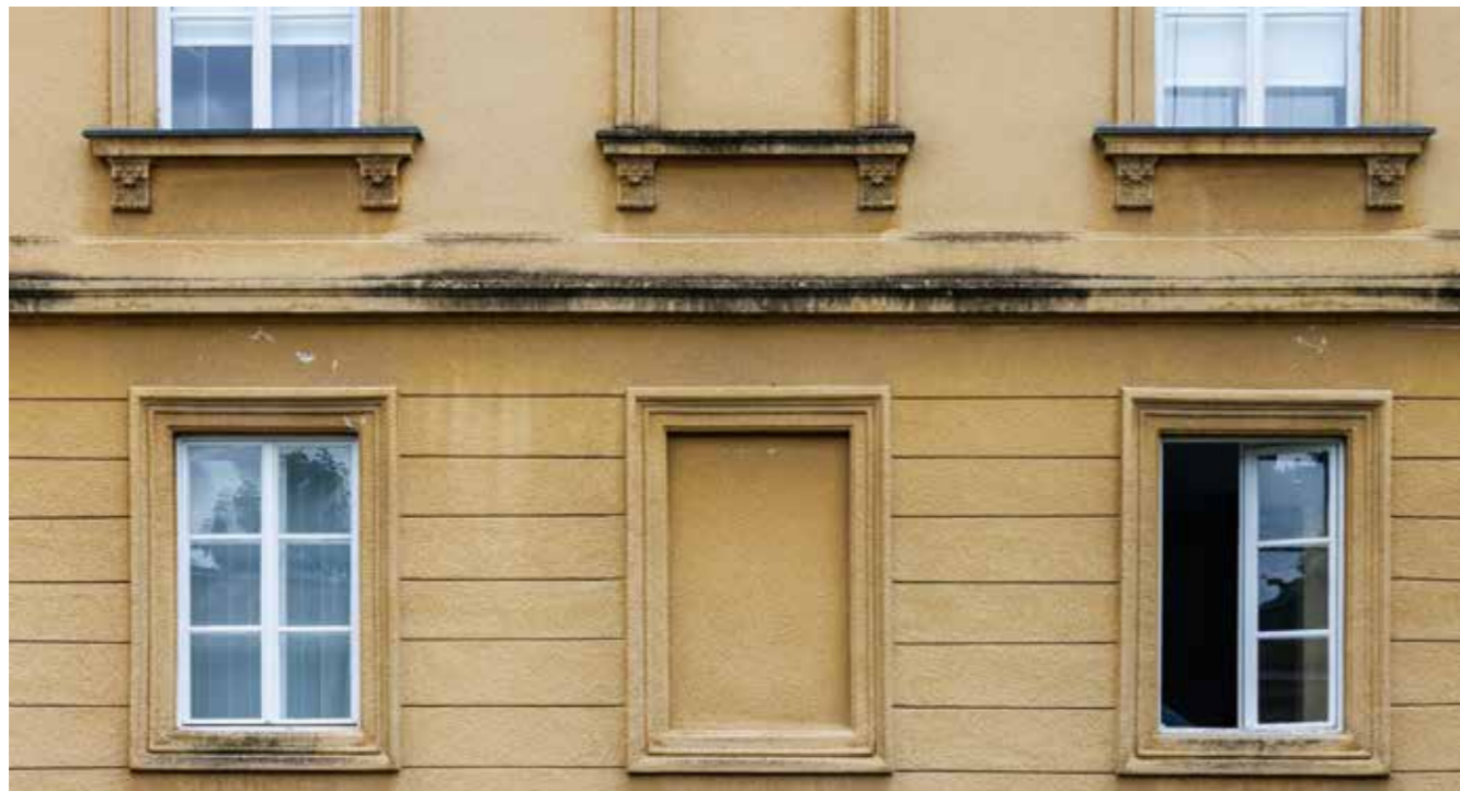
Prozori visokog prizemlja istočnog pročelja
