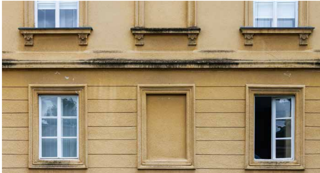
Prozori visokog prizemlja istočnog pročelja
