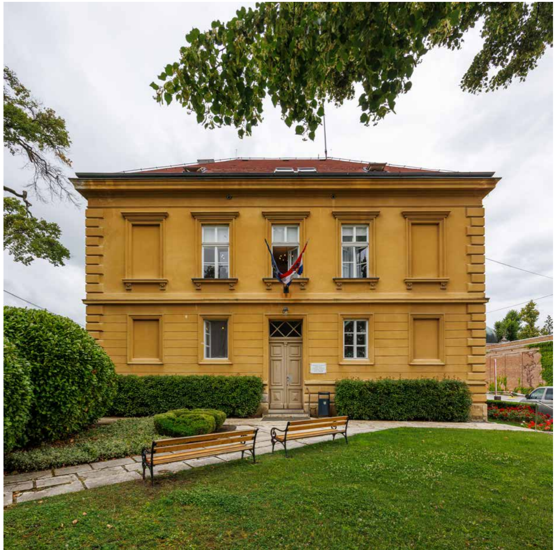
Južno, glavno pročelje
