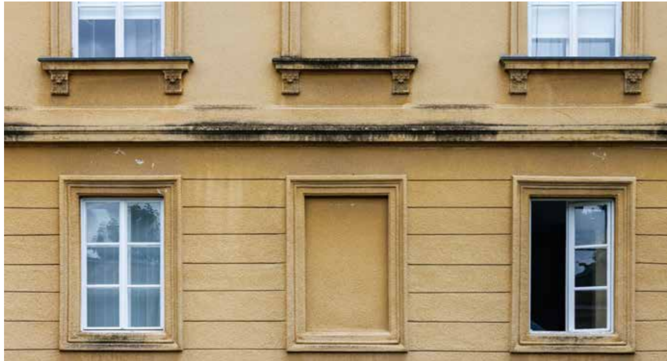
Prozori visokog prizemlja istočnog pročelja
