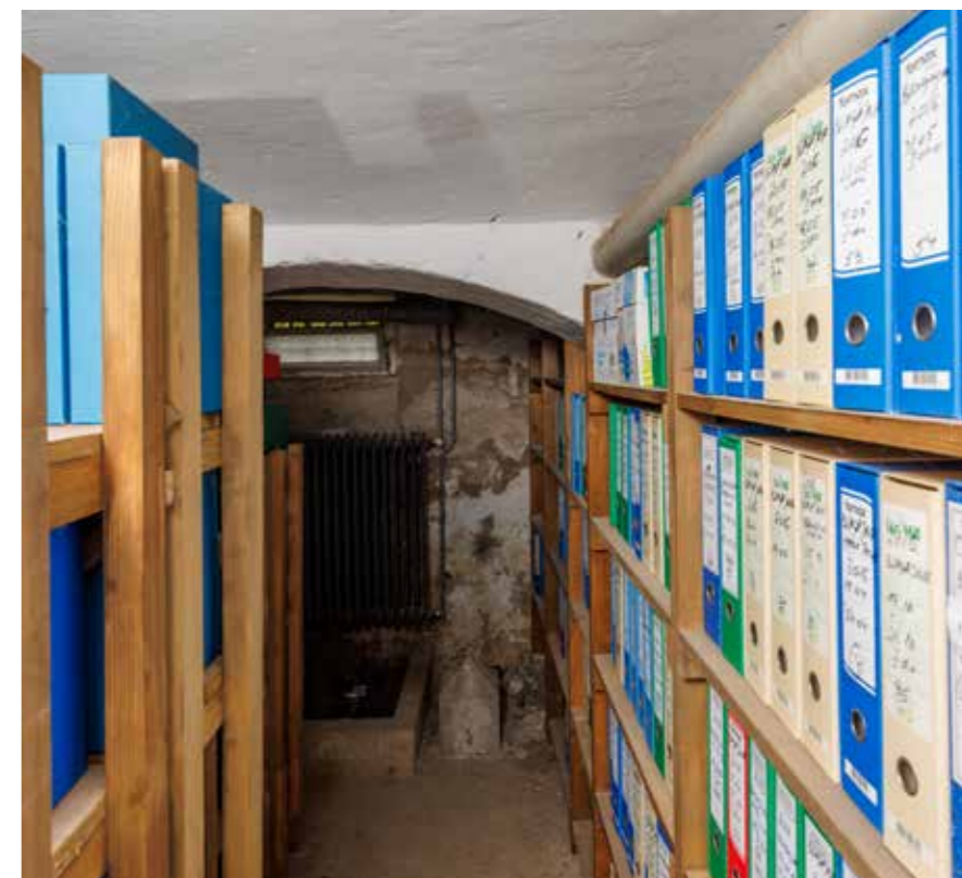
Bunjato u prizemlju, oštećenja
