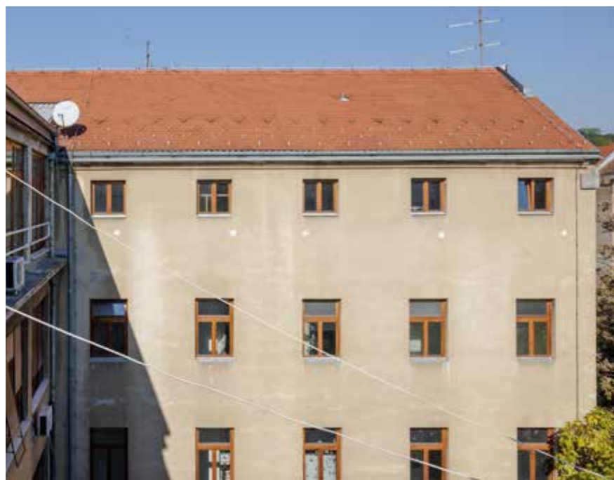
Južno pročelje Ivekovićeve zgrade
