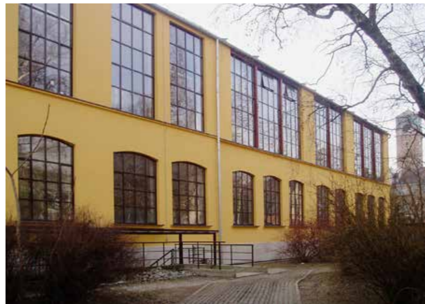
Sjeverno pročelje Alademije likovnih umjetnosti, spoj Bolléove i Grossove zgrade
