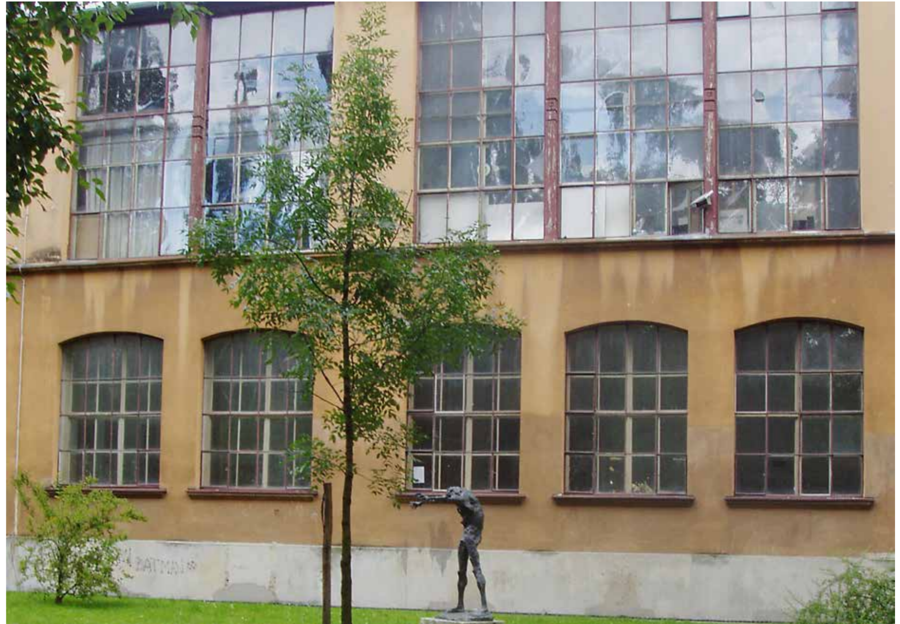
Umjetnički atelijeri prema projektu Hermana Bolléa, sjeverno pročelje prije posljednje obnove 2010. godine, Grad Zagreb, Gradski zavod za zaštitu spomenika kulture i prirode (foto: S. Novak)
