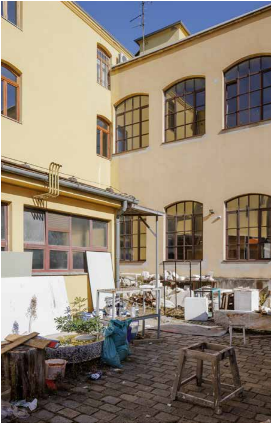
Spoj Grossove zgrade i južnog aneksa
