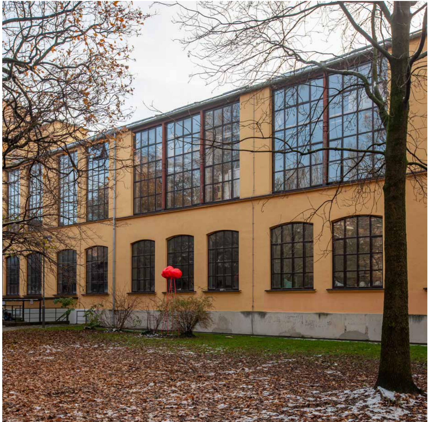
Spoj Bolléove i Grossove zgrade
