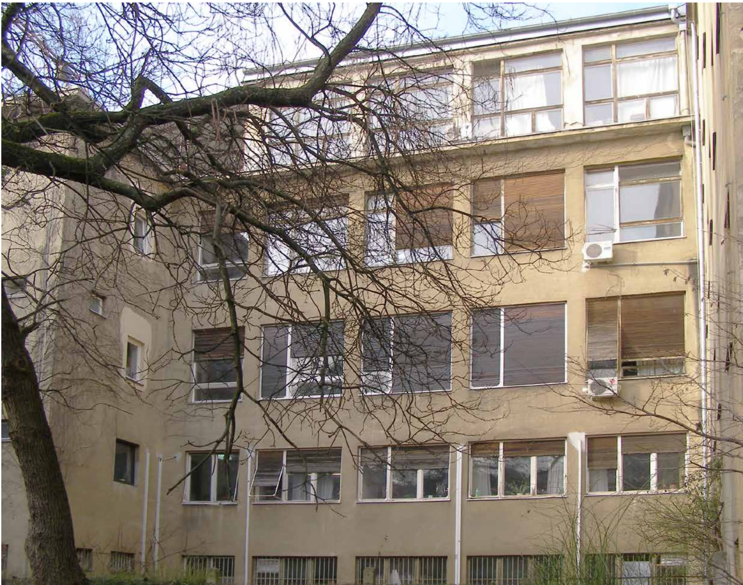
Istočno pročelje dogradnje prema projektu Ive Geršića, 1953.–1957.
