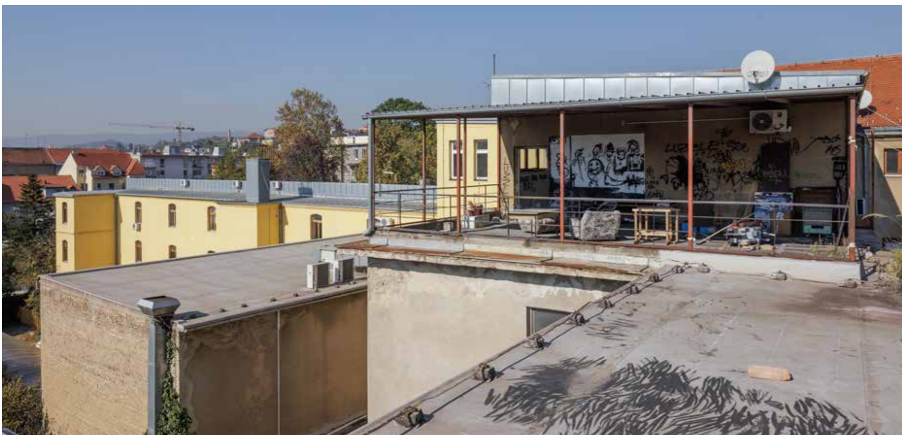
Krov akt-sale u Geršičevoj zgradi • Krov s nadstrešnicama na Geršičevoj zgradi
