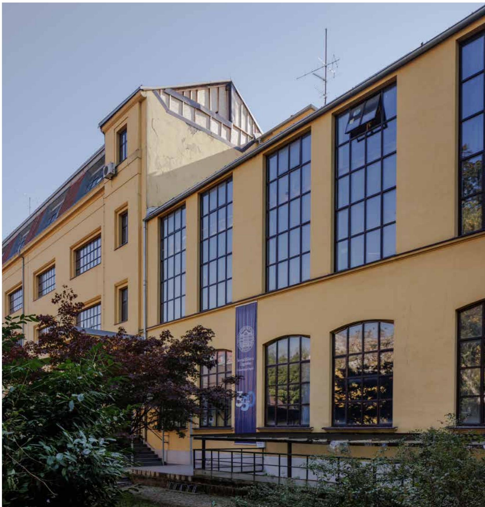
tojanja dilatacije između dijela građevine iz 1922. te dijela iz 1957. godine, koji se konstruktivno bitno razlikuju, stoga i posve drugačije reagiraju na potres, zbog čega je znatno narušena nosiva konstrukcija sklopa. Upravo je zato na tom dijelu došlo do najvećih deformacija konstrukcije. Na većem dijelu sklopa vidljive su pukotine na spoju zidova sa stropnim konstrukcijama te su mjestimično uočene veće
