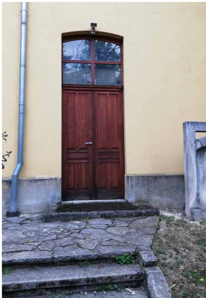
Ulazna vrata sa zapadne strane zgrade
