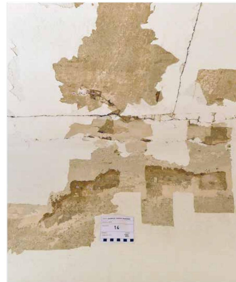
Foto br.5 spoj zida i stropa, hodnik, I kat - zapad, sonda broj 16.
