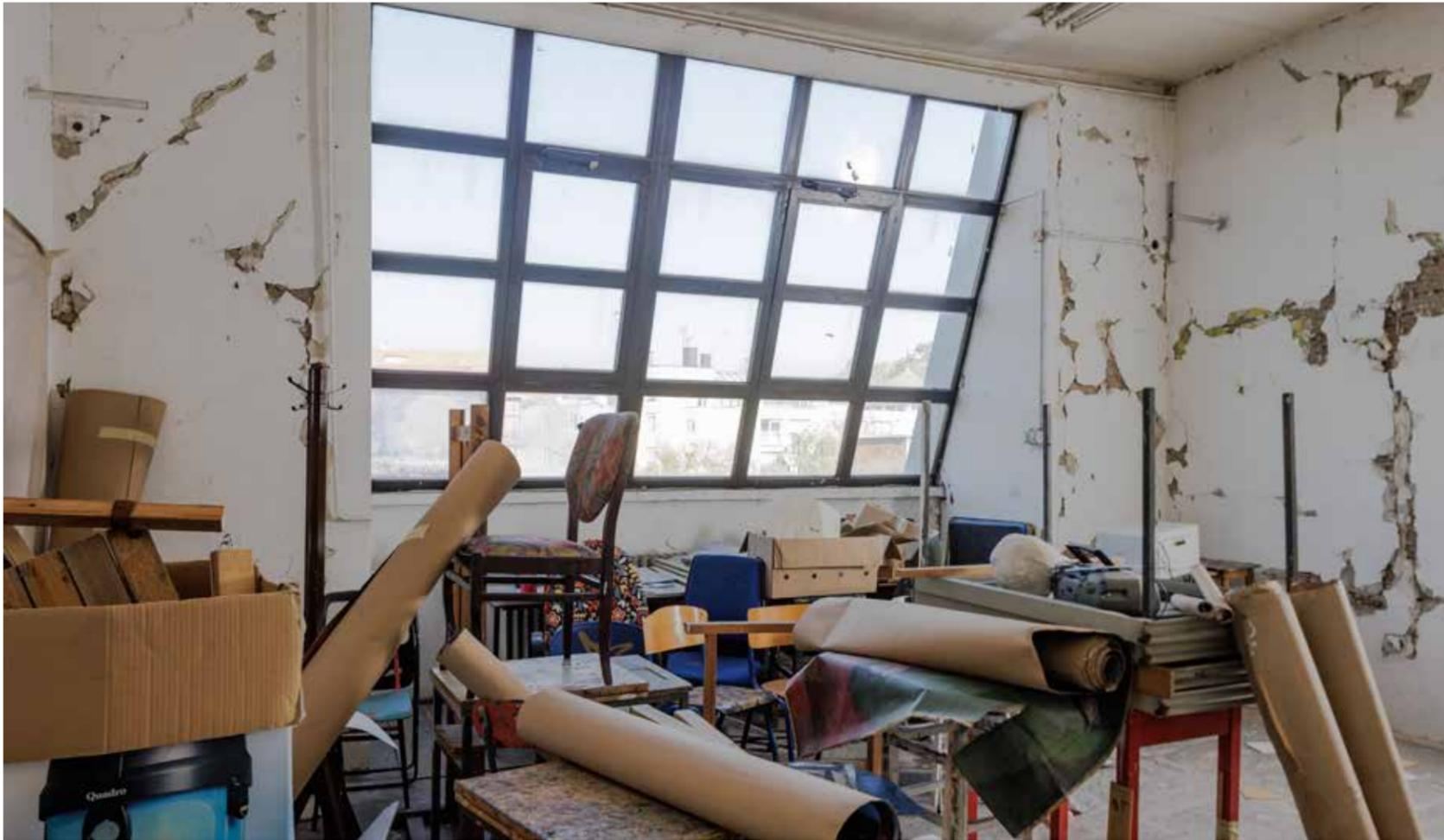
deformacije u podu. Vidljiva su oštećenja nadvoja na svim nosivim zidovima. Sve navedeno upućuje na potrebu cjelovite obnove konstrukcije. U starijim dijelovima oštećenja su povezana i s dotrajalošću građevinskih materijala.
