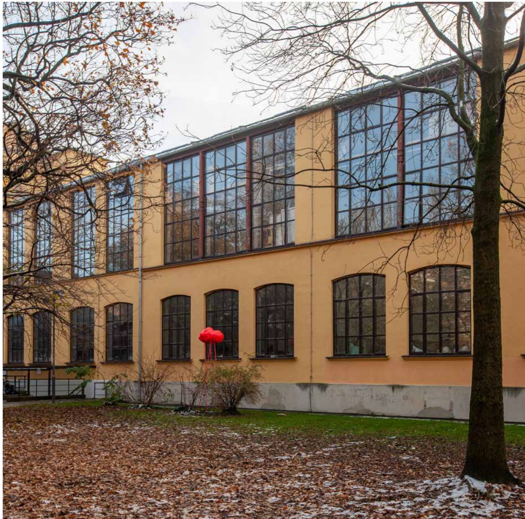
Spoj Bolléove i Grossove zgrade
