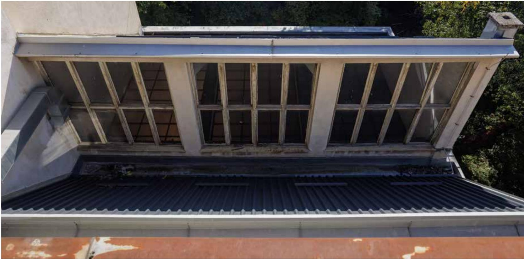
limeni, odnosno biber-crijep na drvenoj potkonstrukciji u Ivekovićevu dijelu. Dio krova na trećem katu južnog dijela Geršičeve dogradnje ima metalnu nadstrešnicu pokrivenu valovitim limom.
