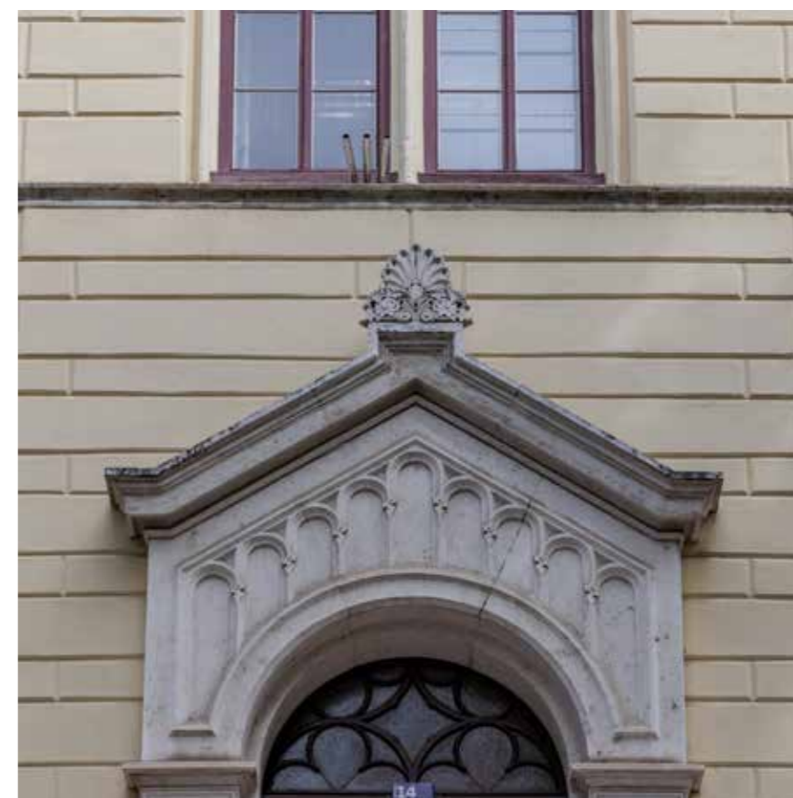
Detalj glavnog portala i bifora
