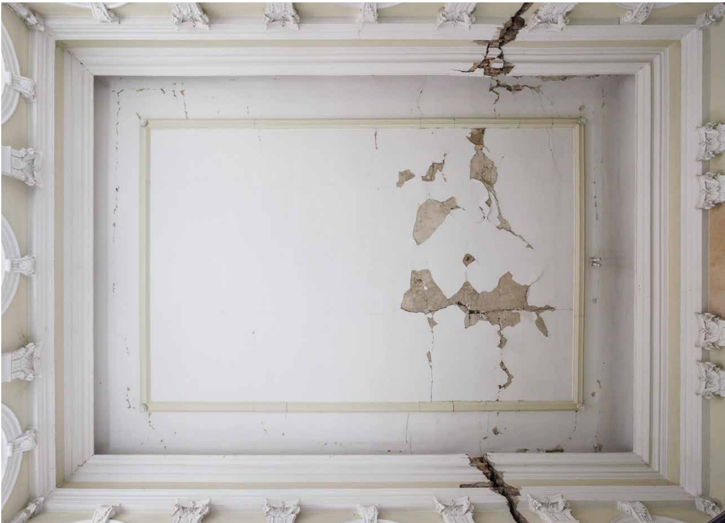
Glavno stubište, strop na drugom katu
