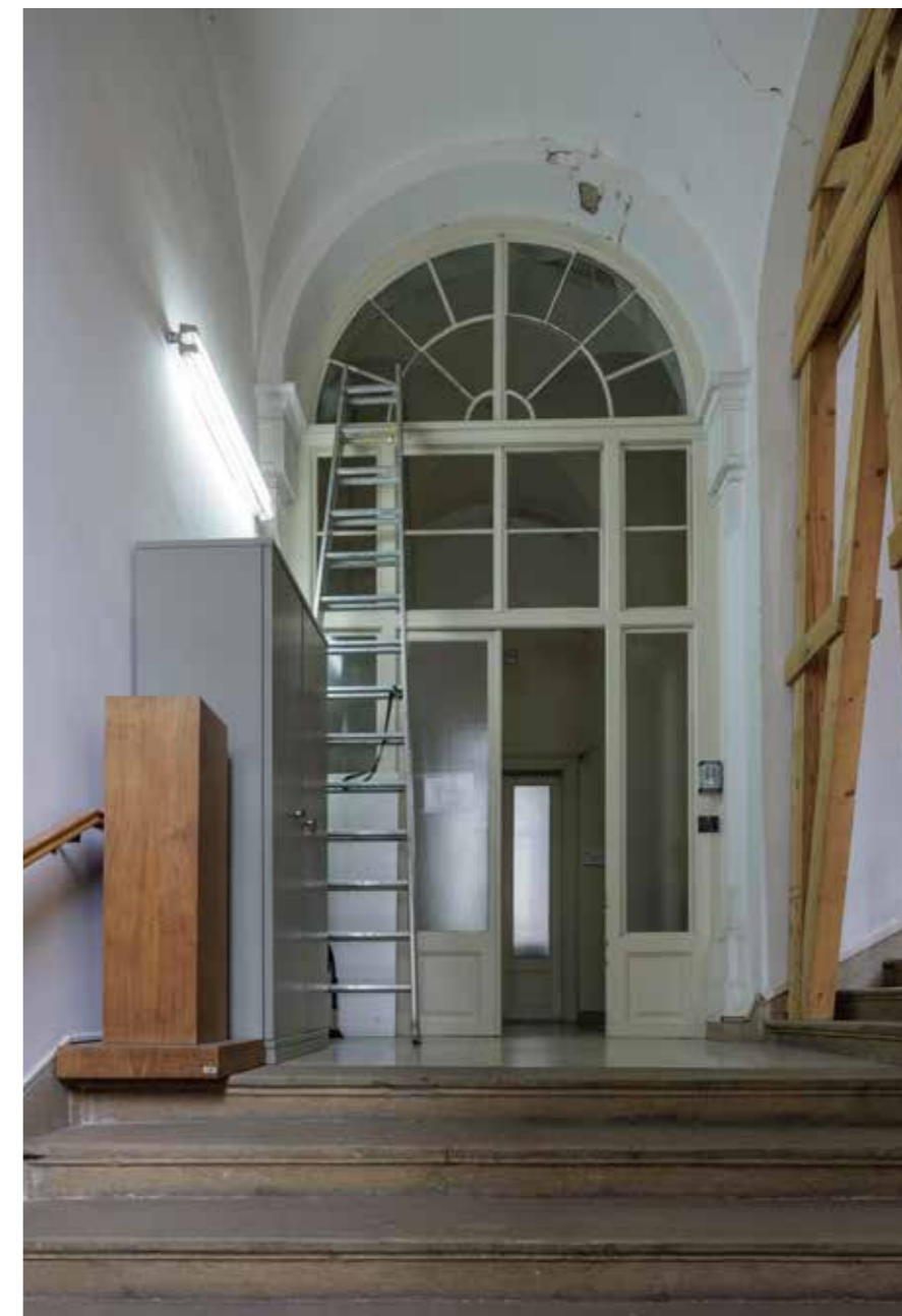
Spoj podesta bočnog stubišta i hodnika s ostakljenim vratnicama
