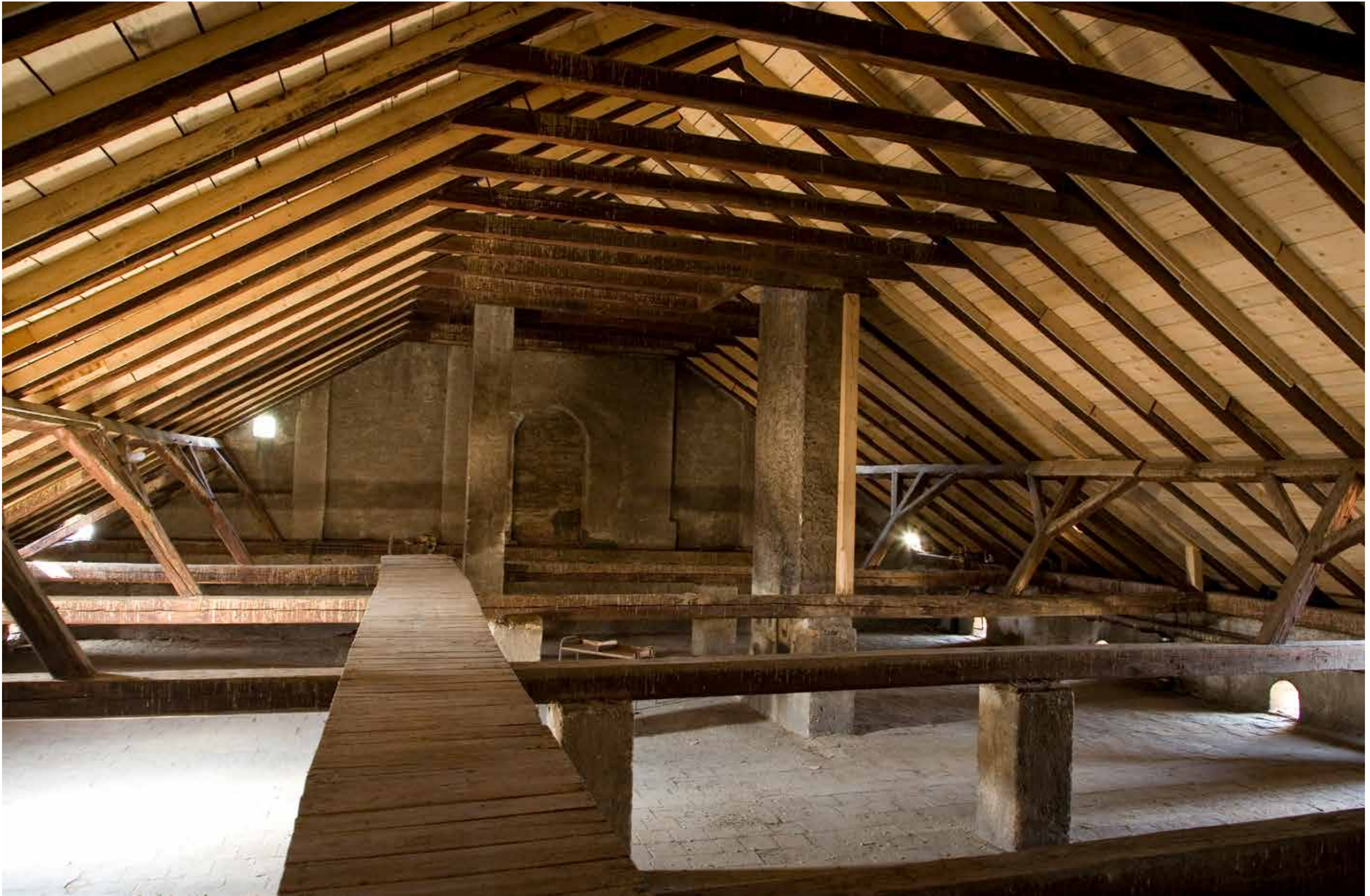
Krovište istočnog krila
