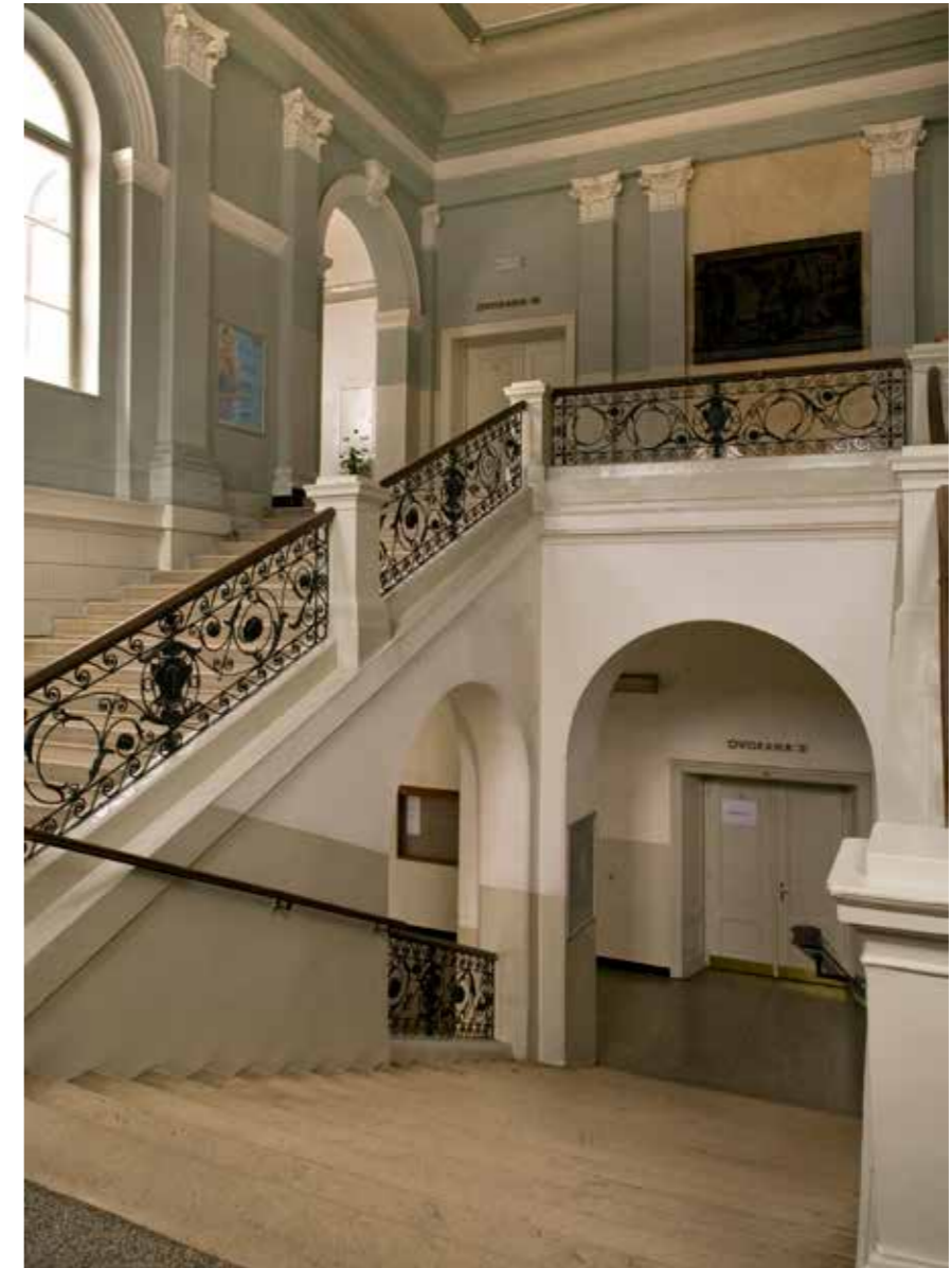
Glavno stubište prije obnove 2009., foto: Danilo Balaban, 2008.
