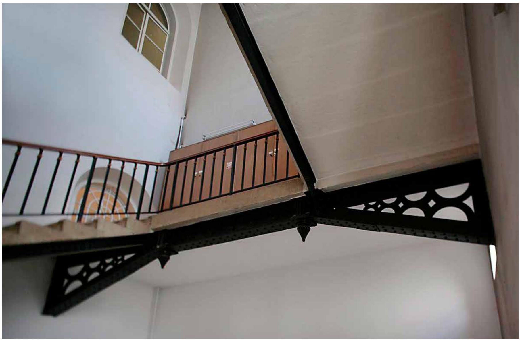
Bočno stubište, konstrukcija od lijevanog željeza ispod međupodesta i krakova stuba, foto: Mladen Perušić
