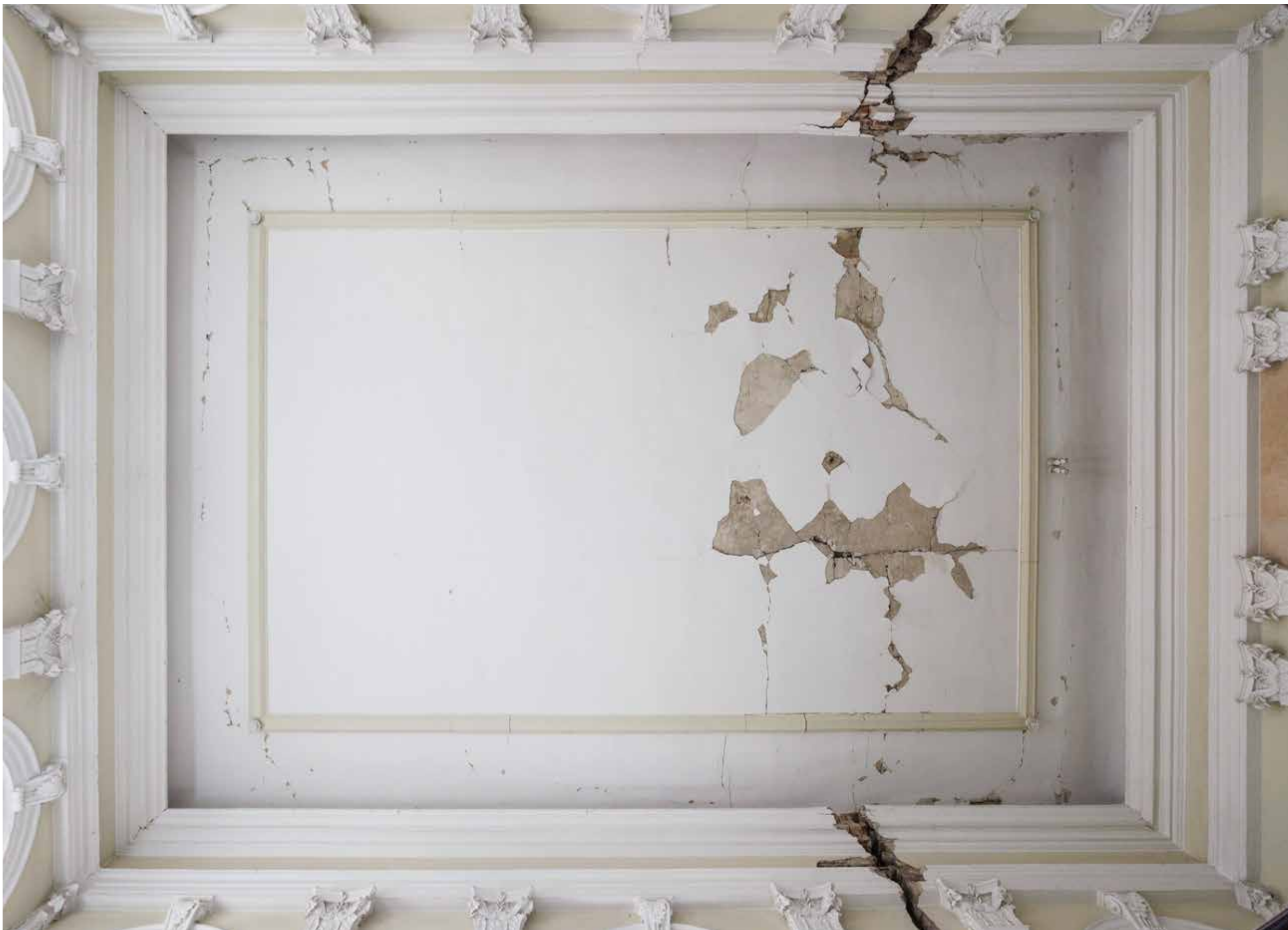
Glavno stubište, strop na drugom katu
