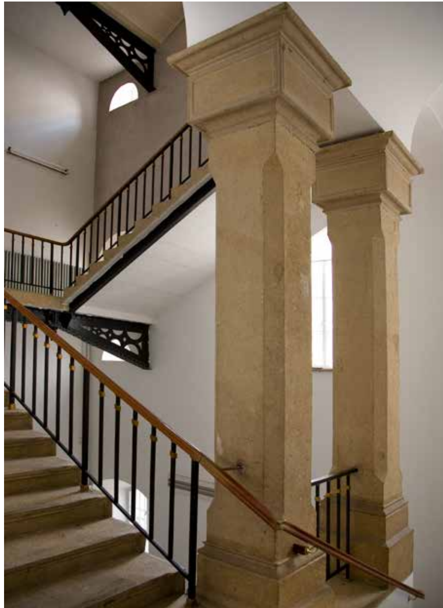
Bočno stubište prije obnove 2009., foto: Danilo Balaban, 2008.
