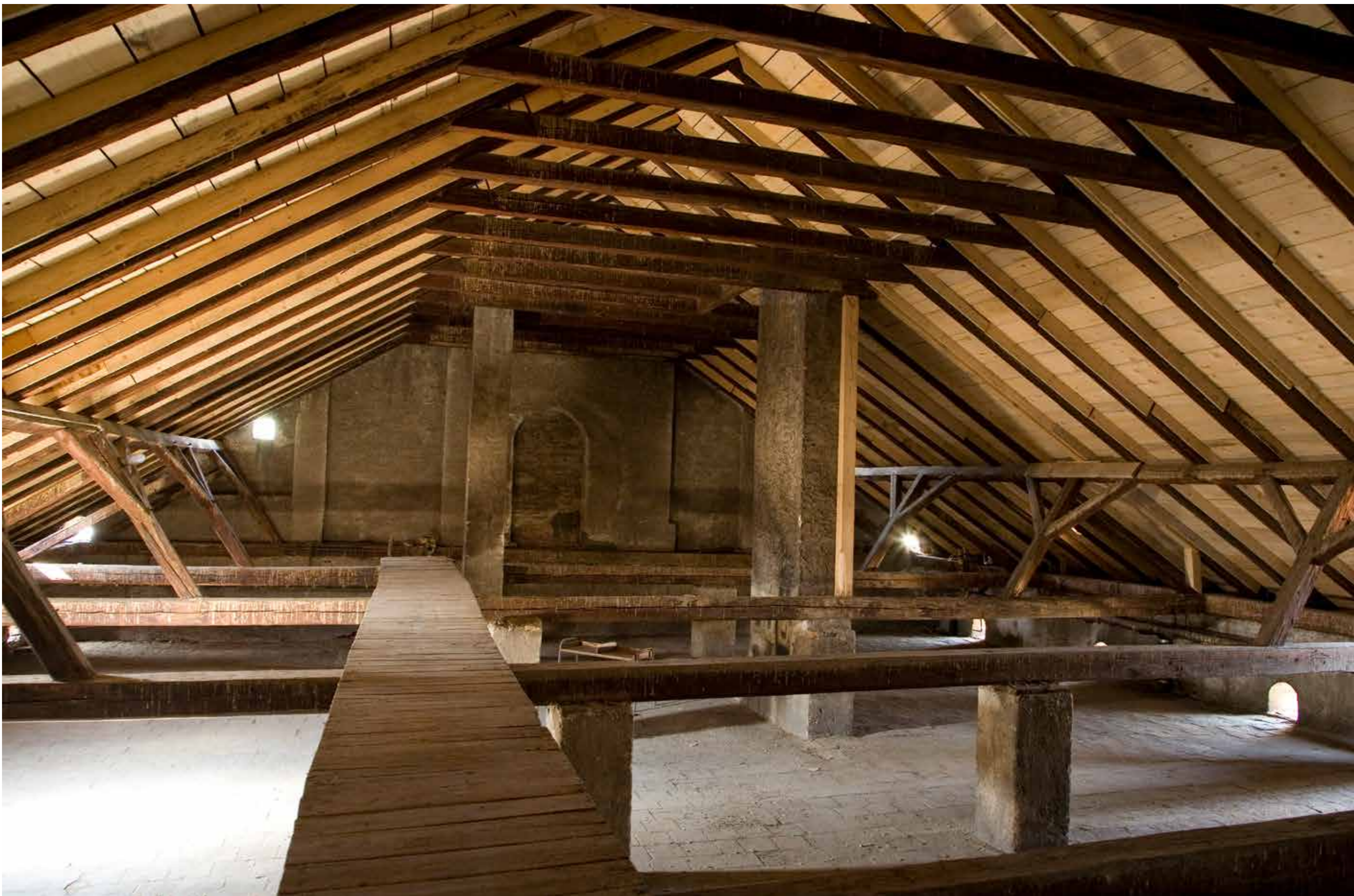
Krovište istočnog krila
