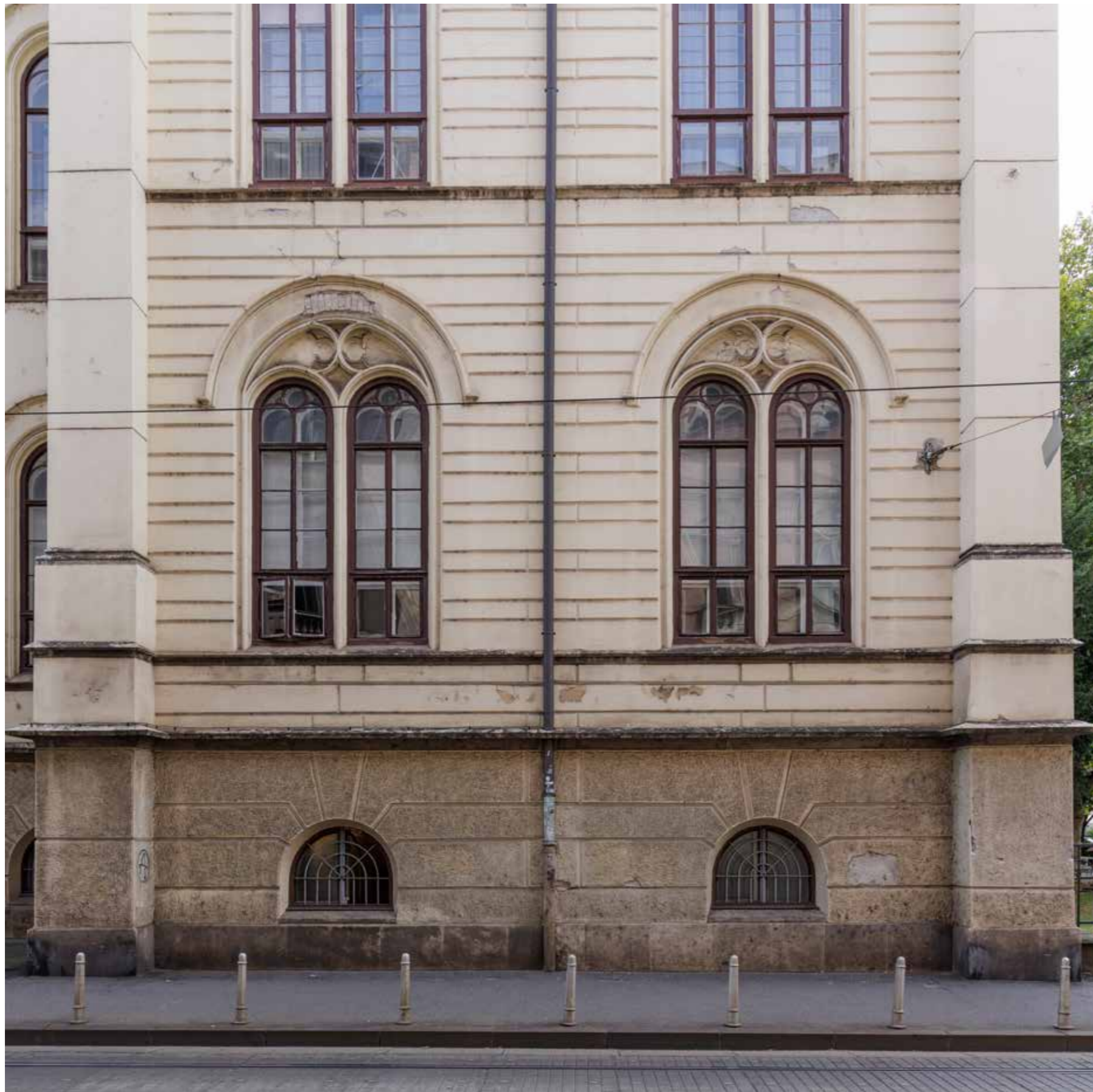
Zapadno pročelje, detalji
