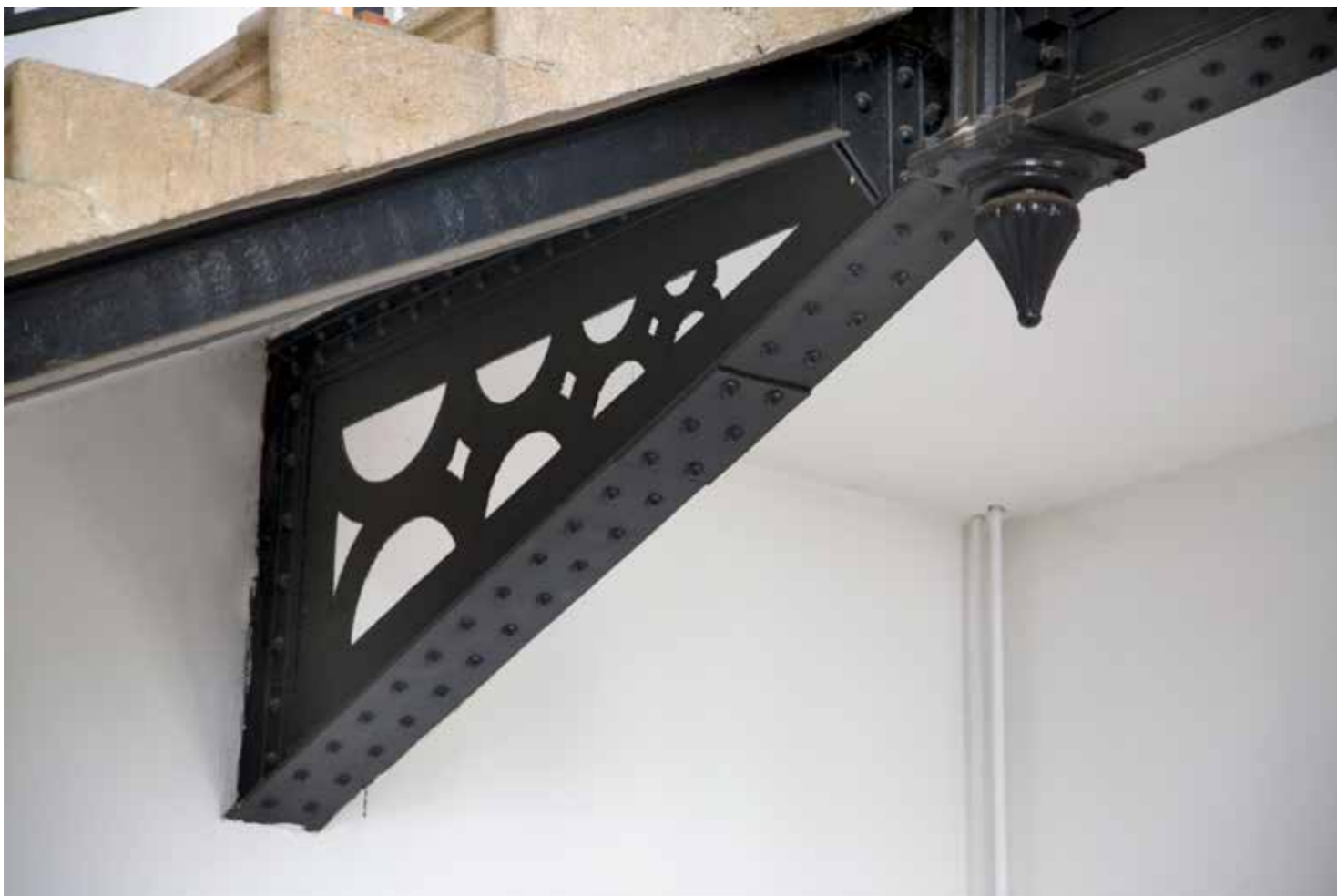
Bočno stubište, detalj konstrukcije od lijevanog željeza, foto: Mladen Perušić
