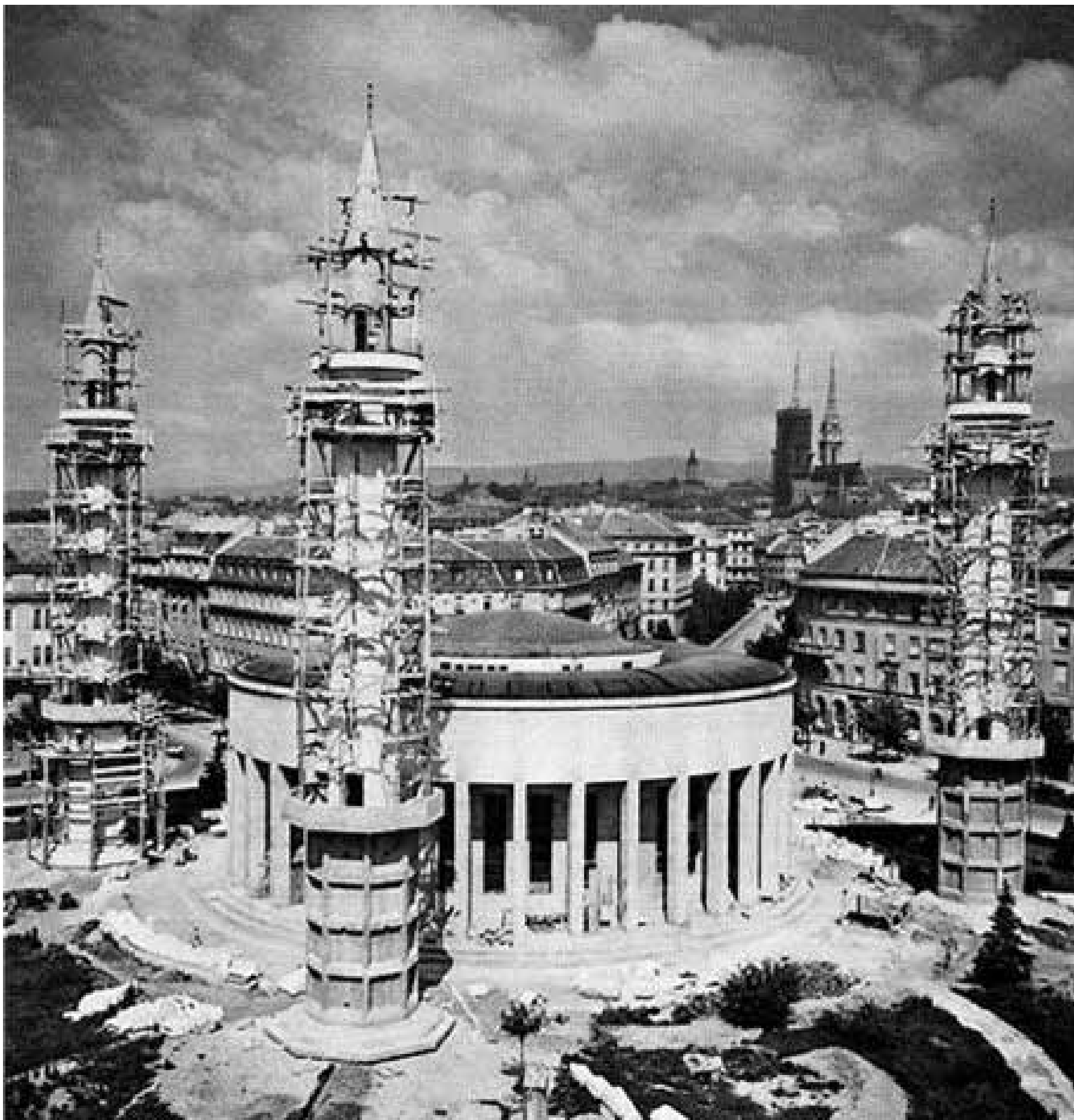
Minareti prema projektu Stjepana Planića u izgradnji, 1942.
