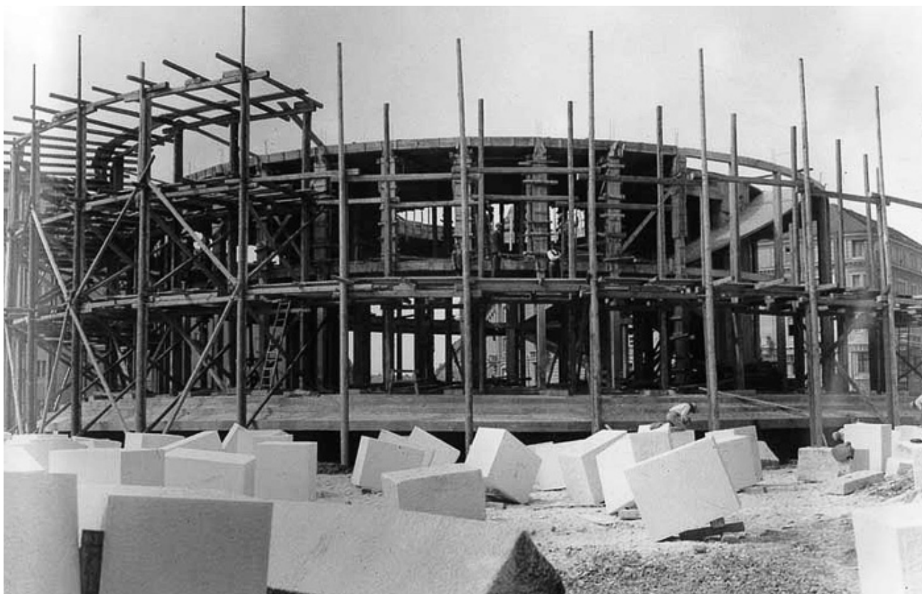
Dom likovnih umjetnosti u izgradnji, 1937./1938., HDA
