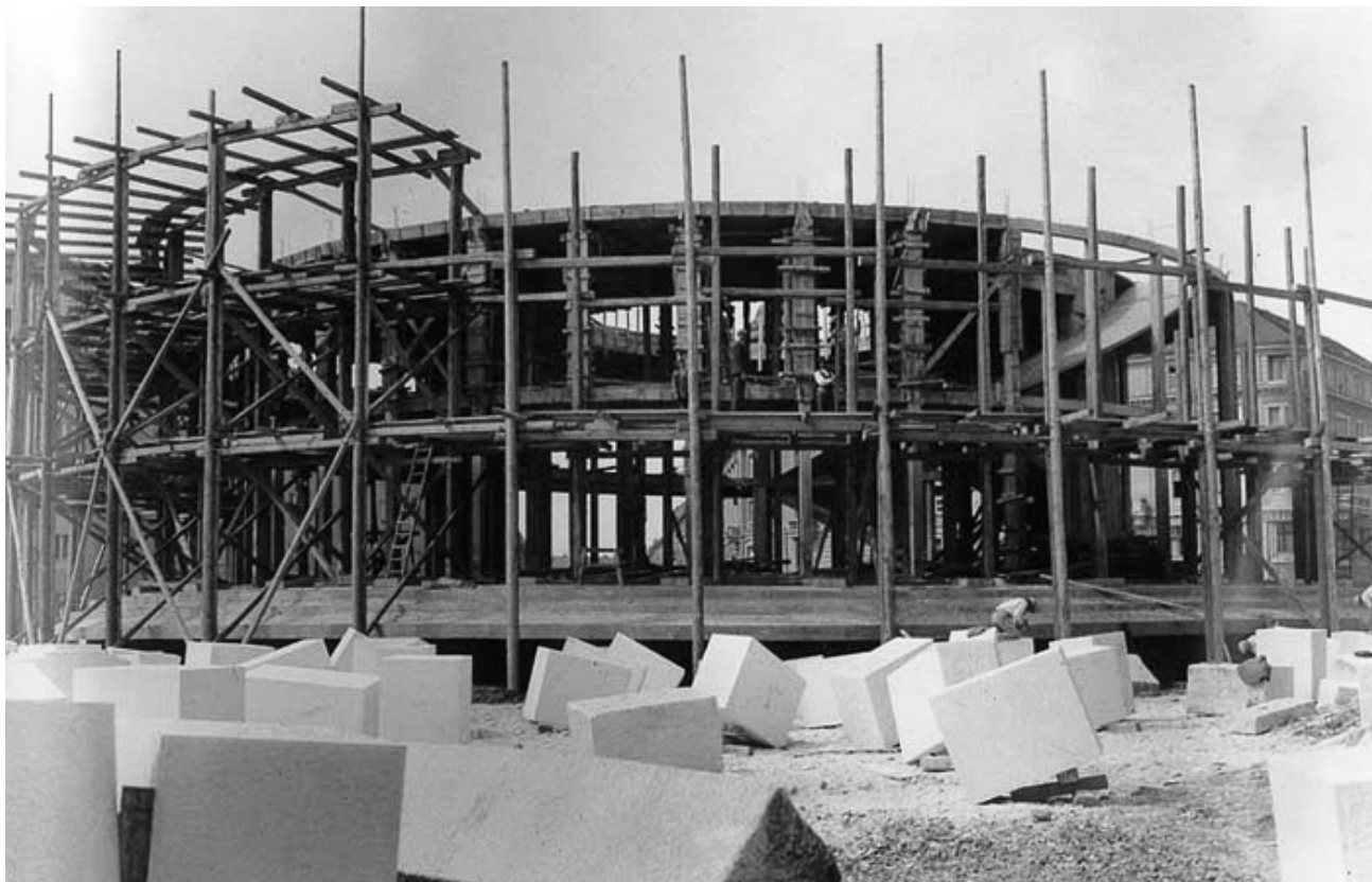
Dom likovnih umjetnosti u izgradnji, 1937./1938., HDA
