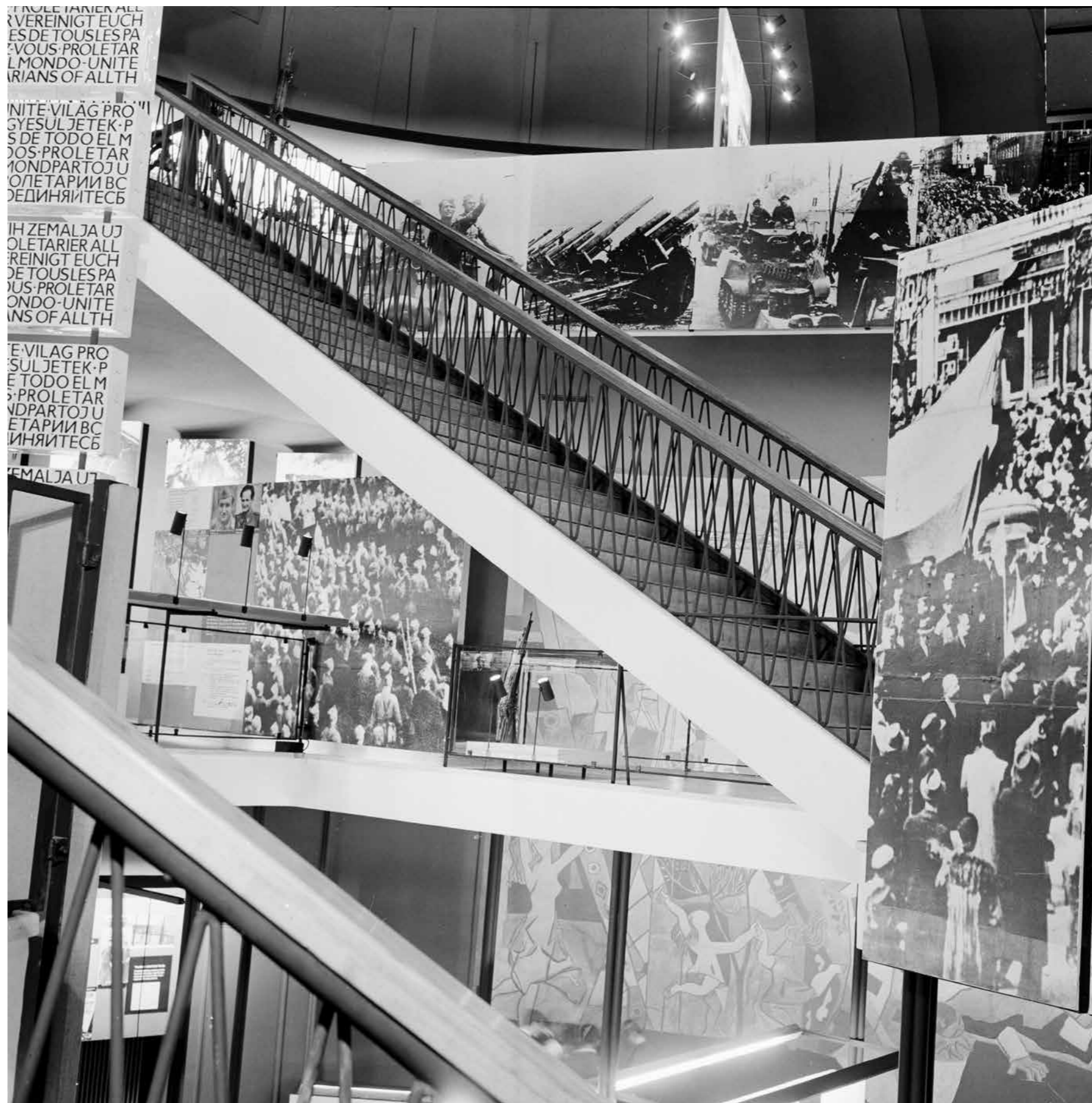
Montažne stepenice prema nacrtu Vjenceslava Richtera, HDA
