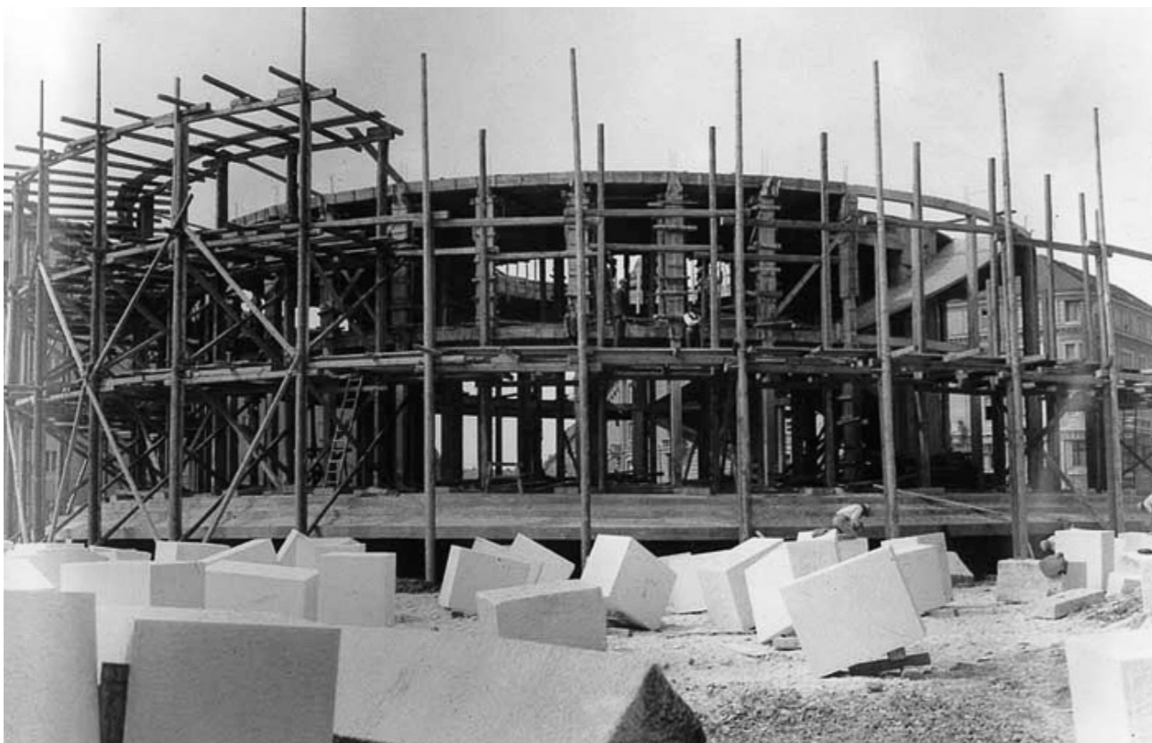
Dom likovnih umjetnosti u izgradnji, 1937./1938., HDA
