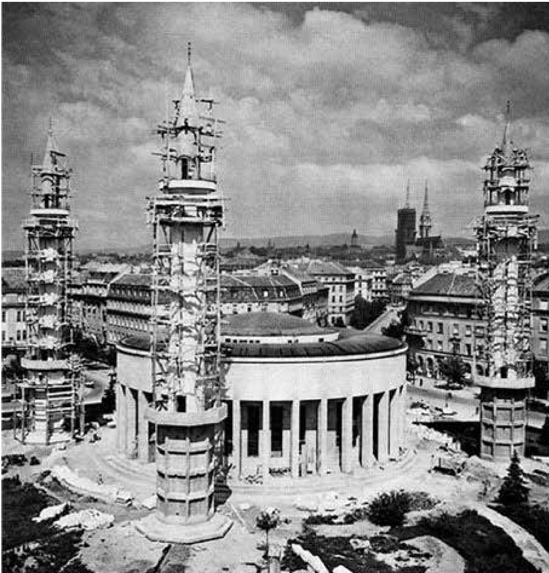
Minareti prema projektu Stjepana Planića u izgradnji, 1942.
