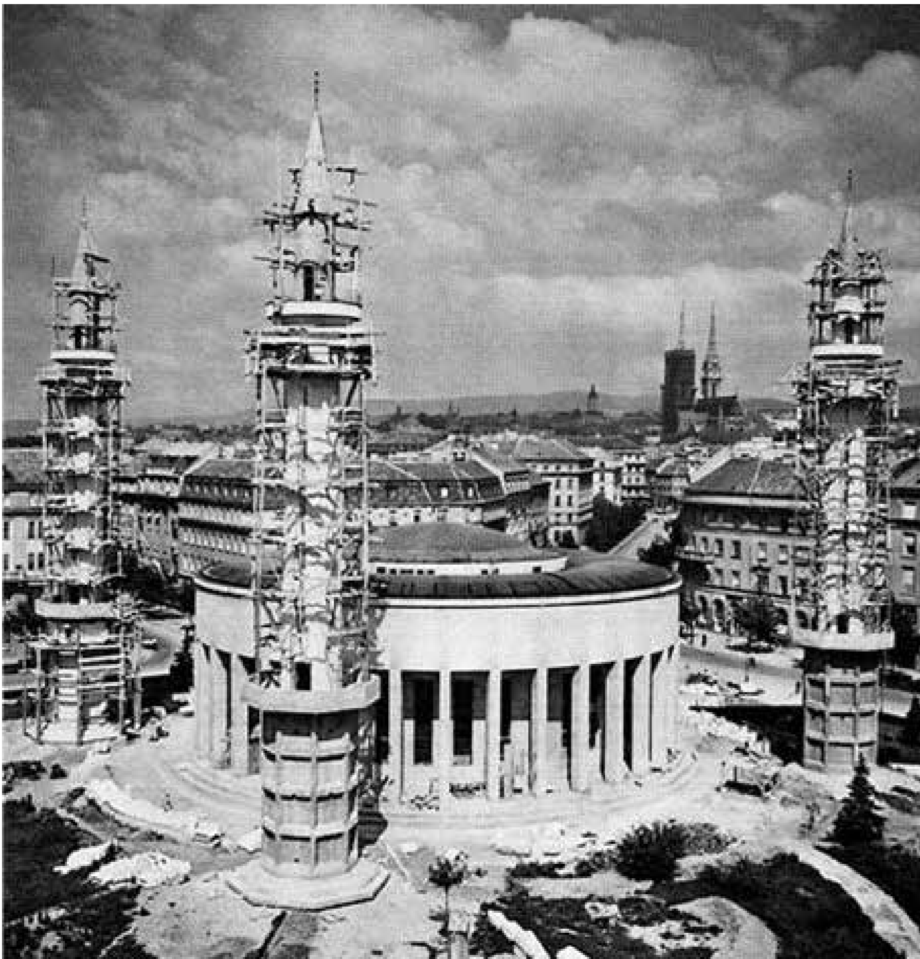
Minareti prema projektu Stjepana Planića u izgradnji, 1942.
