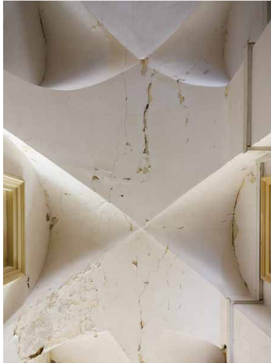
Kuća Miletić (kbr. 11), svodovi u veži
