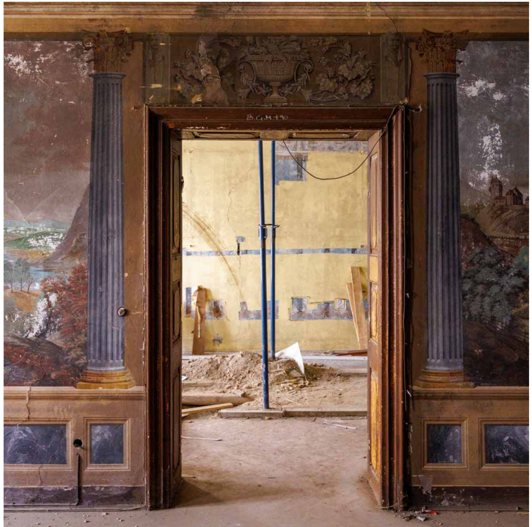
Vrata između dviju oslikanih prostorija na katu
