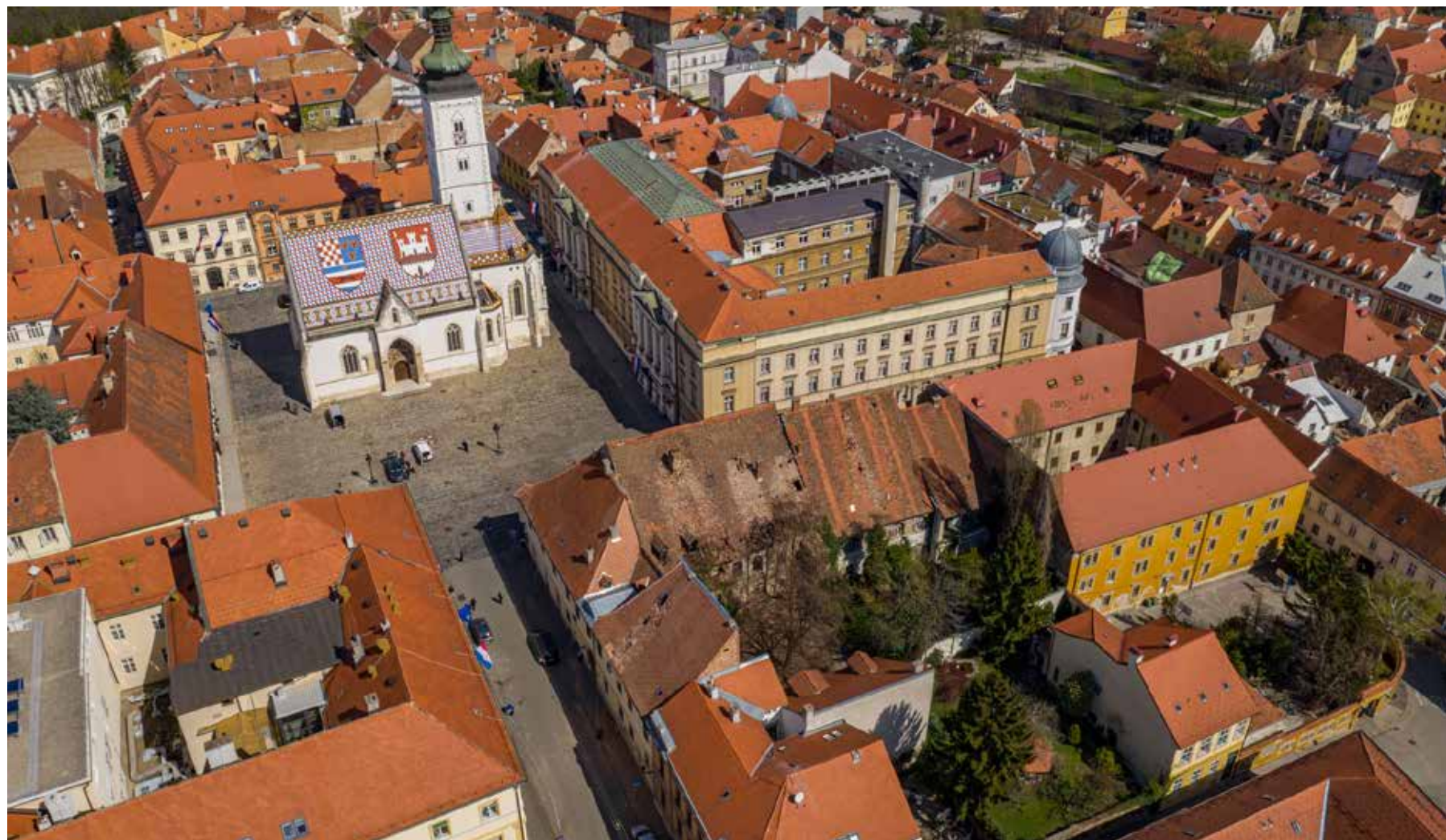
Blok 11, pogled s jugozapada
