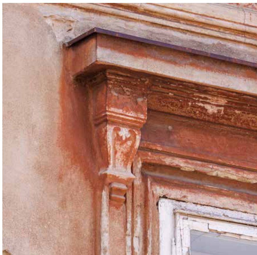
Dograđeno krilo, detalji pročelne plastike
