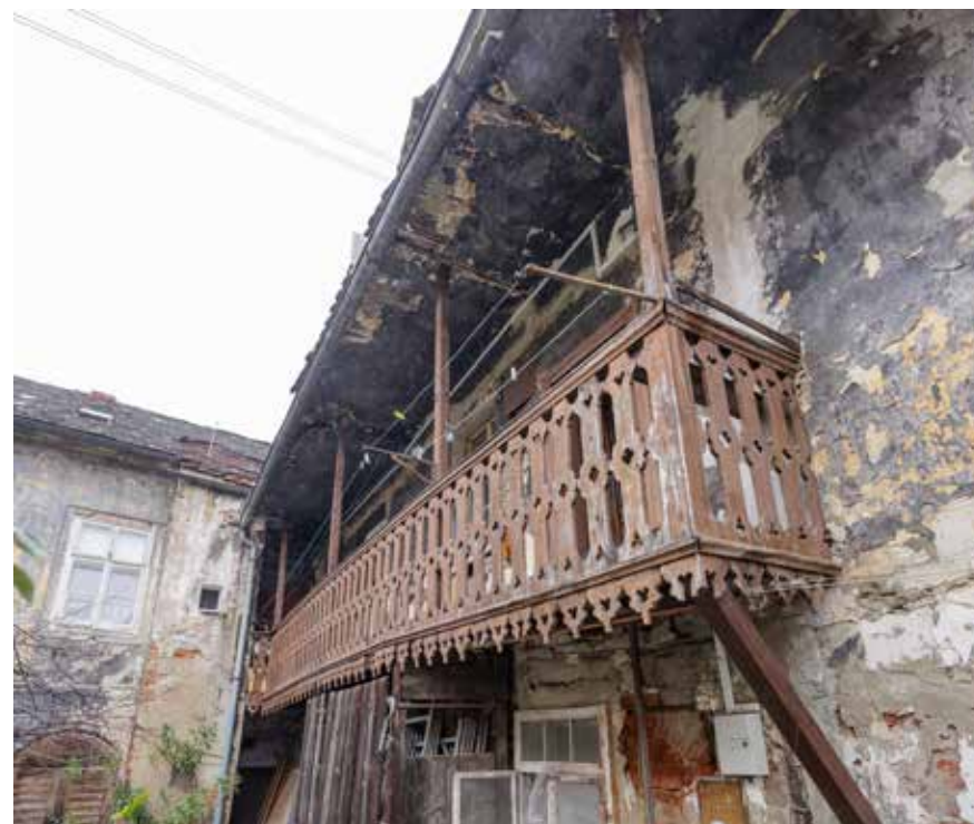
Kuća Fuchs-Devidé, dvorišni trijem
