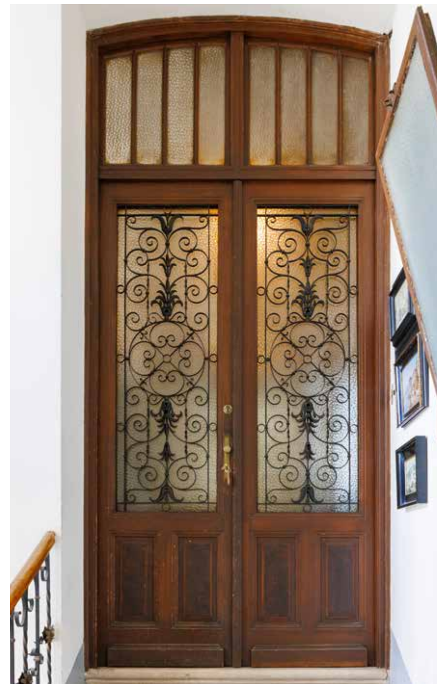
Ulaz iz stubišta u stan
