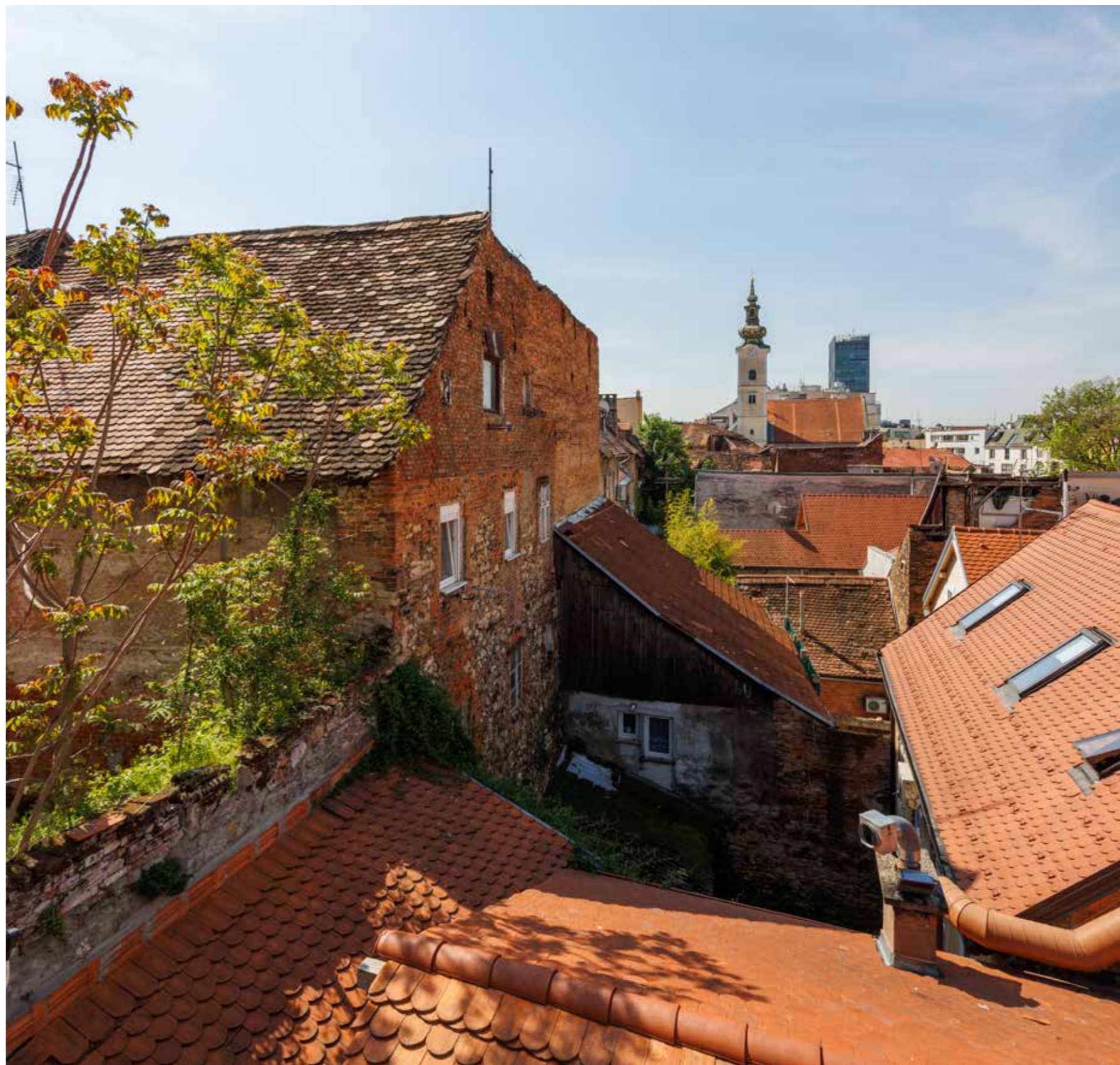
Zapadni gradski zid Kaptola
