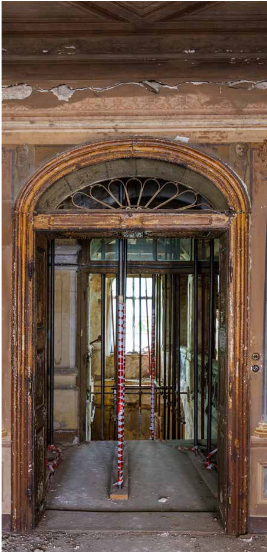
Vrata prema stubištu
