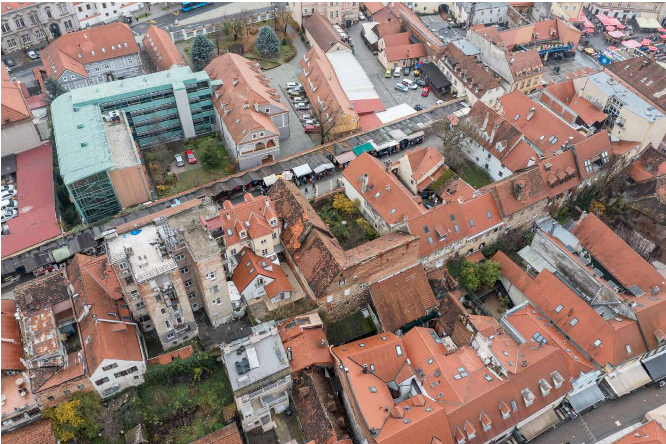
Opatovina, pogled sa zapada (kbr. 33–13)
