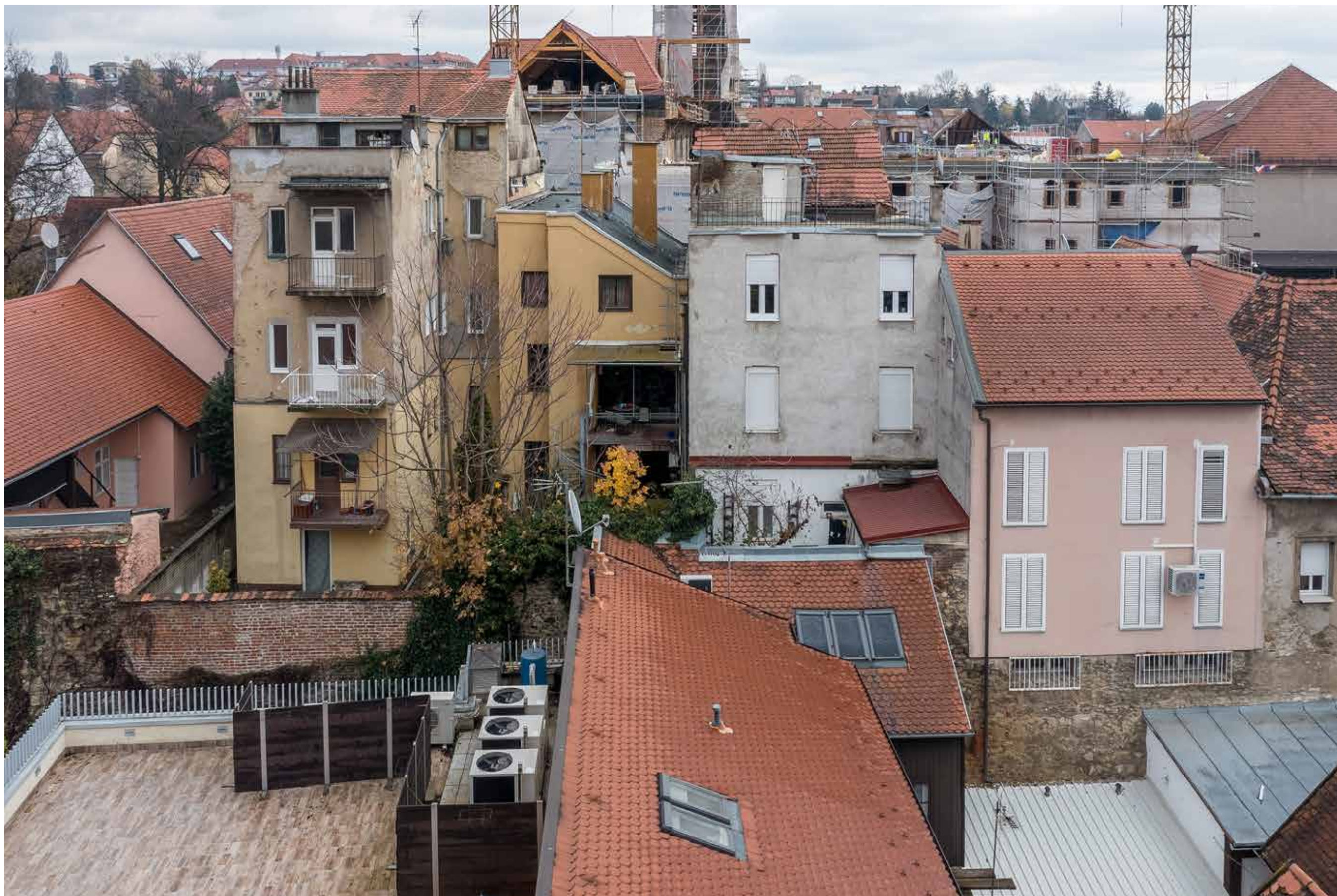
Zapadno začelje poviše gradskog zida
