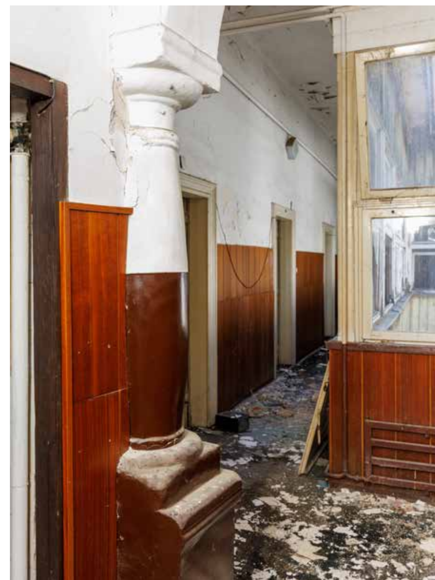
Kuća Miletić, stup nekadašnjega dvorišnog trijema na katu
