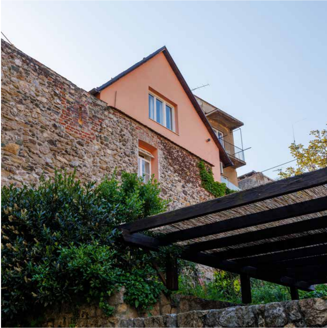
Dvorišna kuća, zapadno pročelje na gradskom zidu
