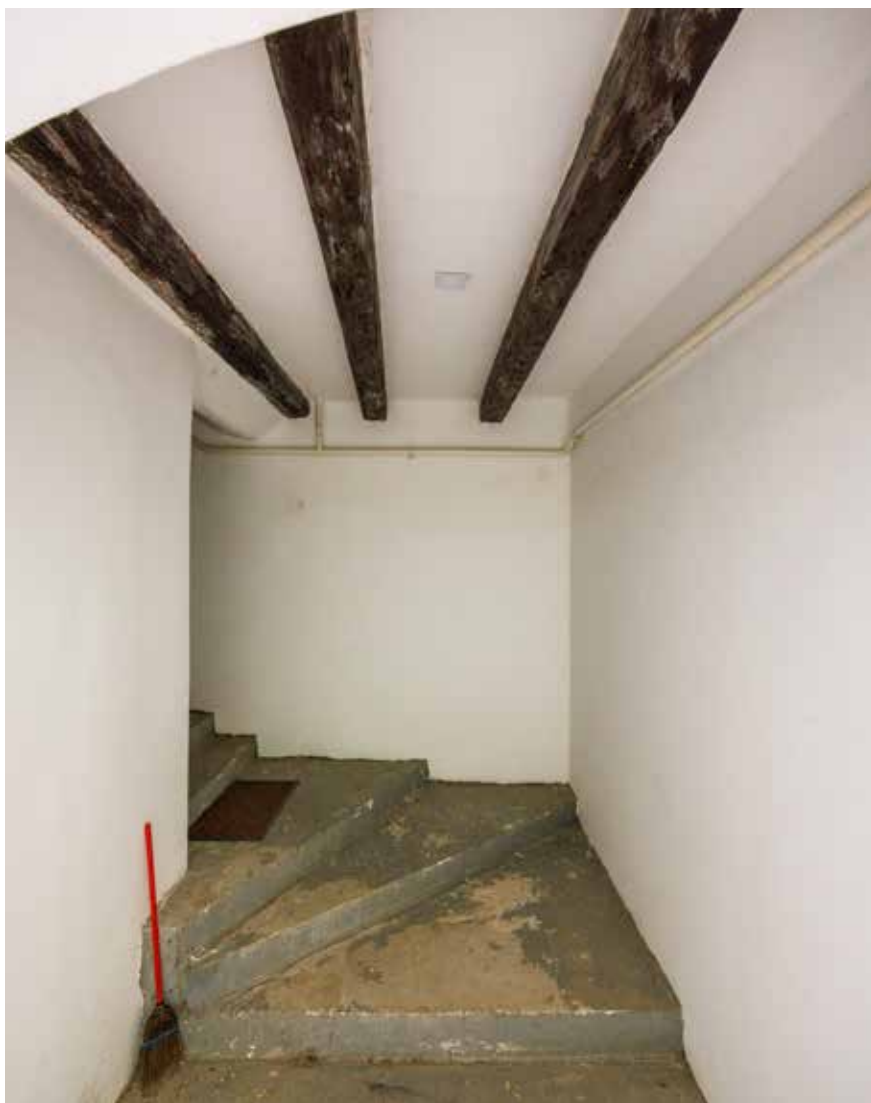
Svod u prizemlju Stubište
