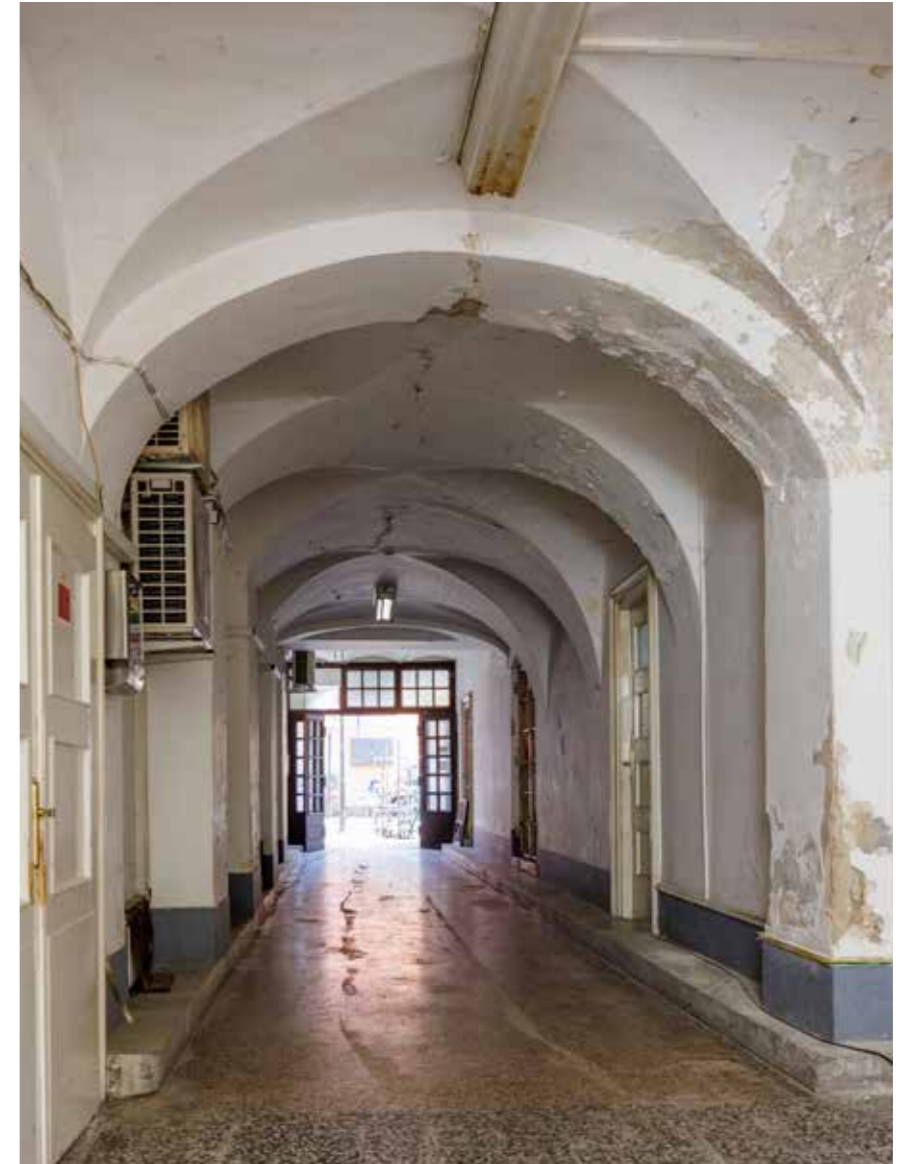
Kuća Miletić, veža
