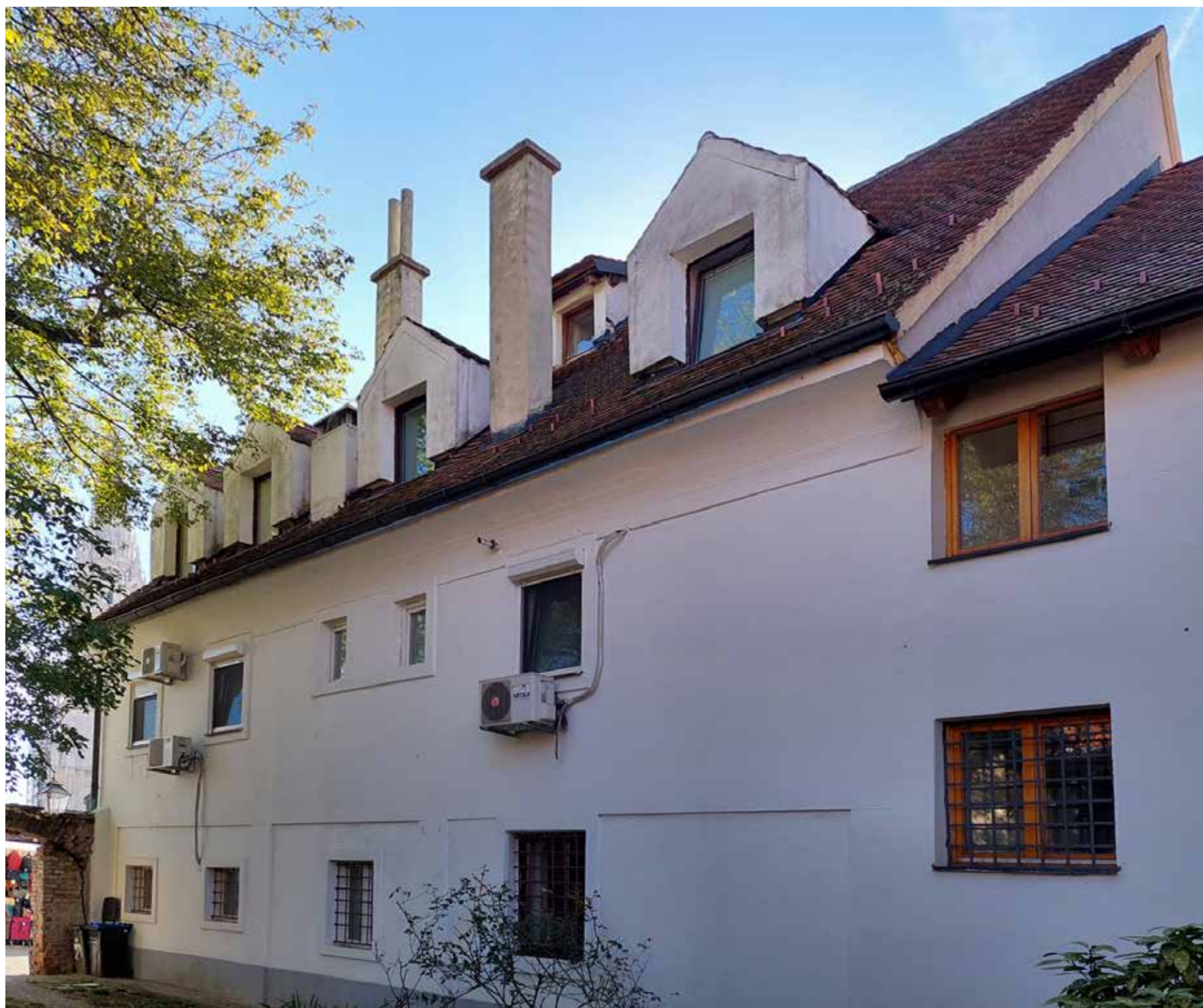
Sjeverno pročelje u dvorištu susjedne kuće
