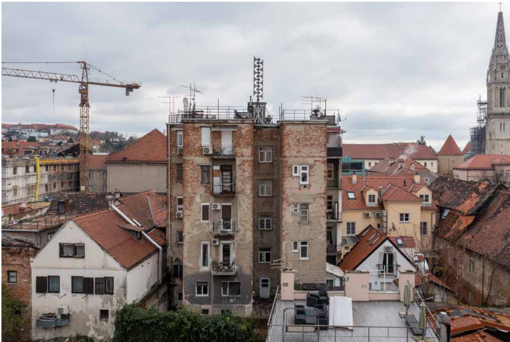
Zapadno začelje poviše gradskog zida
