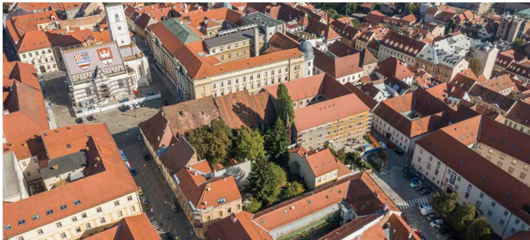
Blok 11, pogled s jugozapada
