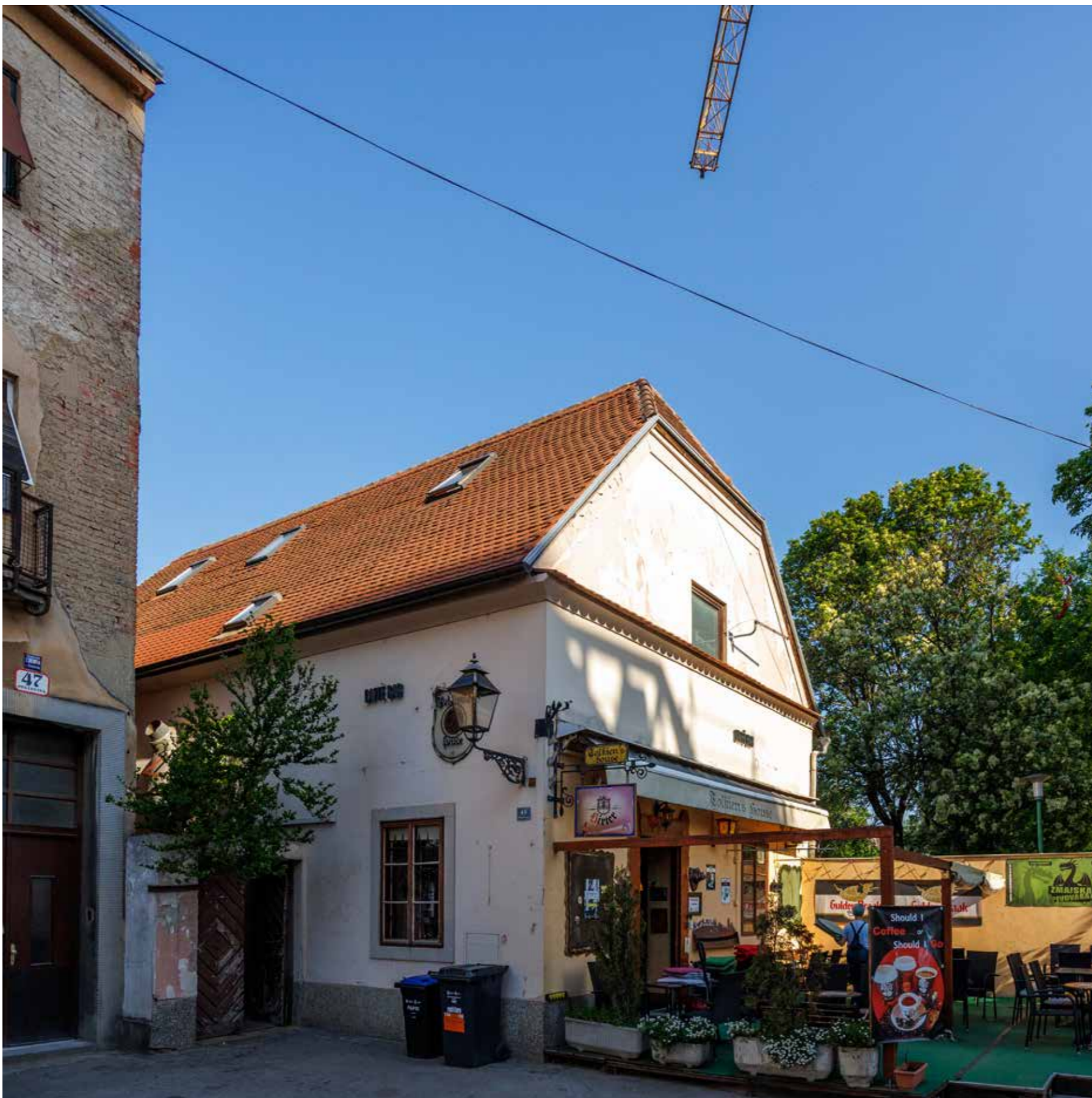
Ulična kuća, južno i istočno pročelje
