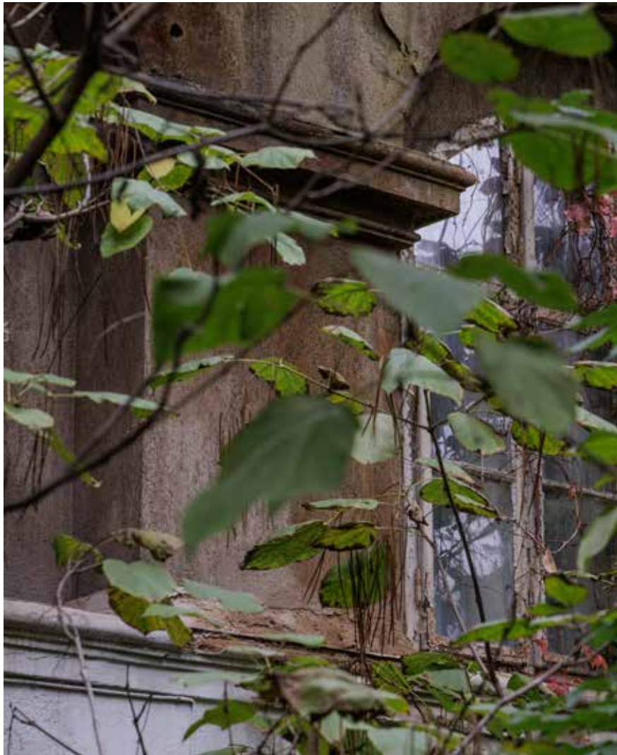
Trijem na dvorišnom pročelju, detalj
