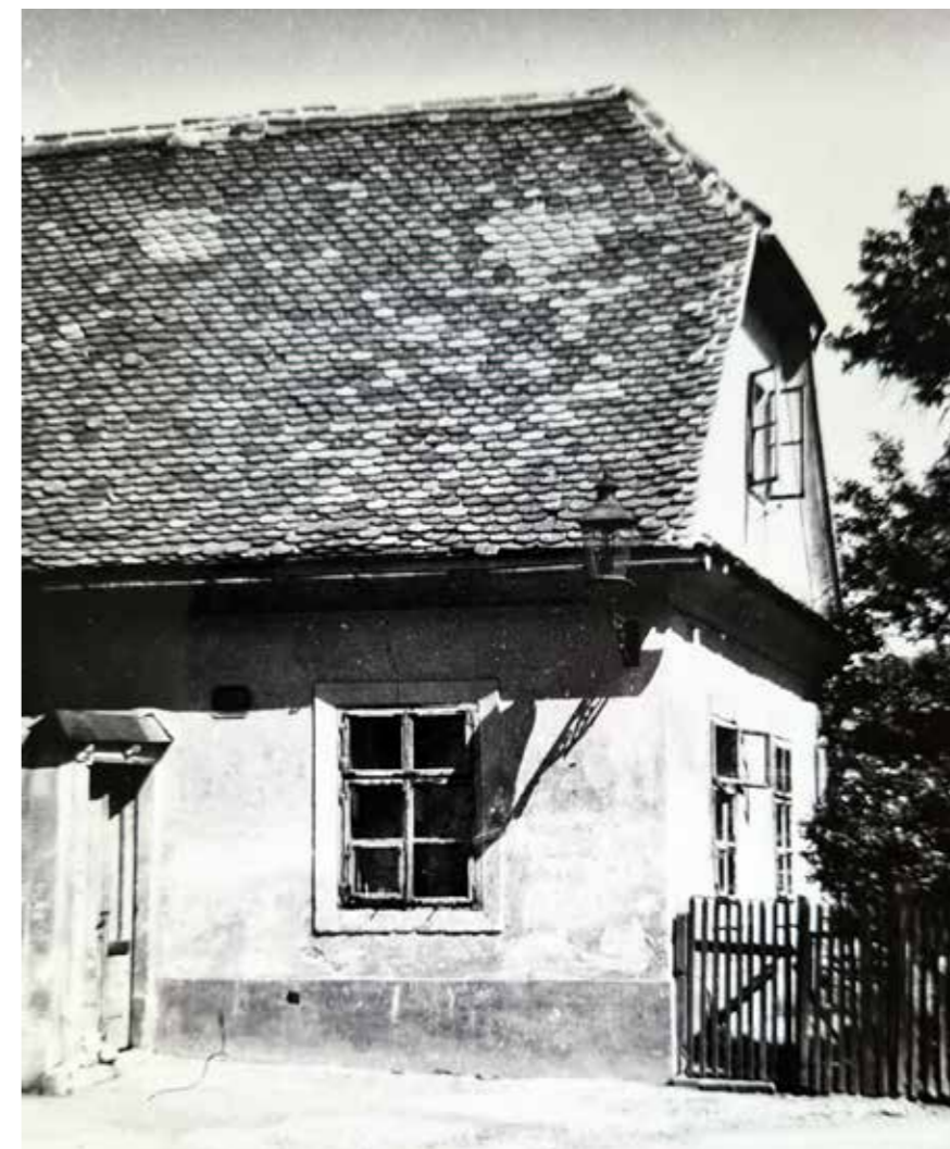
Opatovina 49, ulična kuća prije povišenja, fotografija s početka 20. stoljeća
