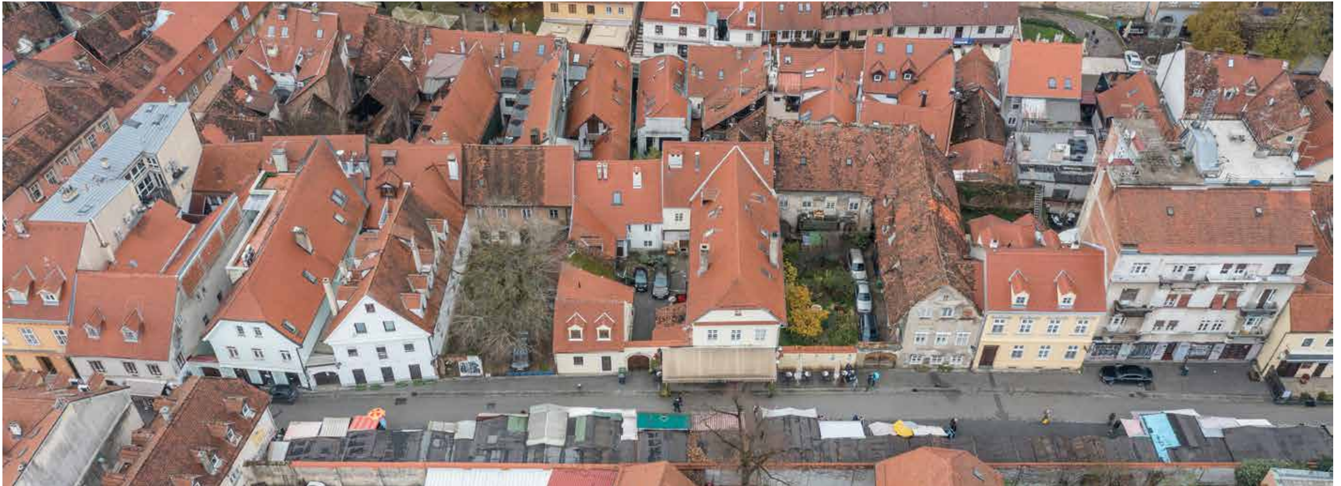
Opatovina, pogled s istoka (kbr. 15–29)
