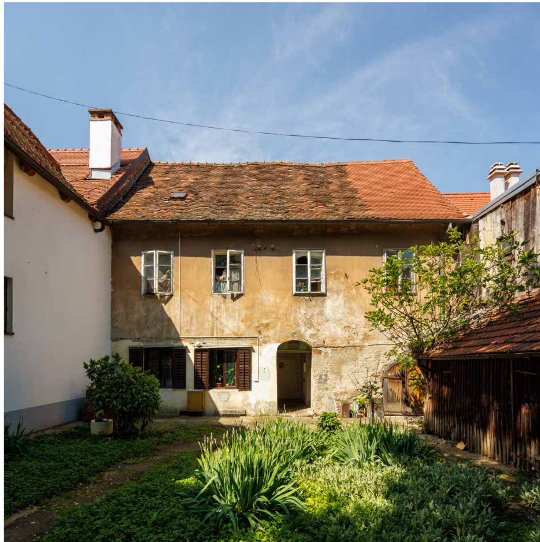
Dvorišna kuća, istočno pročelje
