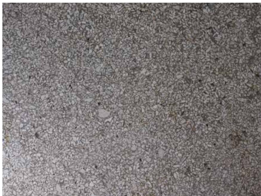
Popločenje poda u stubištu, detalji
