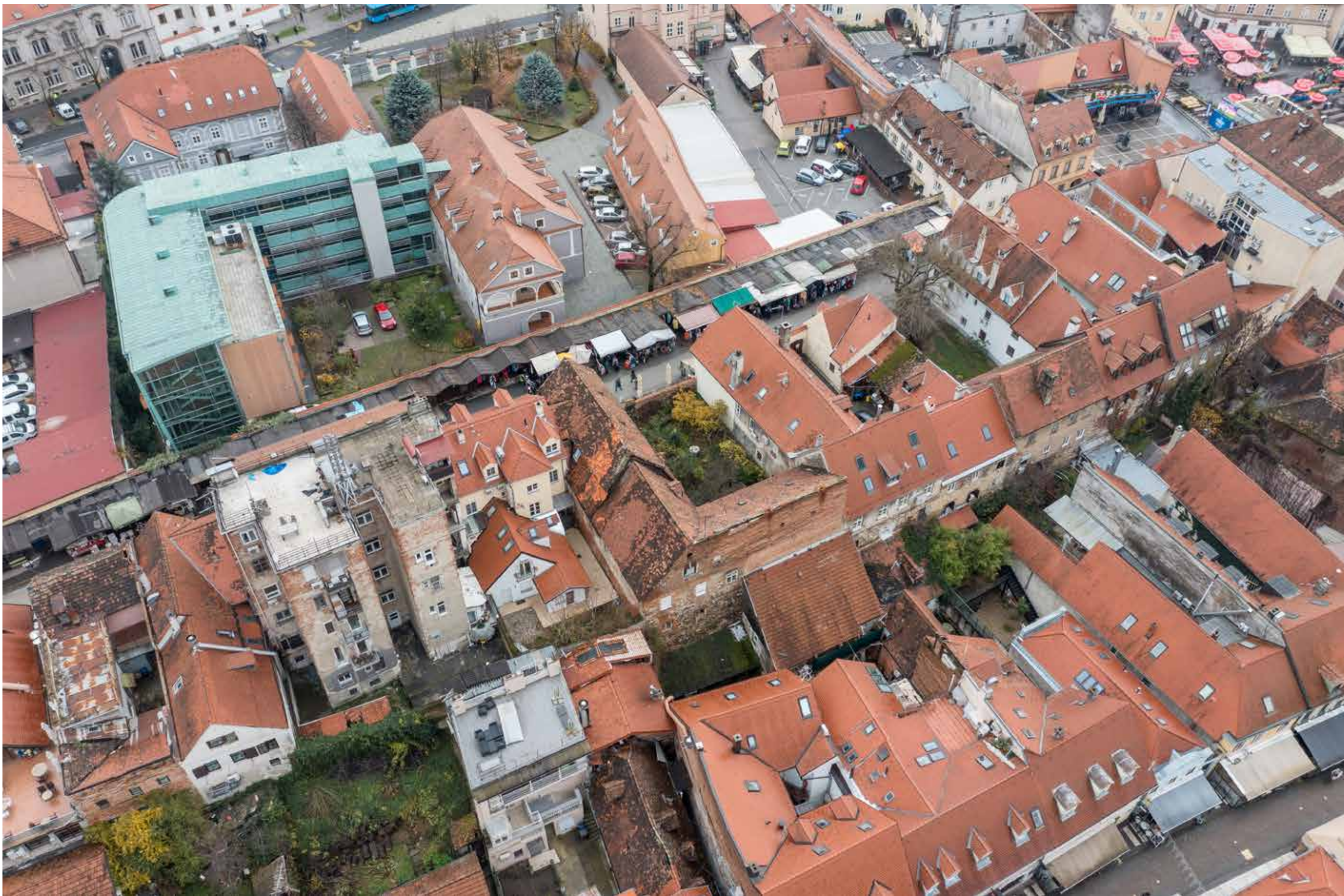
Opatovina, pogled sa zapada (kbr. 33–13)
