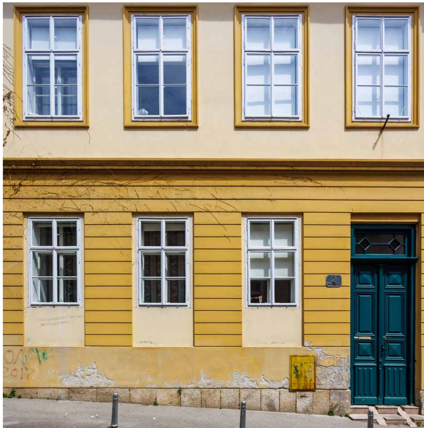
Južno pročelje, detalj
