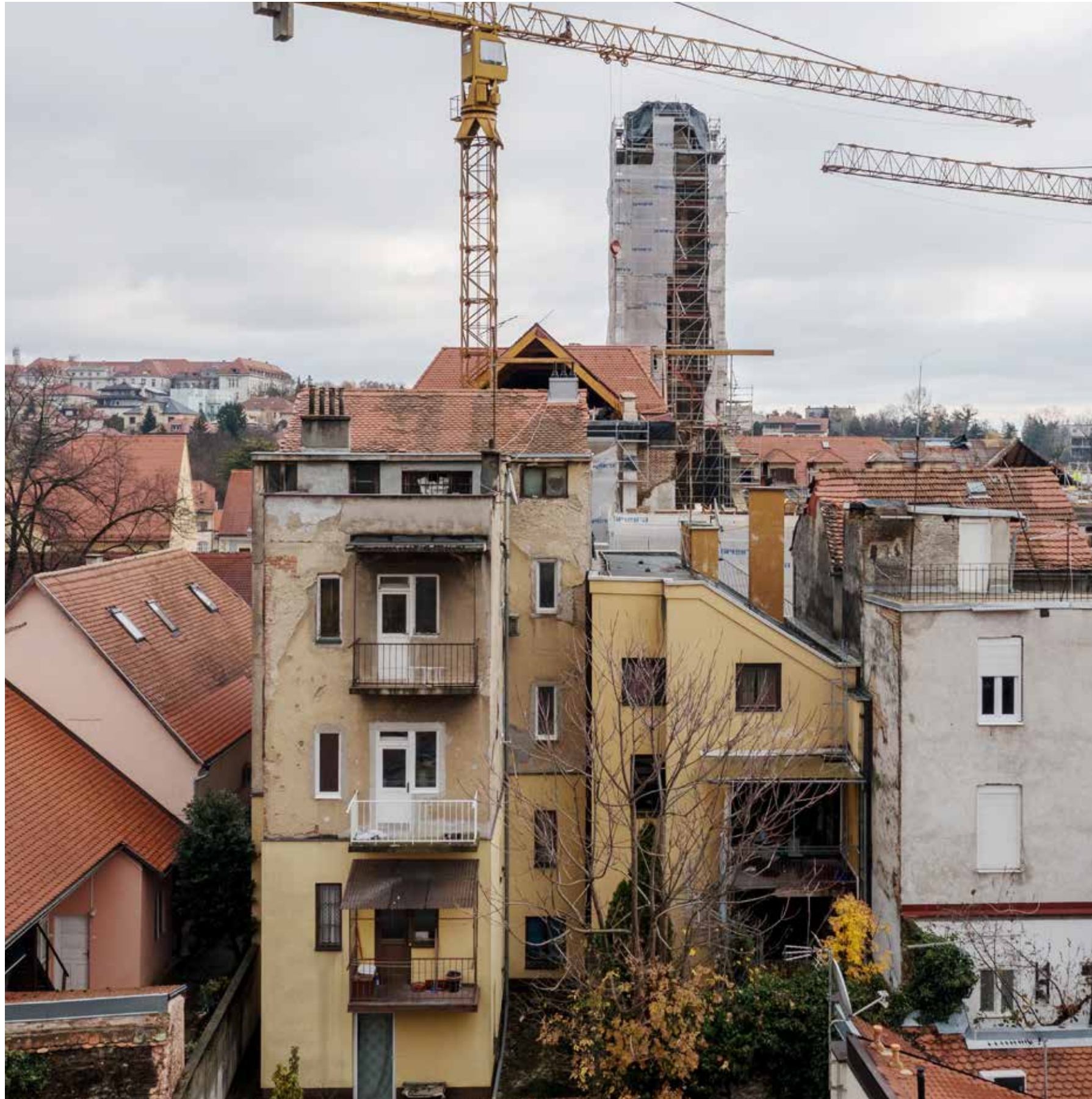
Zapadno začelje poviše gradskog zida
