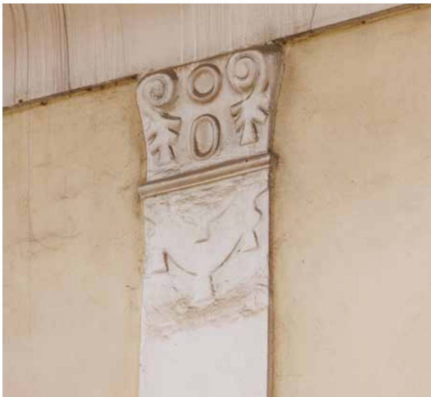
Pročelni pilastar, detalj
