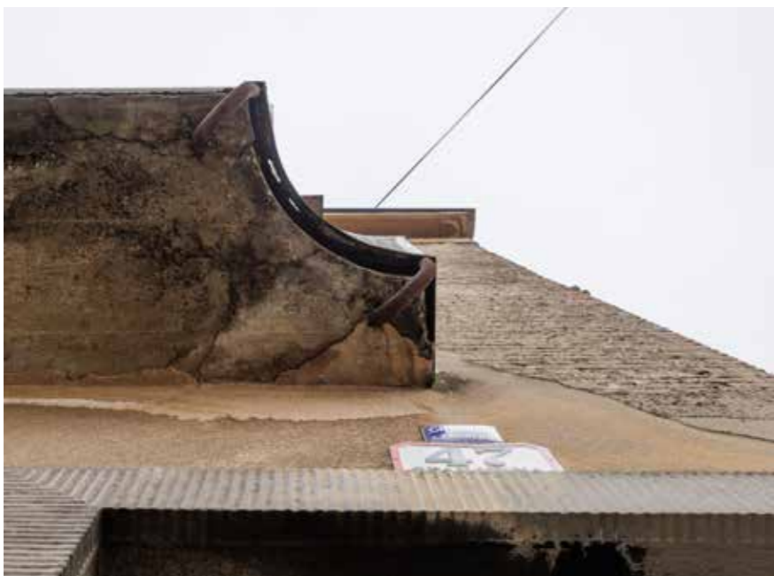
Balkonska ploča, detalj
