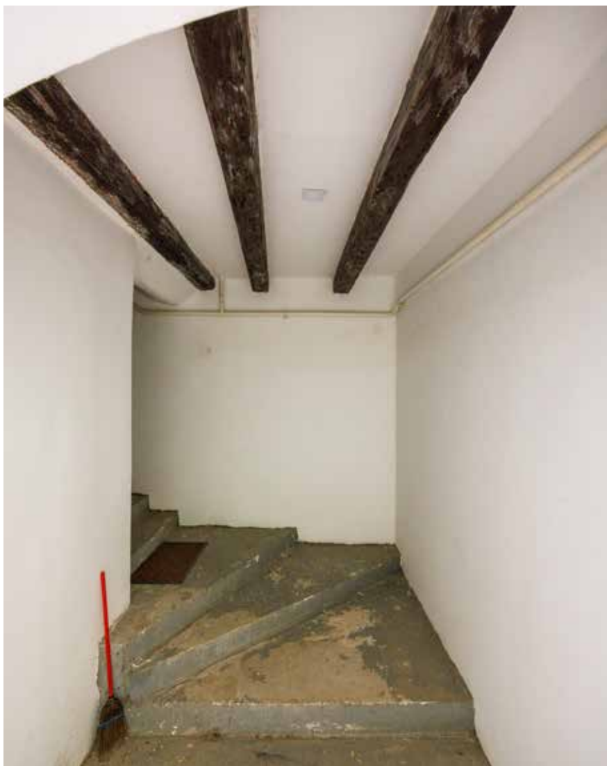
Svod u prizemlju Stubište
