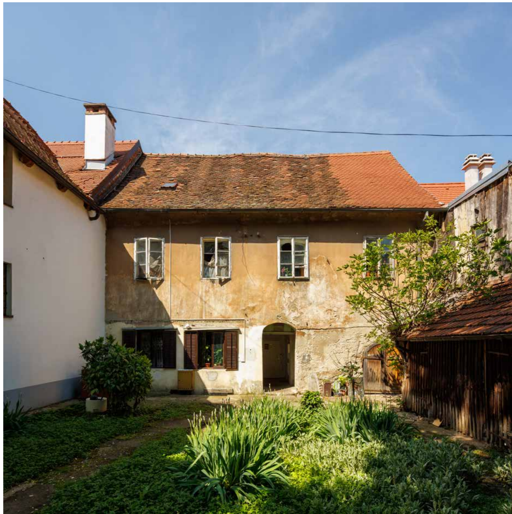
Dvorišna kuća, istočno pročelje
