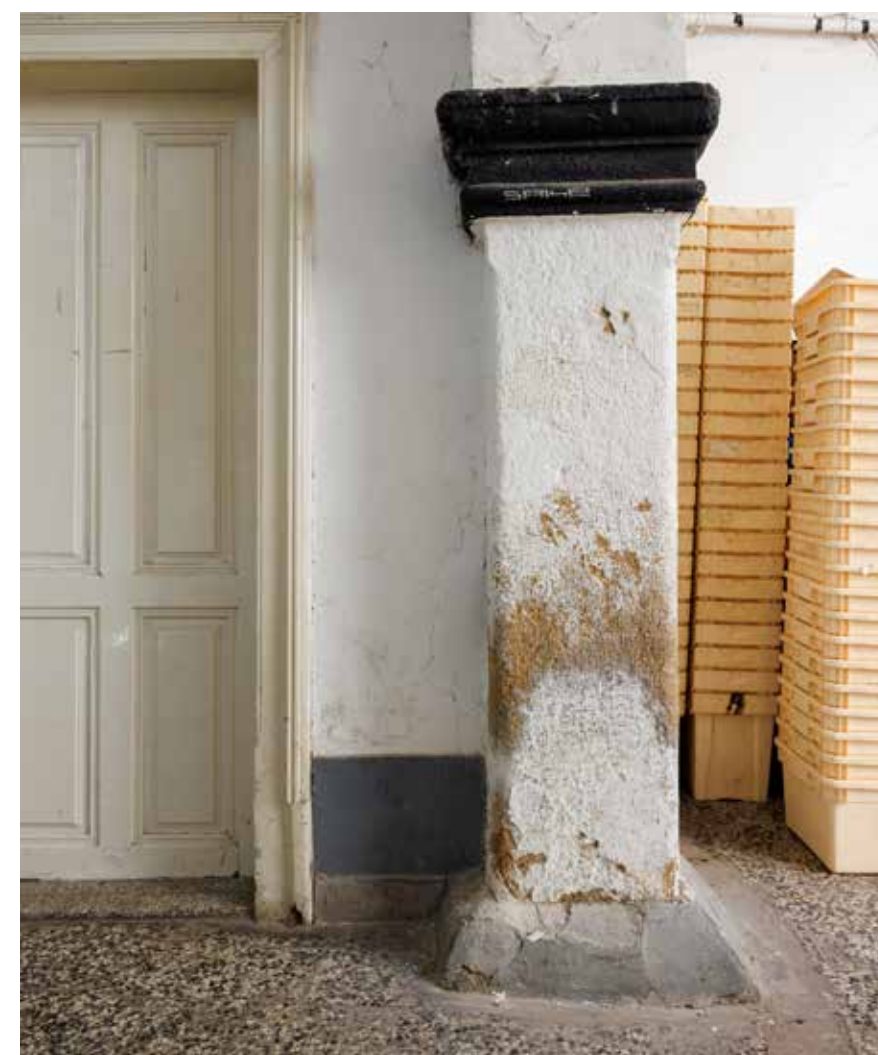
Stupac nekadašnjeg dvorišnog trijema u prizemlju
