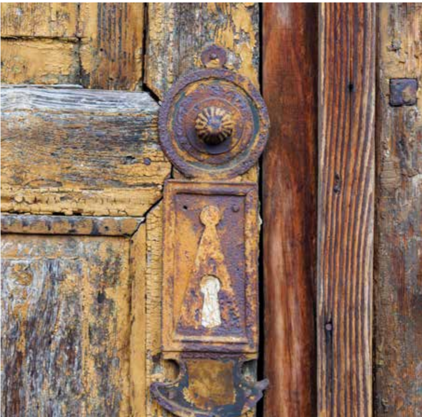
Ulaz u dvorište, detalji vratnica
