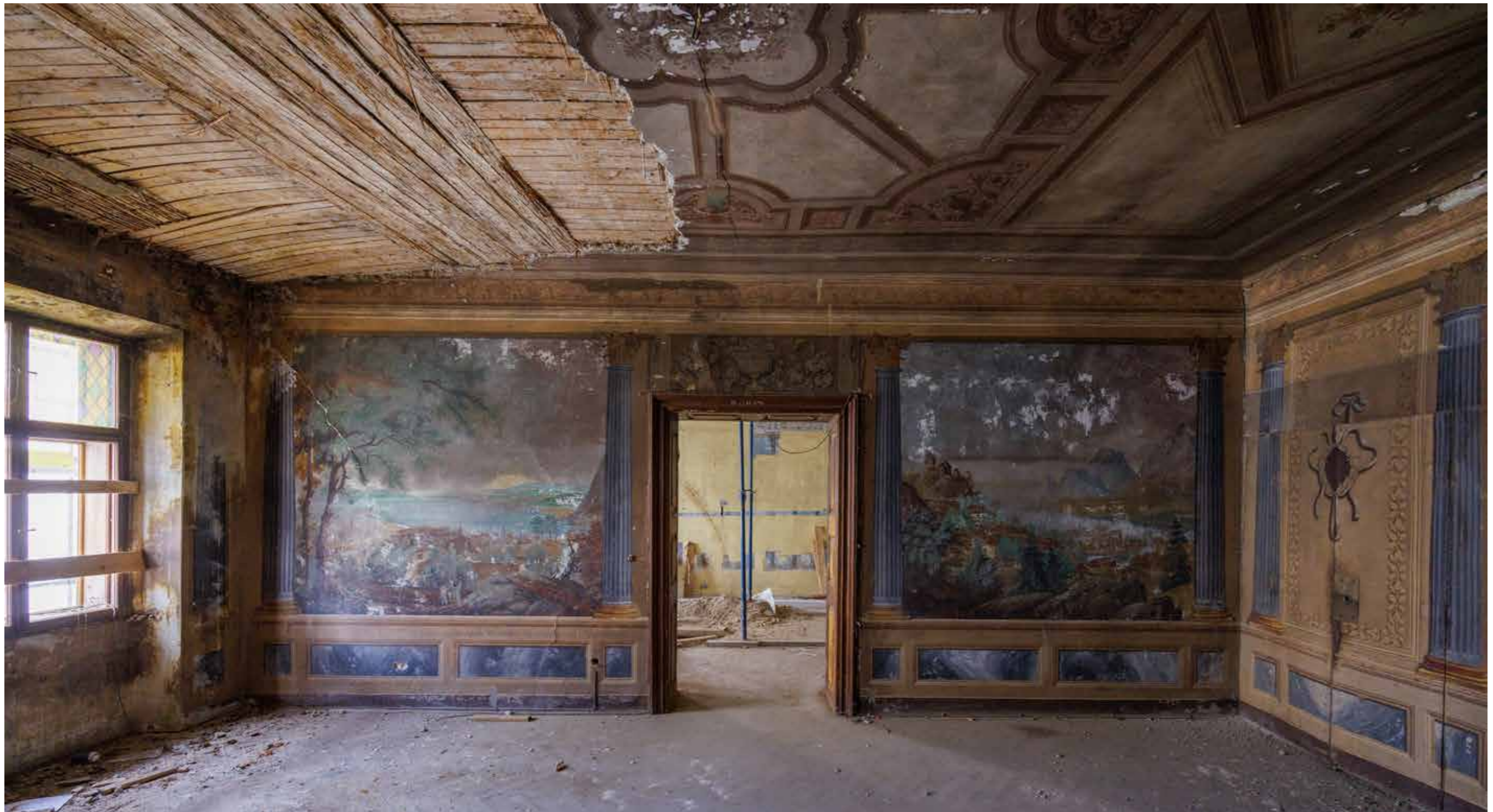
Prostorije na katu sa zidnim slikama
