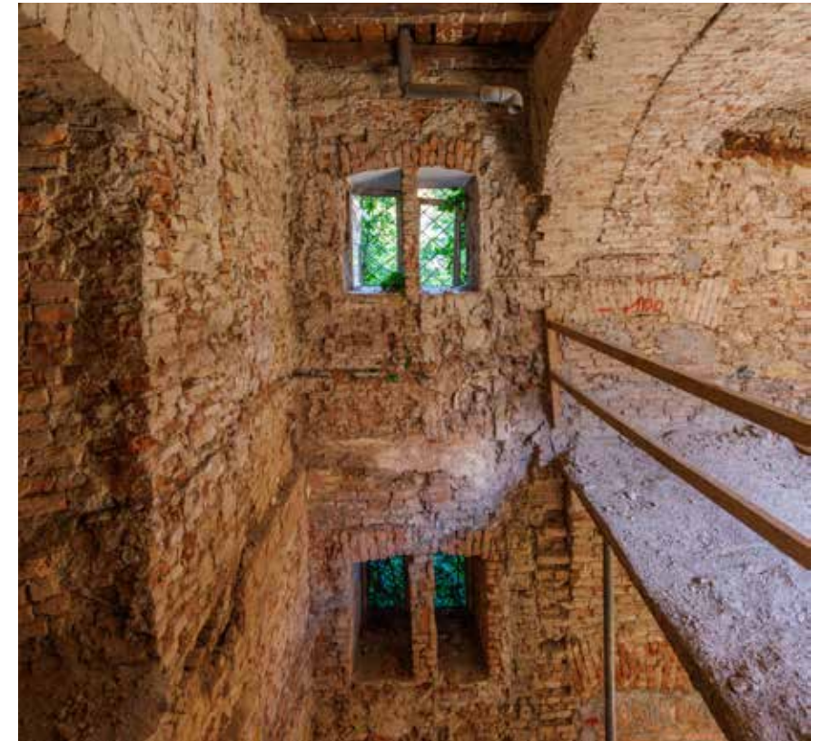
Otvori na katu
