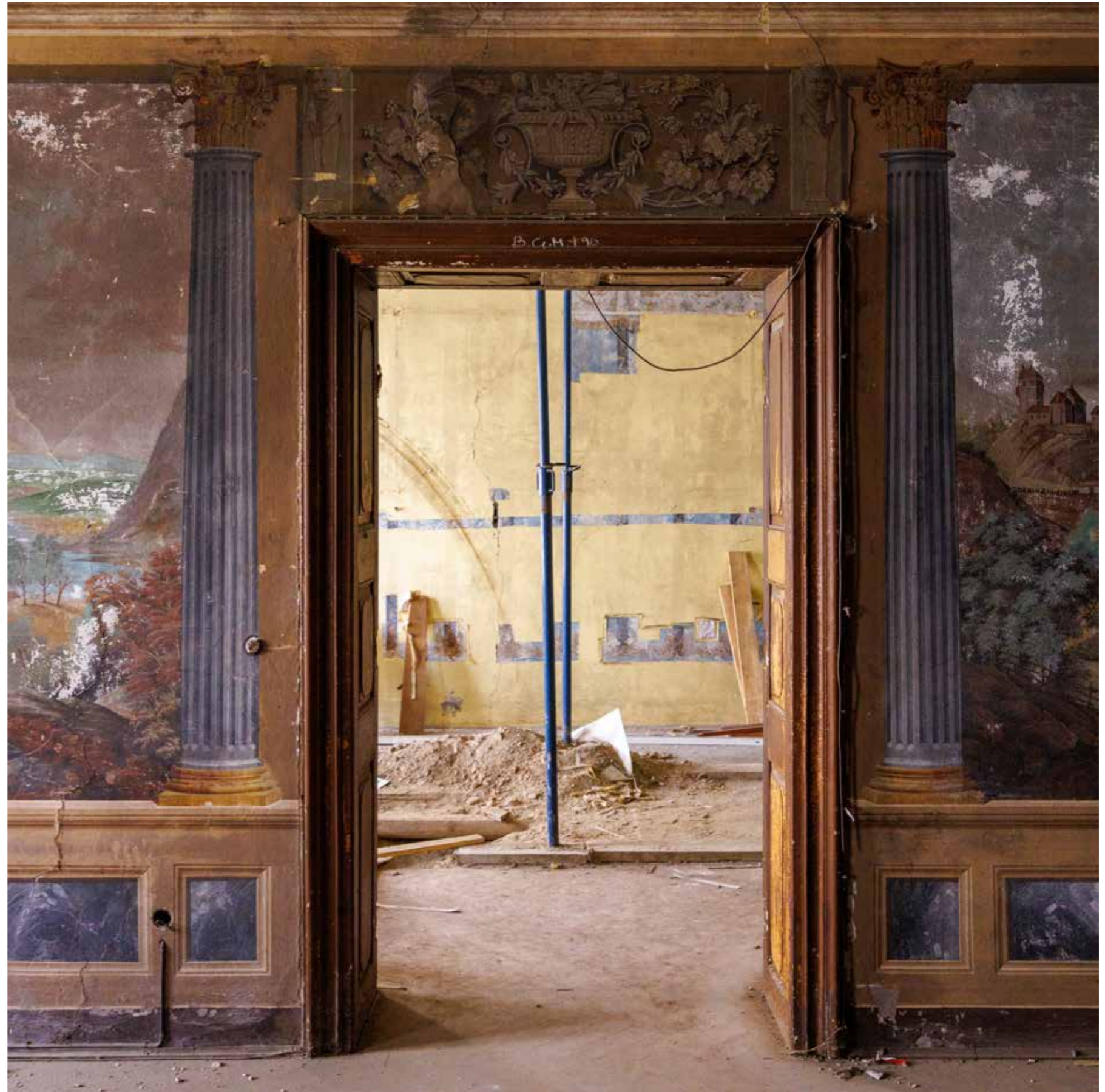
Vrata između dviju oslikanih prostorija na katu
