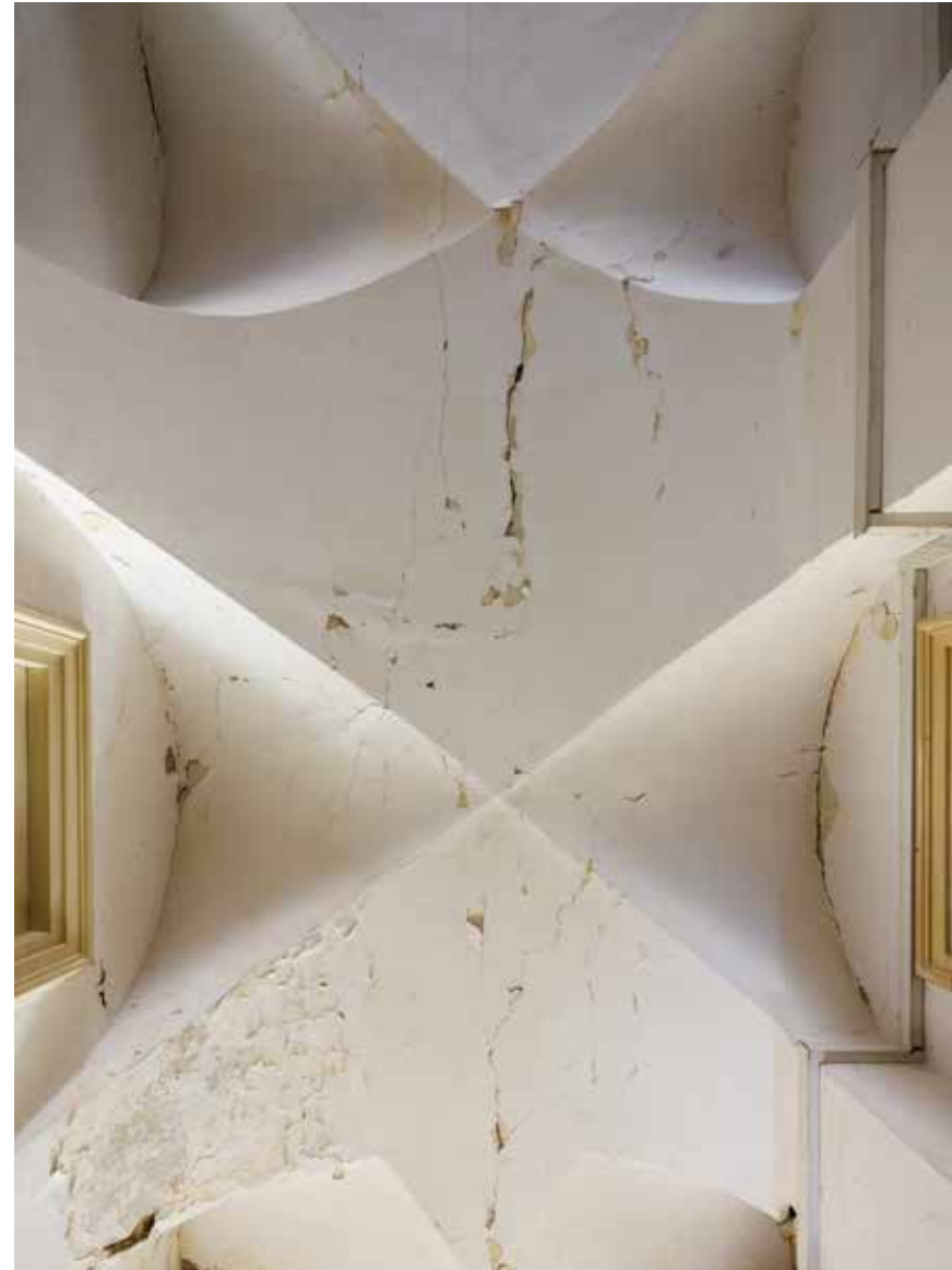
Kuća Miletić (kbr. 11), svodovi u veži
