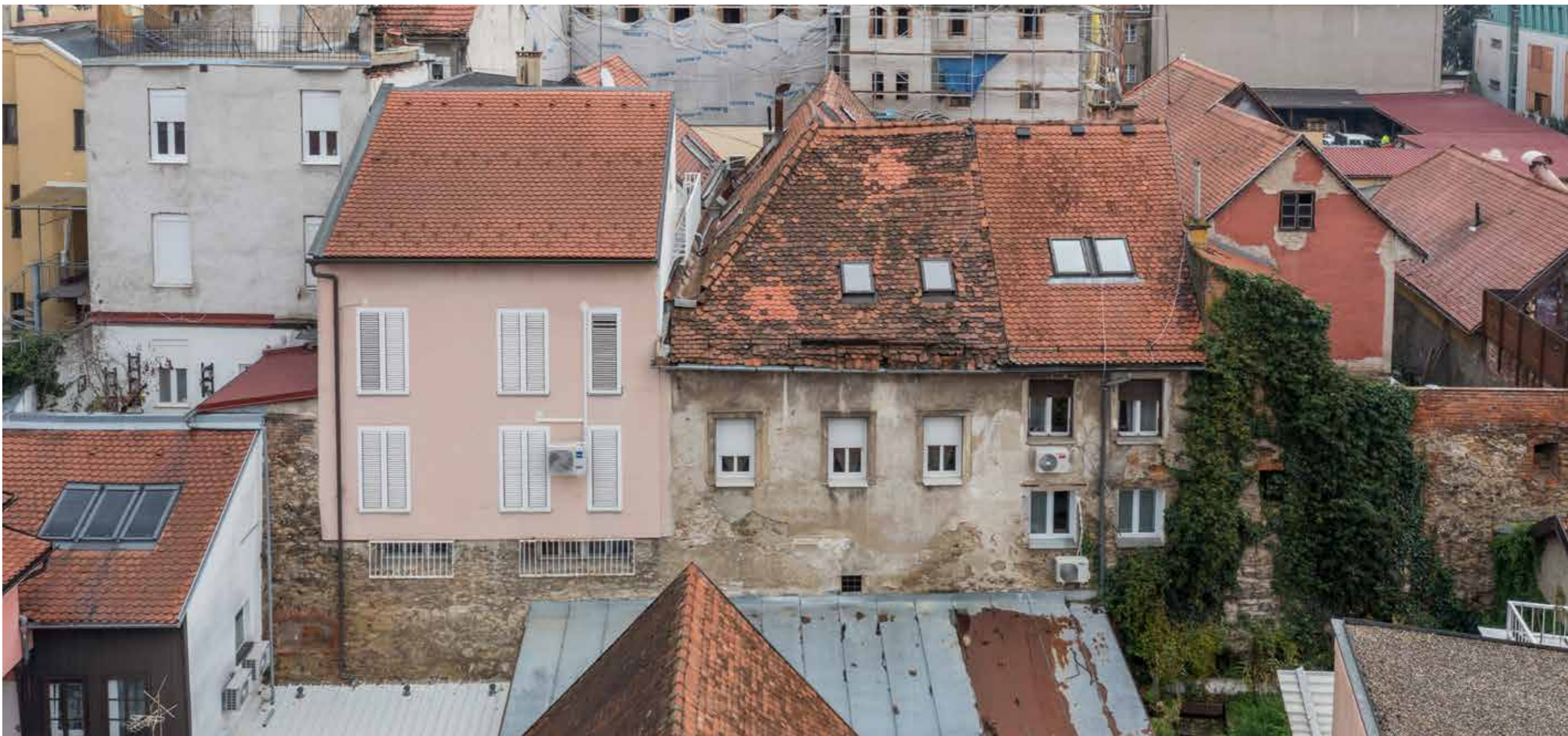
Zapadno začelje na gradskom zidu
