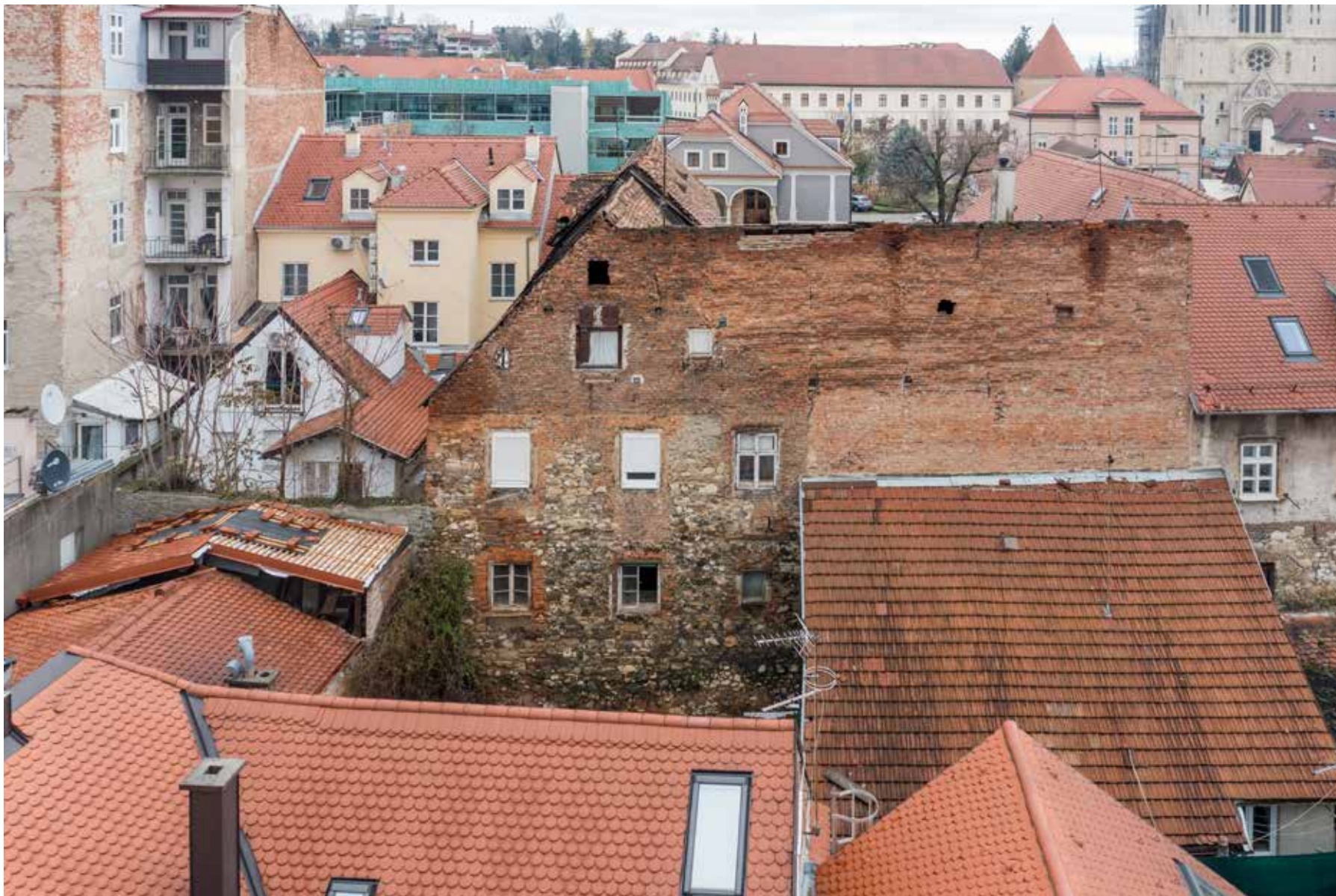
Zapadno začelje na gradskom zidu
