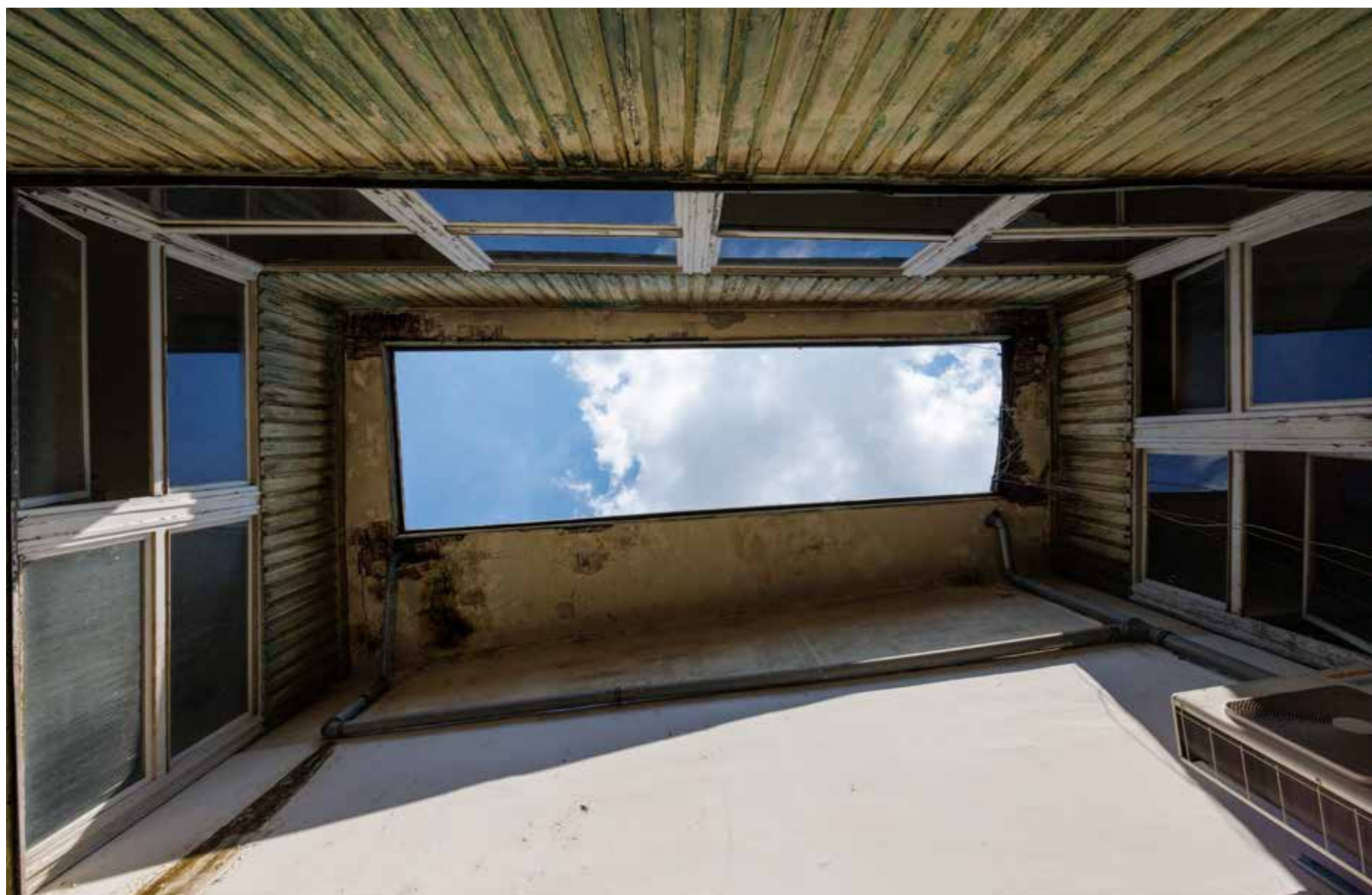
Kuća Miletić, unutarnje dvorište
