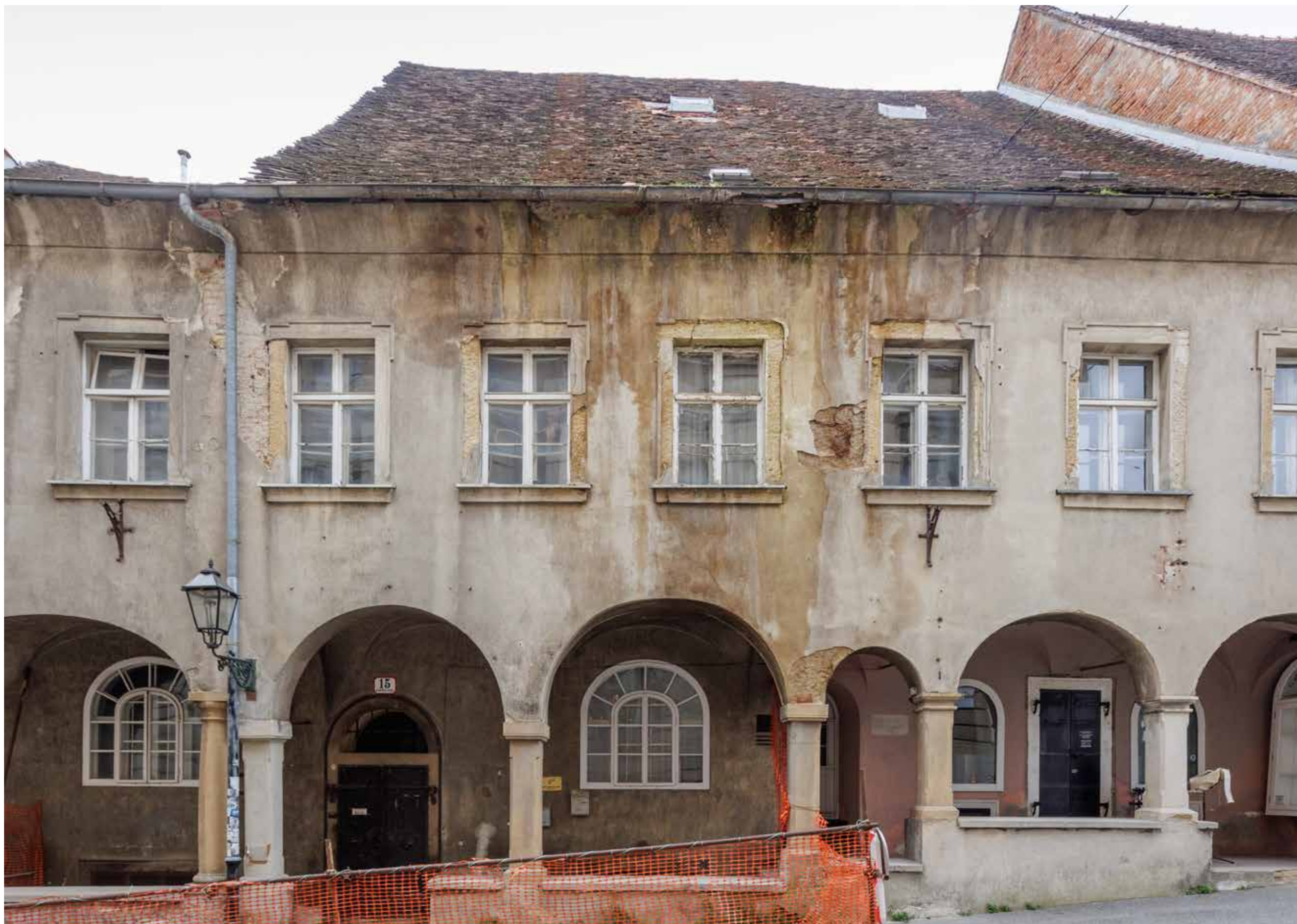
Sjeverno pročelje s trijemom
