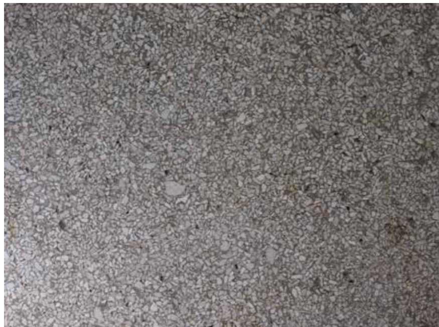
Popločenje poda u stubištu, detalji
