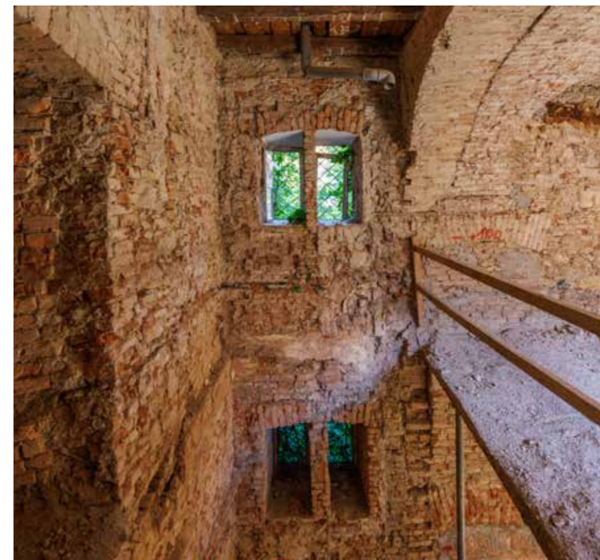
Otvori na katu
