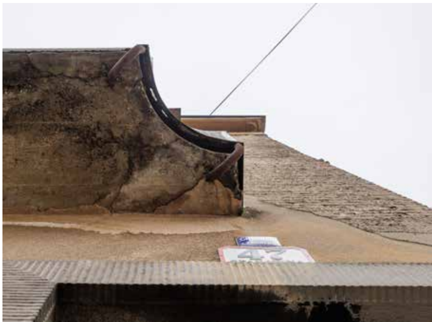
Balkonska ploča, detalj
