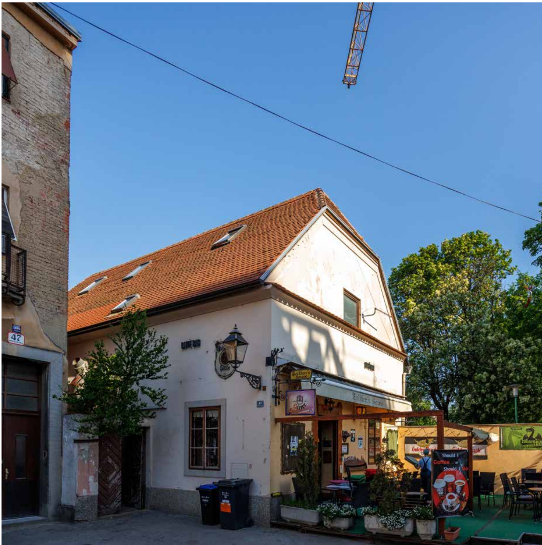
Ulična kuća, južno i istočno pročelje
