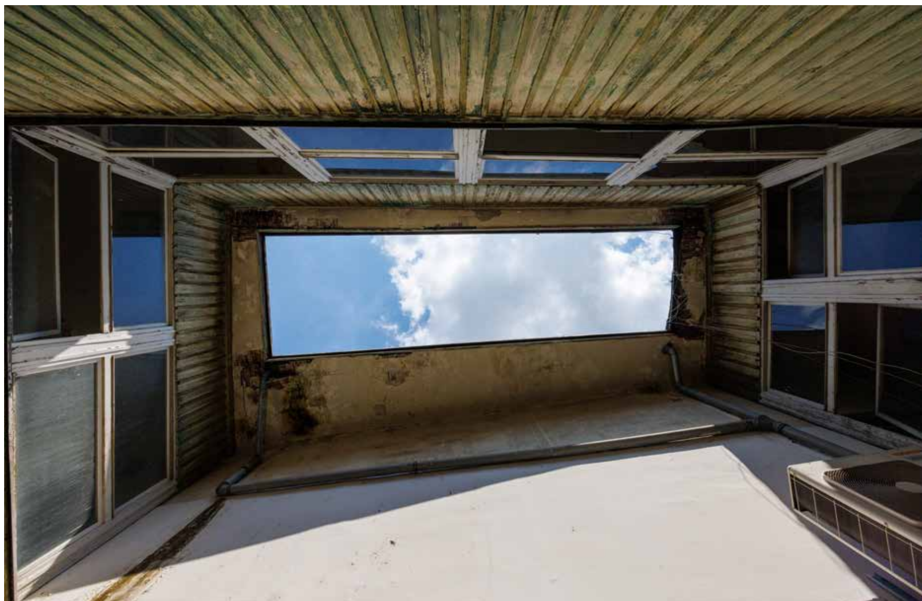
Kuća Miletić, unutarnje dvorište
