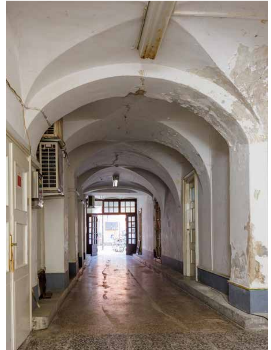
Kuća Miletić, veža
