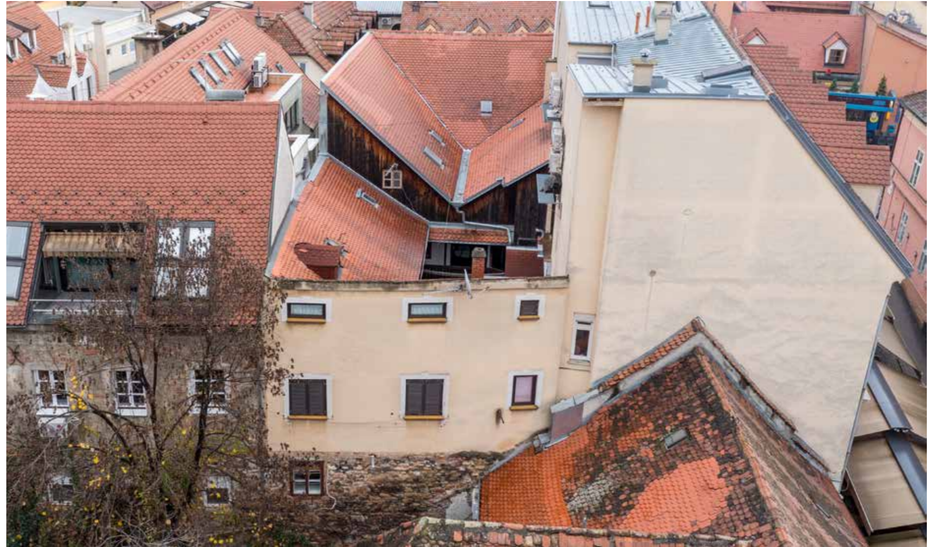
Zapadno začelje na gradskom zidu
