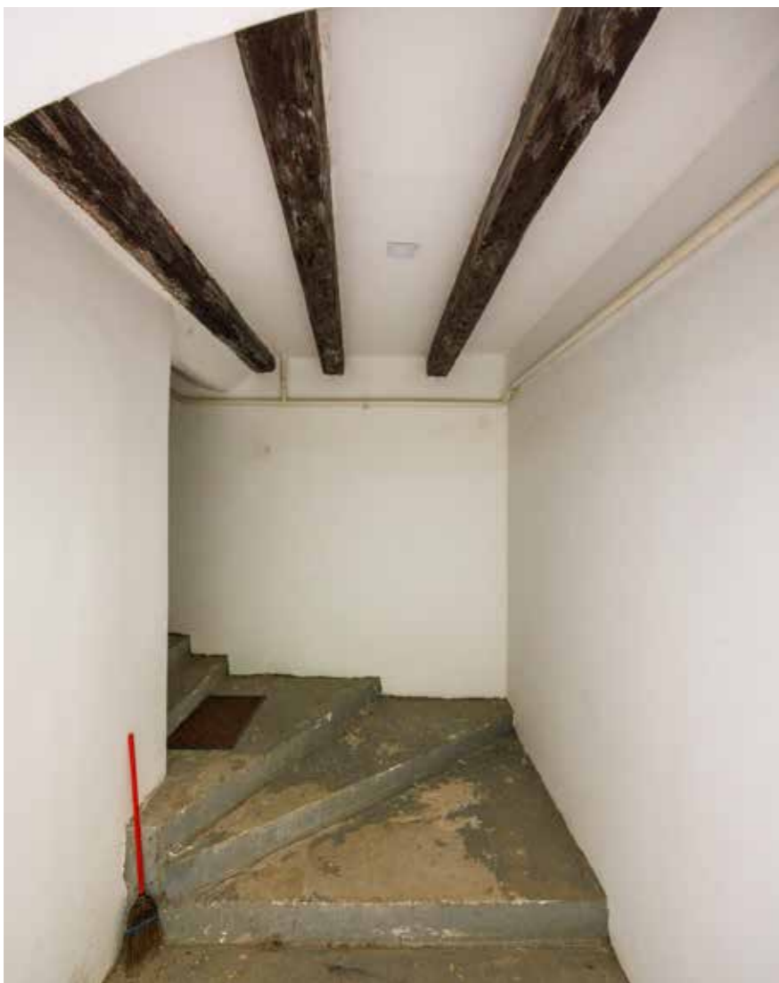
Svod u prizemlju Stubište
