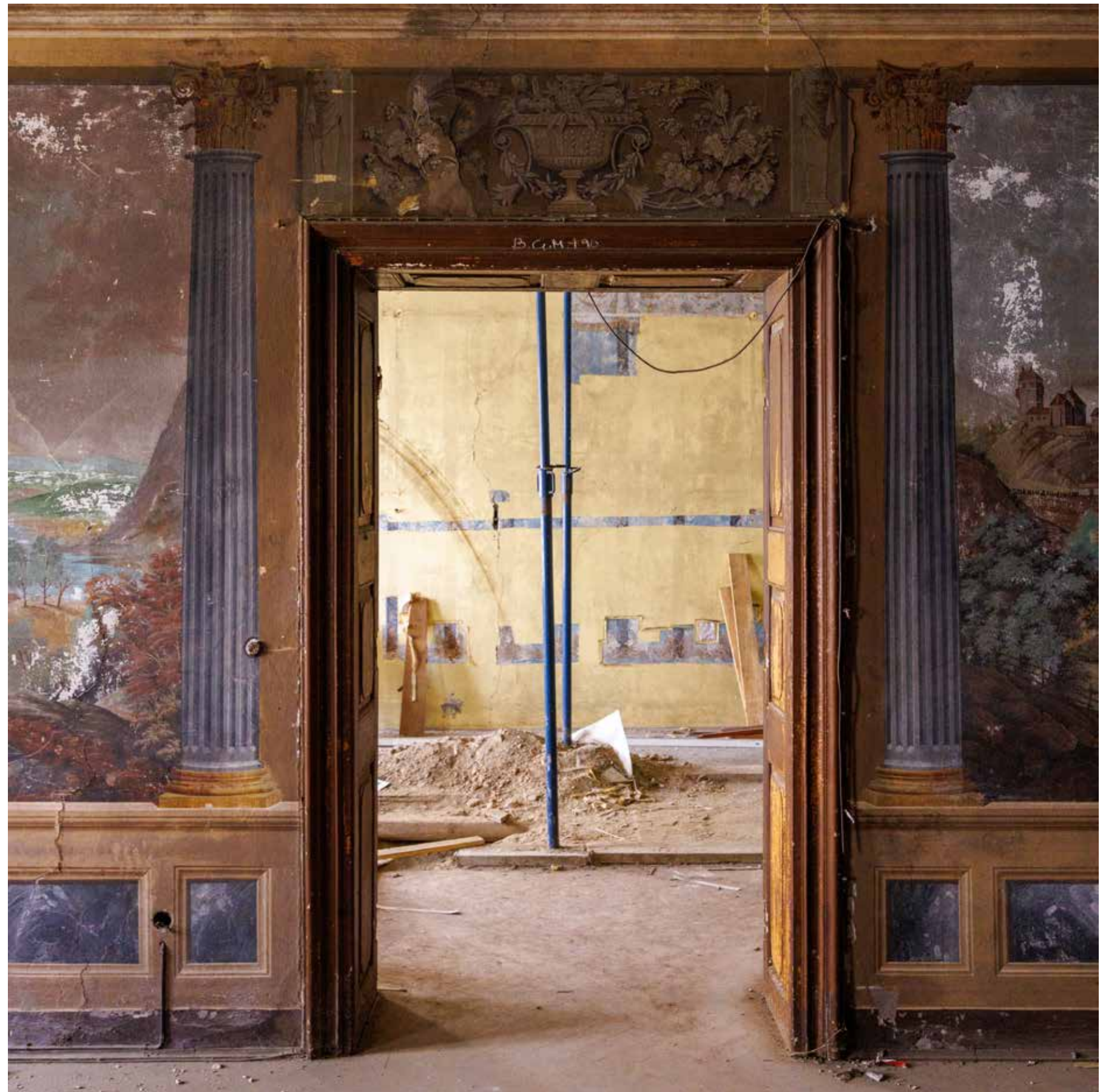
Vrata između dviju oslikanih prostorija na katu
