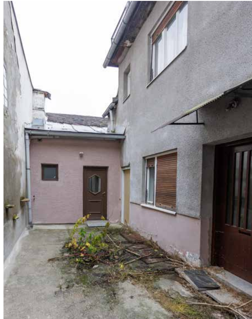
Južno pročelje i prigradnja u dvorištu
