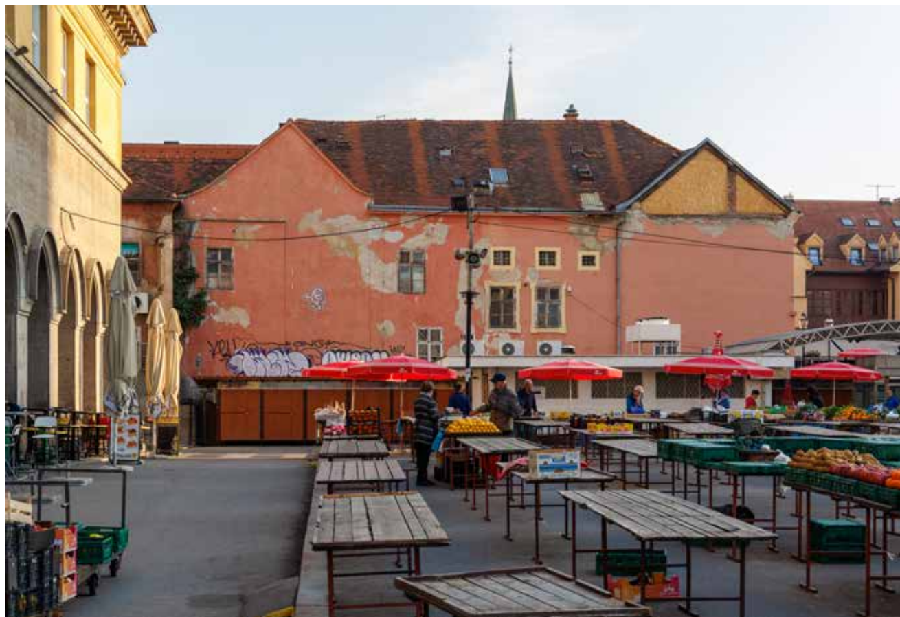
Južno pročelje (oslobođeno rušenjem kuća na Dolcu 1925.)
