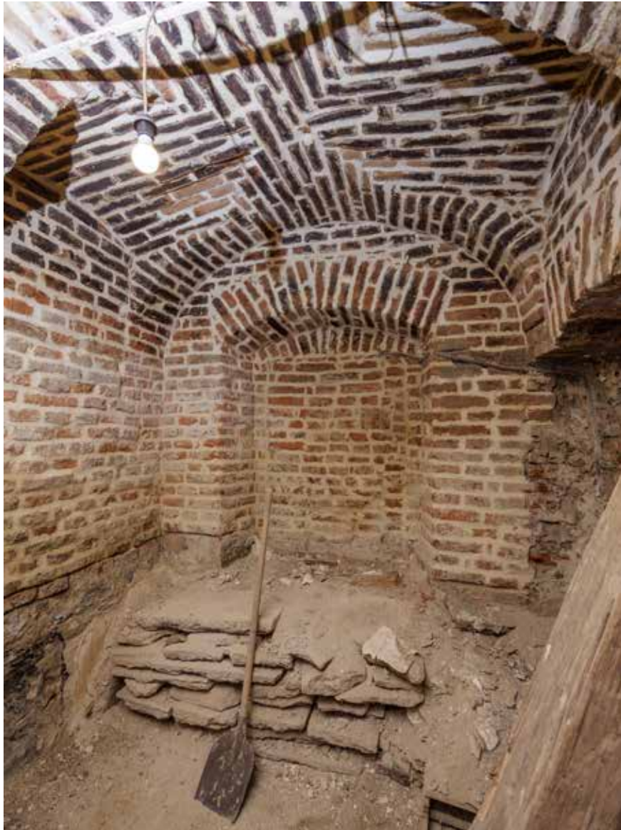
Kuća Fuchs-Devidé (kbr. 25), nadsvođena prostorija u podrumu
