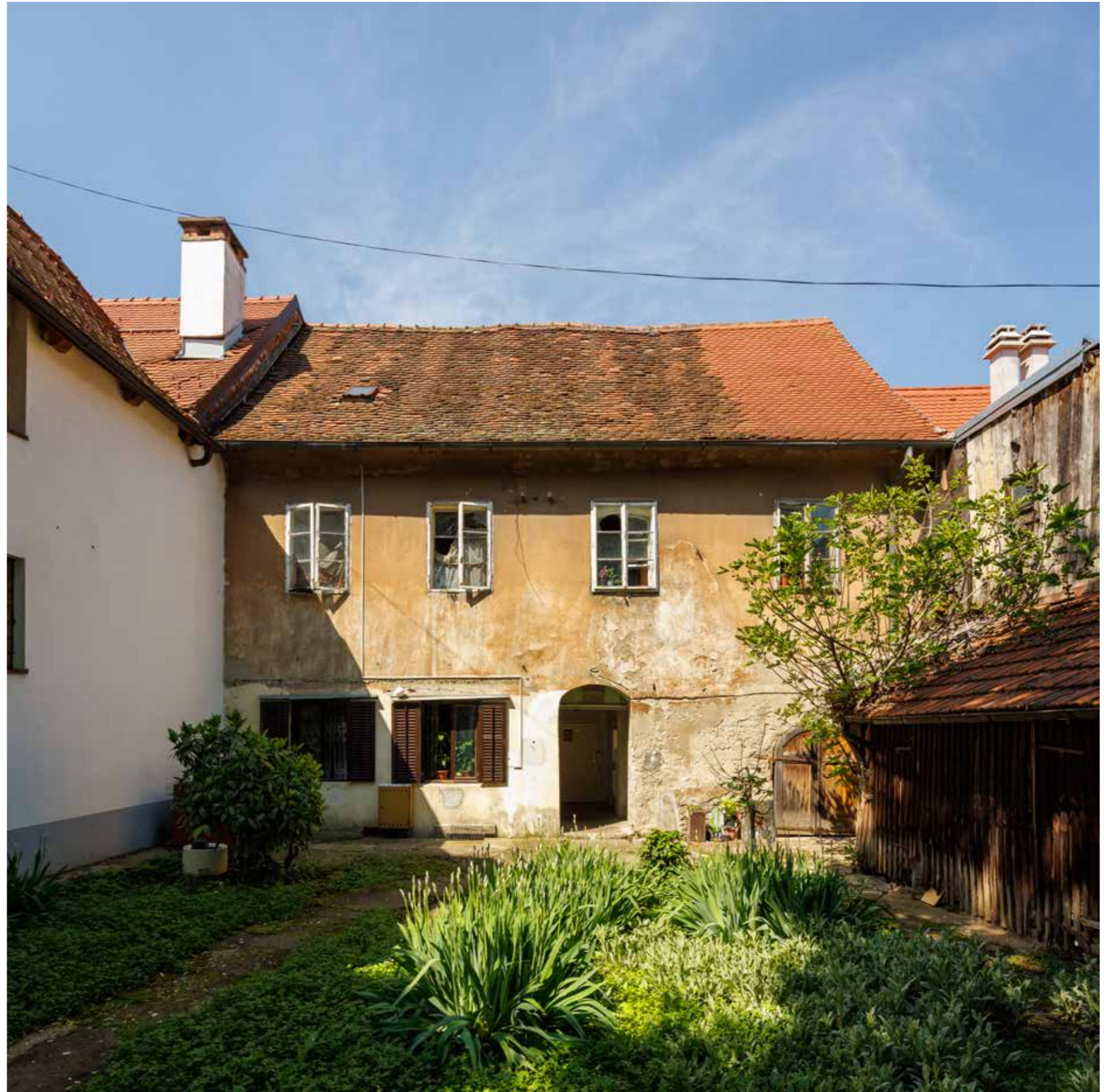
Dvorišna kuća, istočno pročelje
