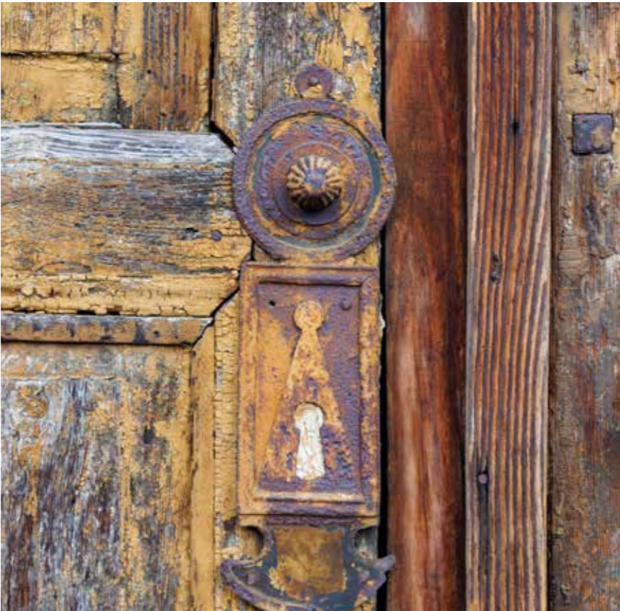
Ulaz u dvorište, detalji vratnica
