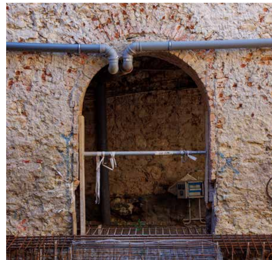
Detalj smanjenoga lučnog otvora trijema u prizemlju
