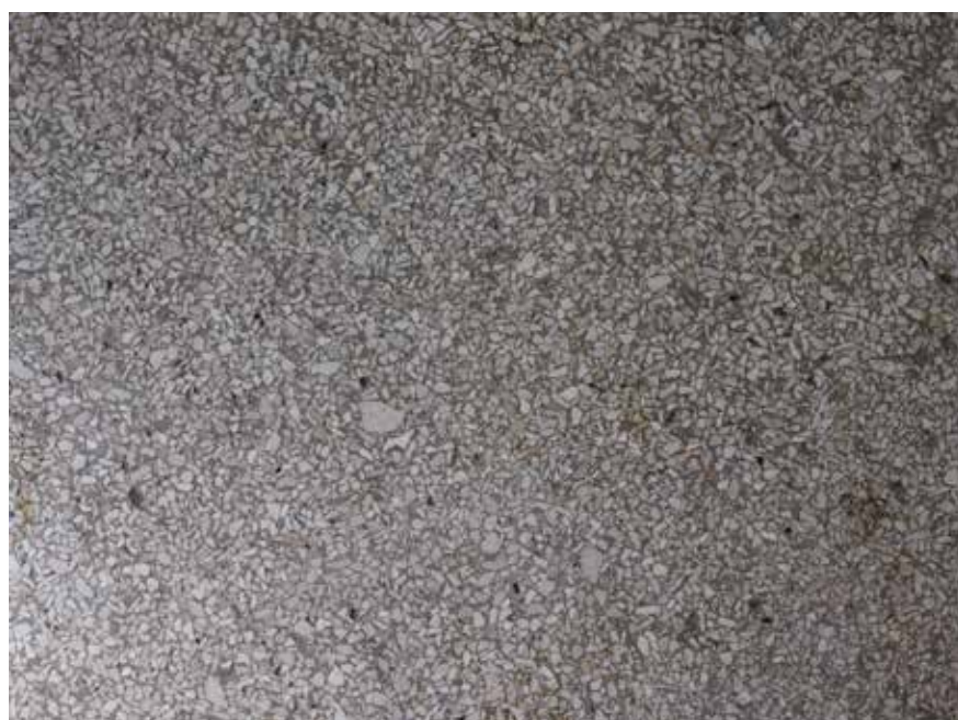
Popločenje poda u stubištu, detalji
