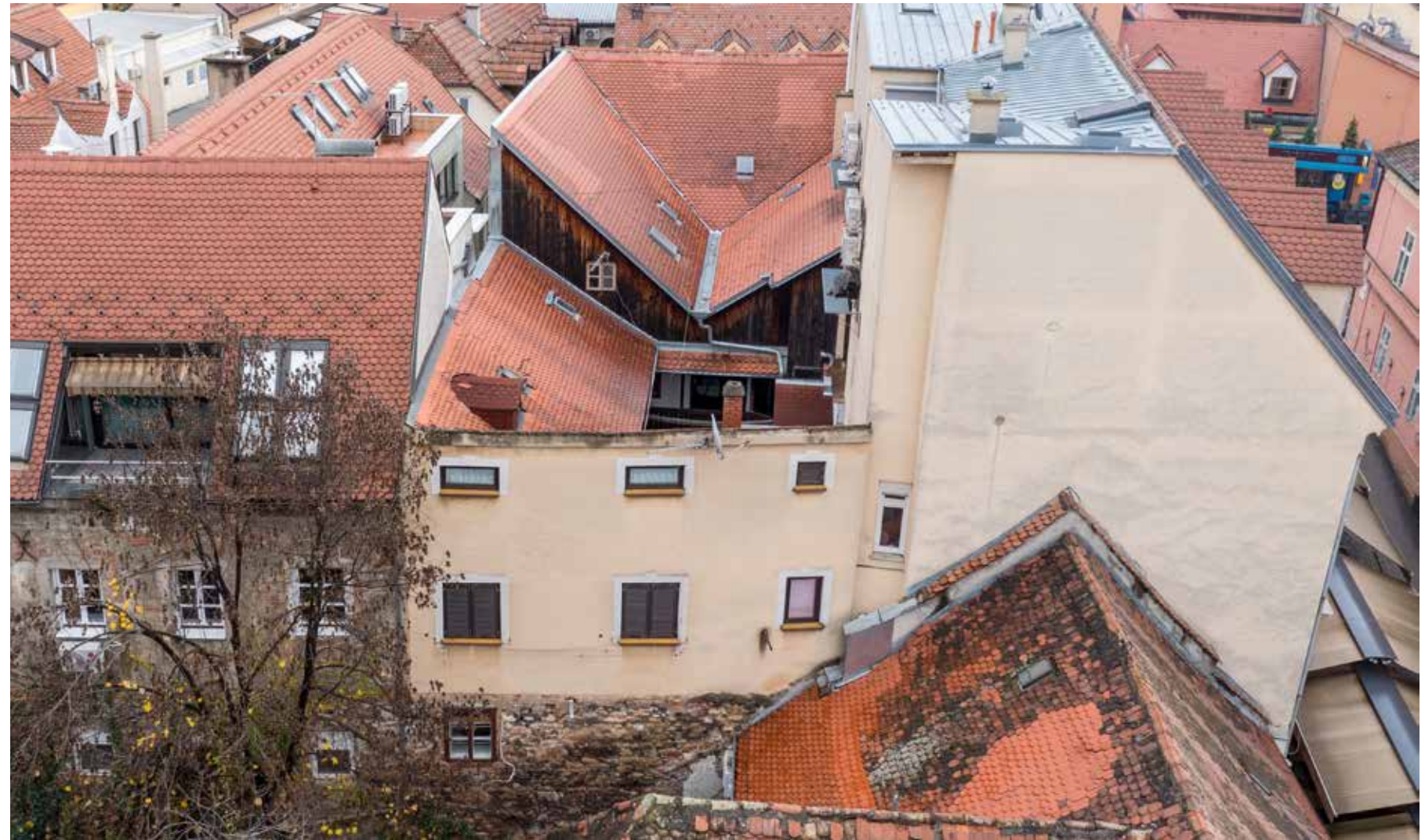
Zapadno začelje na gradskom zidu
