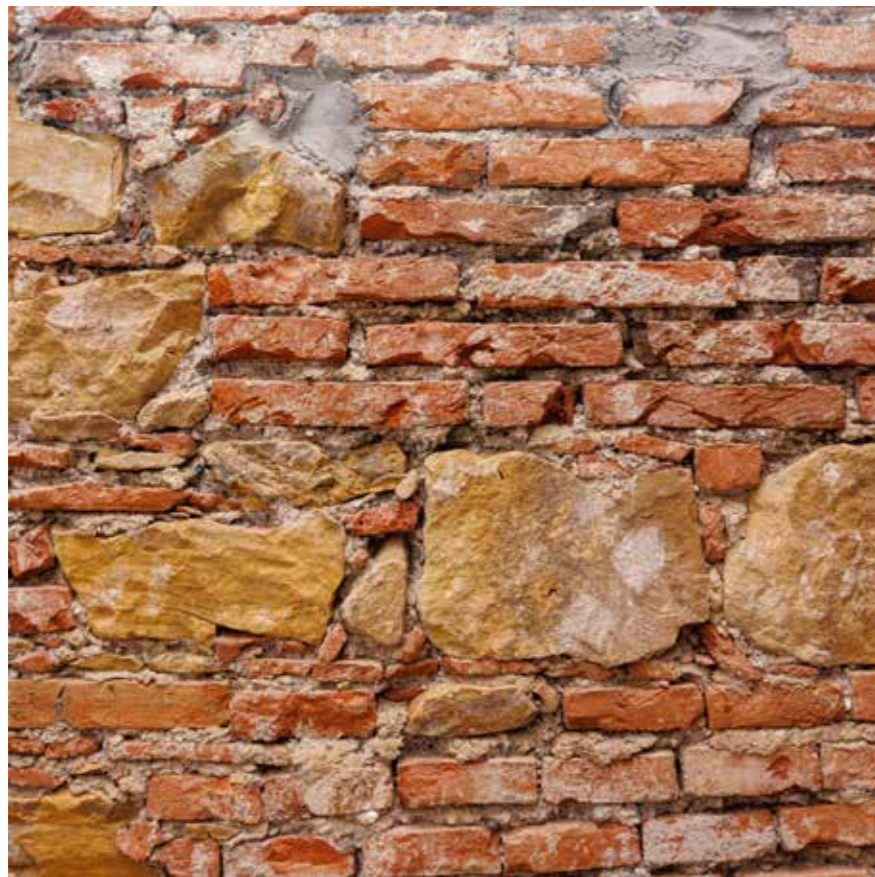
Detalji zida i svoda
