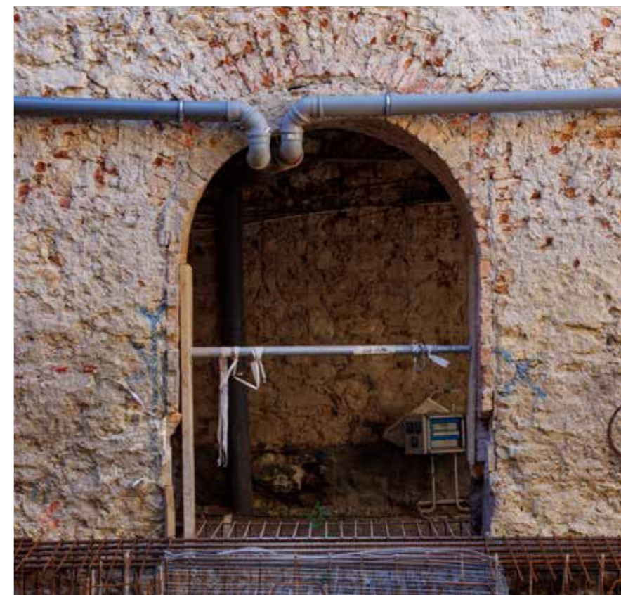
Detalj smanjenoga lučnog otvora trijema u prizemlju
