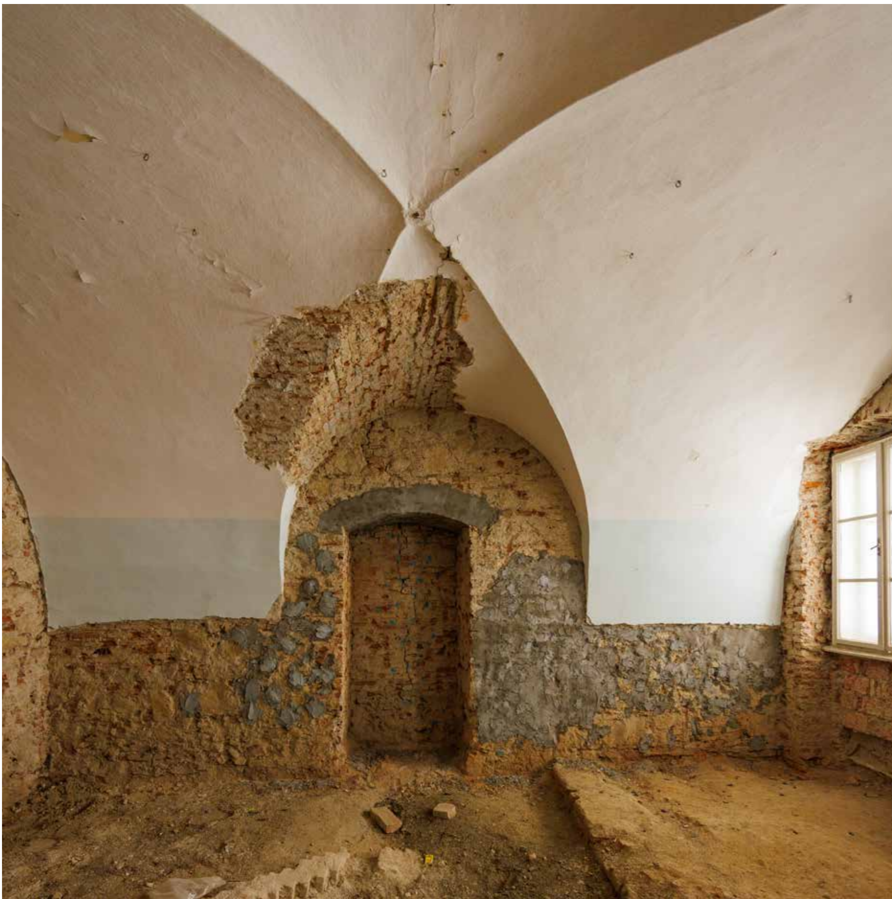
Svod u prizemlju
