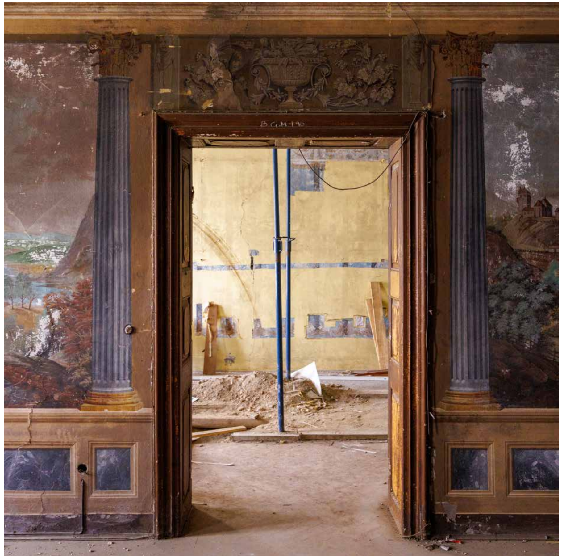
Vrata između dviju oslikanih prostorija na katu
