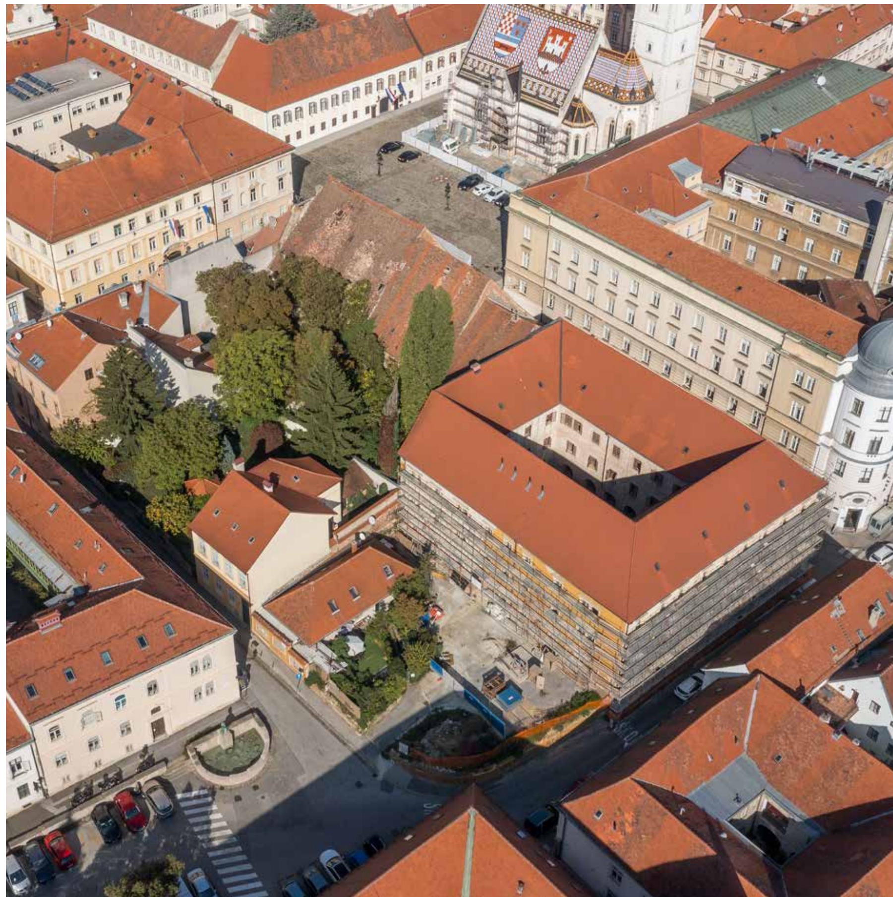
Blok 11, pogled s jugoistoka
