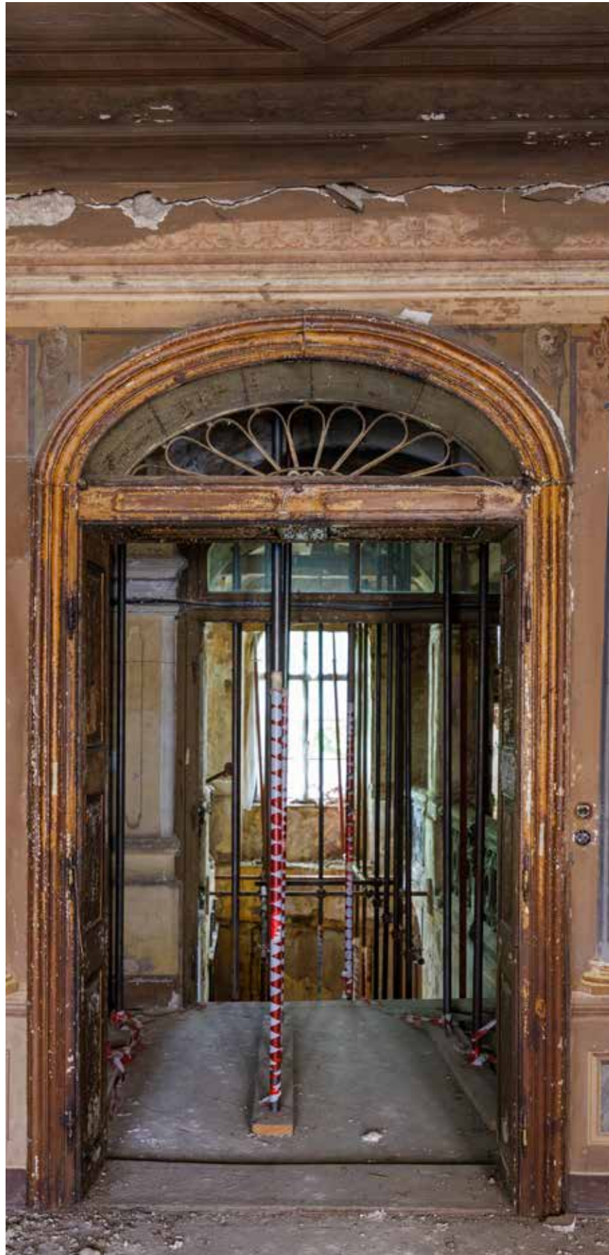
Vrata prema stubištu
