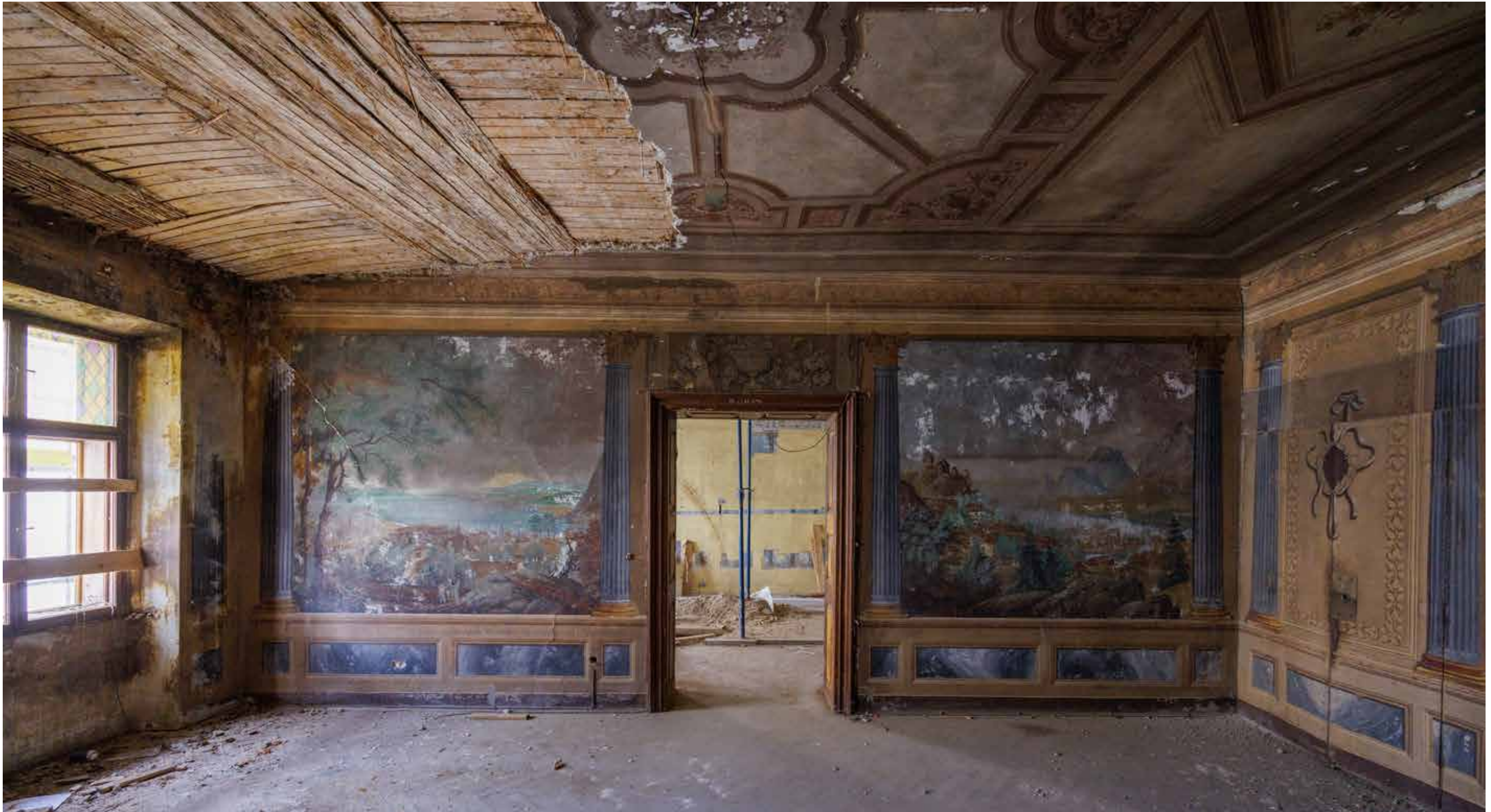
Prostorije na katu sa zidnim slikama
