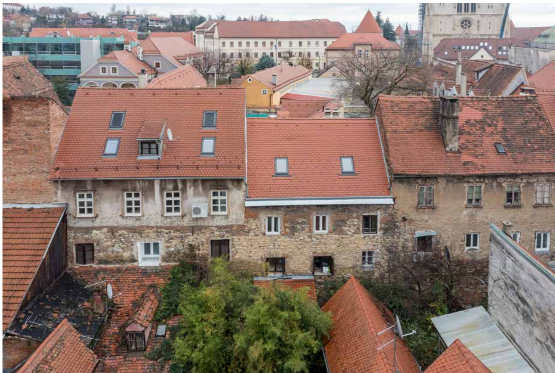
Zapadno začelje na gradskom zidu
