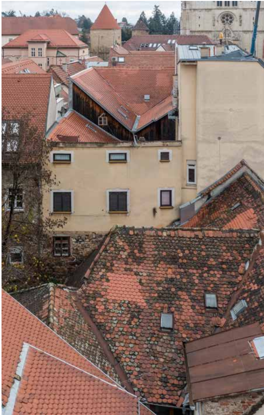
Zapadno začelje na gradskom zidu
