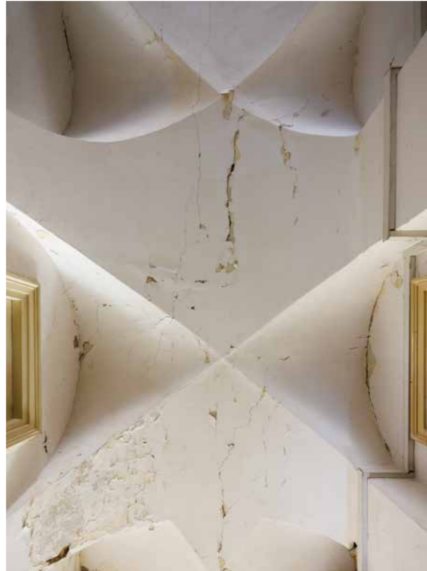
Kuća Miletić (kbr. 11), svodovi u veži
