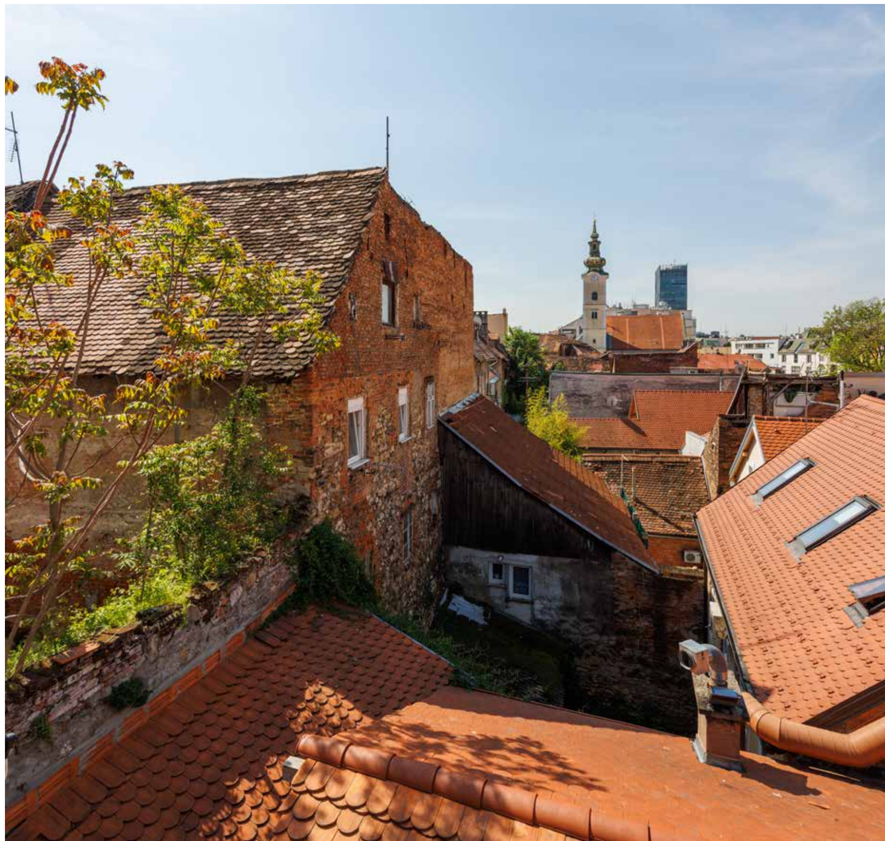
Zapadni gradski zid Kaptola
