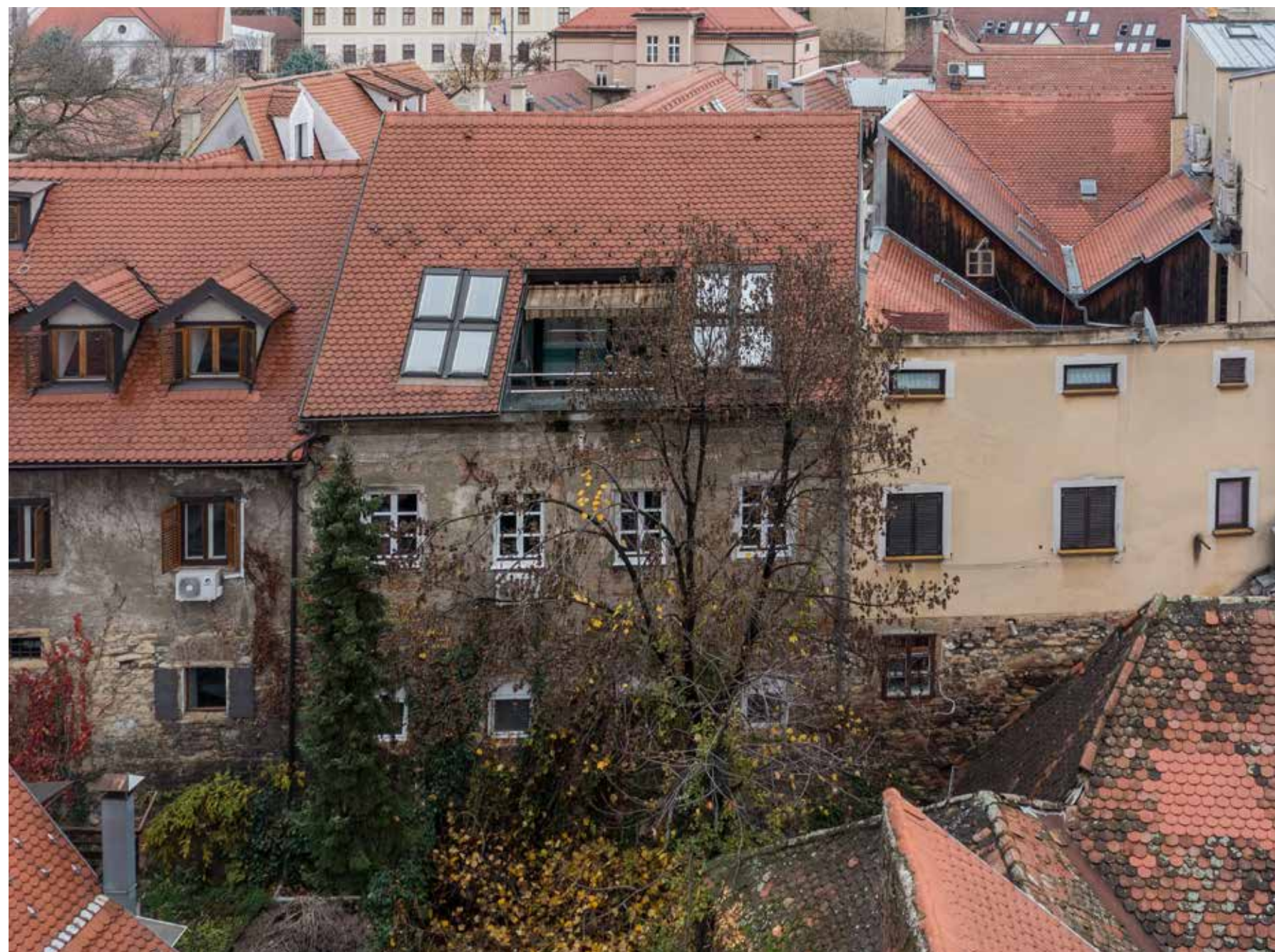
Zapadno začelje na gradskom zidu
