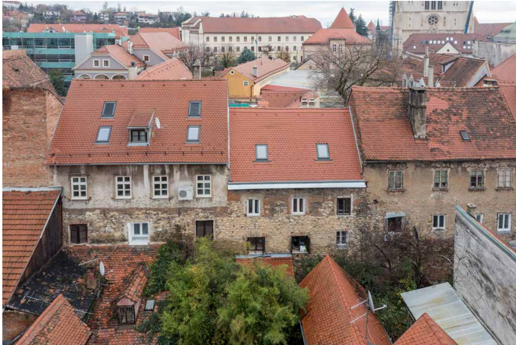
Zapadno začelje na gradskom zidu
