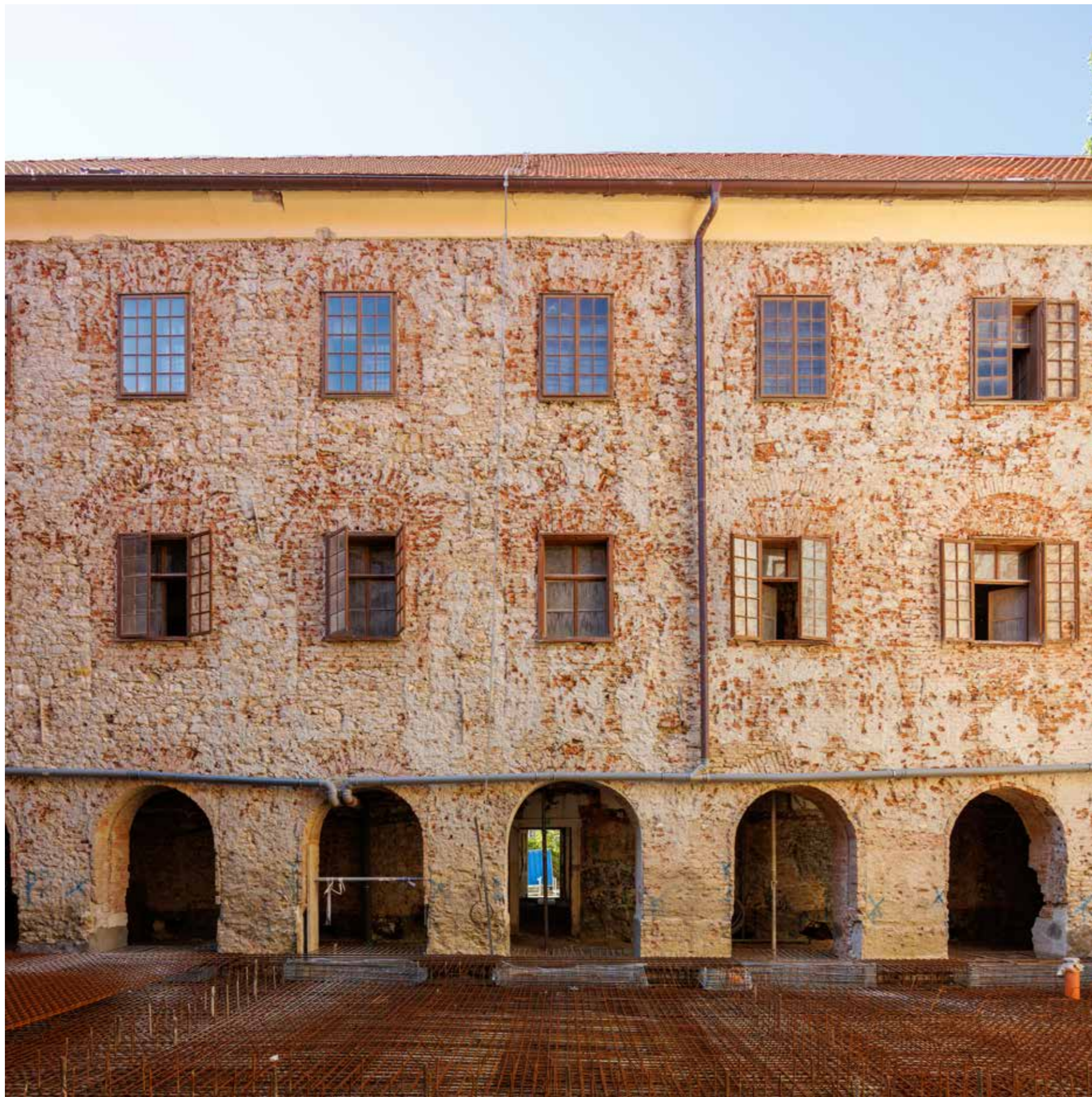
Pročelje južnog krila u unutarnjem dvorištu
