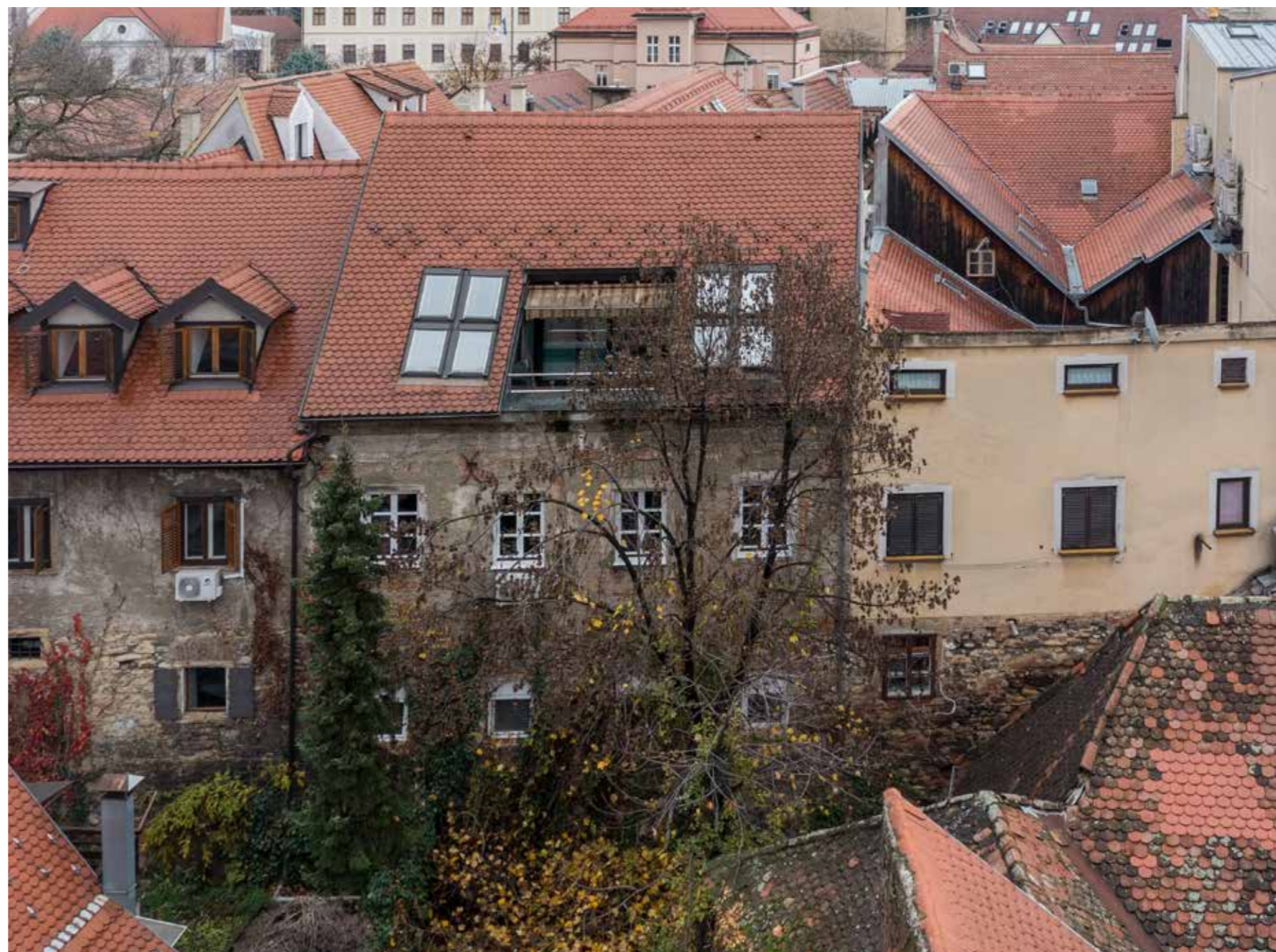
Zapadno začelje na gradskom zidu
