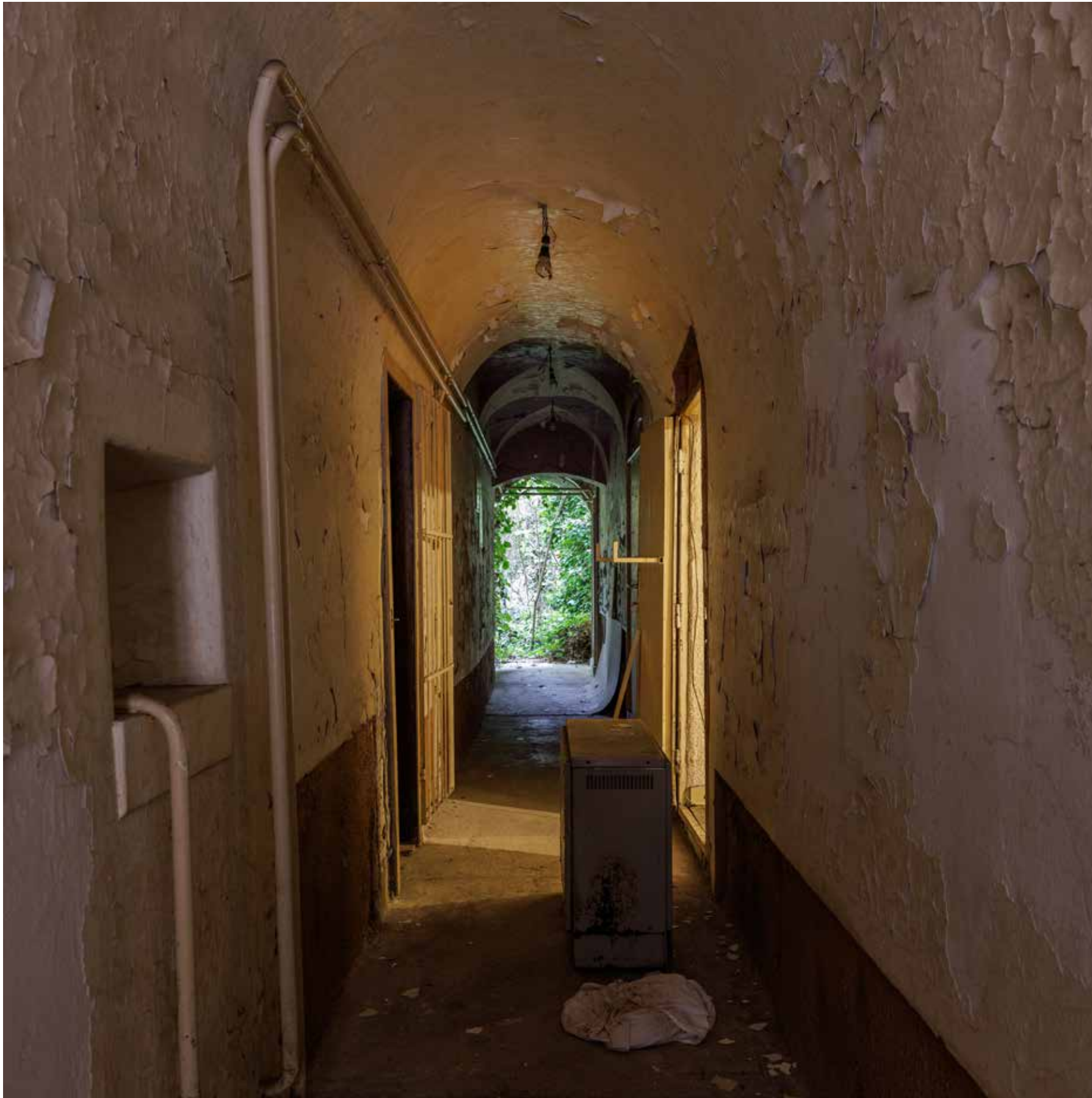
Veža u zapadnom dijelu prizemlja
