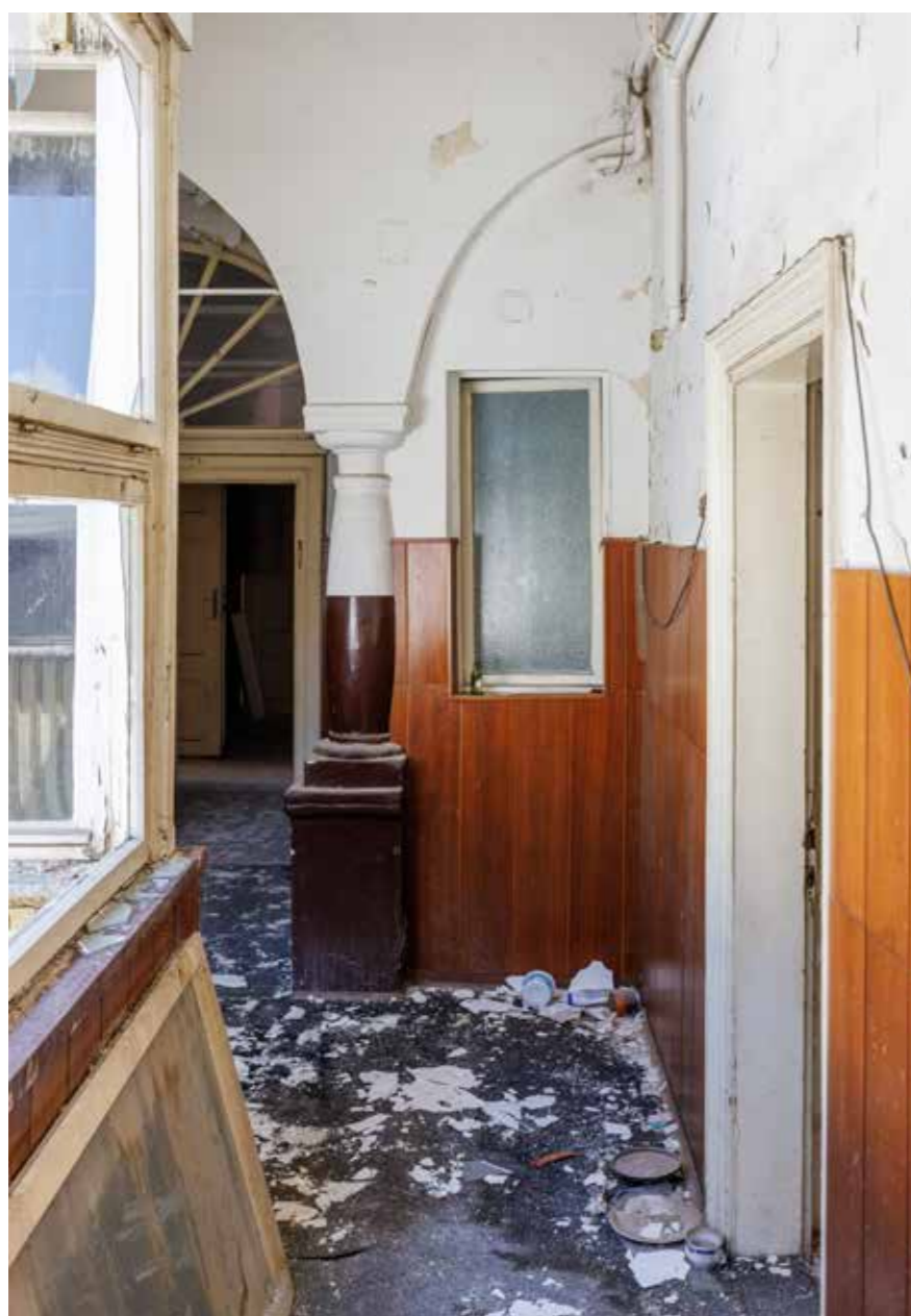
Stup nekadašnjega dvorišnog trijema na katu
