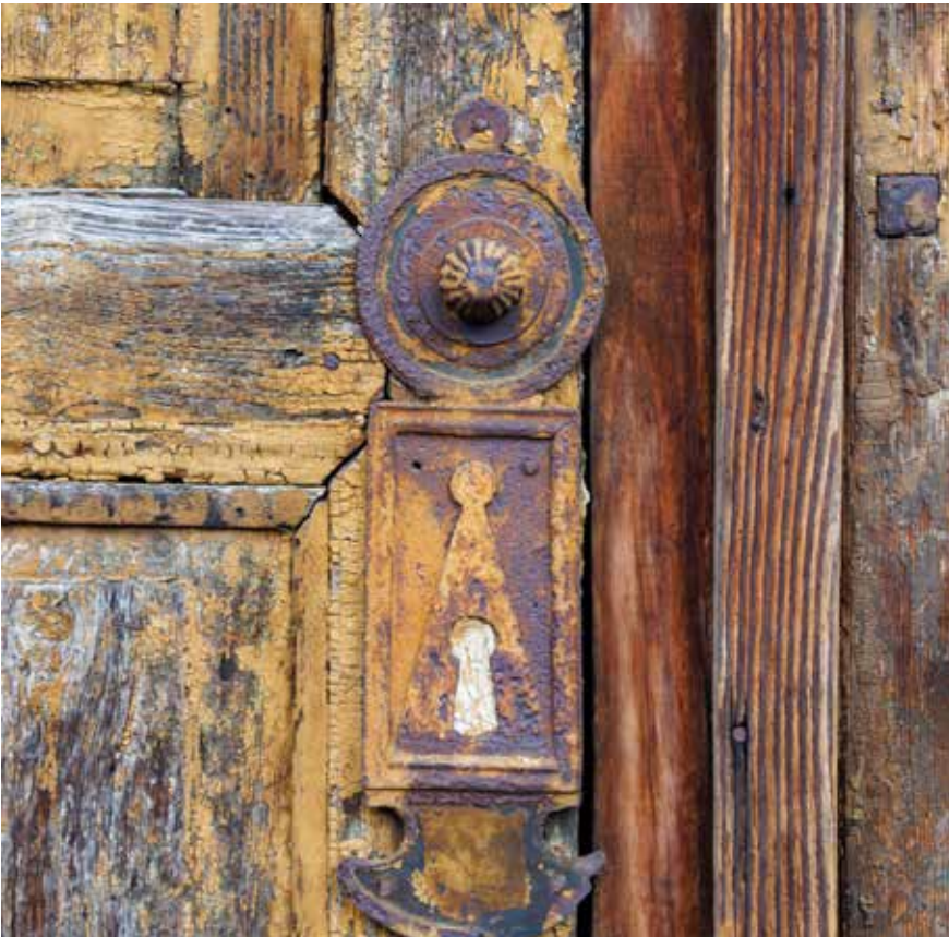
Ulaz u dvorište, detalji vratnica
