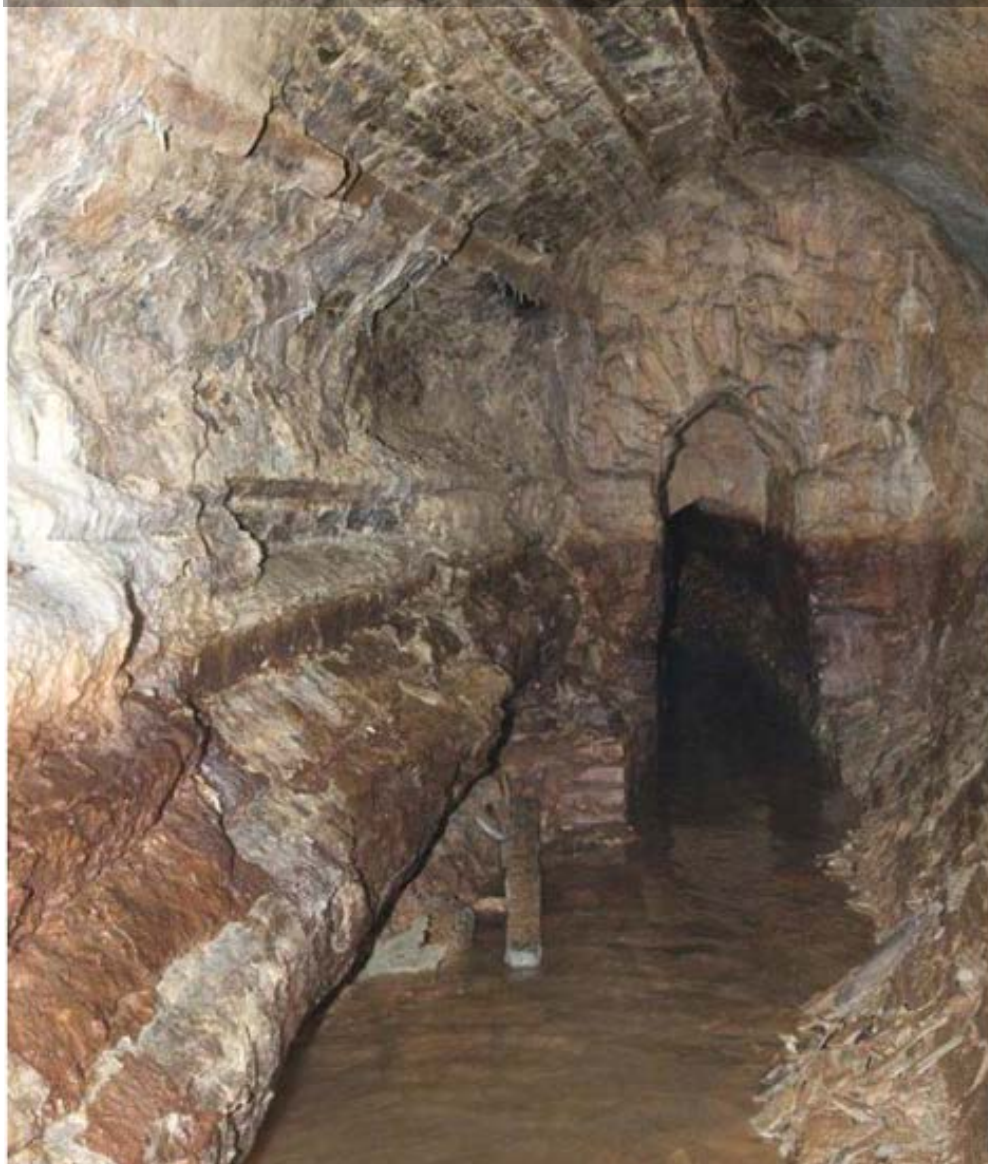
Tunelski dio Dioklecijanova vodovoda. (Foto: Tonči Rađa)
