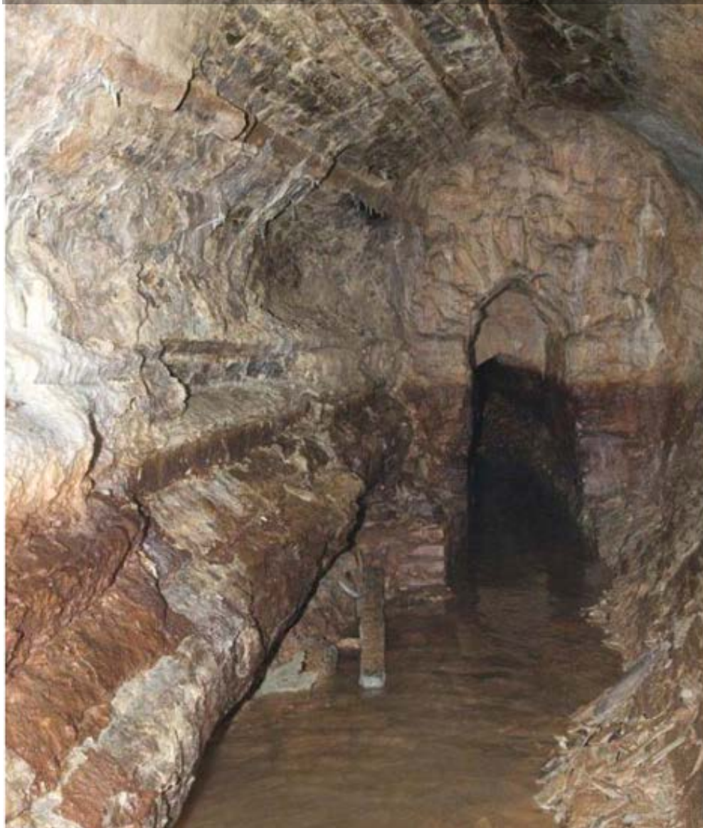
Tunelski dio Dioklecijanova vodovoda. (Foto: Tonči Rađa)
