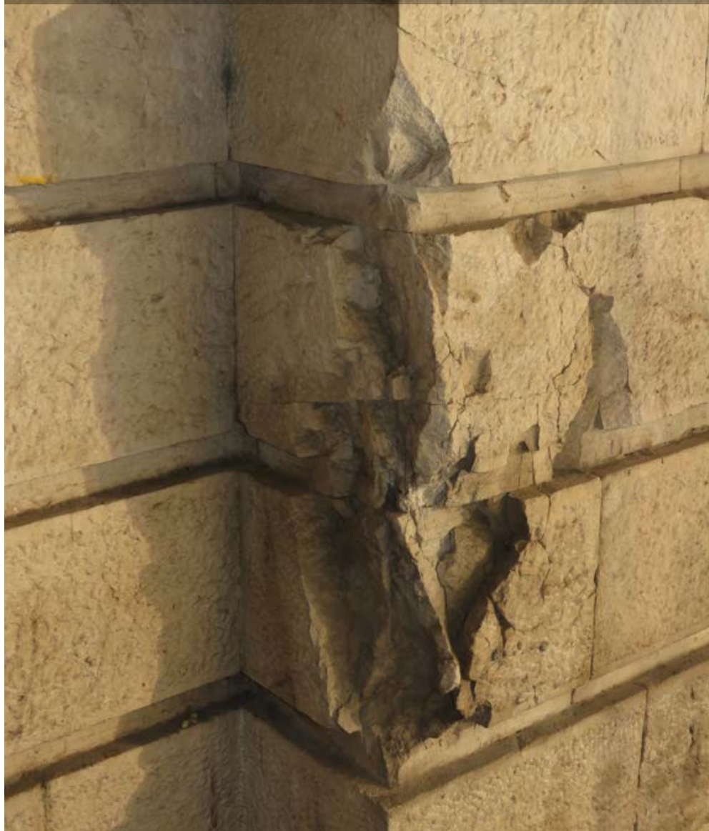
Zdrobljeni sjeverni ugao središnjeg rizalita na zapadnom pročelju. (foto: G. Nikšić)
