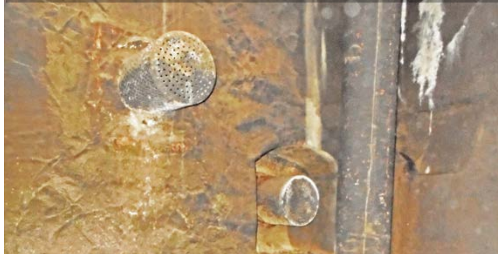
Mali (južni) spremnik s odvodnim cijevima i preljevnom cijevi (detalj). (foto: G. Nikšić)
