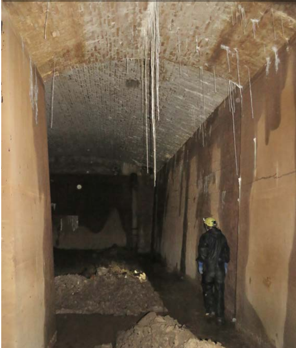
Stalaktiti koji vise iz luka i svoda u velikom spremniku, nastali ispiranjem vapnenog morta kišnicom. (foto: G. Nikšić)
