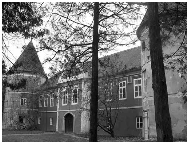
1. Pogled na glavno, istočno pročelje, sadašnje stanje
