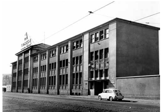
4. Tvornica »Gorica« – negdašnja zgrada rafinerije i pecare tvornice »Vladimir Arko«, Šubićeva ulica, Zagreb, oko 1970. (Ministarstvo kulture, Konzervatorski odjel u Zagrebu)
