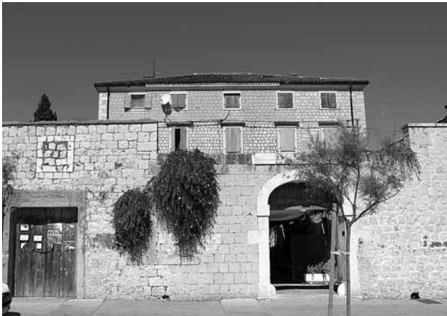
5. Današnji pogled na sklop s kaštelanske obale. Glavno pročelje uvučeno je iza ograđenog dvorišta
