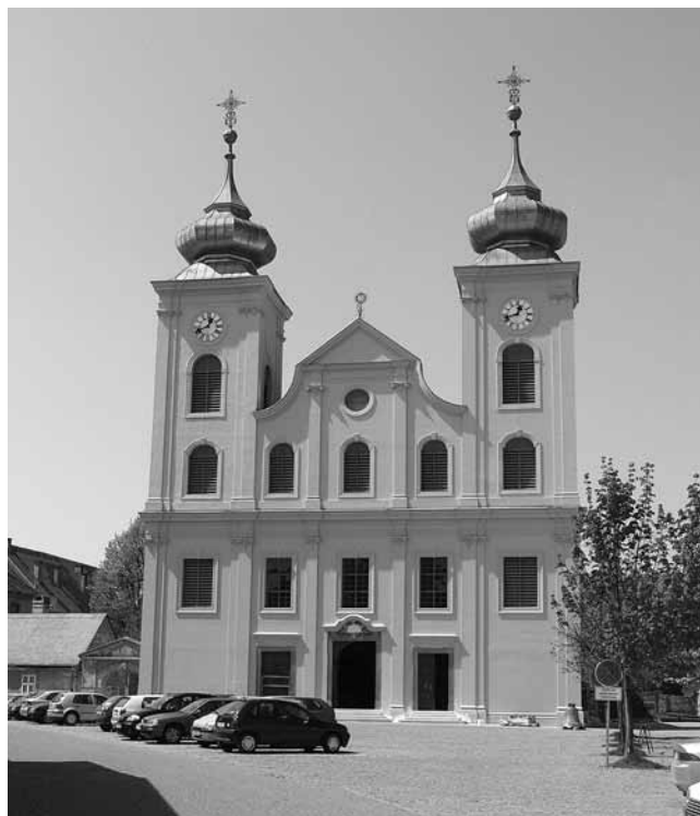
1. Osijek, isusovačka (sada župna) crkva sv. Mihovila (1725. – 1766.), pročelje, http://en.wikipedia.org/wiki/File:St._Michael%27s_Church,_Osijek.jpg
