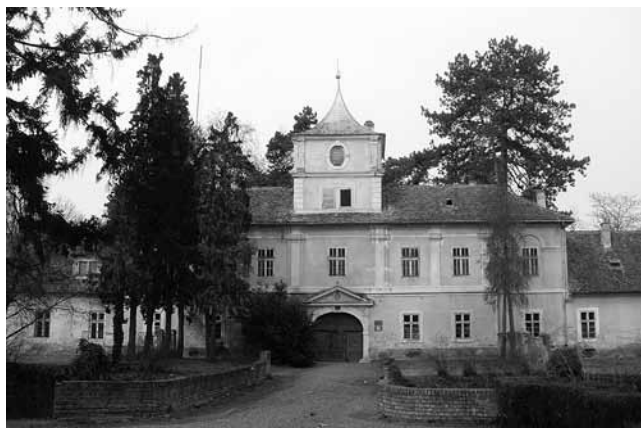
1. Dvorac Bilje, pročelje (snimio Ž. Predojević)
