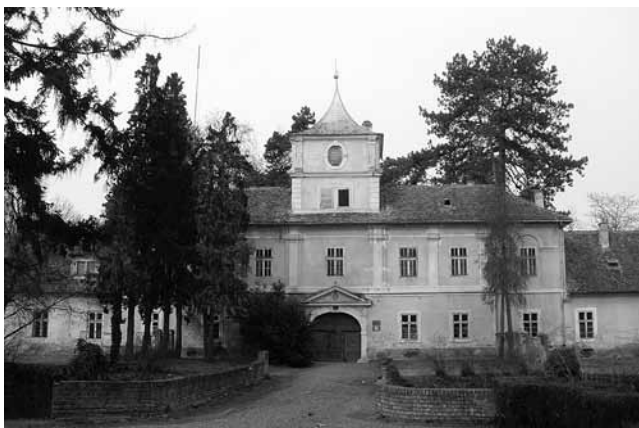
1. Dvorac Bilje, pročelje (snimio Ž. Predojević)
