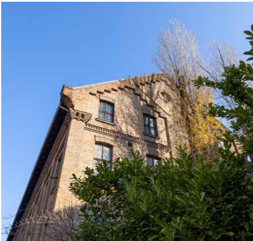
Zapadna ulična zgrada, pogled na južno pročelje
