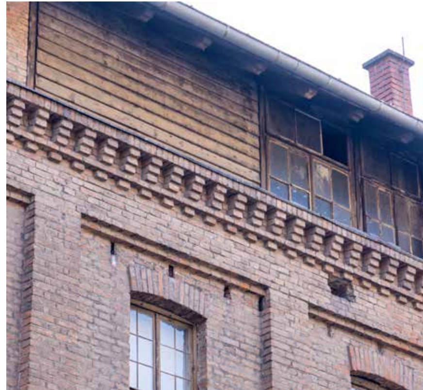
Zapadna ulična zgrada, detalj zapadnog pročelja (završni vijenac i drveni nadozid)
