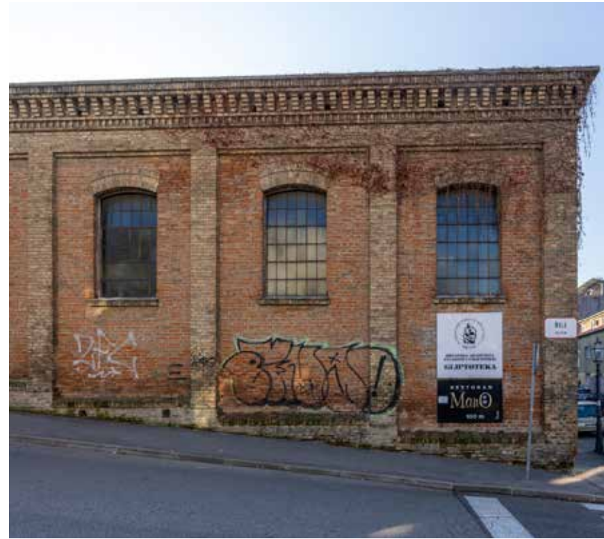
Sjeverna zgrada Šibenik, pogled na sjeverno pročelje objekta strojarnice sa sjevera
