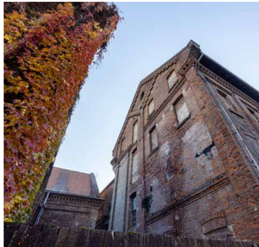
Zapadna ulična zgrada, pogled na sjeverno pročelje
