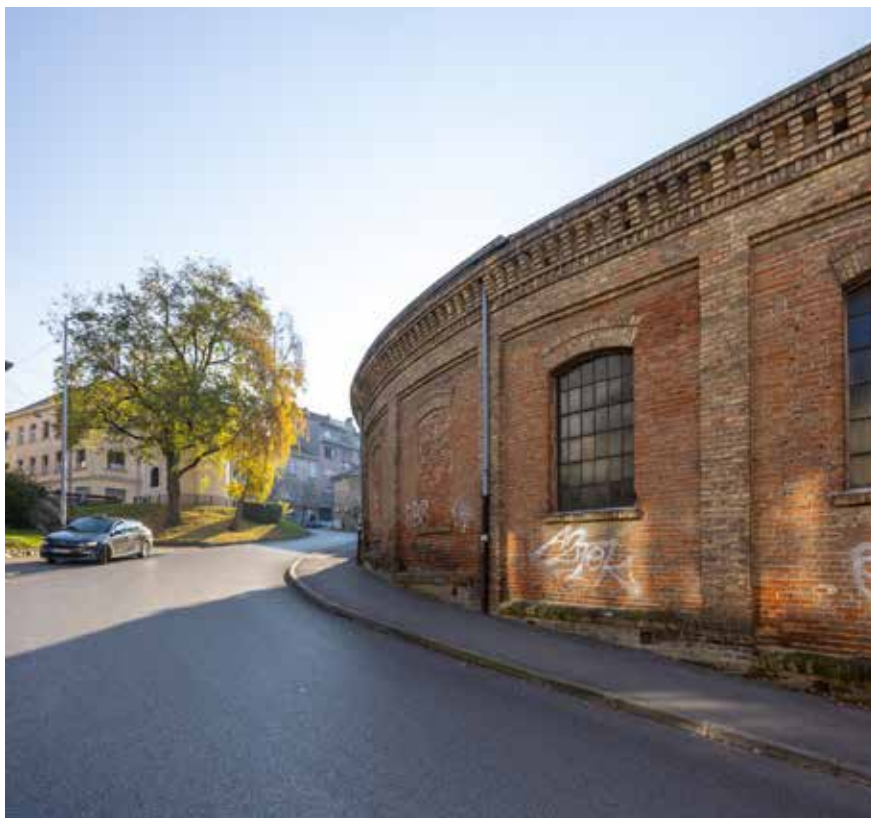
Sjeverna zgrada Šibenik, vizura uličnog pročelja objekta kotlovnice i Male ulice
