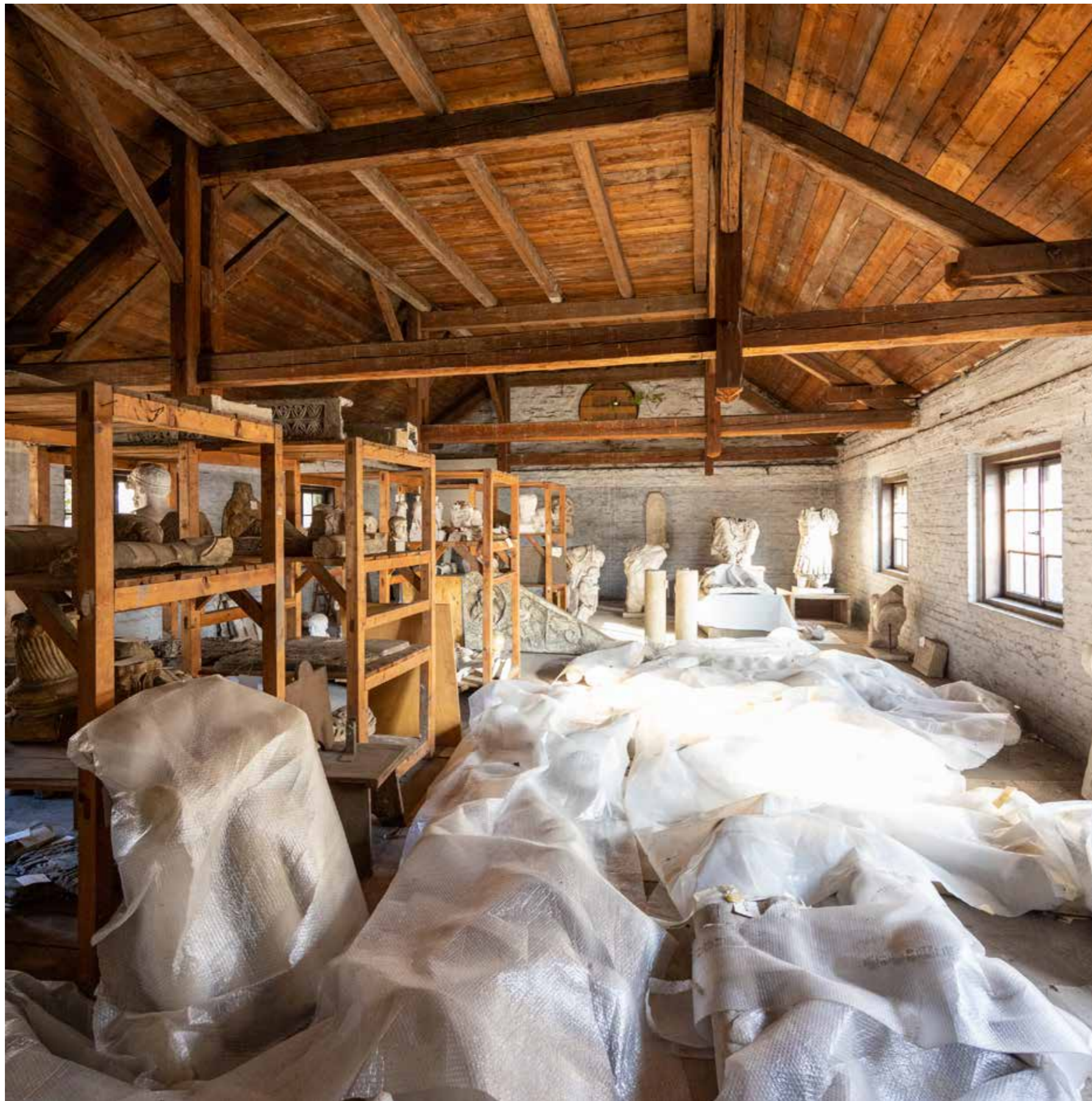
Južna zgrada Antika, krovište južnog krila
