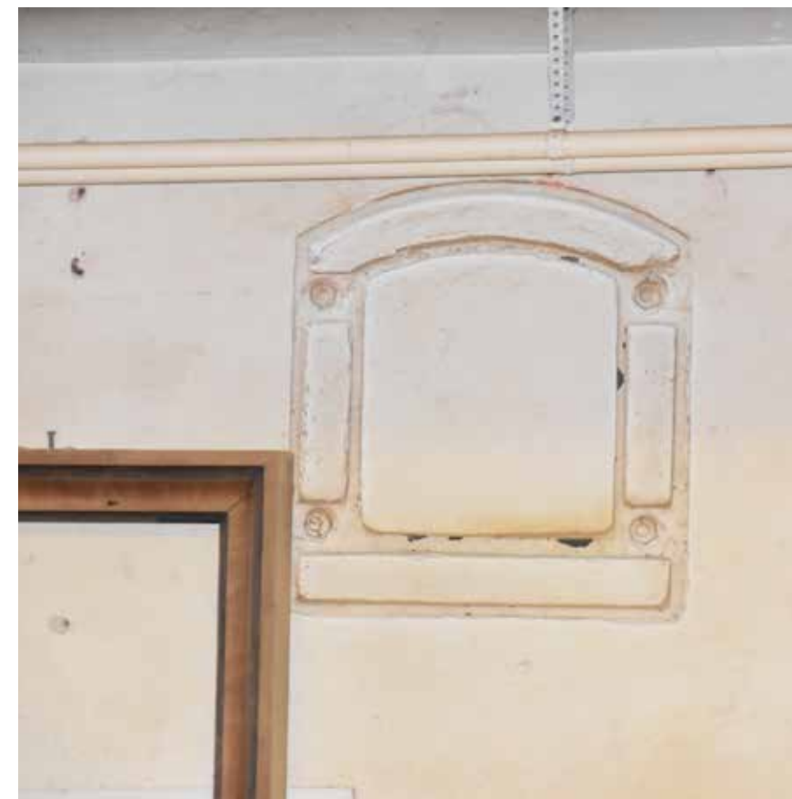
Željezni otvor, zapadna zgrada
