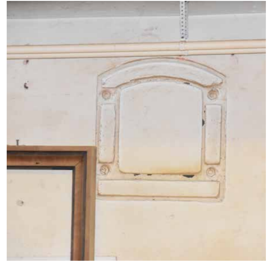
Željezni otvor, zapadna zgrada
