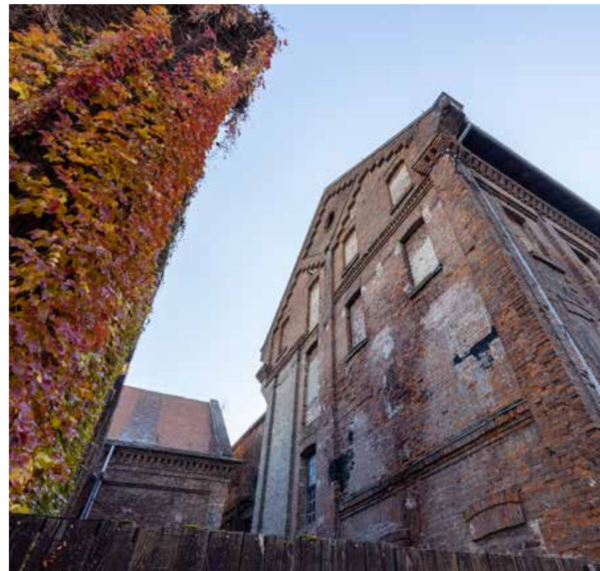
Zapadna ulična zgrada, pogled na sjeverno pročelje
