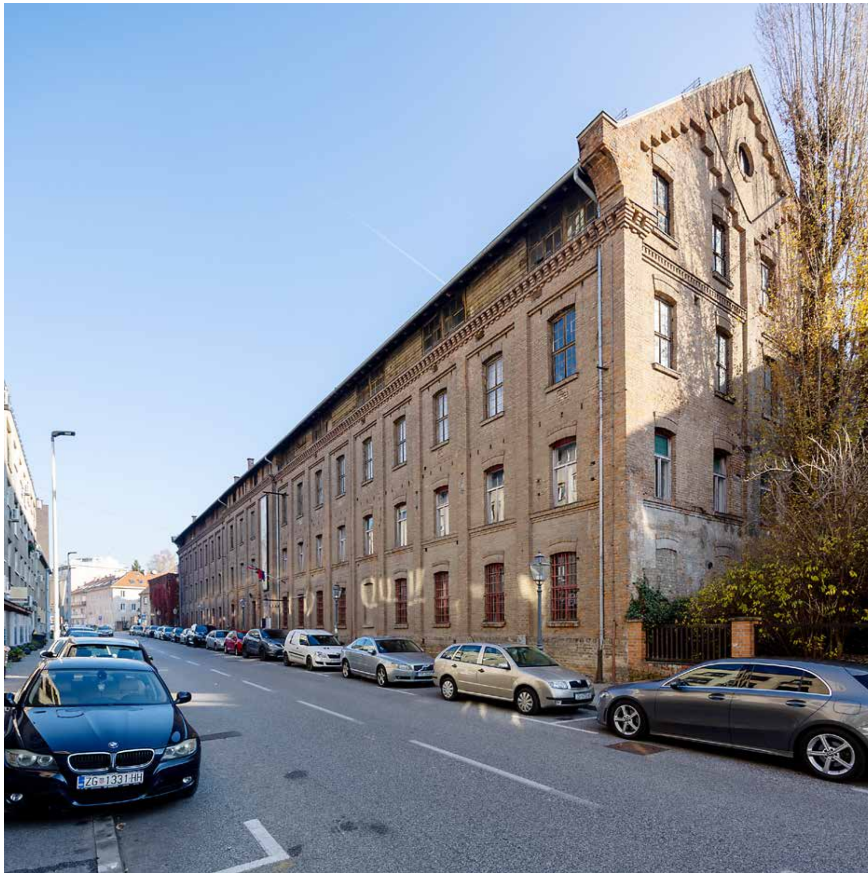
Zapadna ulična zgrada, pogled s juga na zapadno pročelje
