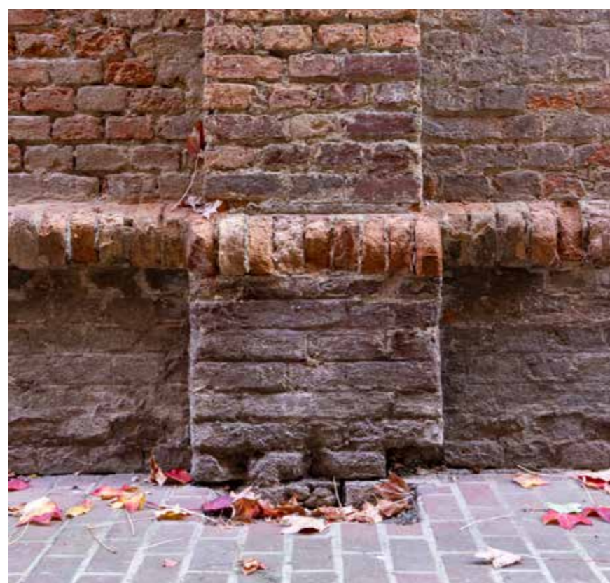
Istočna dvorišna zgrada, detalj opečne građe na zapadnoj fasadi u zoni podnožja
