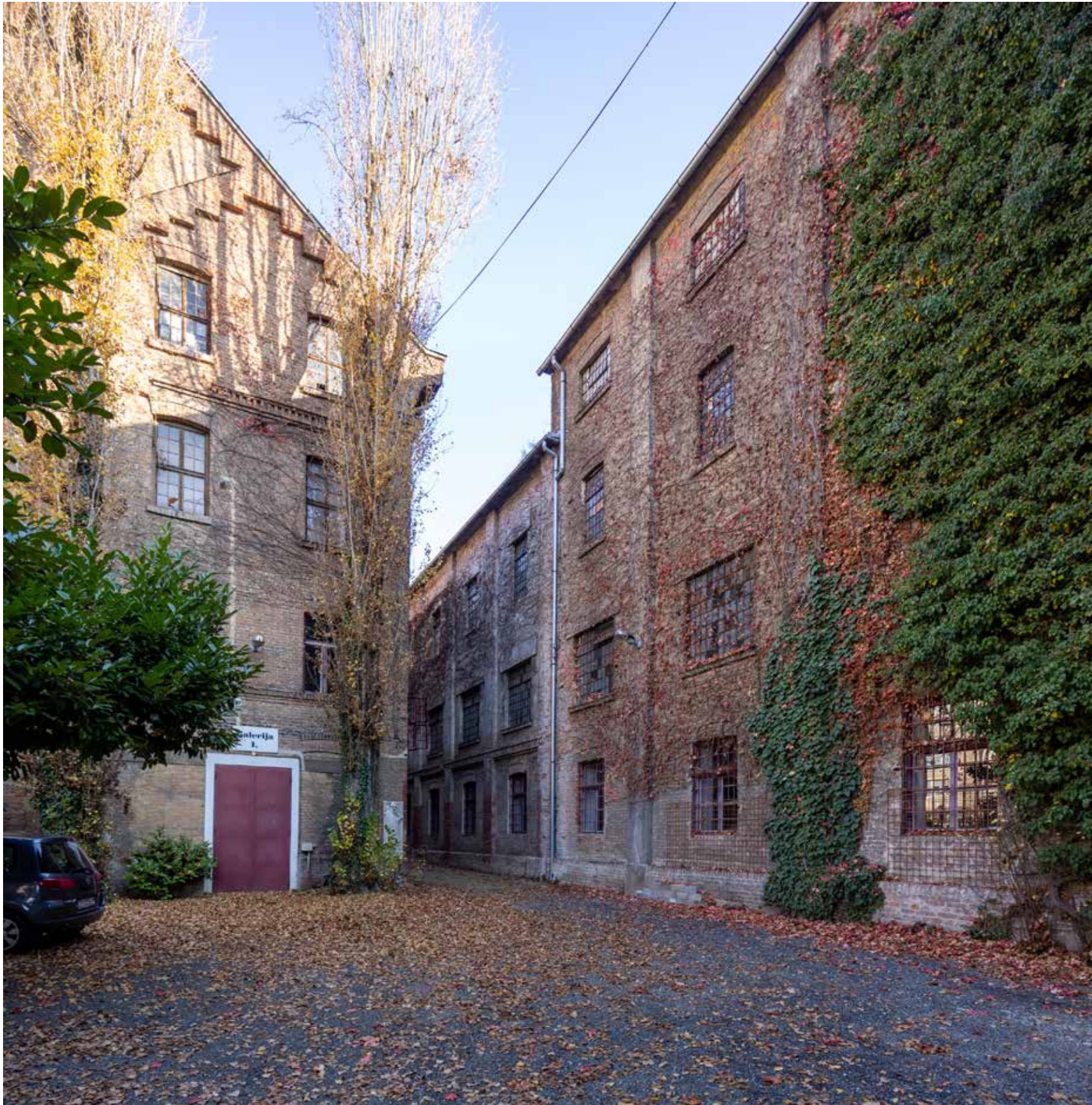
Istočna dvorišna zgrada, pogled na središnji dio zapadnog pročelja i ulazni trg
