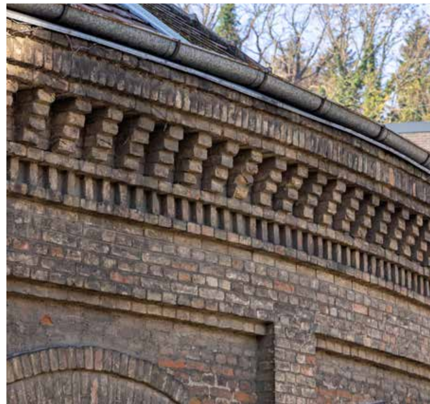
Sjeverna zgrada Šibenik, detalj vijenca
