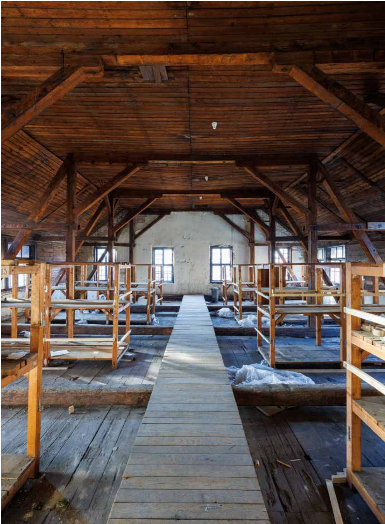
Zapadna ulična zgrada, krovšte, sjeverno krilo
