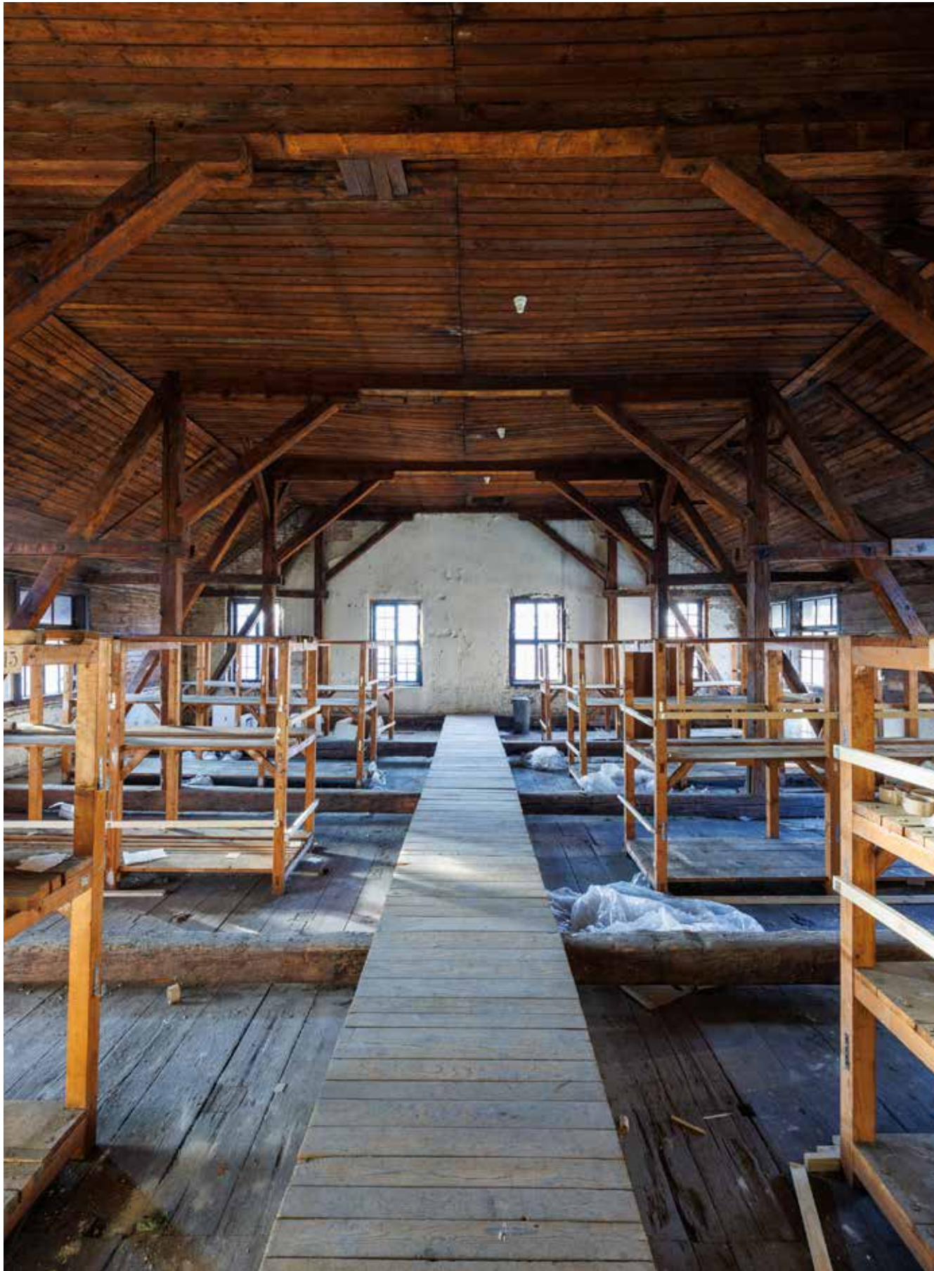
Zapadna ulična zgrada, krovšte, sjeverno krilo
