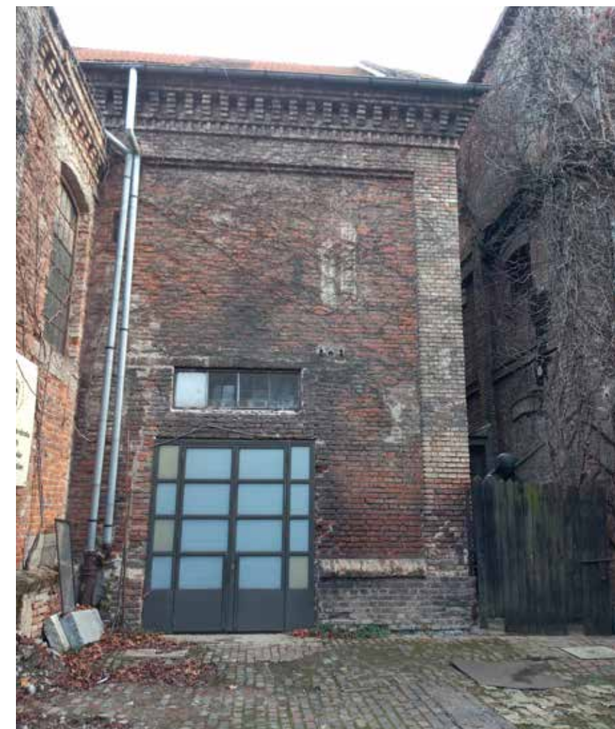
Servisno dvorište, pogled za zapada
