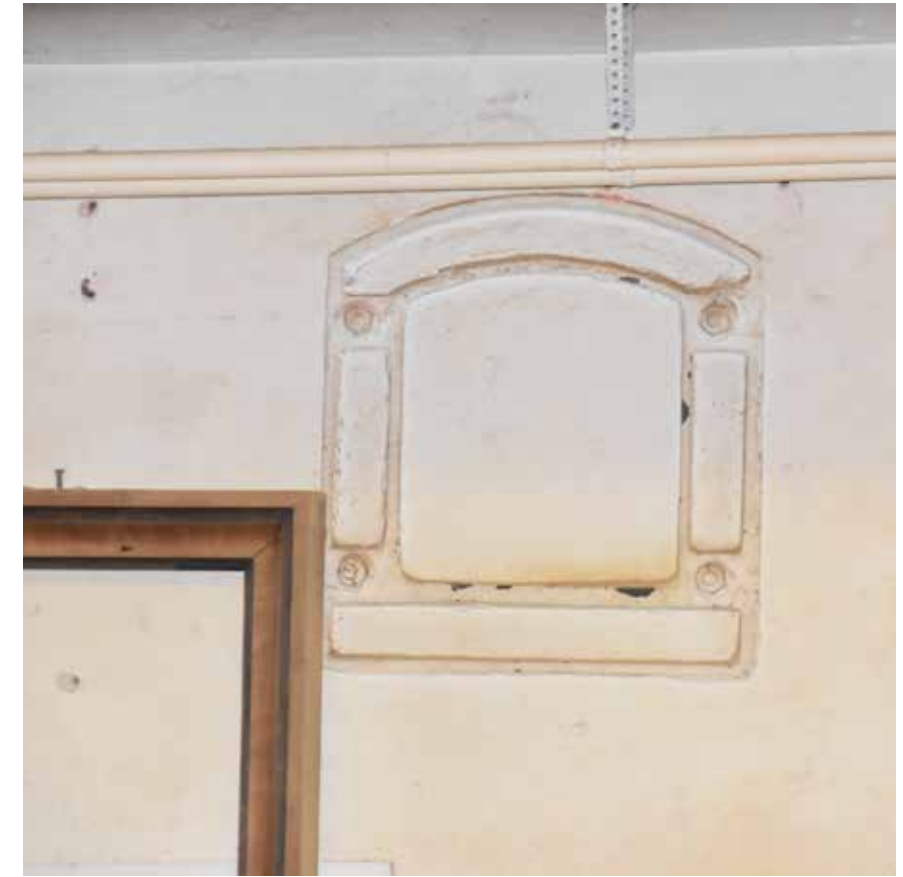
Željezni otvor, zapadna zgrada
