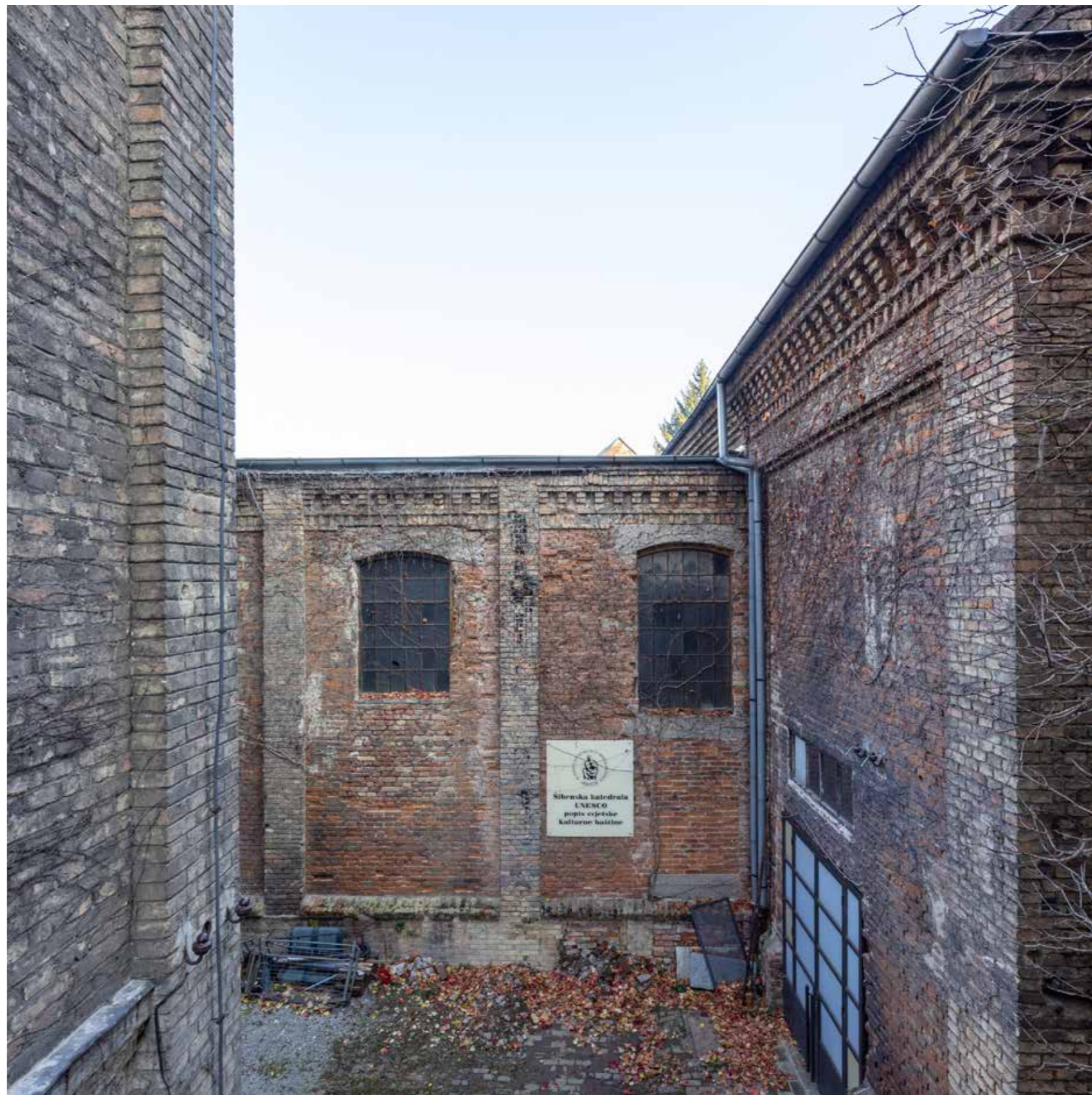
Pogled na sjevernu zgradu Šibenik i servisno dvorište
