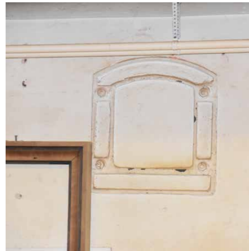
Željezni otvor, zapadna zgrada
