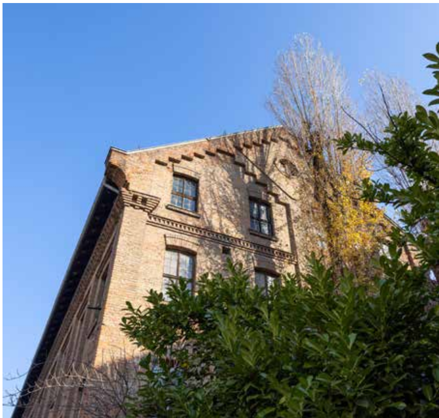
Zapadna ulična zgrada, pogled na južno pročelje
