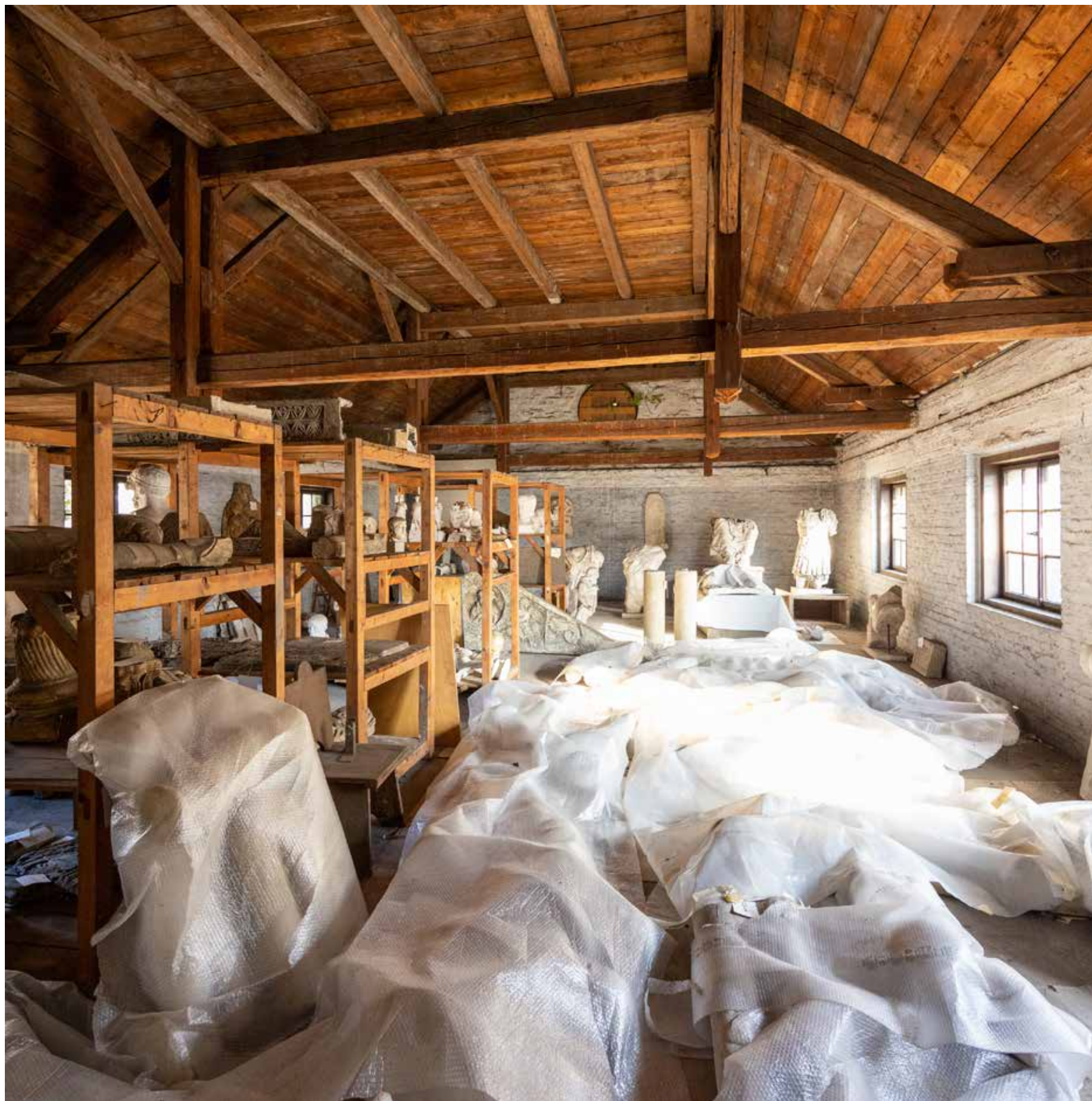
Južna zgrada Antika, krovište južnog krila
