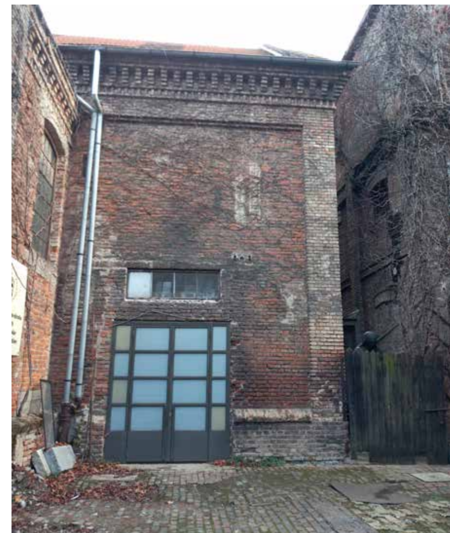
Servisno dvorište, pogled za zapada
