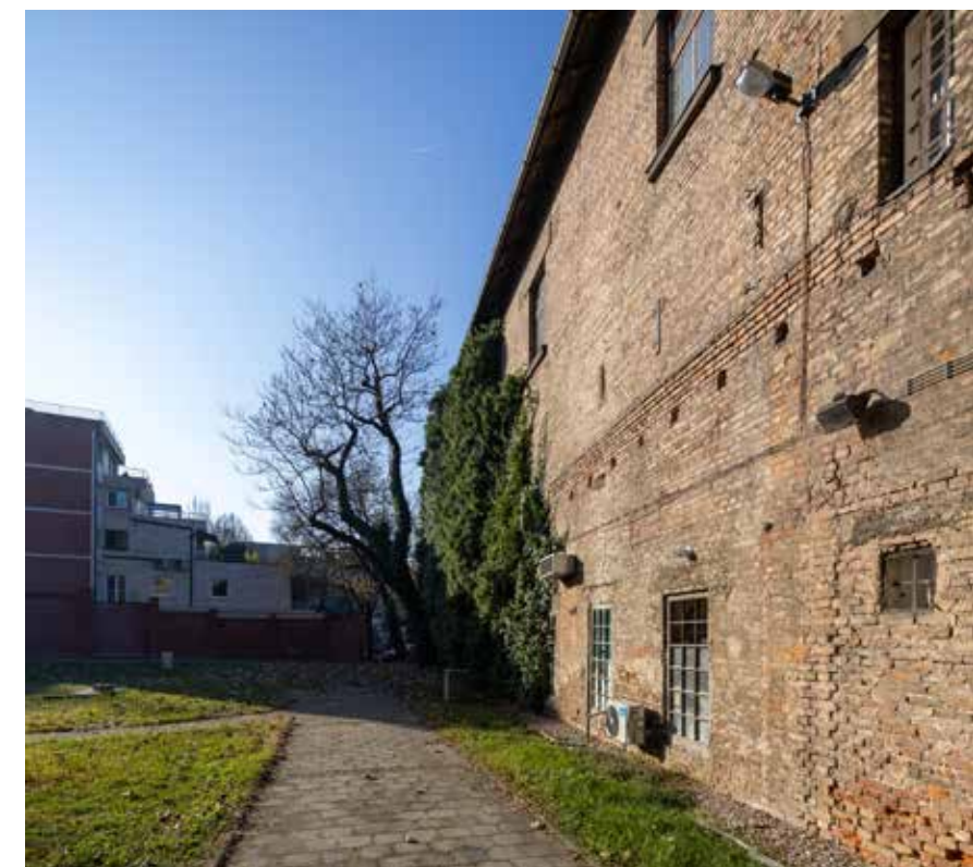
Južna zgrada Antika, pogled na južno pročelje
