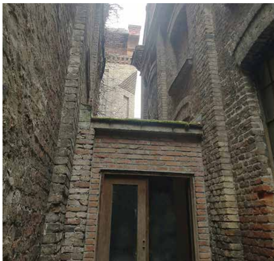
Istočna dvorišna zgrada, pogled na sjeverno pročelje i koridor koji spaja istočnu i sjevernu zgradu
