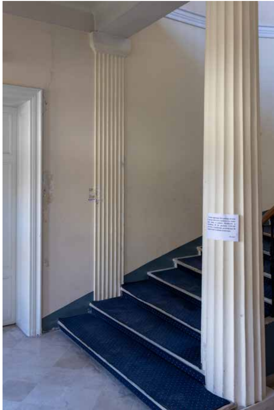
Pogled na sjeverni zid predvorja, detalj izvornog oblikovanja
