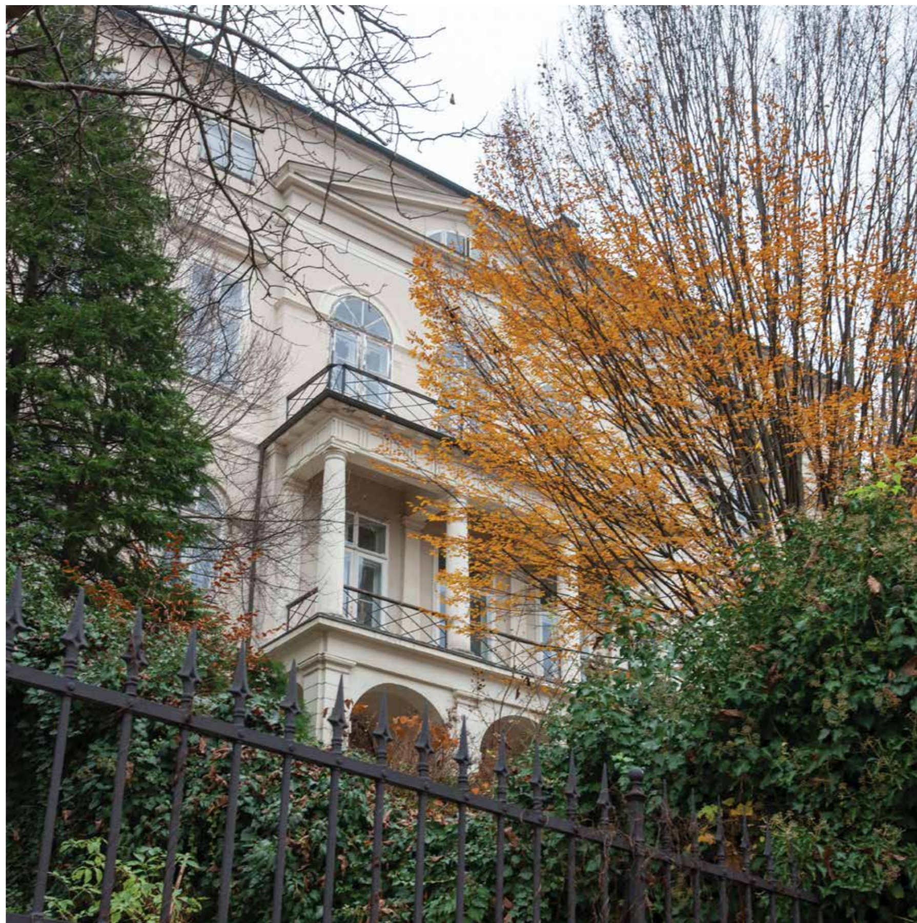
Istočno pročelje s altanom
