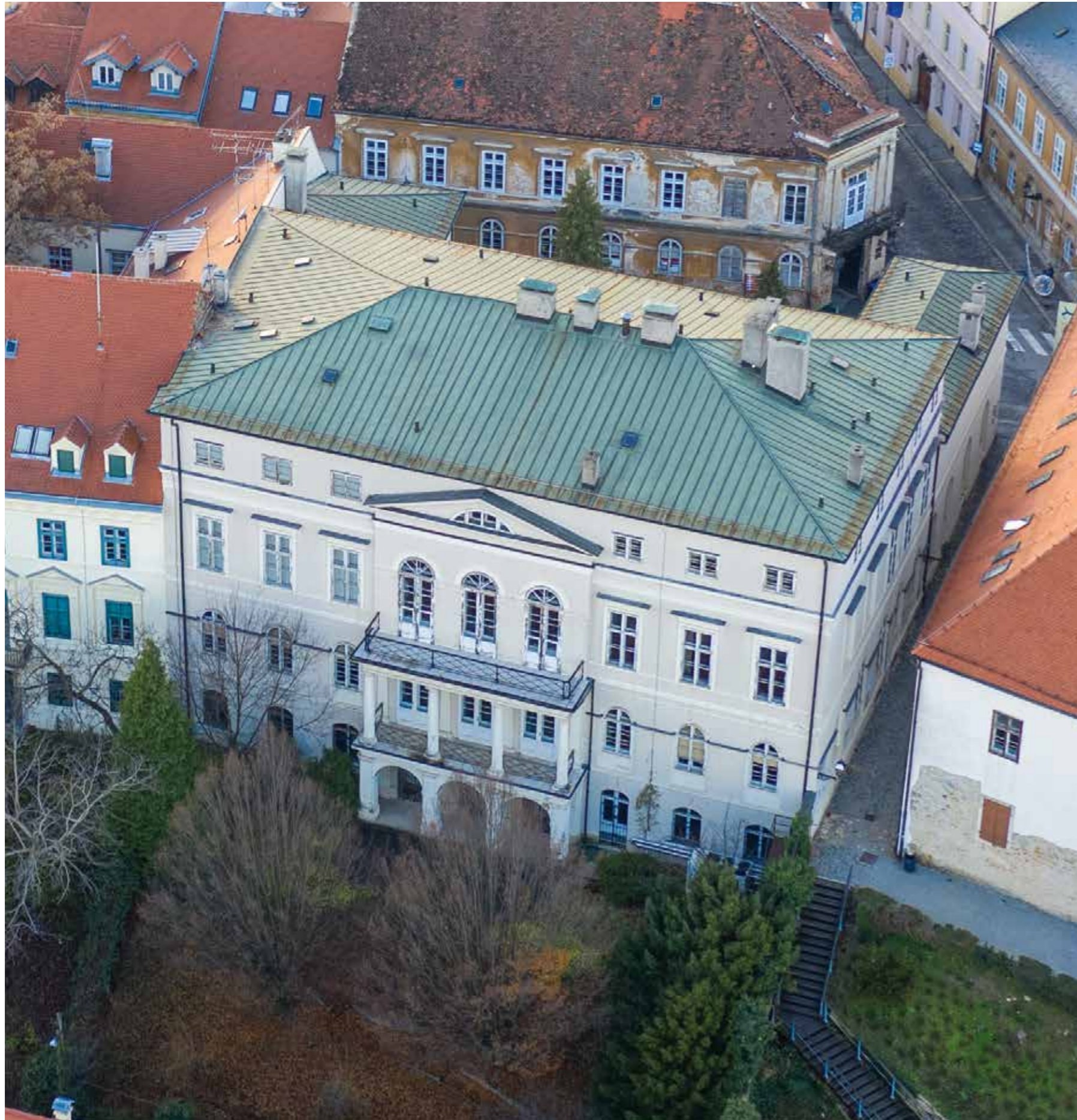
Istočno pročelje s altanom
