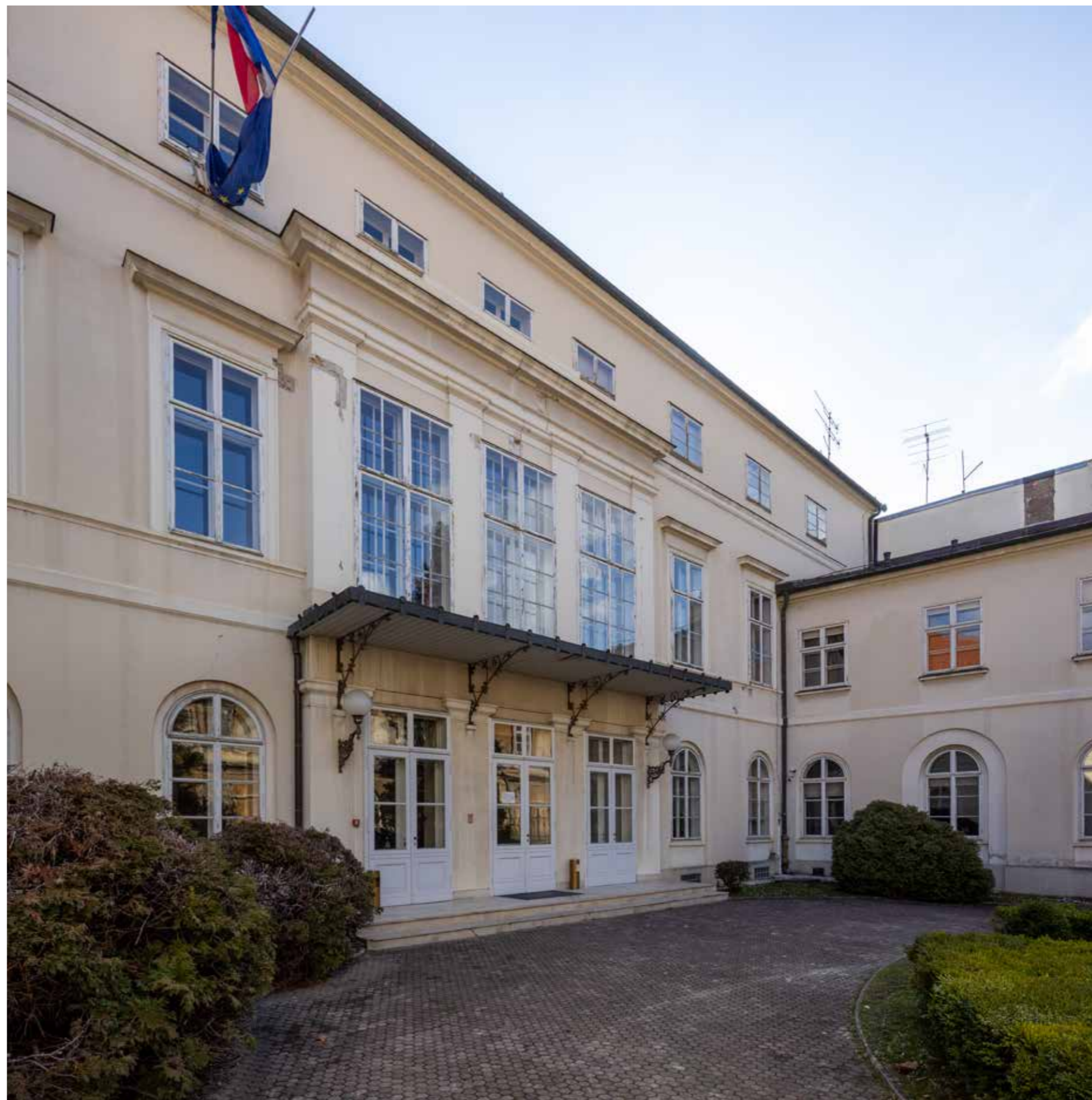
Pogled na zapadno pročelje
