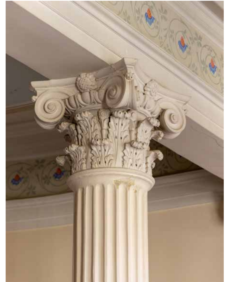
Arhitektonska plastika galerije stubišta predvorja, detalj kapitela stupa
