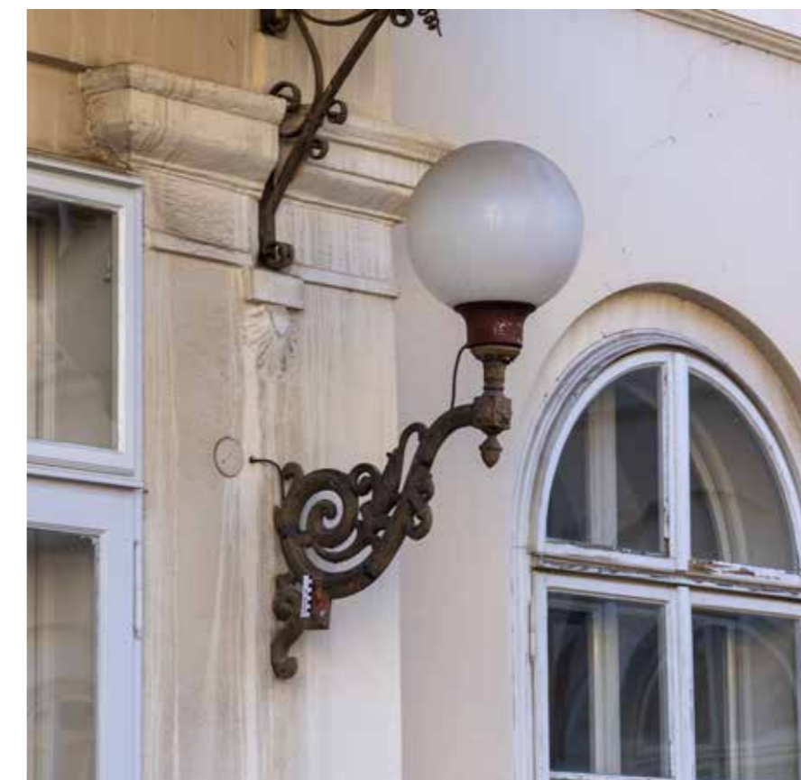
Zapadno pročelje, detalj prizemlja središnjeg rizalita
