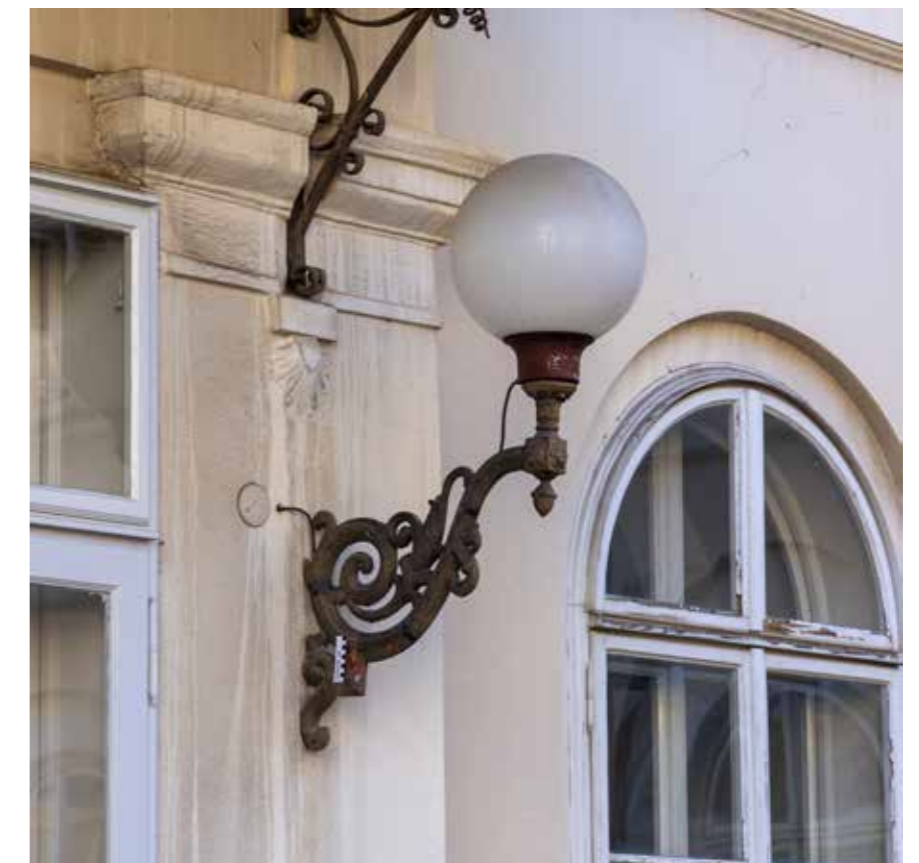
Zapadno pročelje, detalj prizemlja središnjeg rizalita
