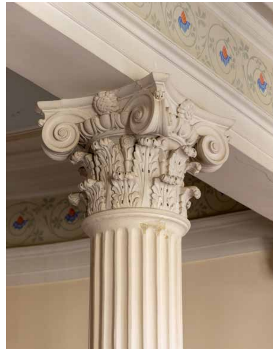
Arhitektonska plastika galerije stubišta predvorja, detalj kapitela stupa
