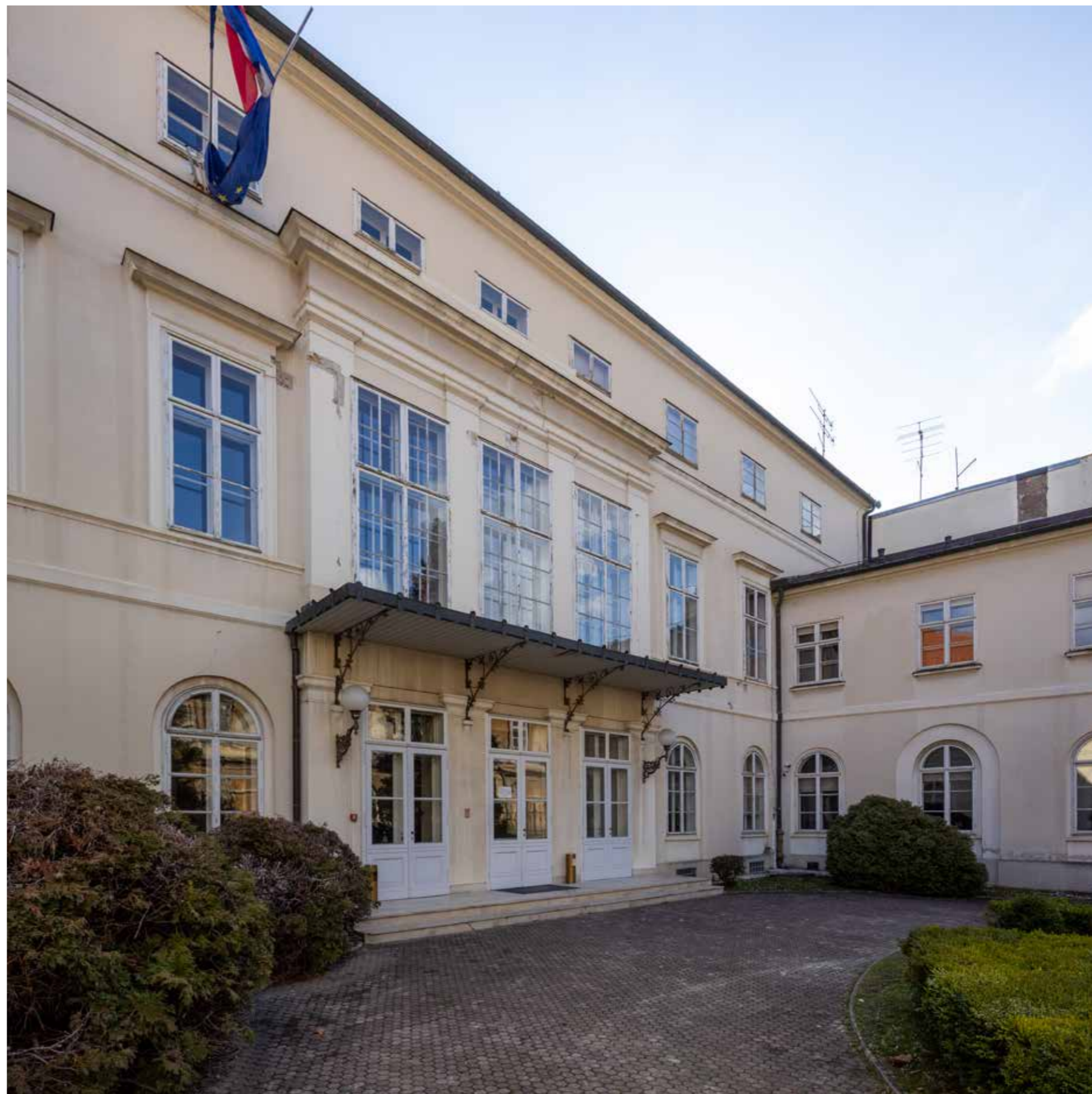
Pogled na zapadno pročelje
