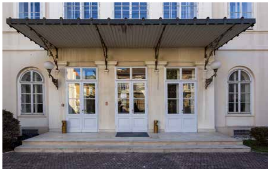
Pogled na zapadno pročelje, detalj nadstrešnice iznad ulaza
