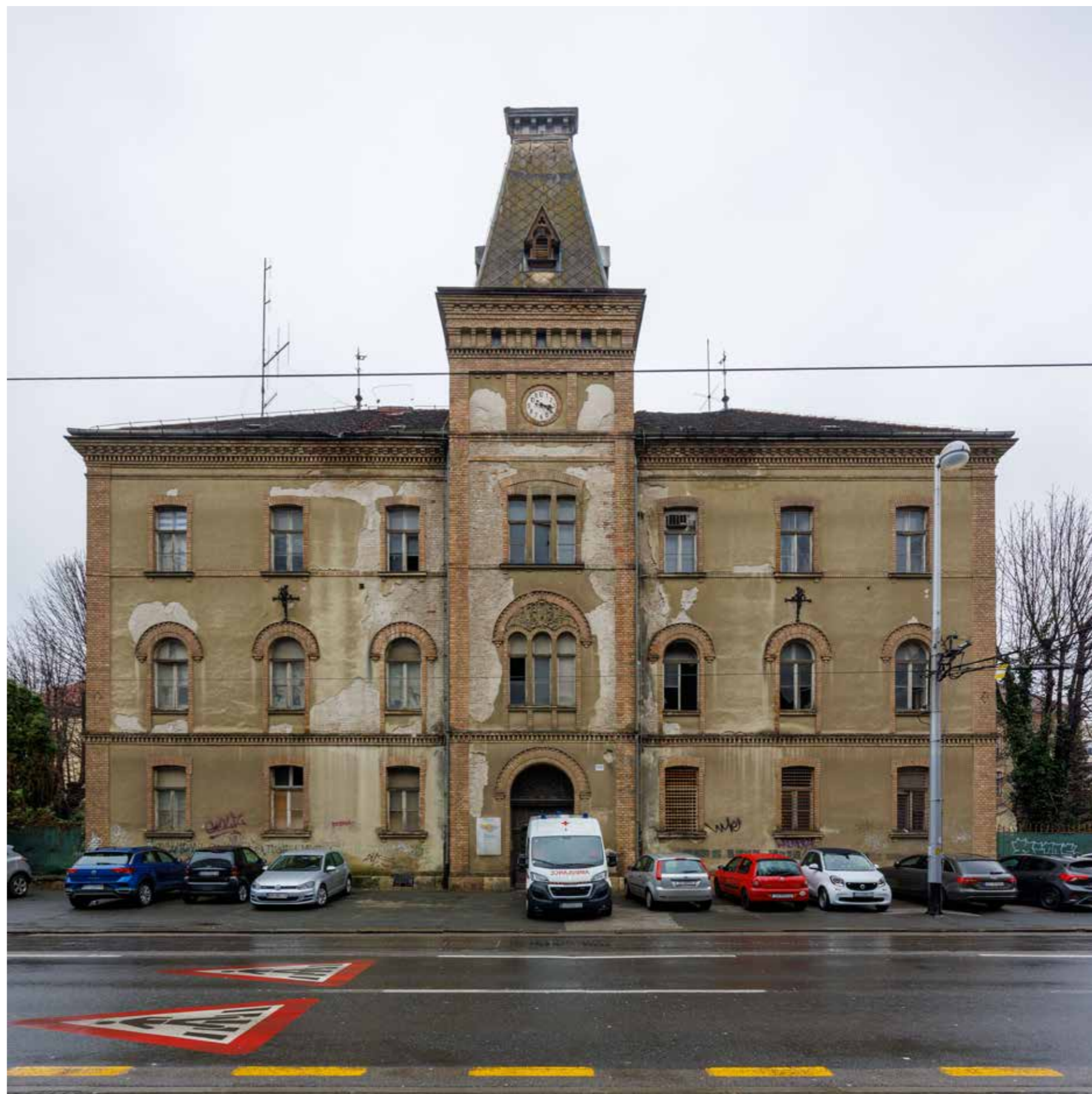
Zgrada pisarnice, južno pročelje
