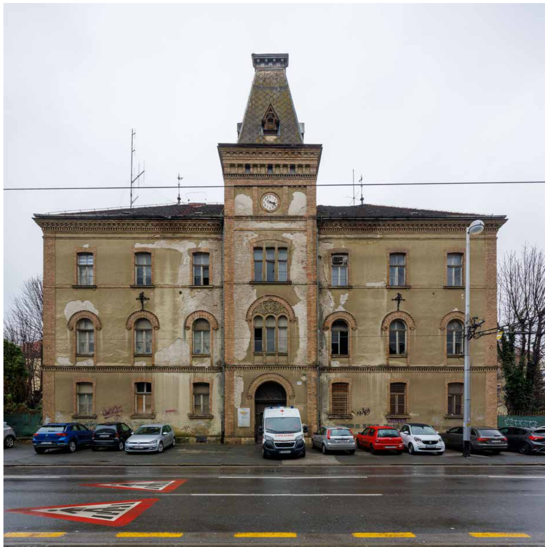
Zgrada pisarnice, južno pročelje
