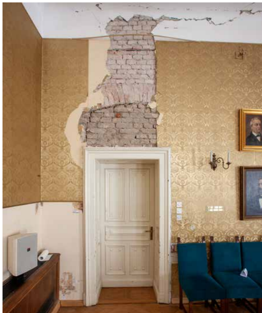
Velika sjednička dvorana na prvom katu Sonde na zidu i stropu
