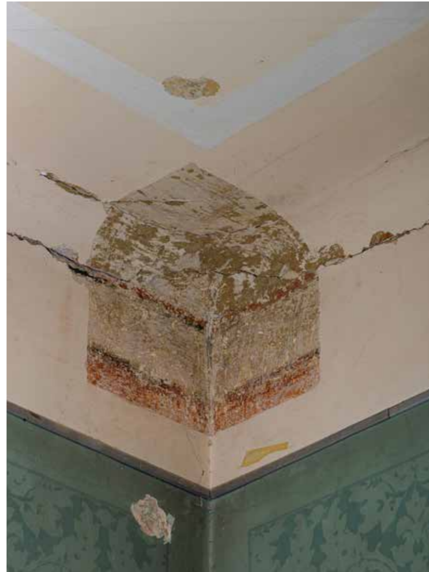
Sonde na zidu i stropu
