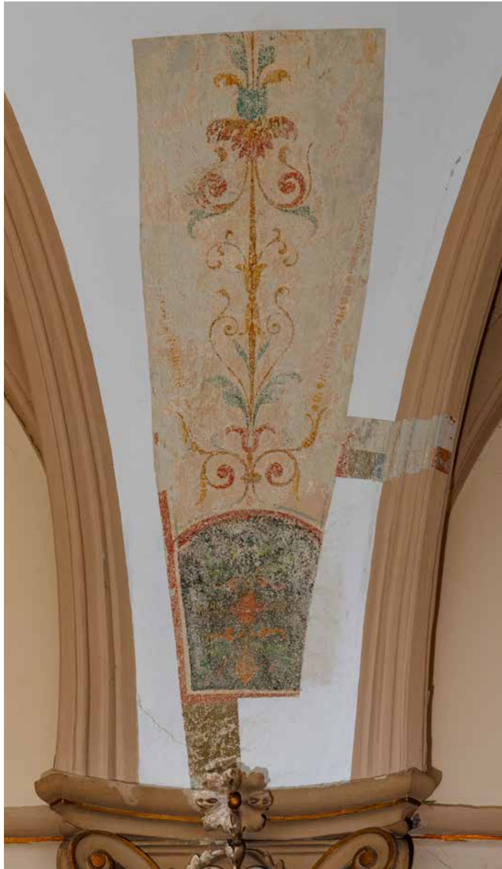
Stubište na drugom katu, sonde na svodu, kapitelu, vijencu i frizu
