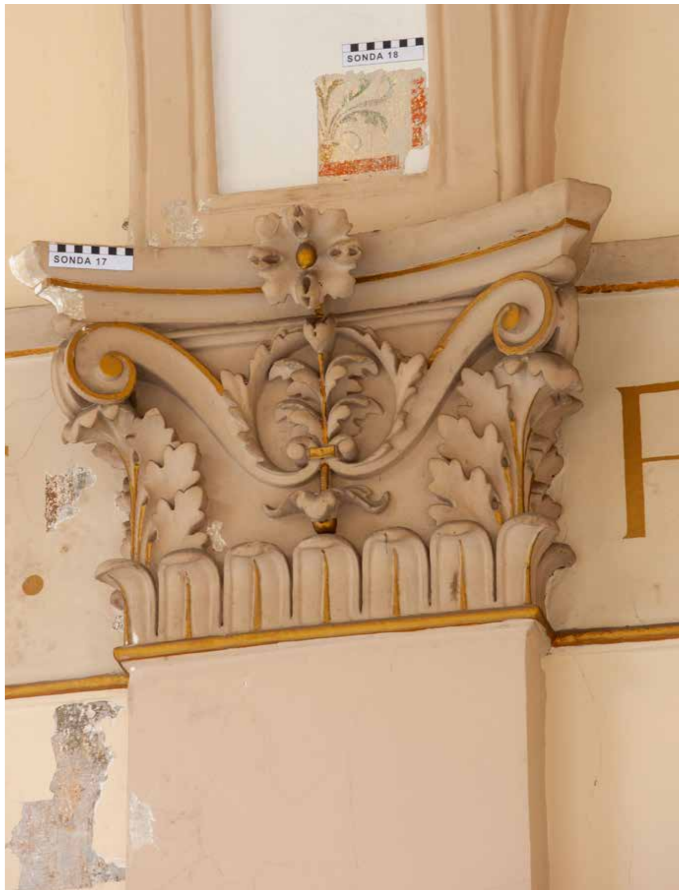
Trijem atrija na drugom katu Sonde na svodu i kapitelu
