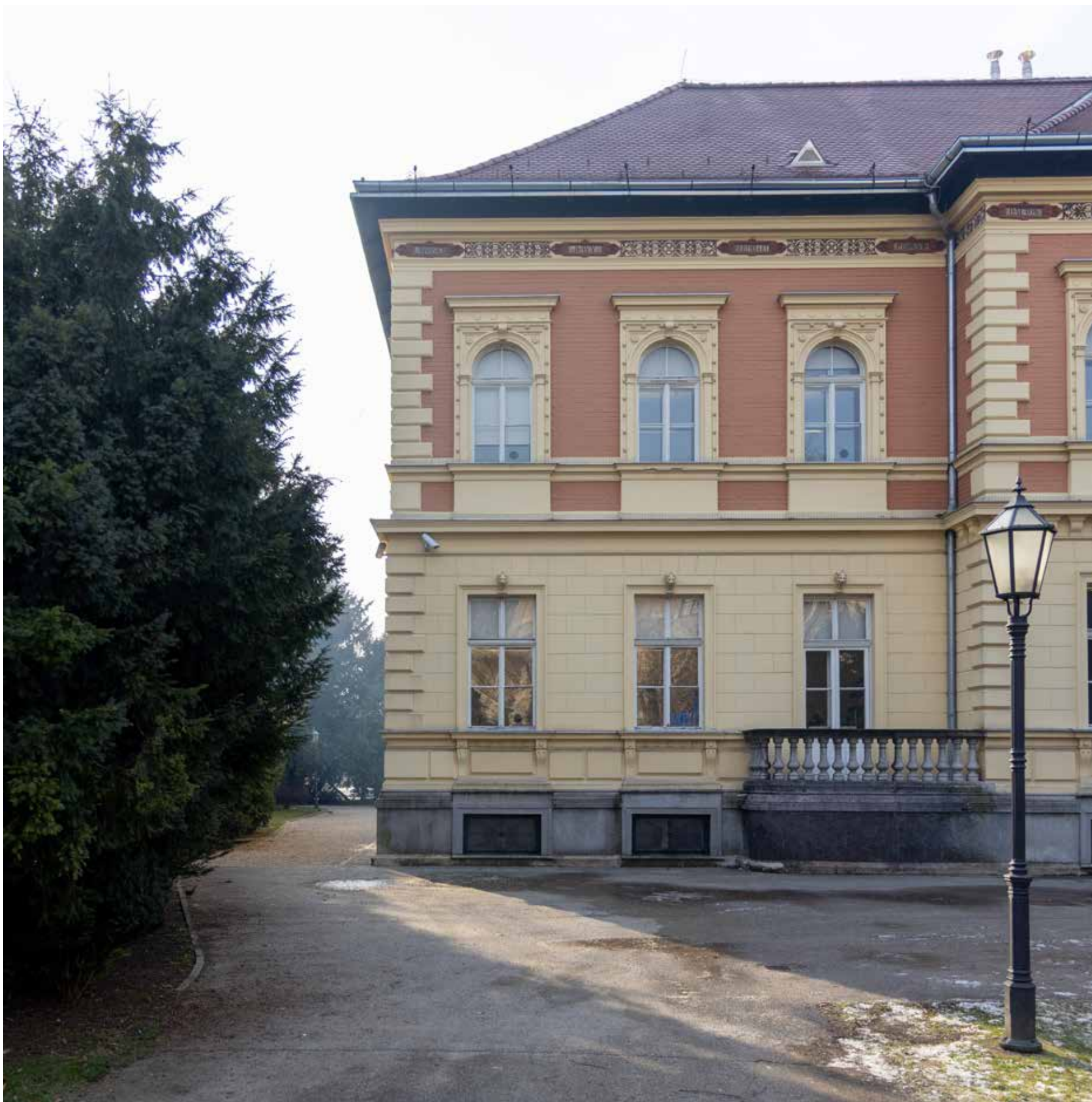
Sjeverno pročelje, detalj
