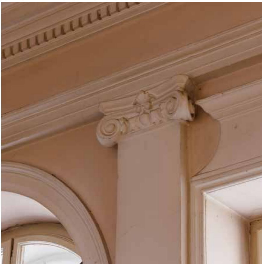
Zrcalni strop iznad stubišta
