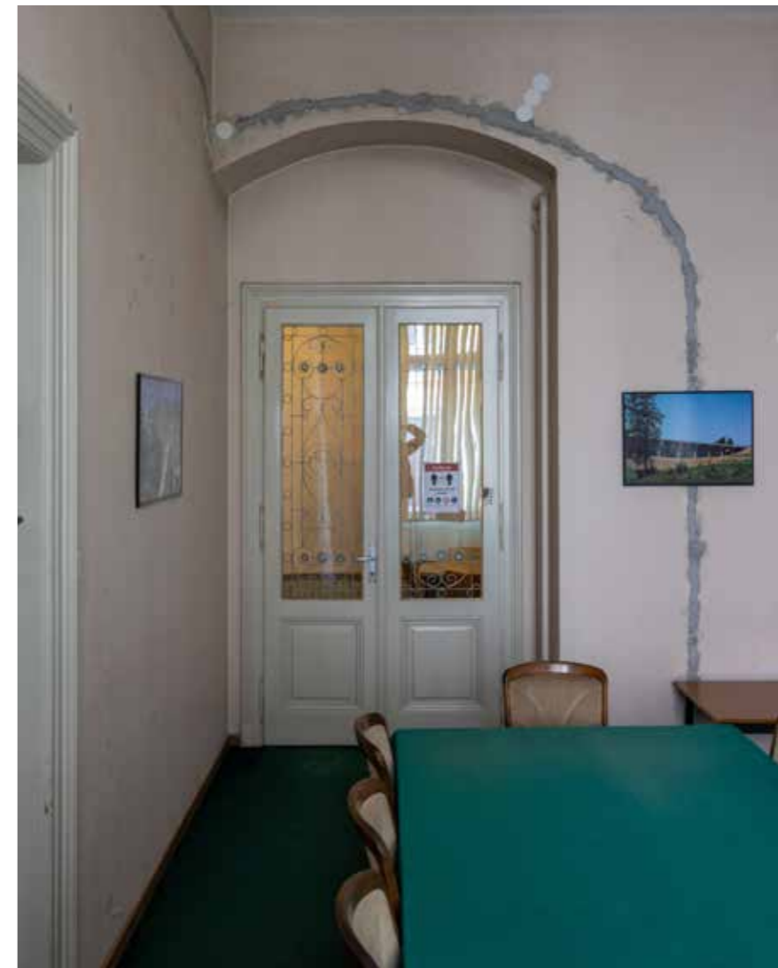
Nekadašnje predsoblje u srednjem dijelu prizemlja, lučni otvor prema hodniku koji treba otvoriti i vratnice koje treba vratiti na ulaz iz predvorja
