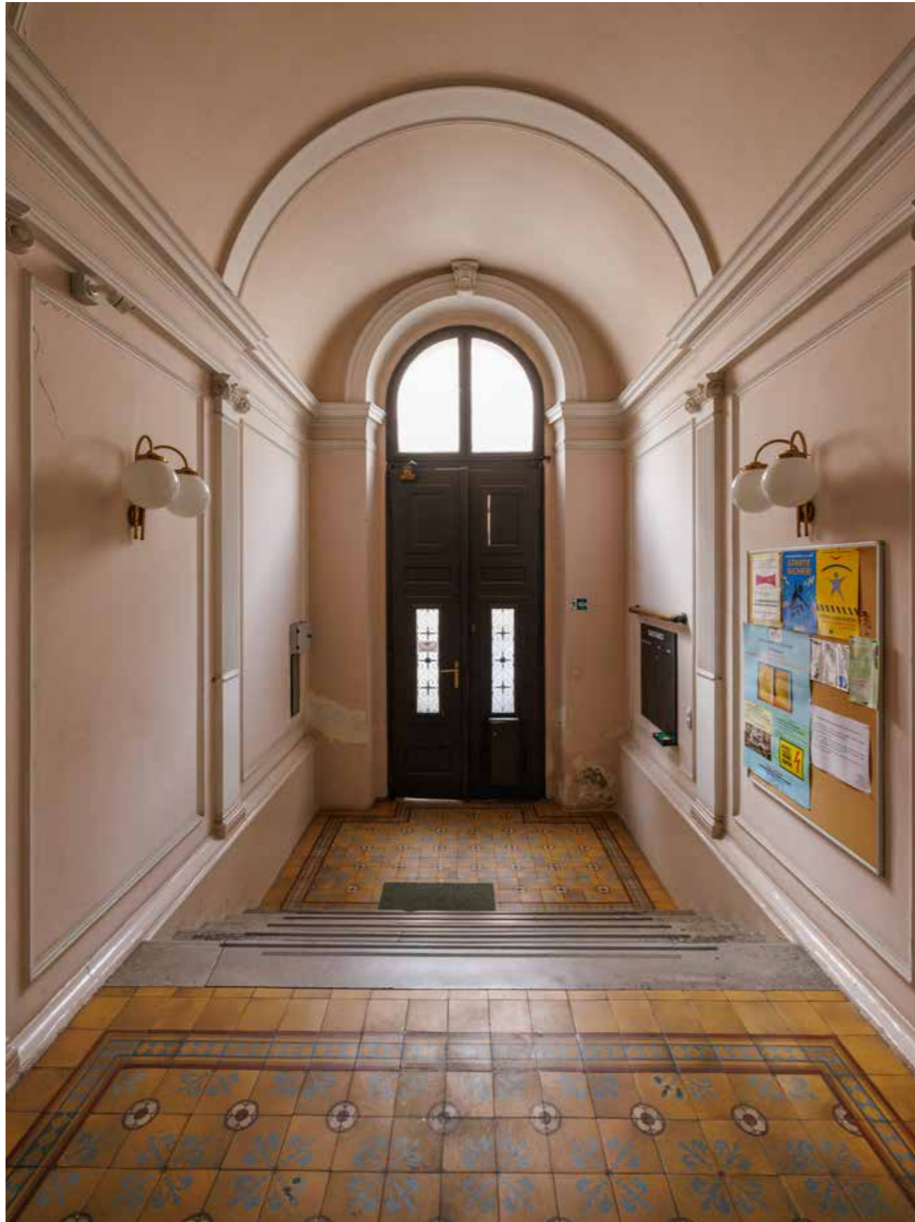
Predvorje (br. 1), pogled prema pročelnom ulazu
