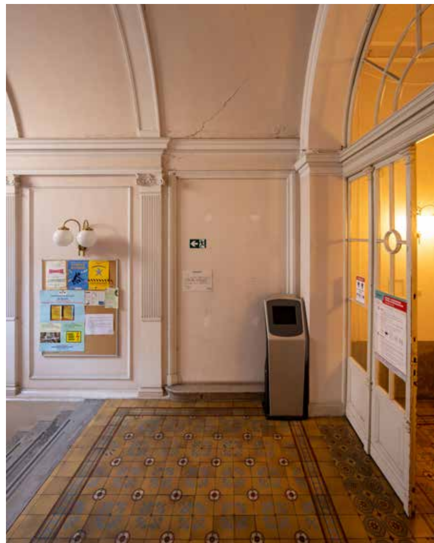
Predvorje, zazidani ulaz u srednji dio prizemlja koji treba rekonstruirati
