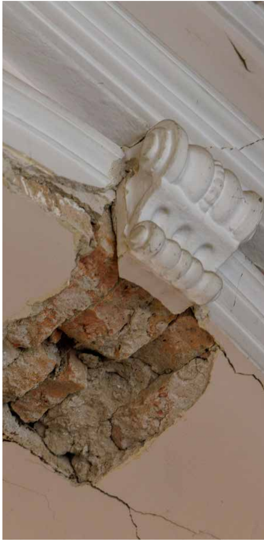
Oštećenja od potresa u interijeru
