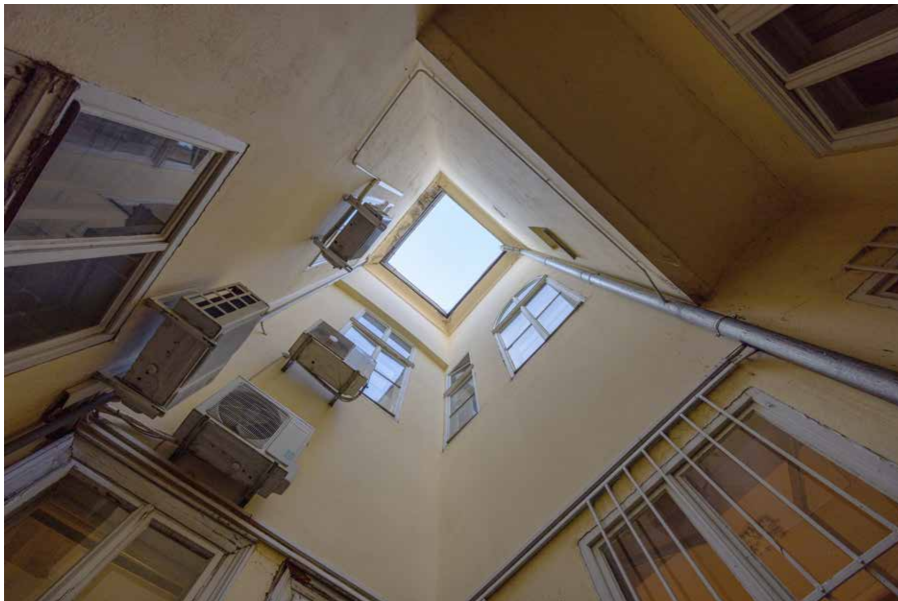
Istočni svjetlarnik, pogled na naknadne ugradnje koje treba ukloniti
