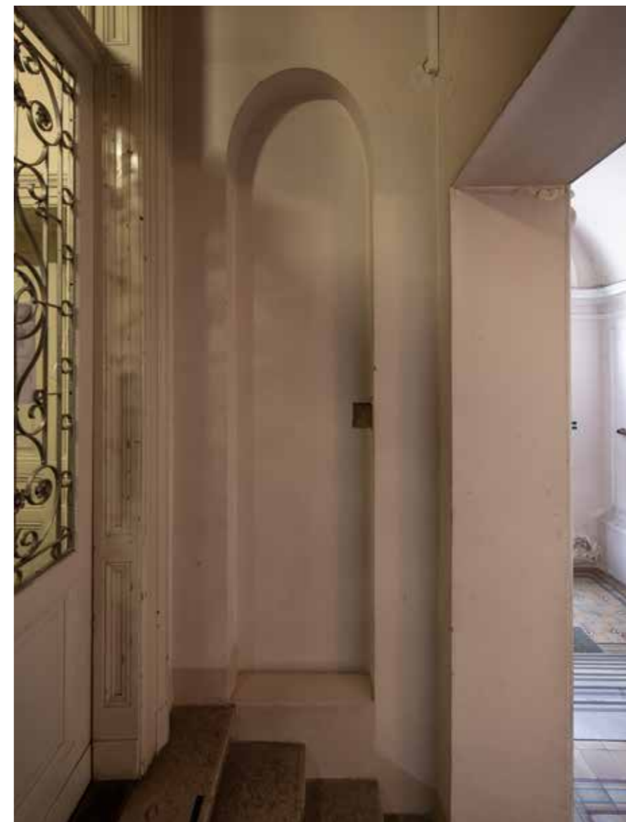
Svod u veži (izmijenjen u gradnji u odnosu na projekt)
