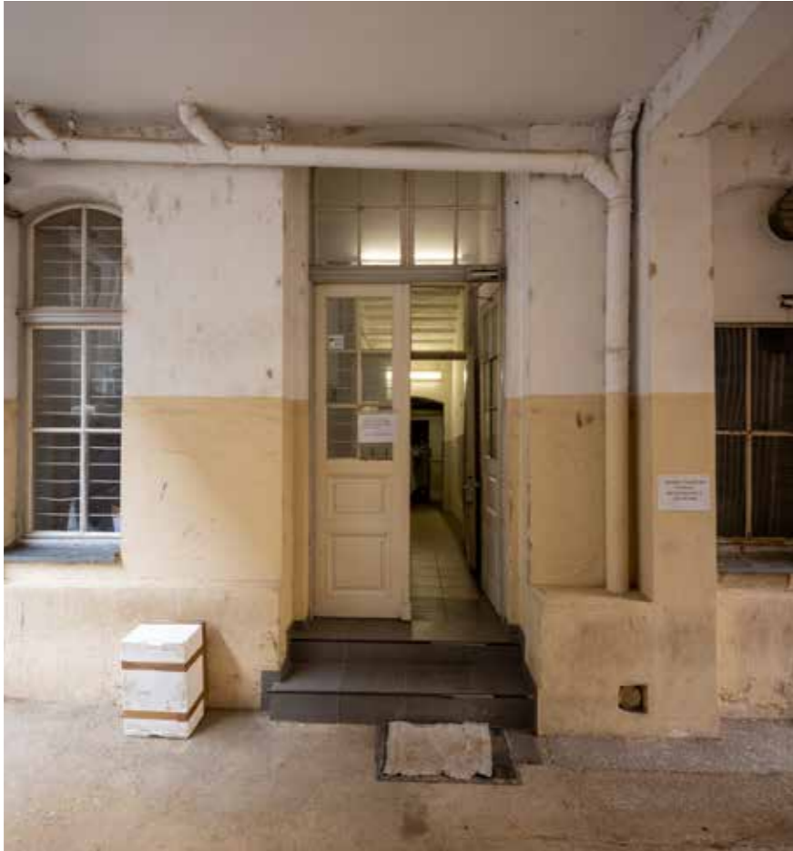
Glavna zgrada – sjeverno dvorišno začelje
