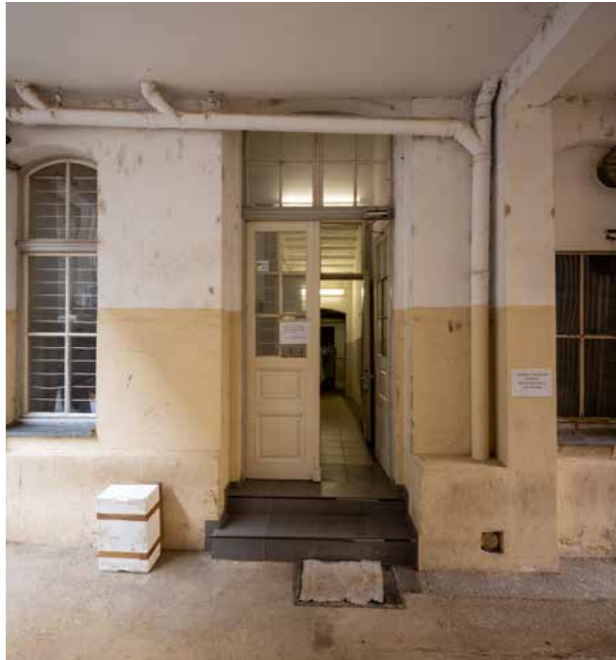
Glavna zgrada – sjeverno dvorišno začelje
