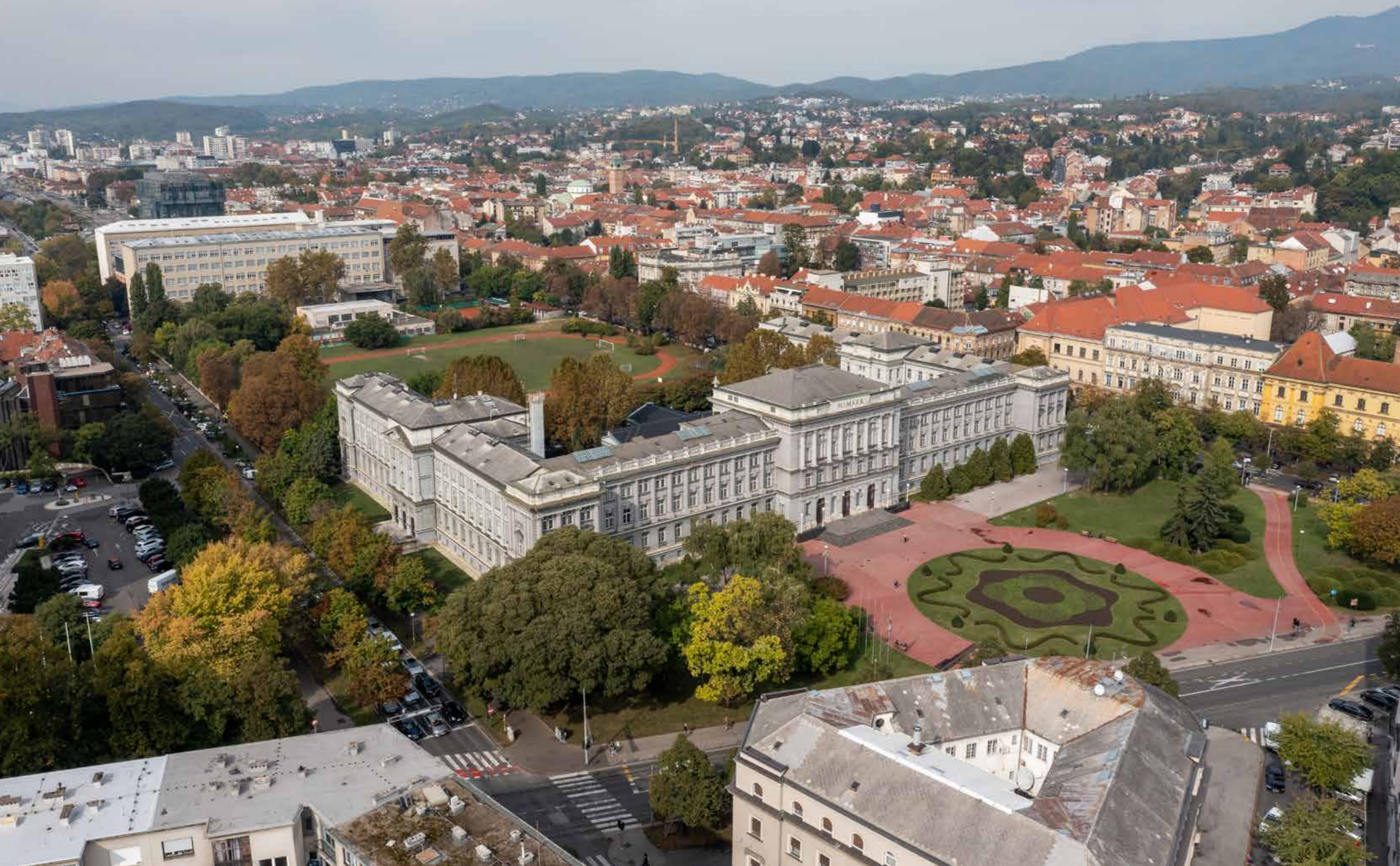
Zgrada Muzeja Mimara, Osnovne škole Izidor Kršnjavi i V. gimnazije, pogled s jugoistoka
