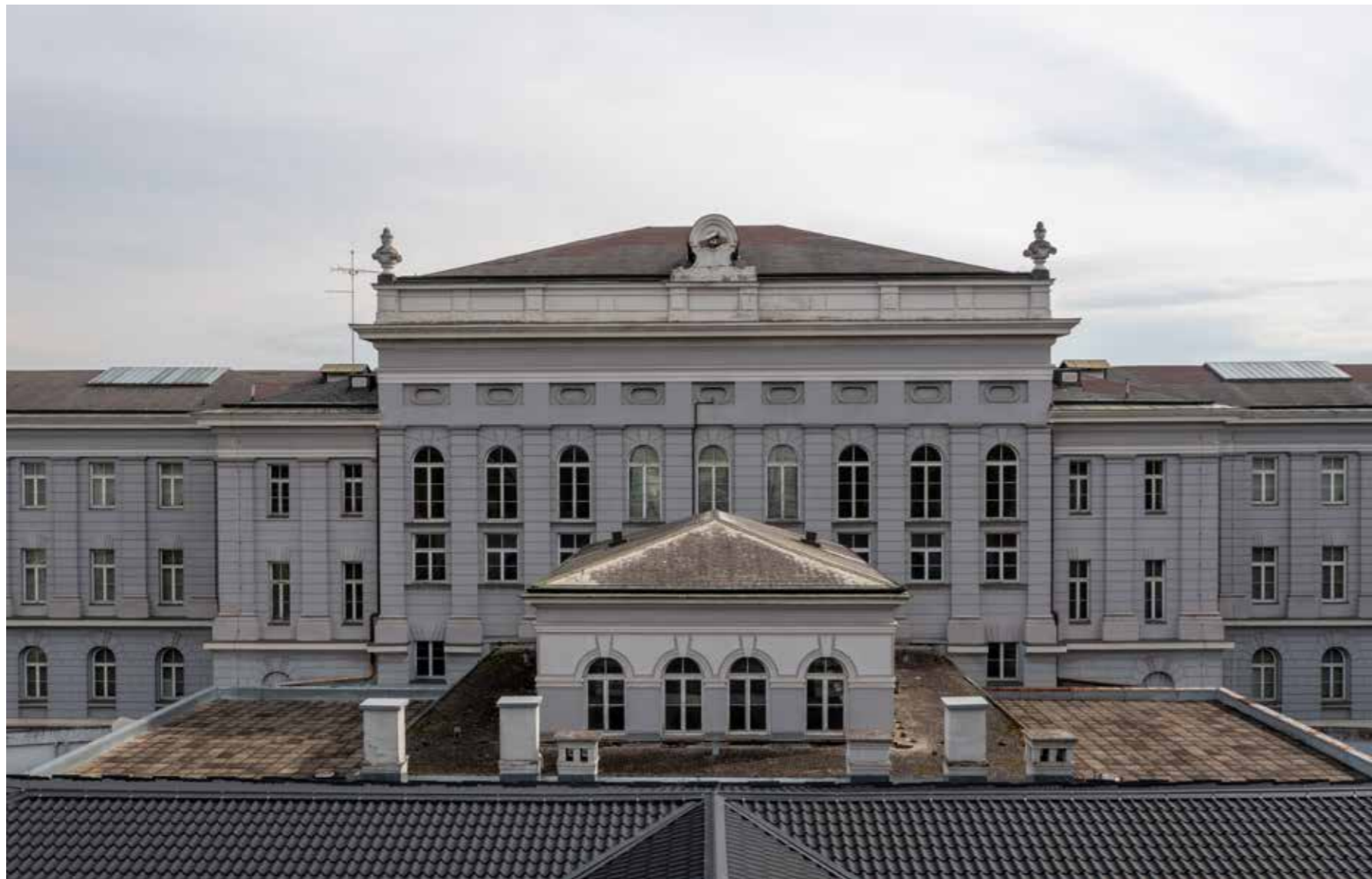
Zapadno pročelje Muzeja Mimara
