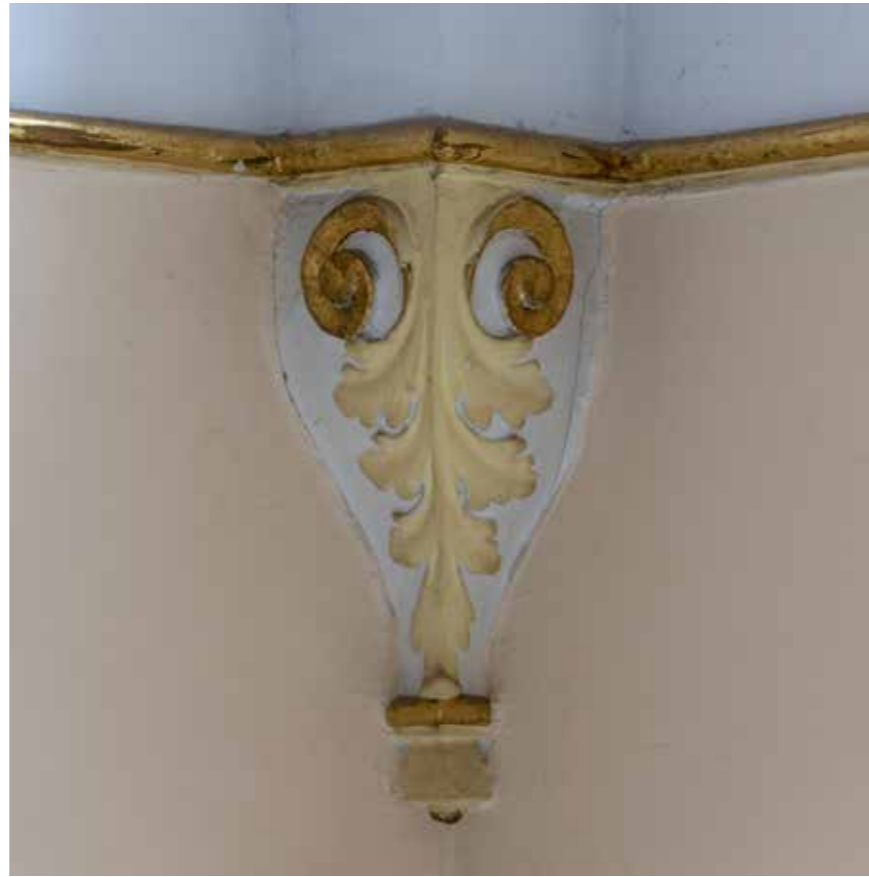
Detalji razdjelnog i krunskog vijenca u atriju
