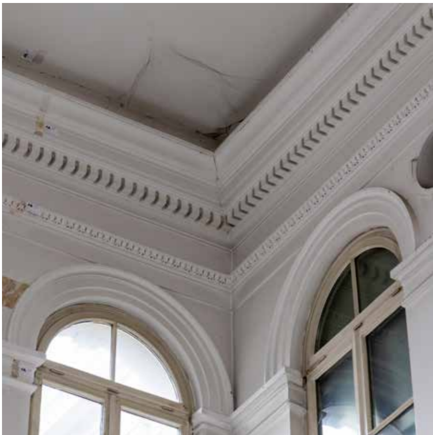
Detalji razdjelnog i krunskog vijenca u atriju
