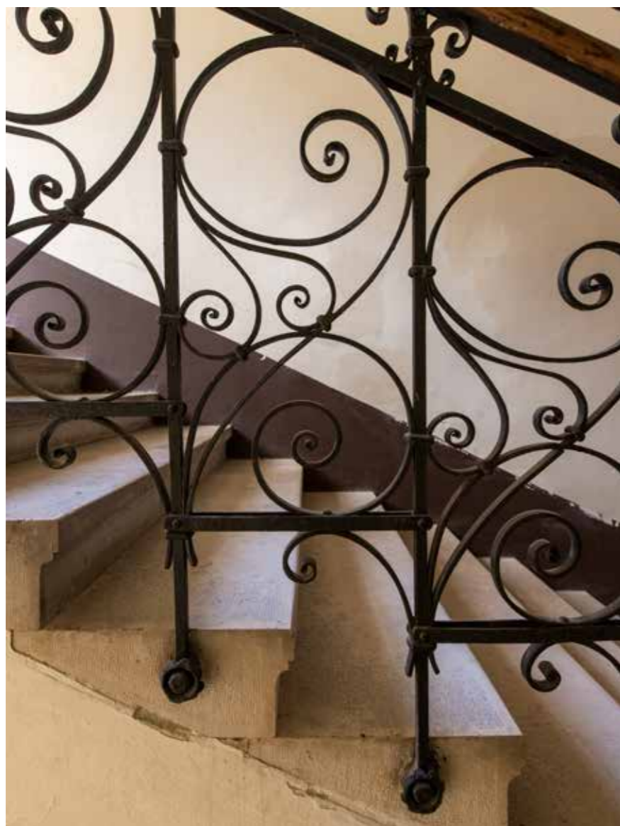
Ograda stubišta • Svjetiljka u ulaznom prostoru Pilastar u stubištu
