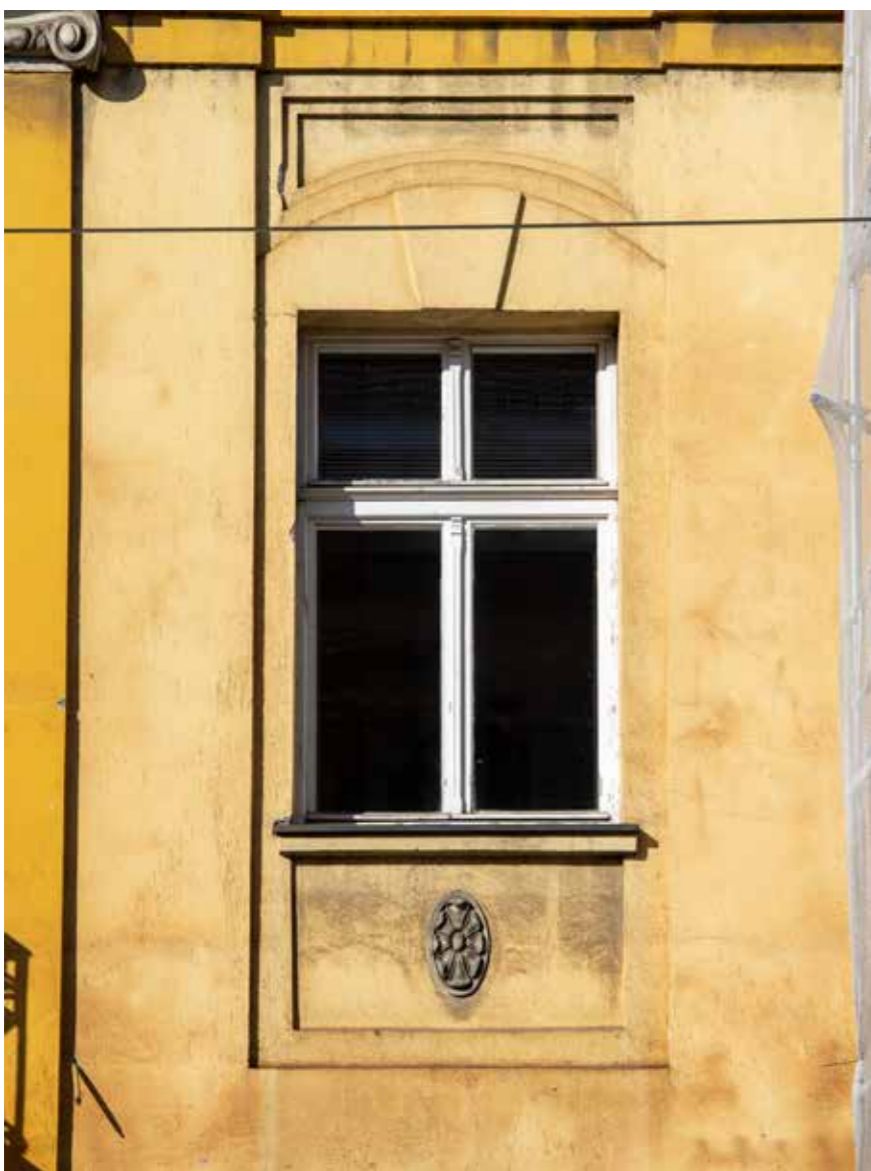
Prozor na prvom katu • Akroterij • Pilastar
