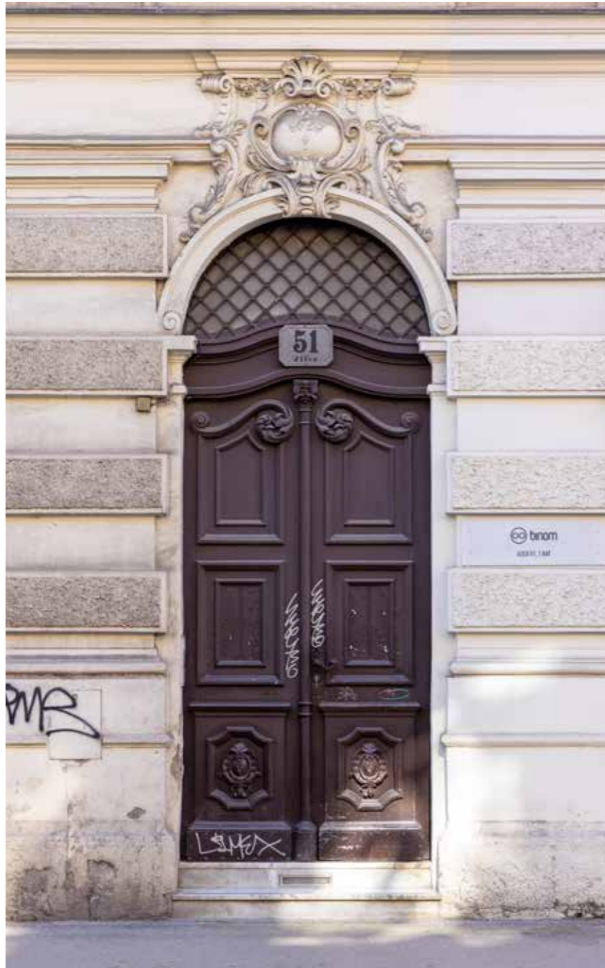
Pročelni portal • Prozor na prvom katu
