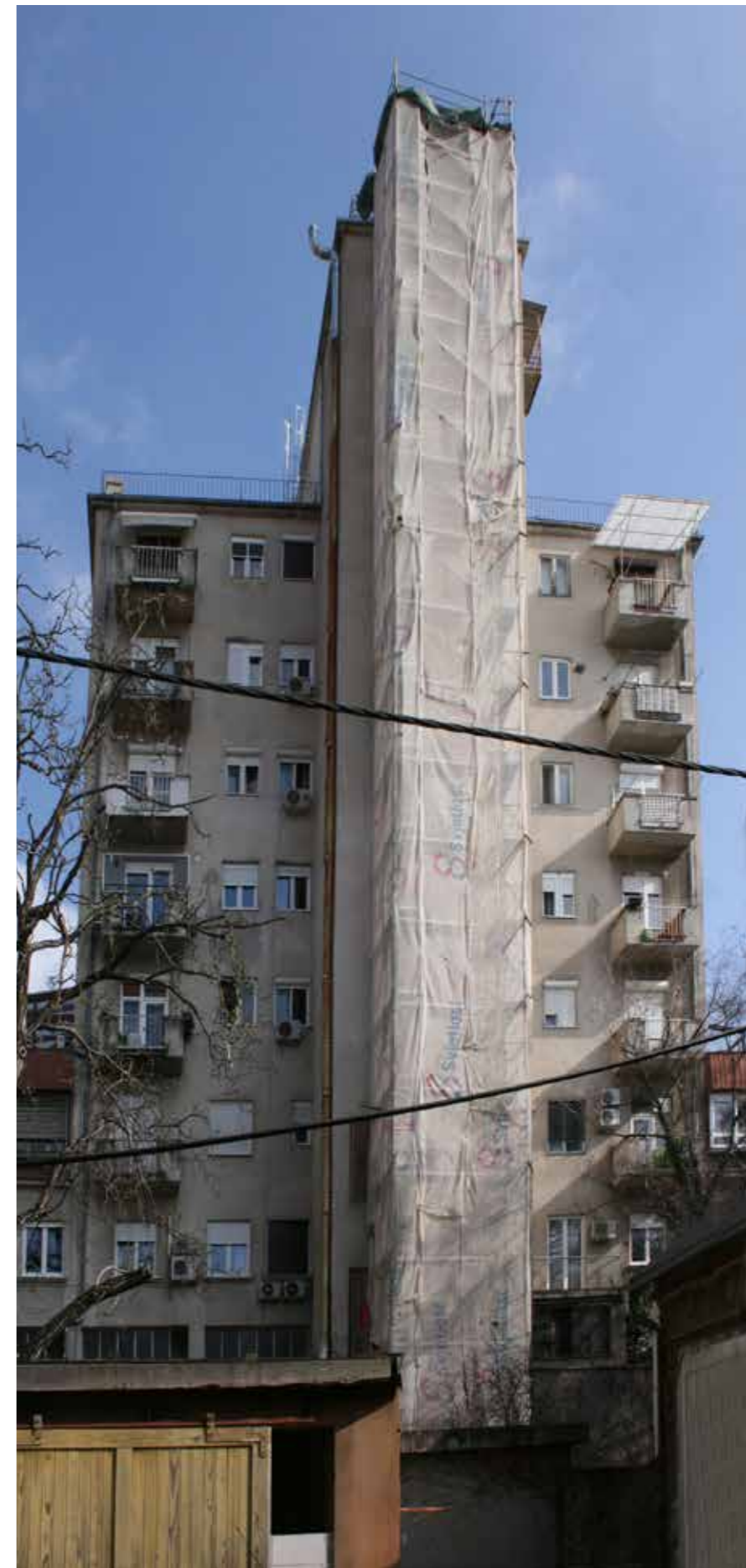
Prva dvorišna zgrada, zapadno pročelje
