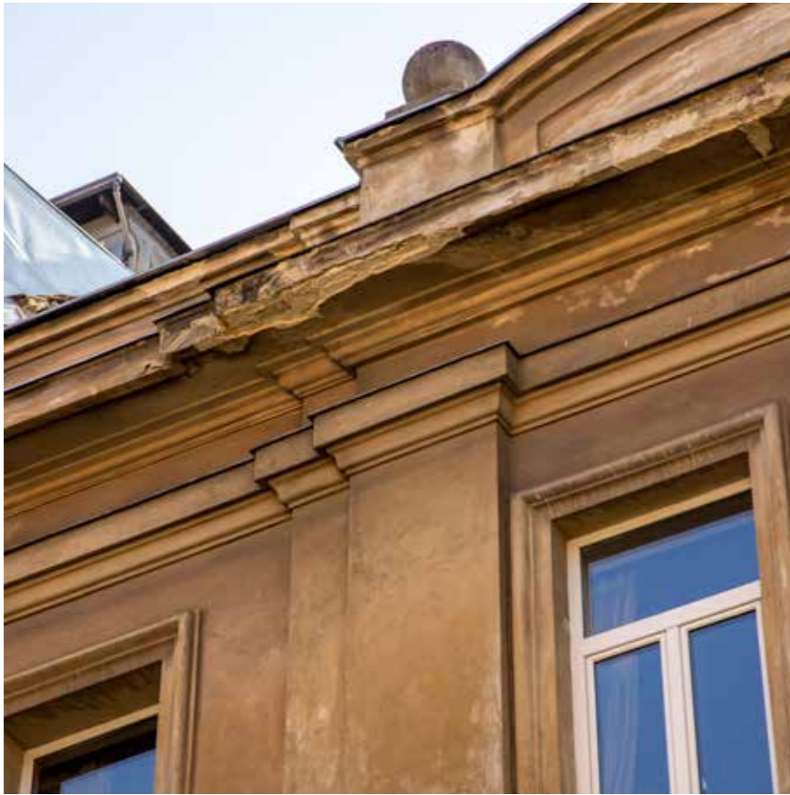
Detalj pilastra i završnog vijenca pročelja
