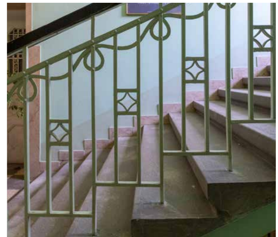
Ograda u stubištu
