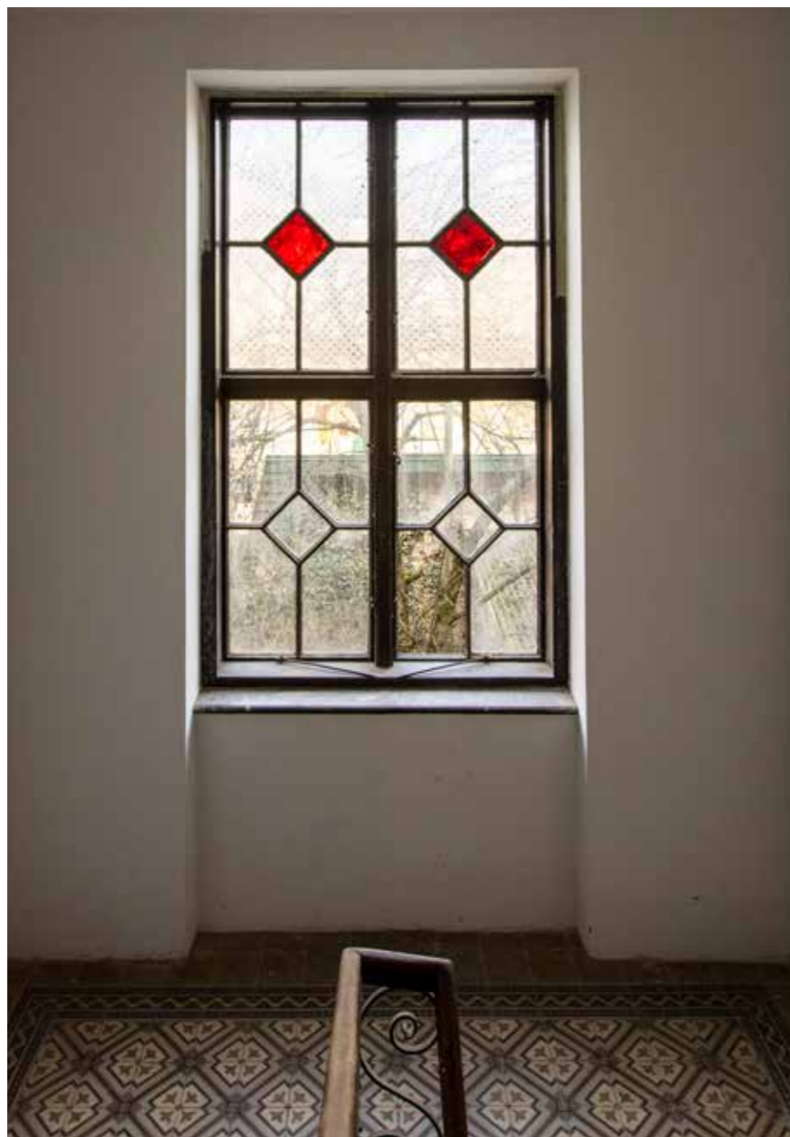
Prozor u stubištu
