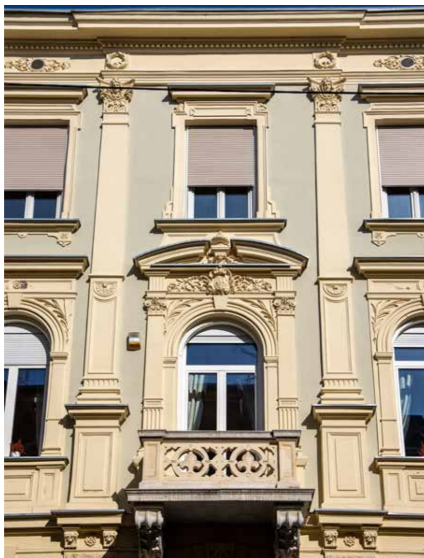
Balkon na prvom katu
