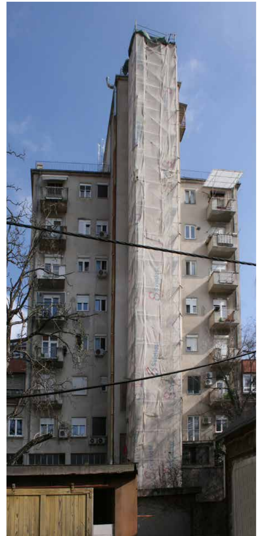
Prva dvorišna zgrada, zapadno pročelje
