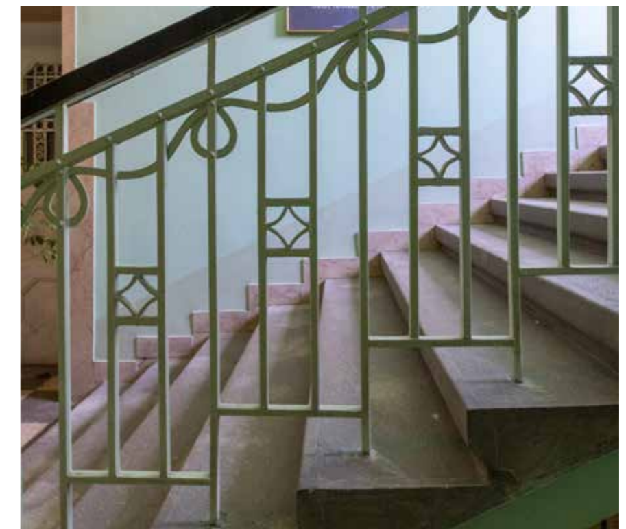
Ograda u stubištu
