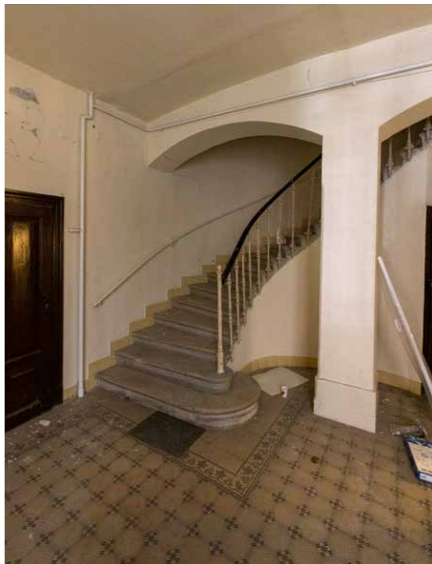
Predvorje sa stubištem unutrašnjeg (dvorišnoga) krila
