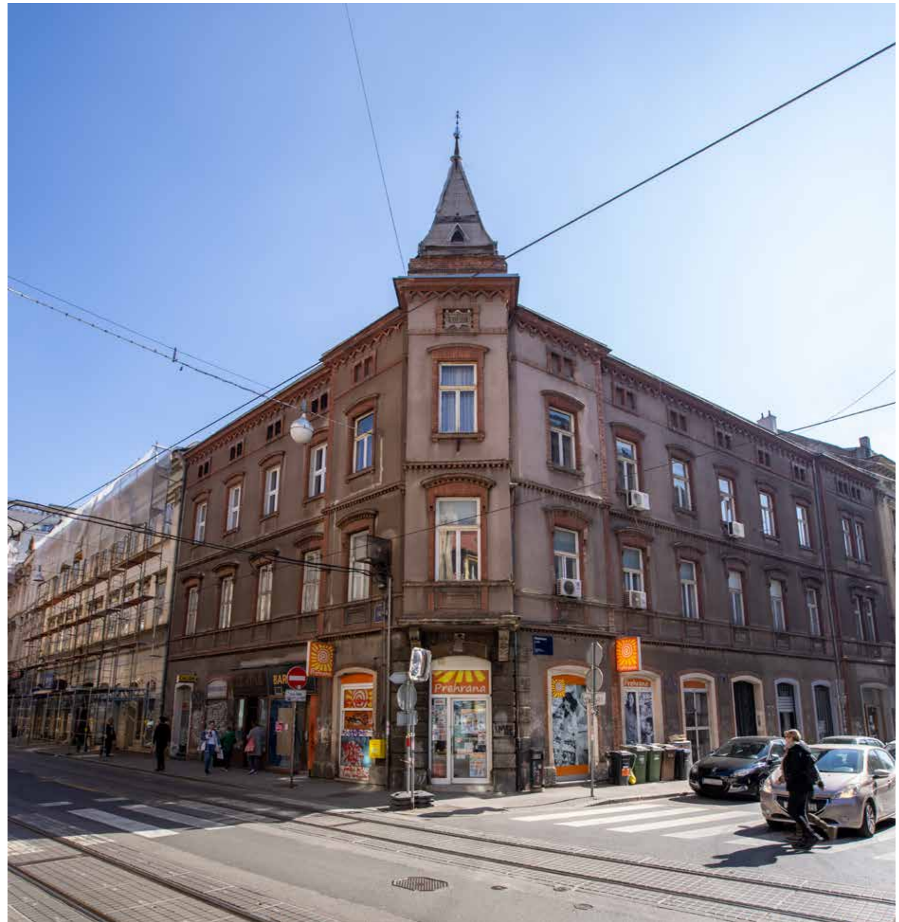
Uglovnica Rossipal, sjeverno i zapadno pročelje
