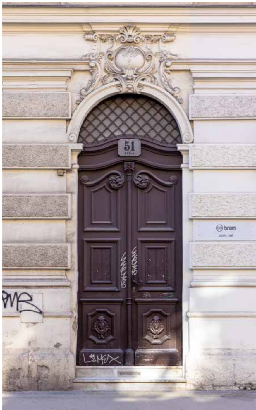
Pročelni portal • Prozor na prvom katu
