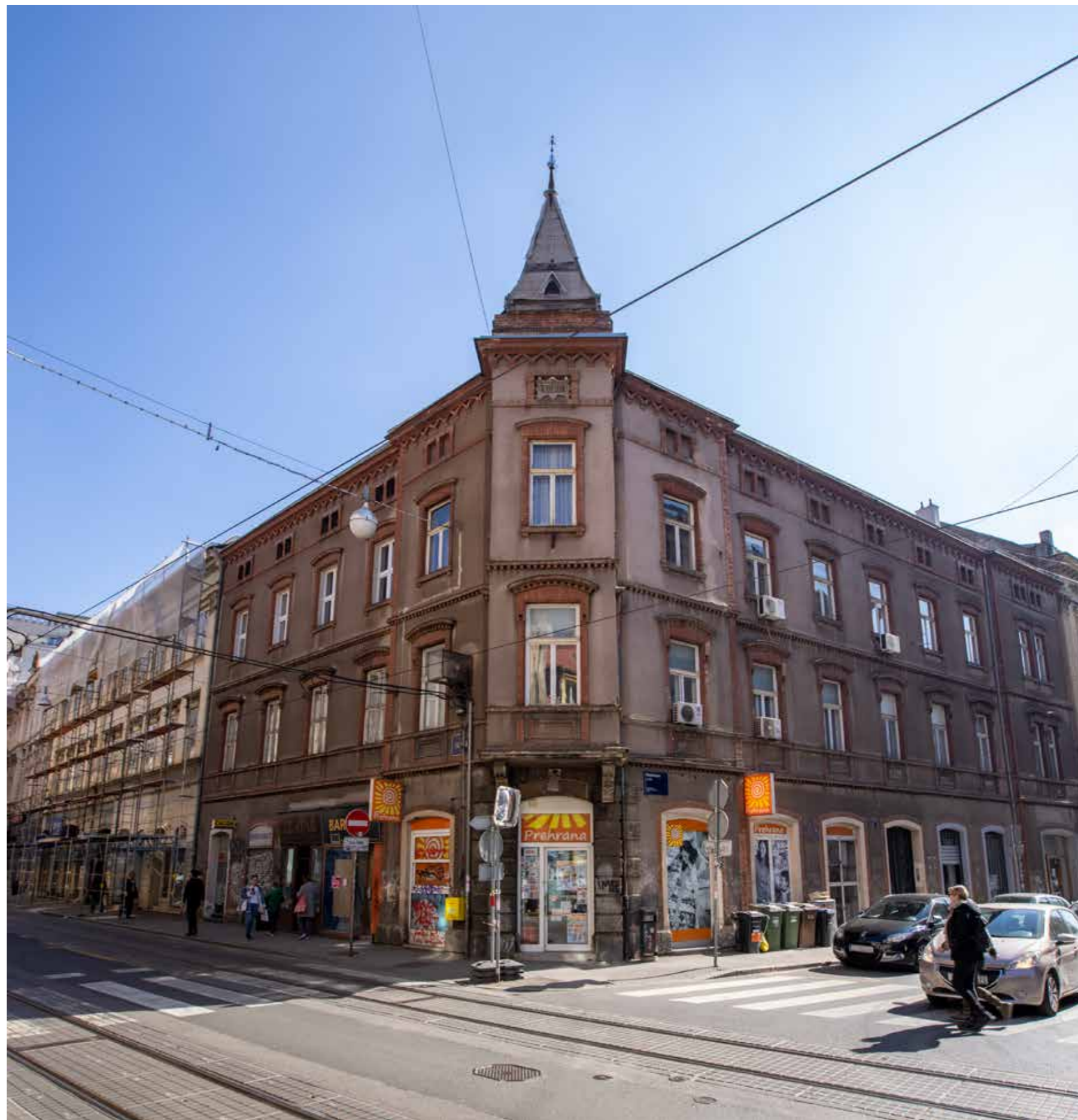
Uglovnica Rossipal, sjeverno i zapadno pročelje
