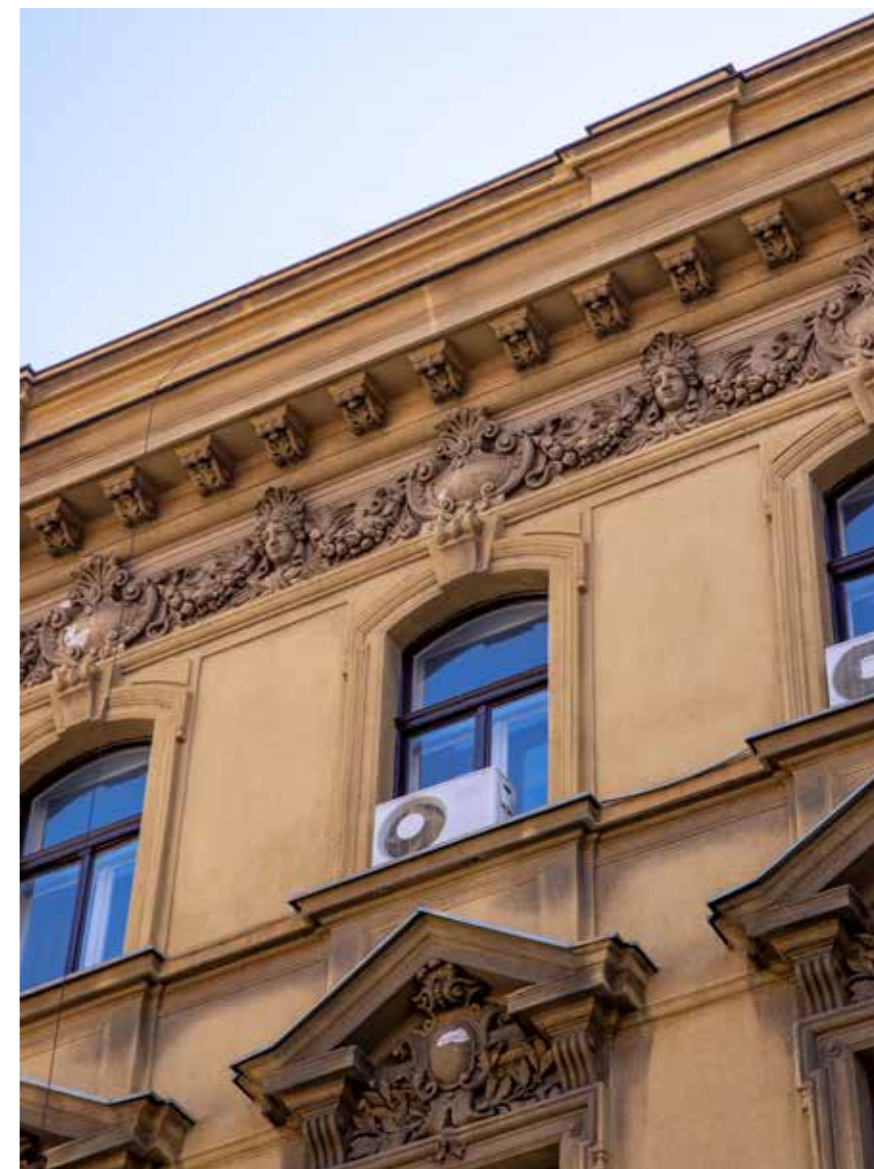
Kuća Hönigsberg, Frankopanska 2, detalj pročelja
