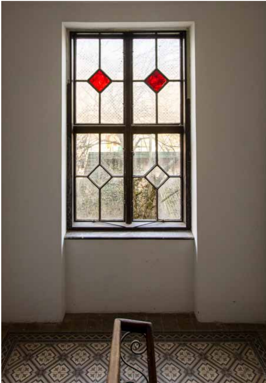
Prozor u stubištu
