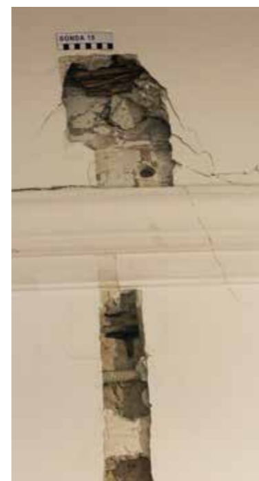
Sonda 15 iznad vrata na južnom zidu sjeverozapadnog salona u prizemlju s tragovima dekorativnih naliča koji pokazuju drukčije oblikovanje svoda prostorije
