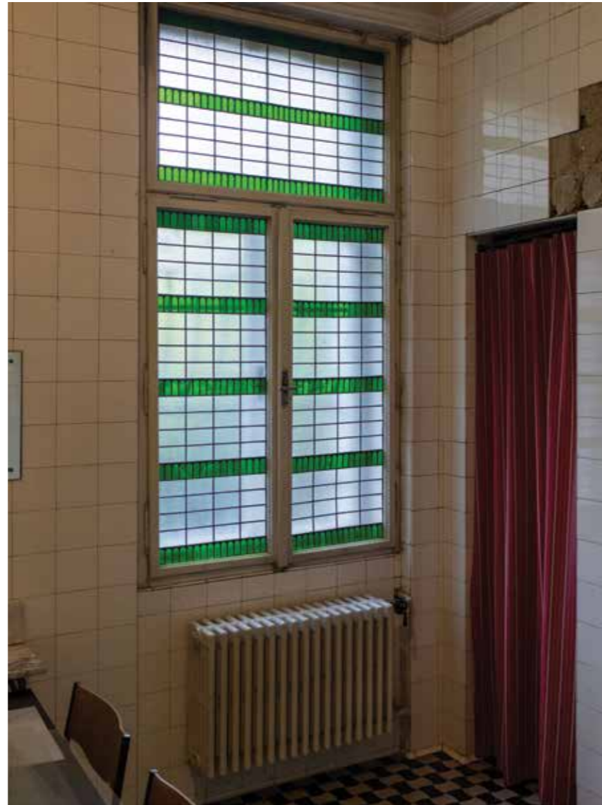
Prizemlje, kupaonica – detalji vitraja, sanitarne opreme i opločenja poda
