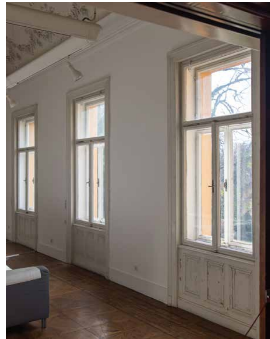
Prozori s drvenom oblogom parapeta
