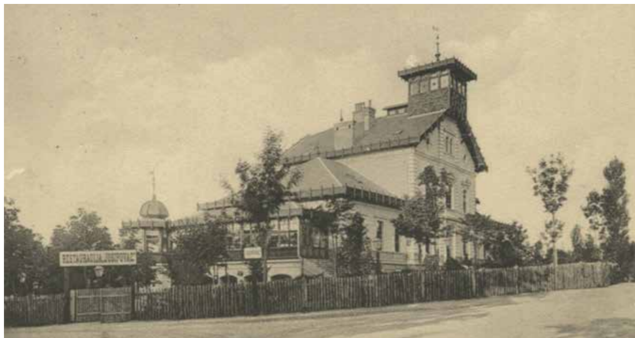
Ljetnikovac Ehrlich s restauracijom »Josipovac«, pogled sa sjeveroistoka, između 1891. i 1898., MGZ
