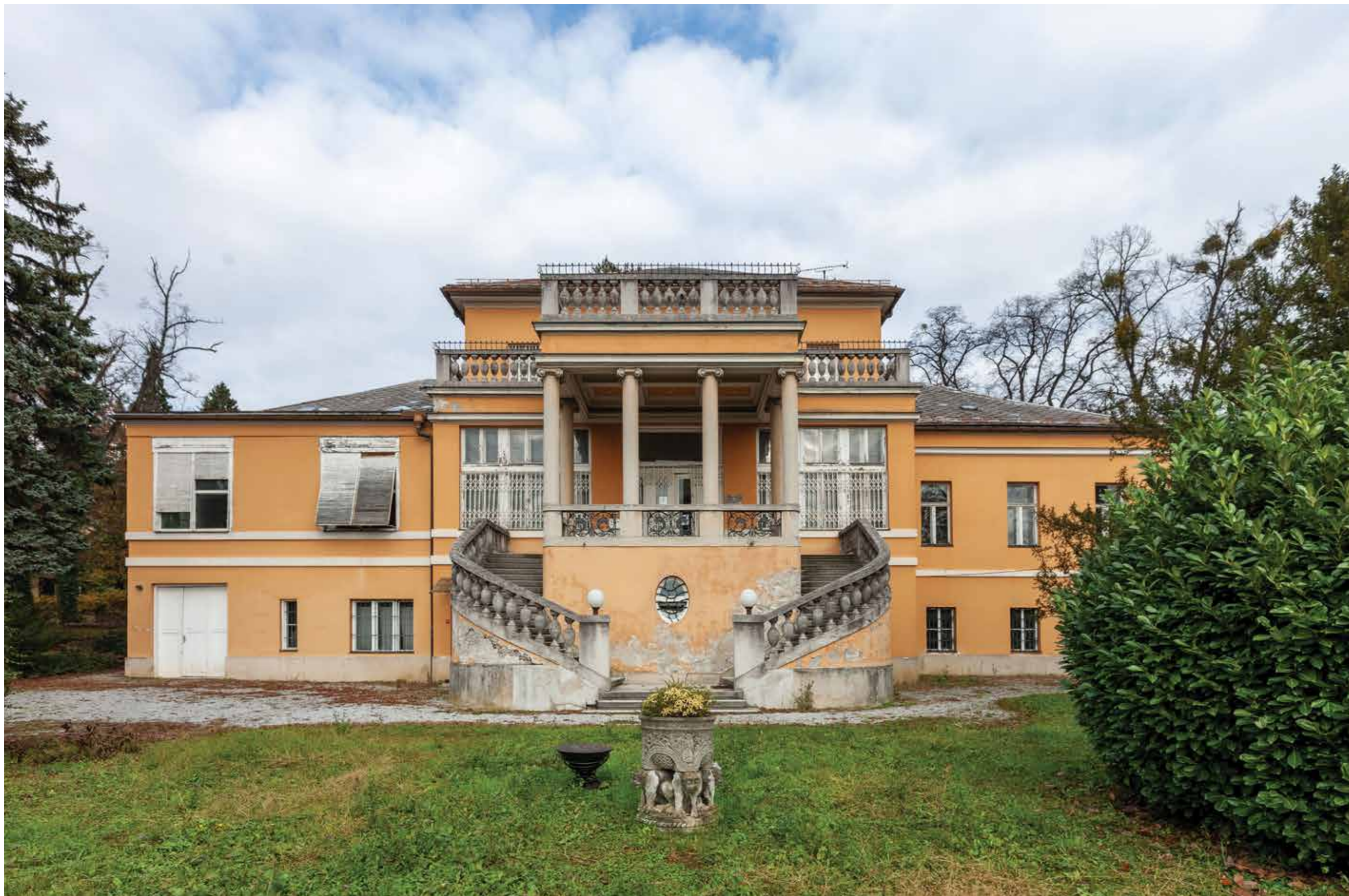
Južno ulazno pročelje
