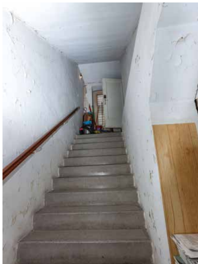
Podrum, unutrašnje stubište između podruma i prizemlja
