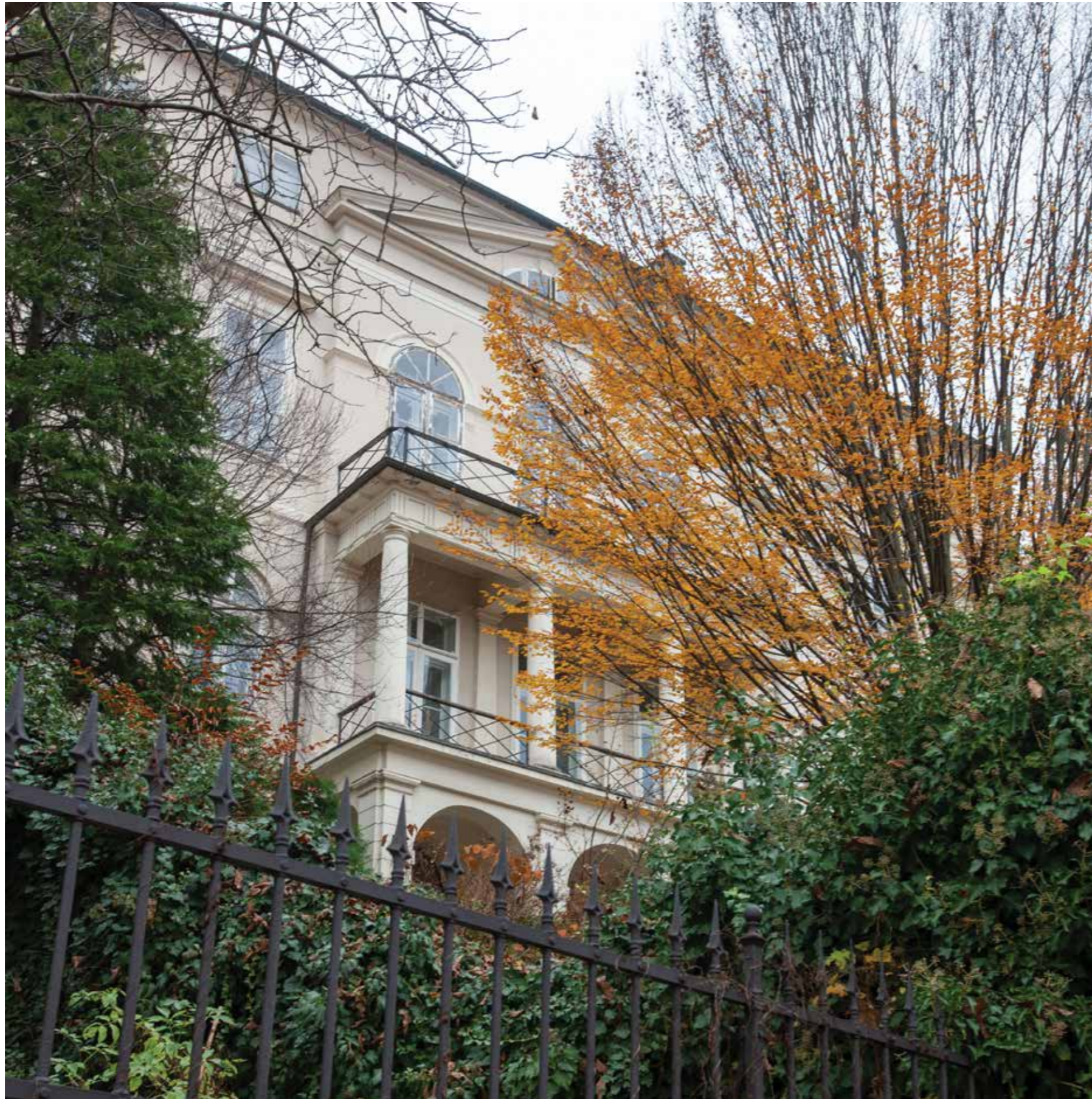
Istočno pročelje s altanom
