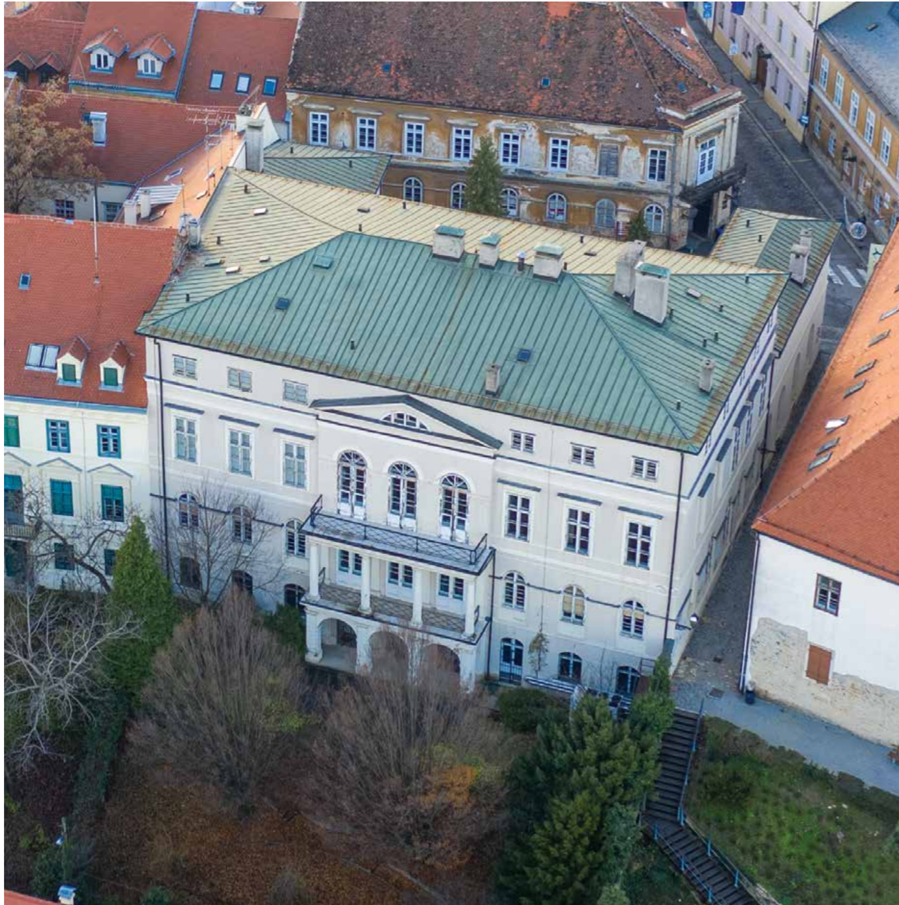
Istočno pročelje s altanom
