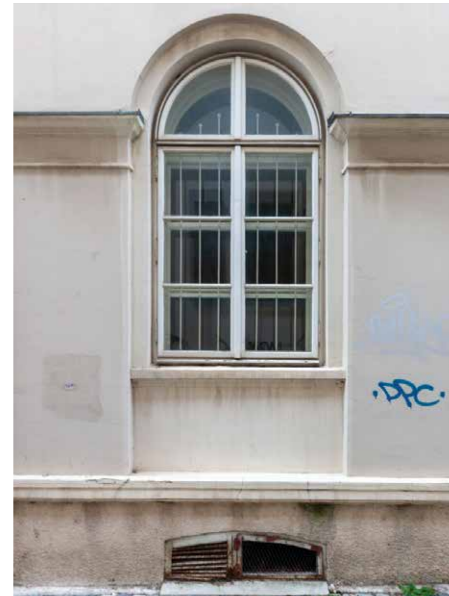
Prozor na sjevernom pročelju
