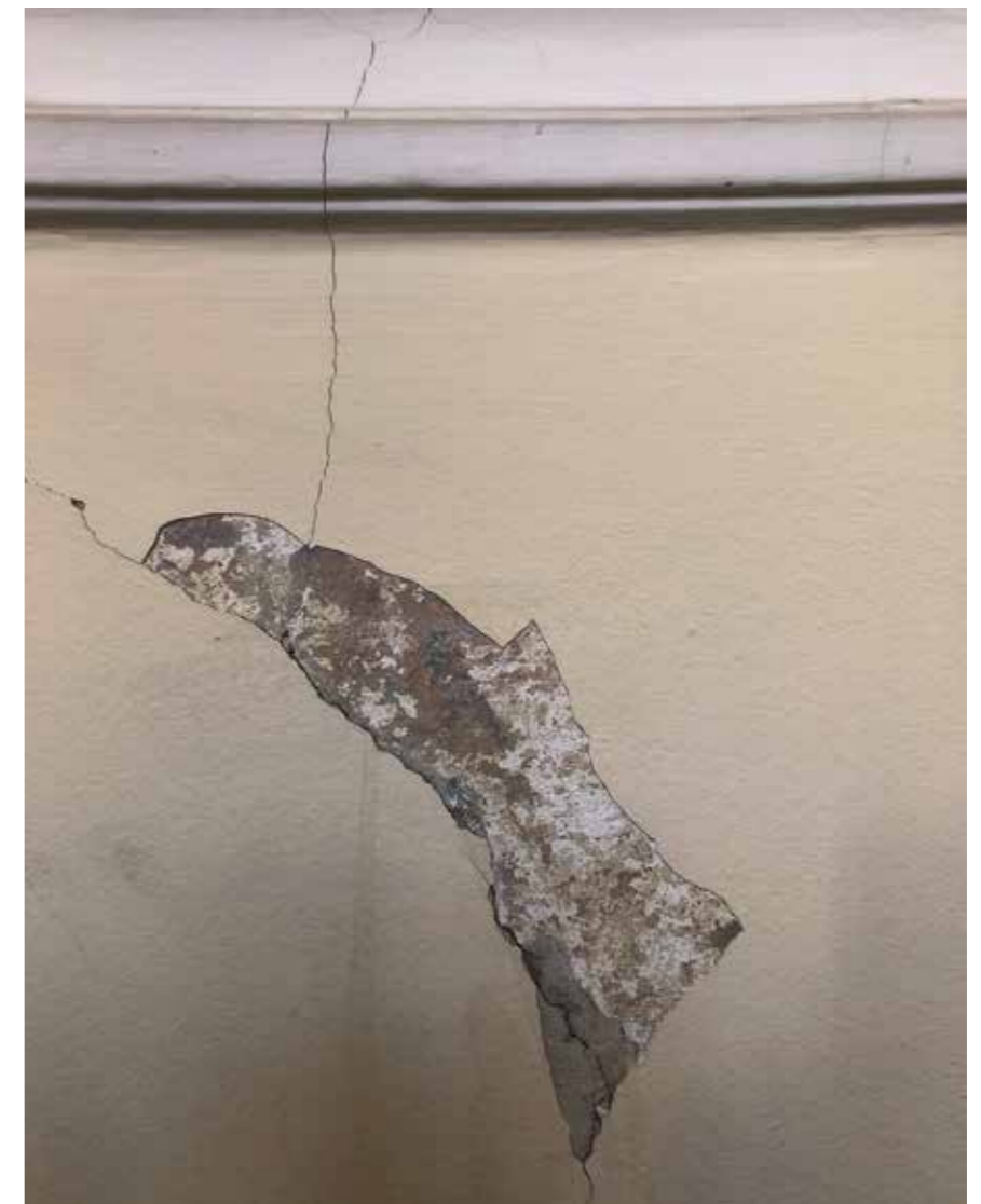
Tipični primjeri oštećenja nastalih u potresu
