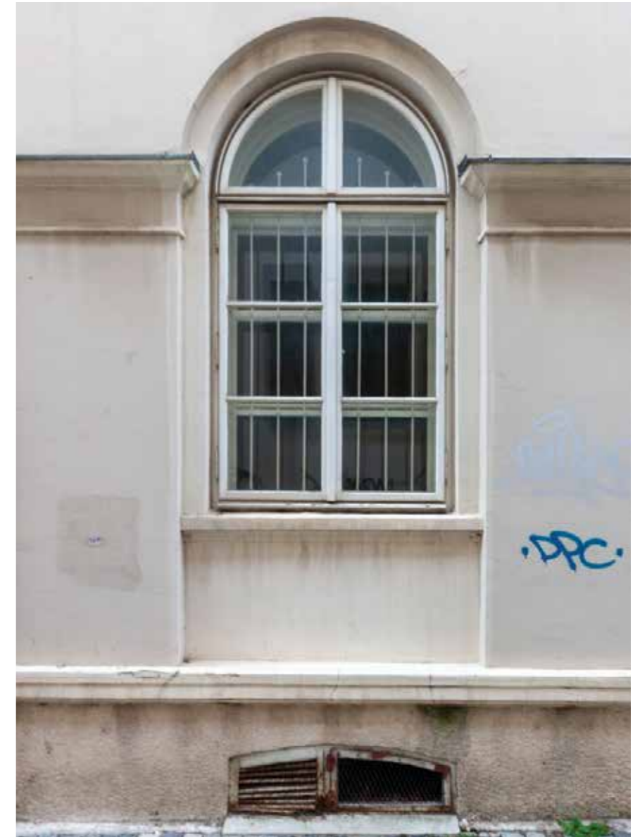
Prozor na sjevernom pročelju
