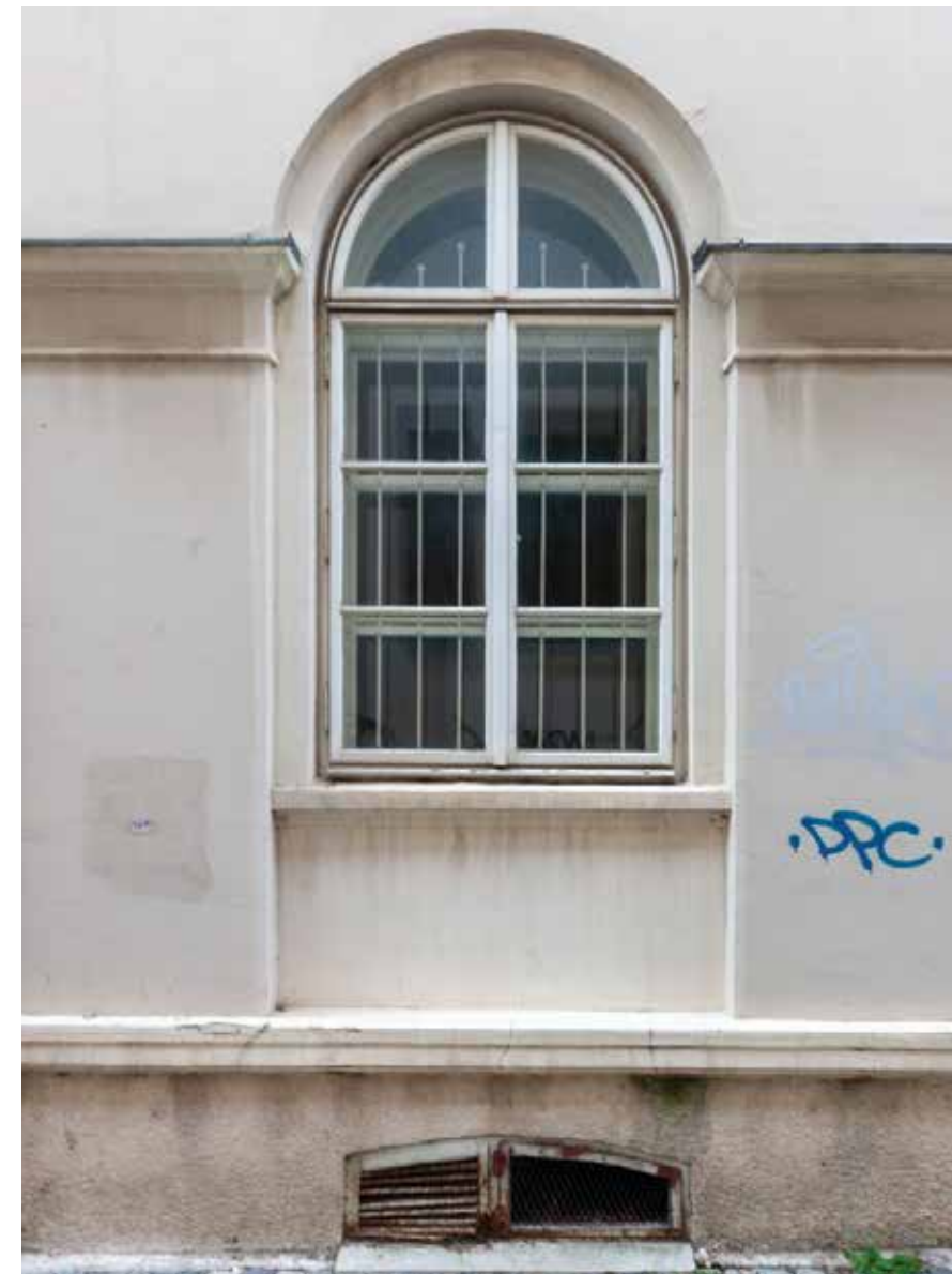
Prozor na sjevernom pročelju
