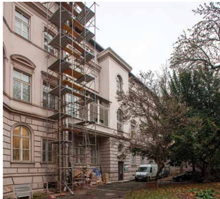
Dvorišna pročelja sjevernog i istočnog krila
