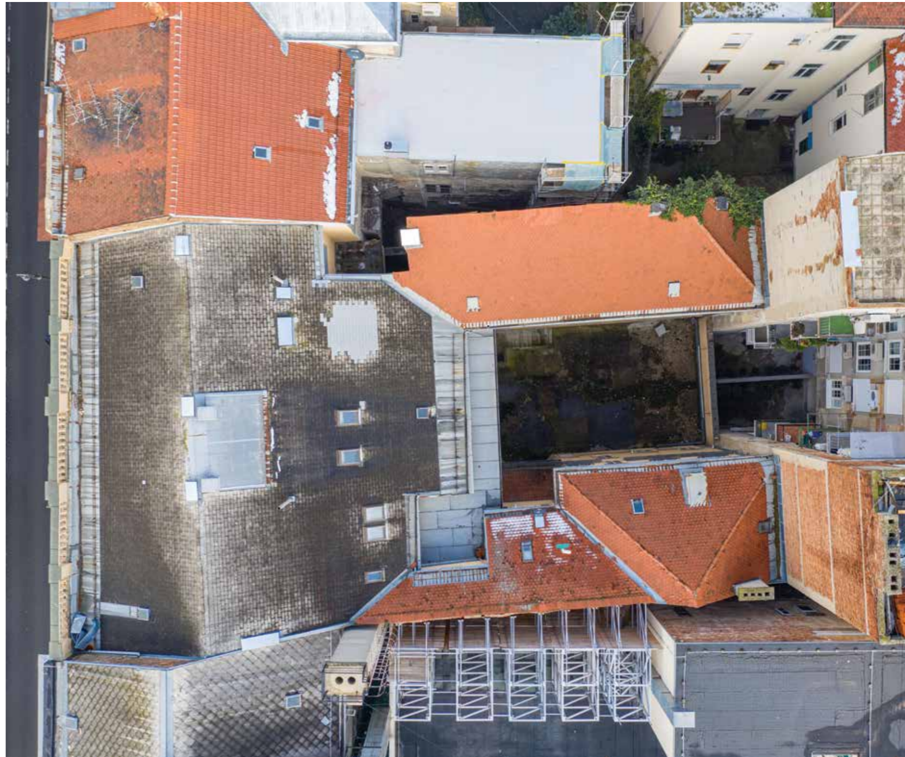
Pogled na krovište
