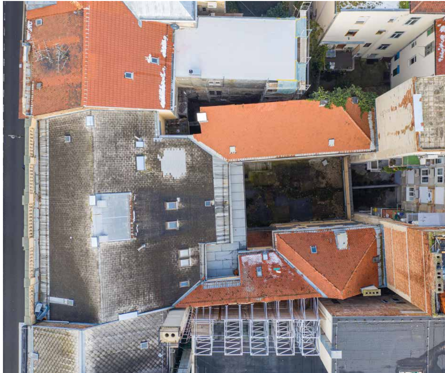
Pogled na krovište
