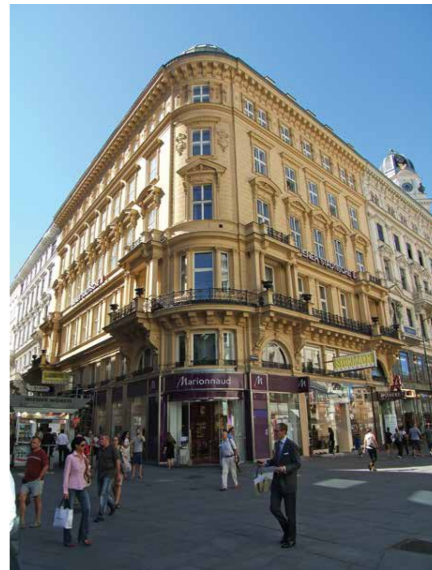
Najamna zgrada u Beču, Graben 7, Ludwig Tischler, 1875.
