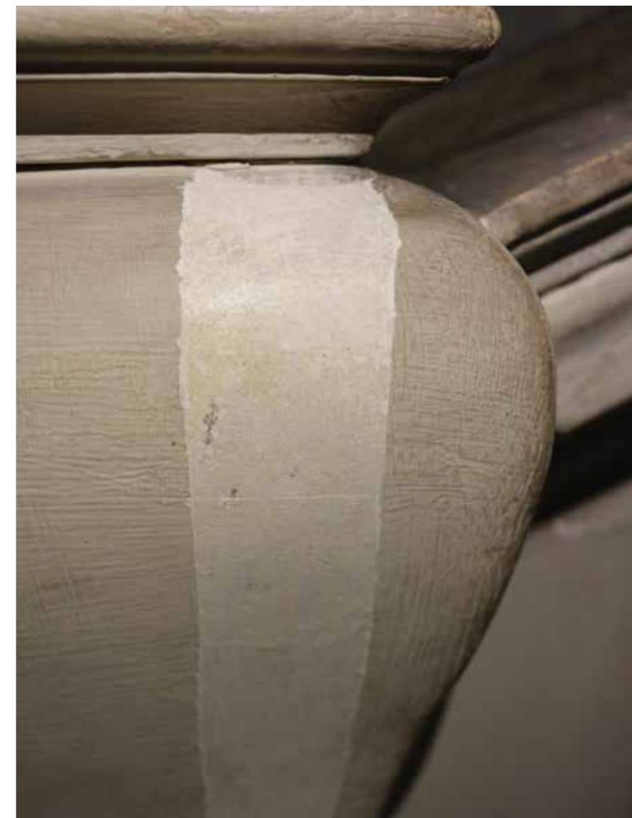
Sonde 19 i 20 na balustrima u stubištu s vidljivom izvornom marmorizacijom
