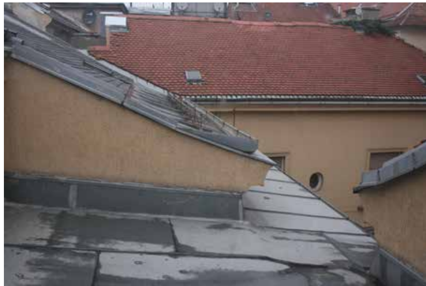
Središnji dio krovišta sa svjetlikom
