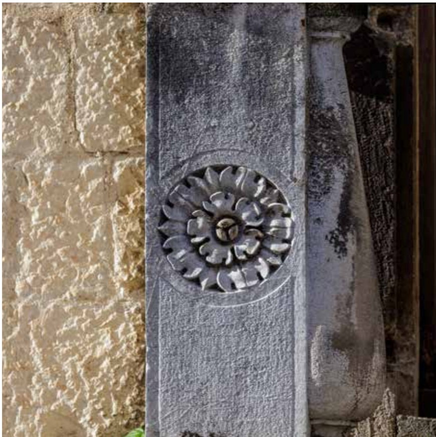
Balkon na prvom katu, detalj
