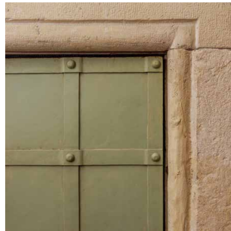
Portal spremišta ispod stuba, detalj
