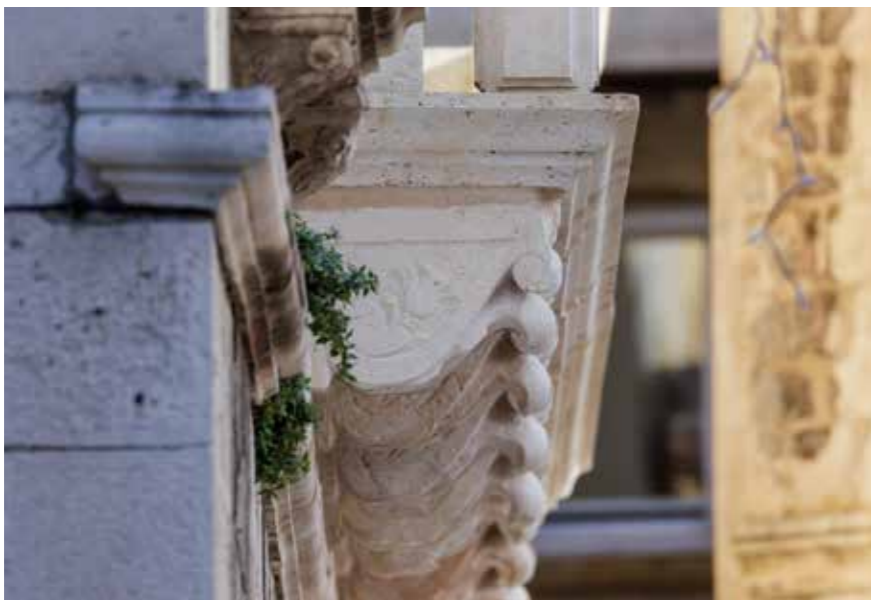
Konzole balkona na prvom katu
