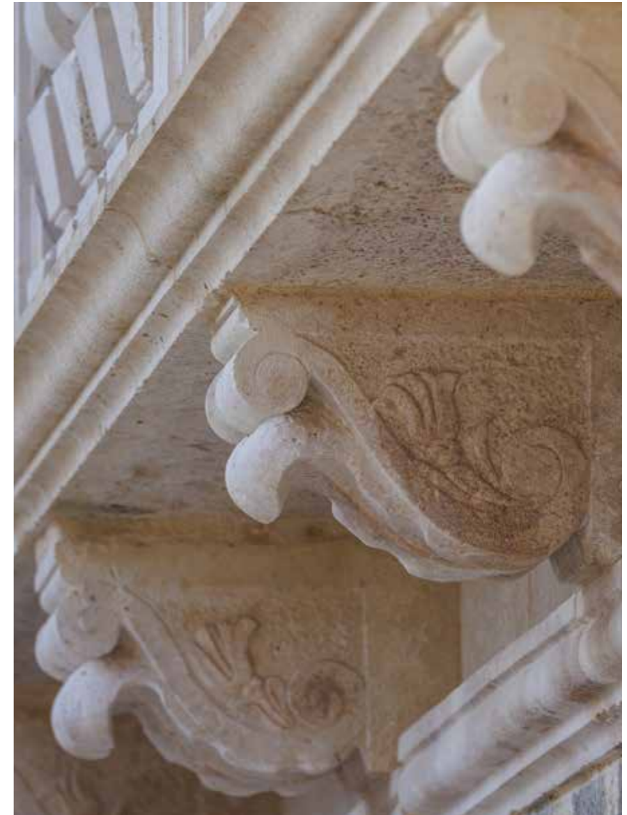
Konzole balkona na južnom pročelju nakon restauracije
