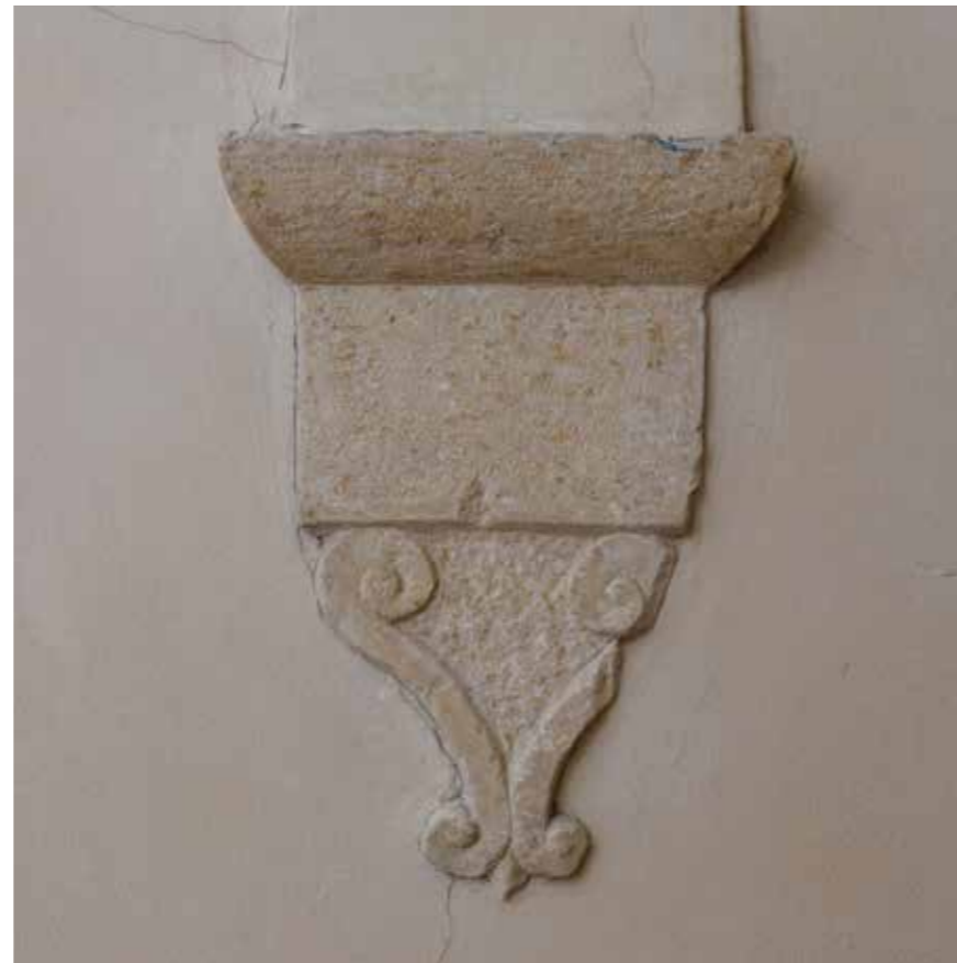
Konzola na podestu na prvom katu
