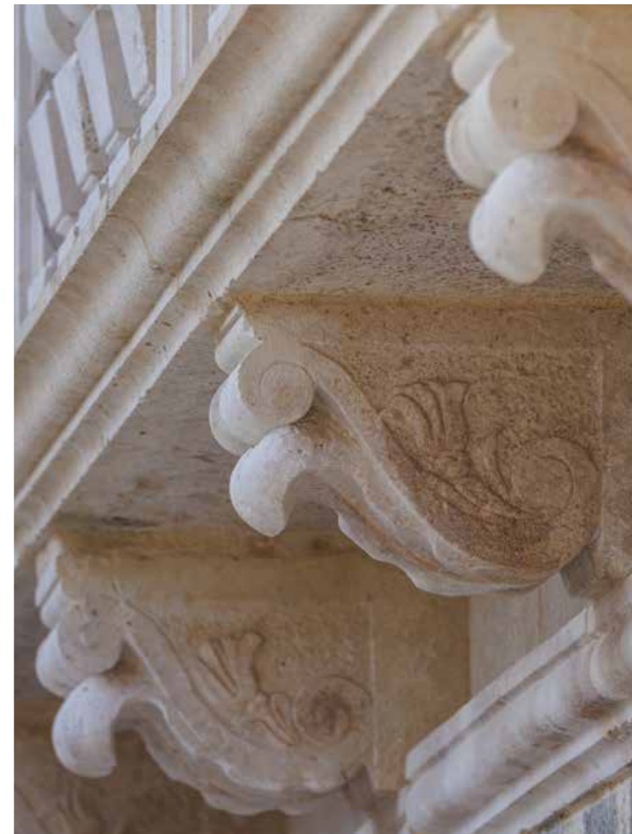
Konzole balkona na južnom pročelju nakon restauracije
