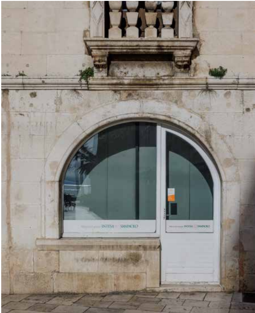
Južno pročelje, dućanski otvor u prizemlju
