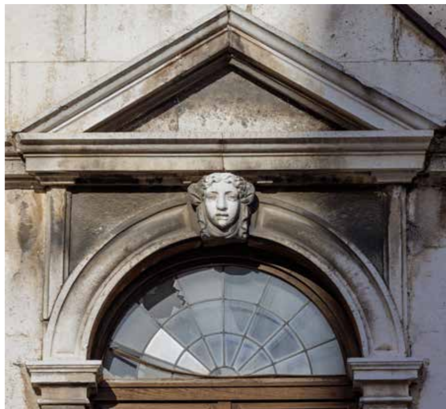
Balkonska vrata na prvom katu, detalj
