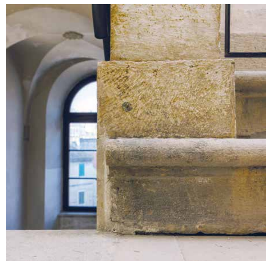
Baza pilastra na podestu na trećem katu
