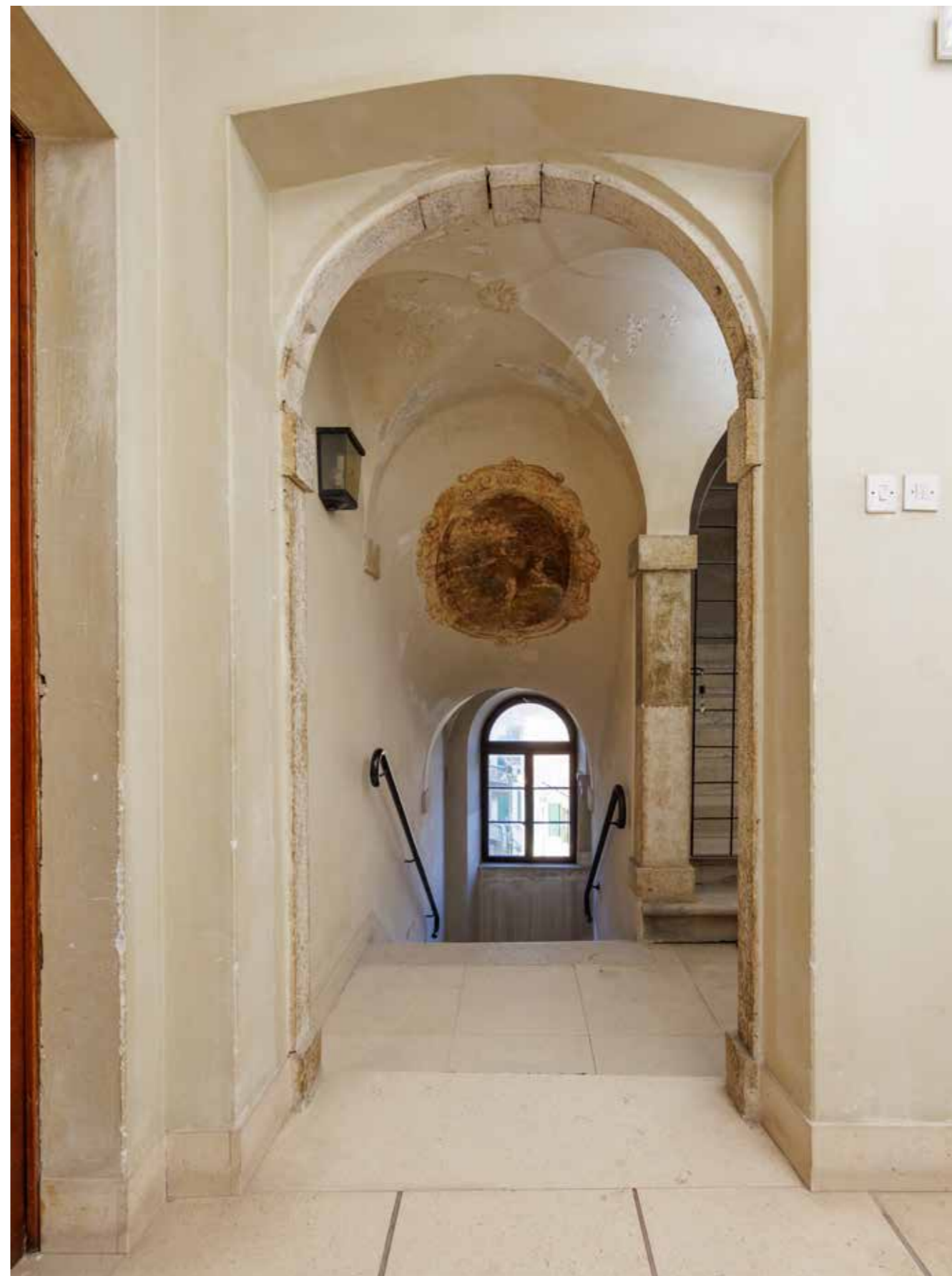
Pogled iz trećeg kata na stubište
