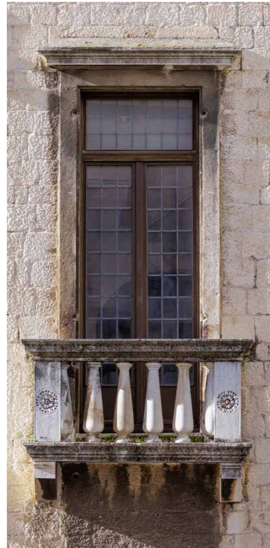
Istočno pročelje, balkon na prvom katu
