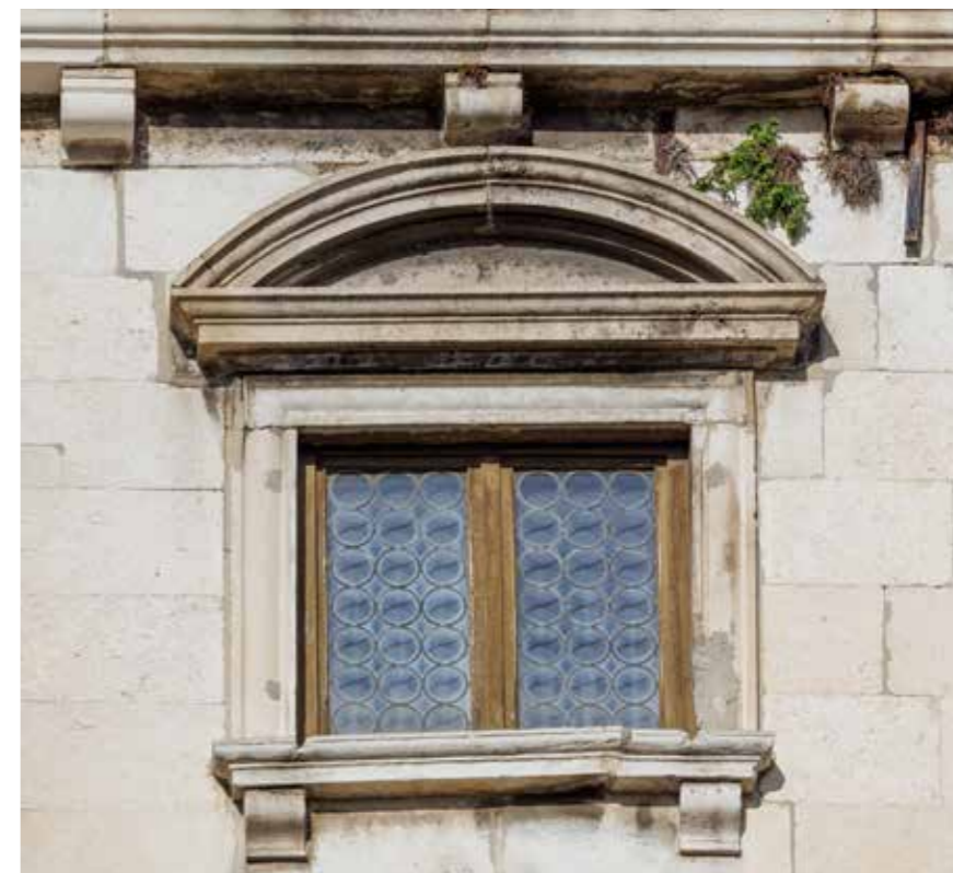
Prozor na trećem katu
