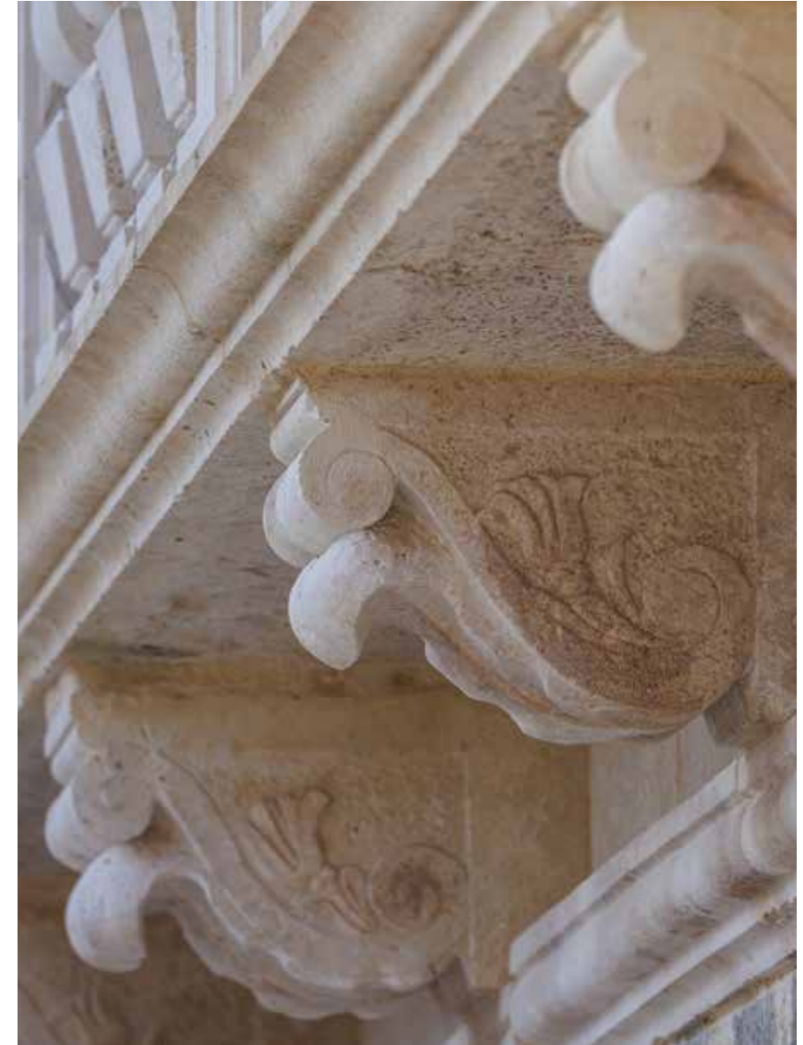
Konzole balkona na južnom pročelju nakon restauracije
