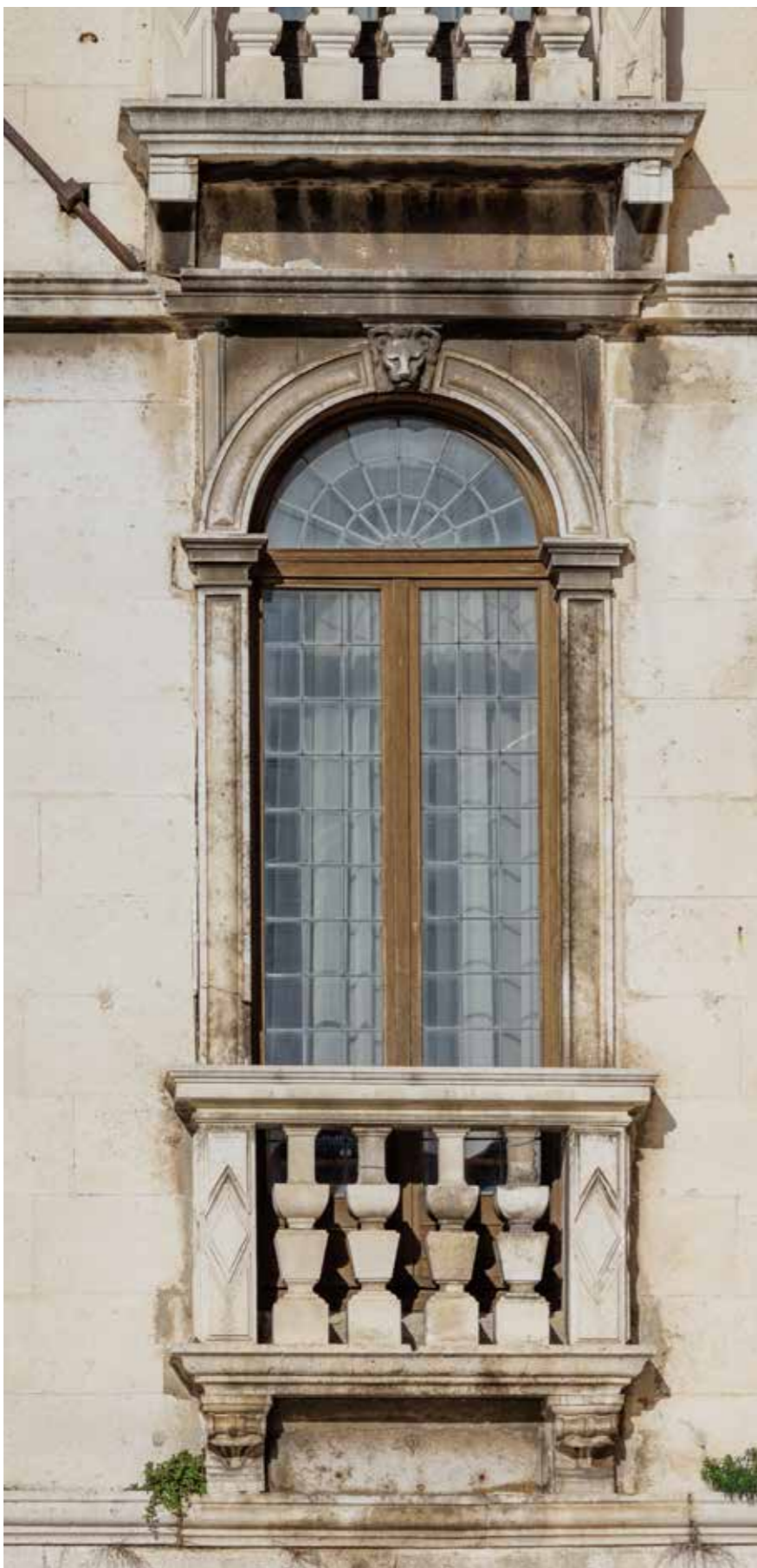
Južno pročelje, francuski prozor na prvom katu
