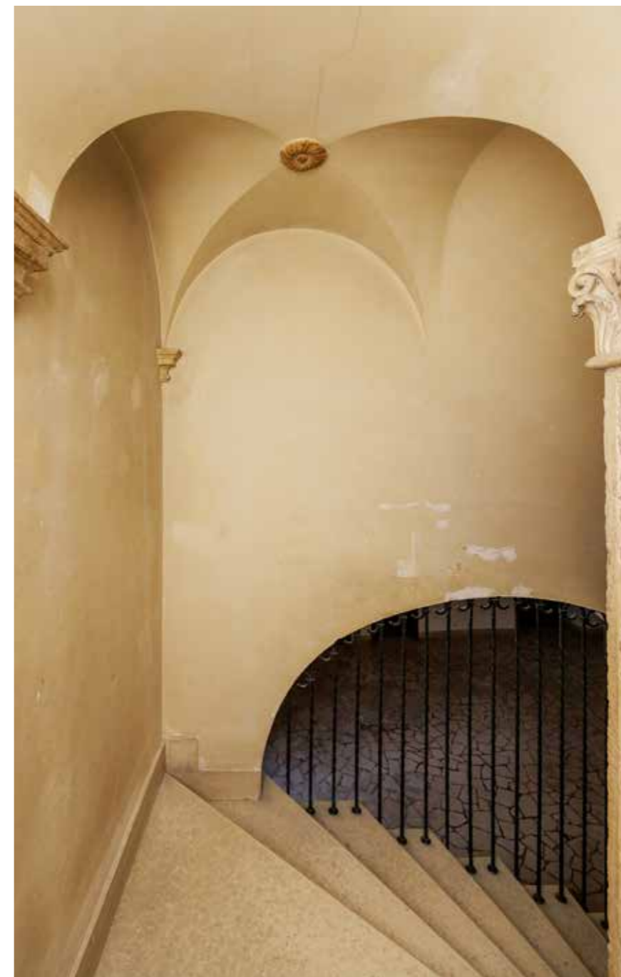
Podest između prizemlja i prvog kata
