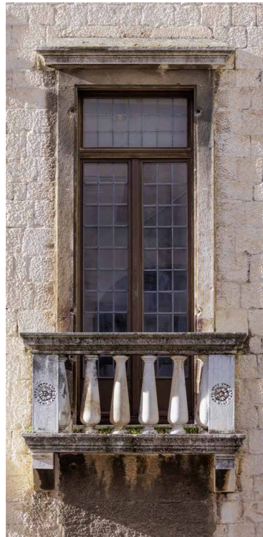
Istočno pročelje, balkon na prvom katu
