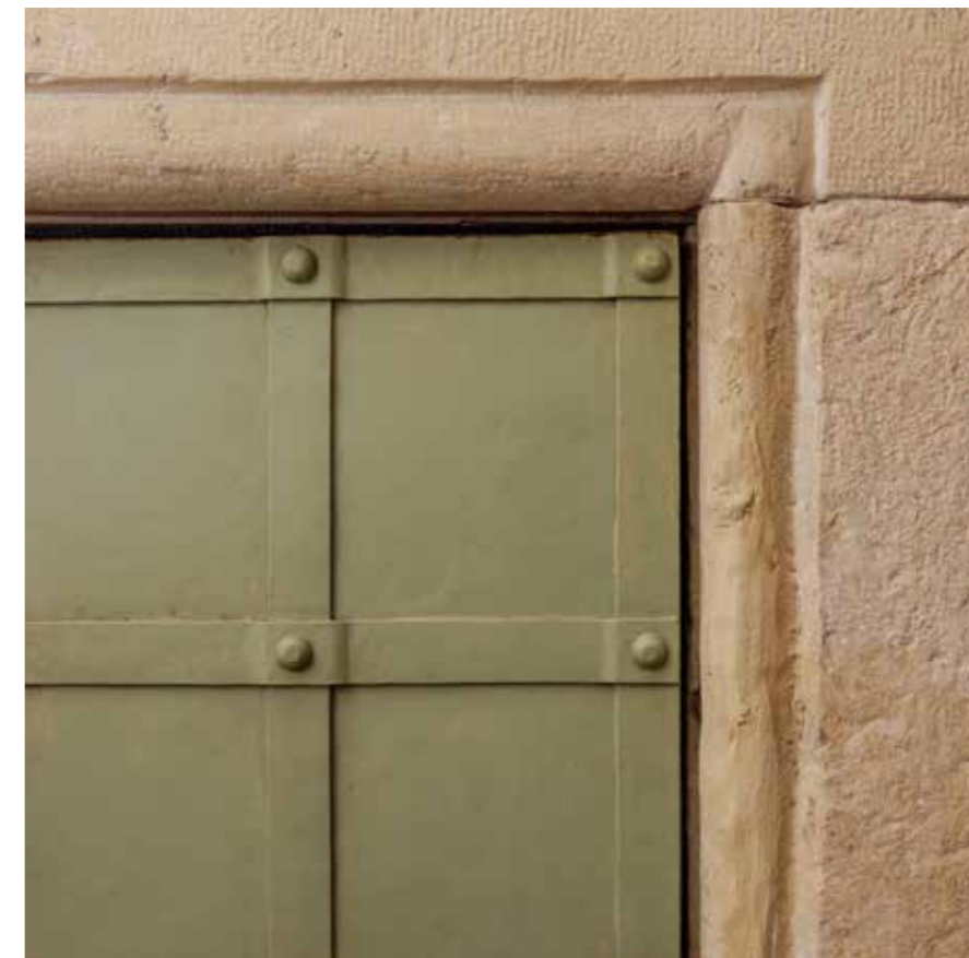
Portal spremišta ispod stuba, detalj
