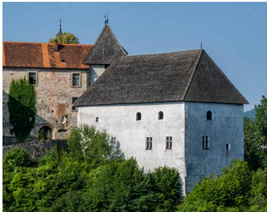
Pogled na Žitnicu sa sjeveroistoka
