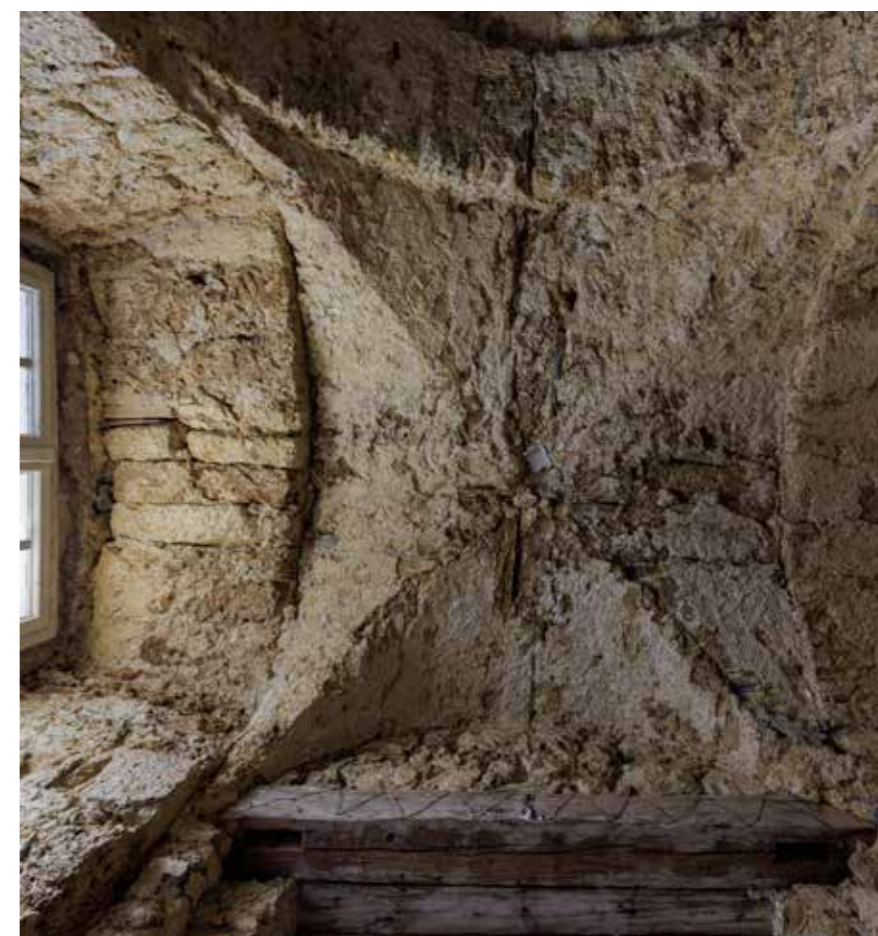
Barokno stubište u sjevernom krilu Križni svod stubišta
