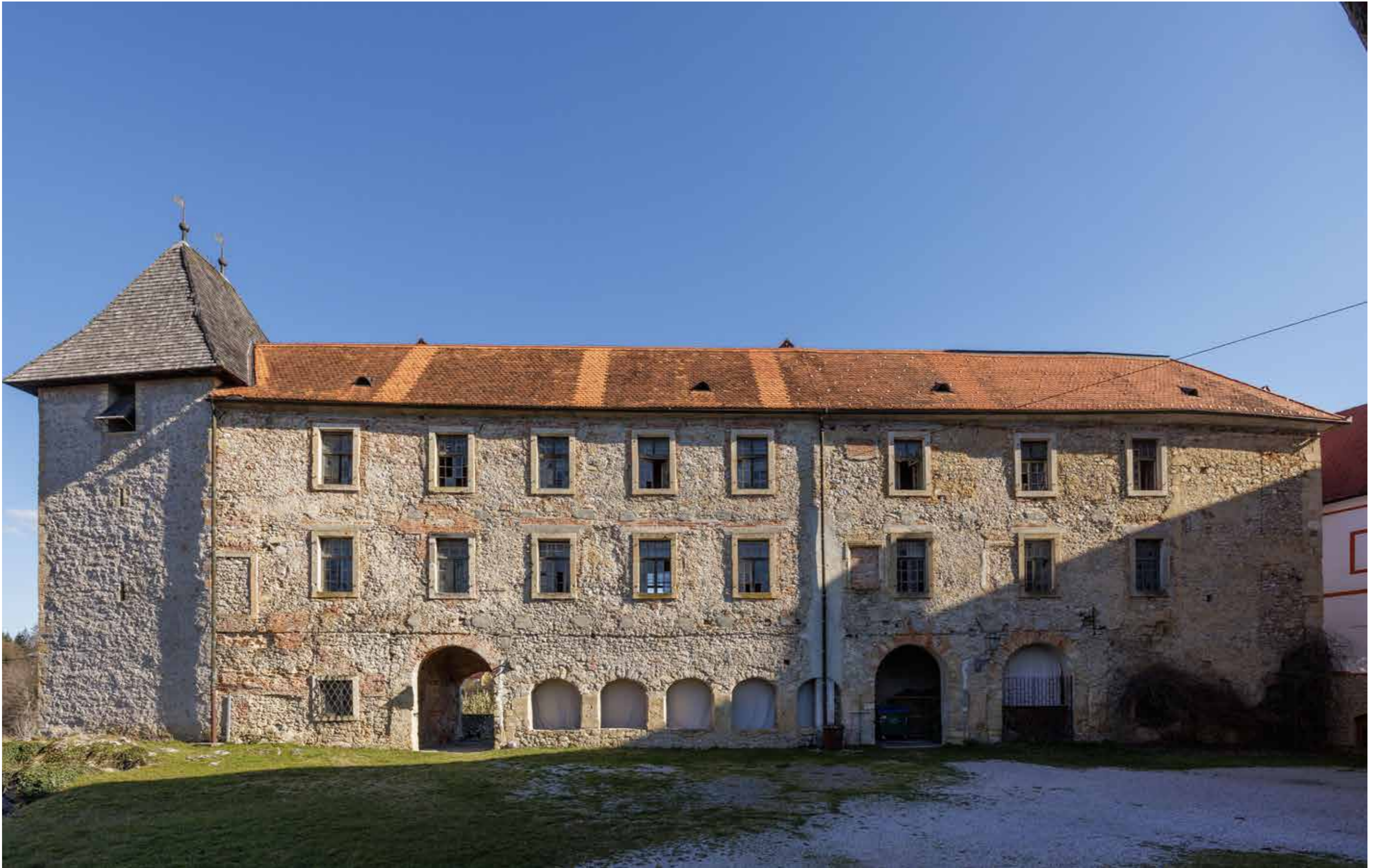
Južno pročelje sjevernog rezidencijalnog krila
