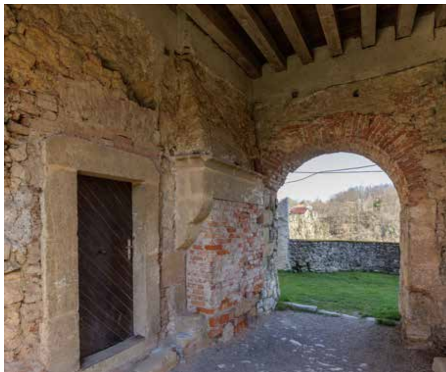
Zazidani gotički kamin u baroknom prolazu prema Žitnici Niša u istočnom zidu prolaza prema Žitnici
