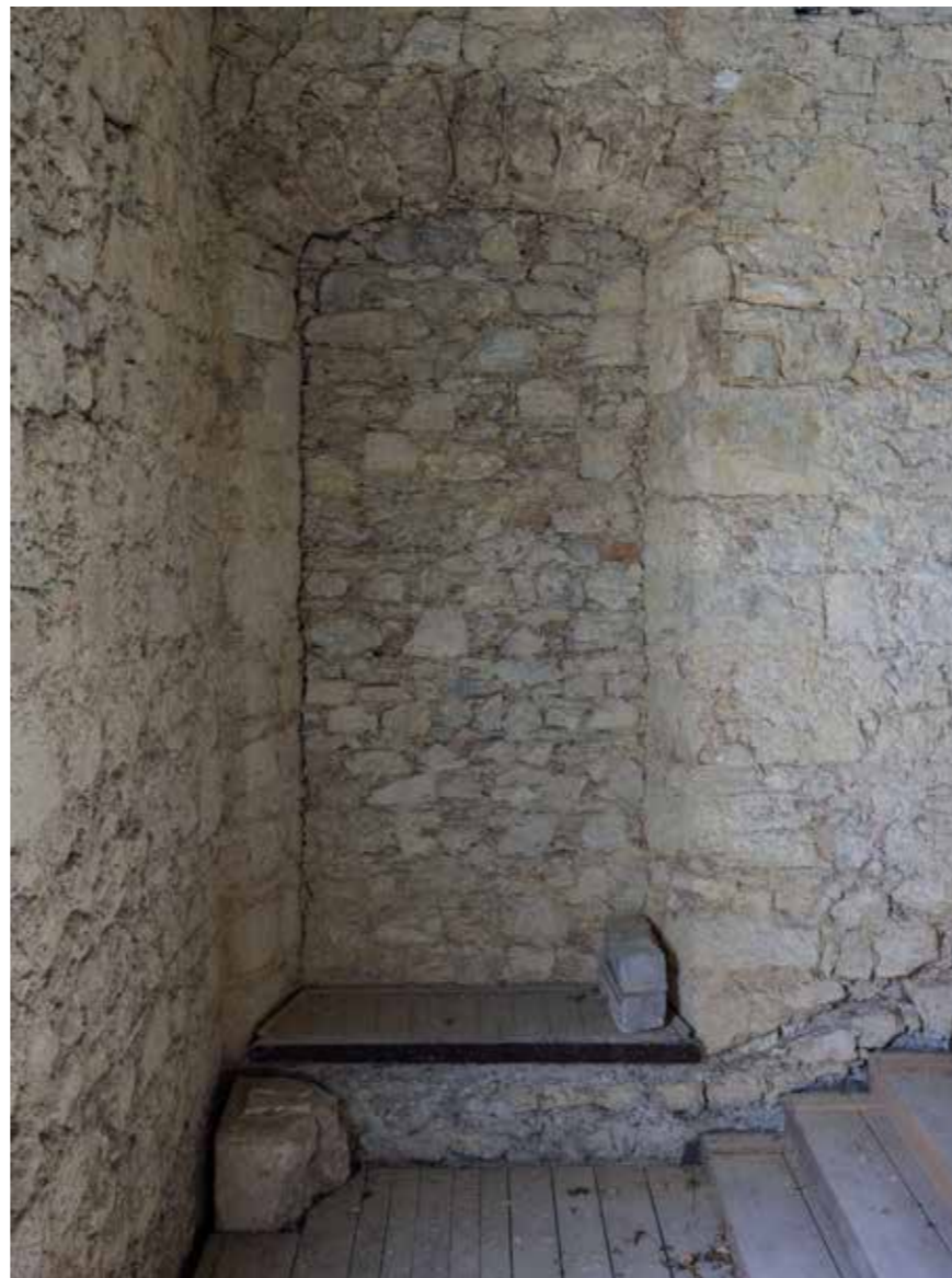
Zazidana ništa prolaza u južnom zidu stubišta
