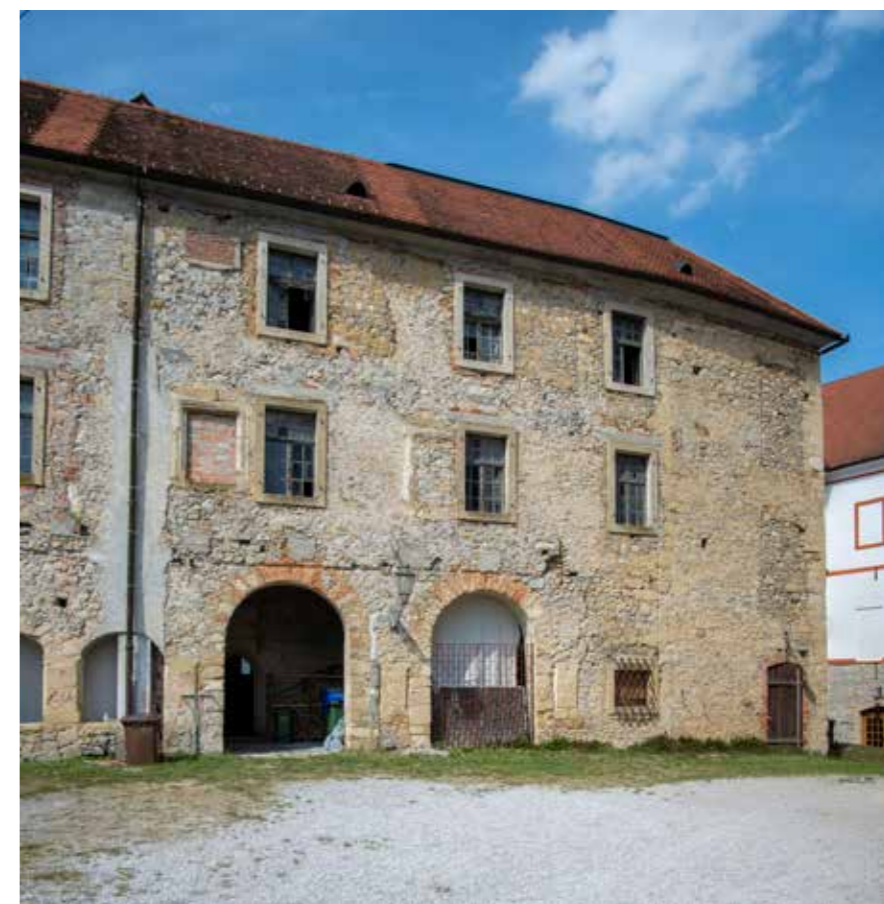
Južno pročelje sjevernog krila uz branič-kulu
