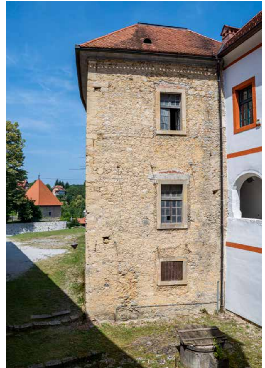
Istočno pročelje stubišta sjevernog krila
