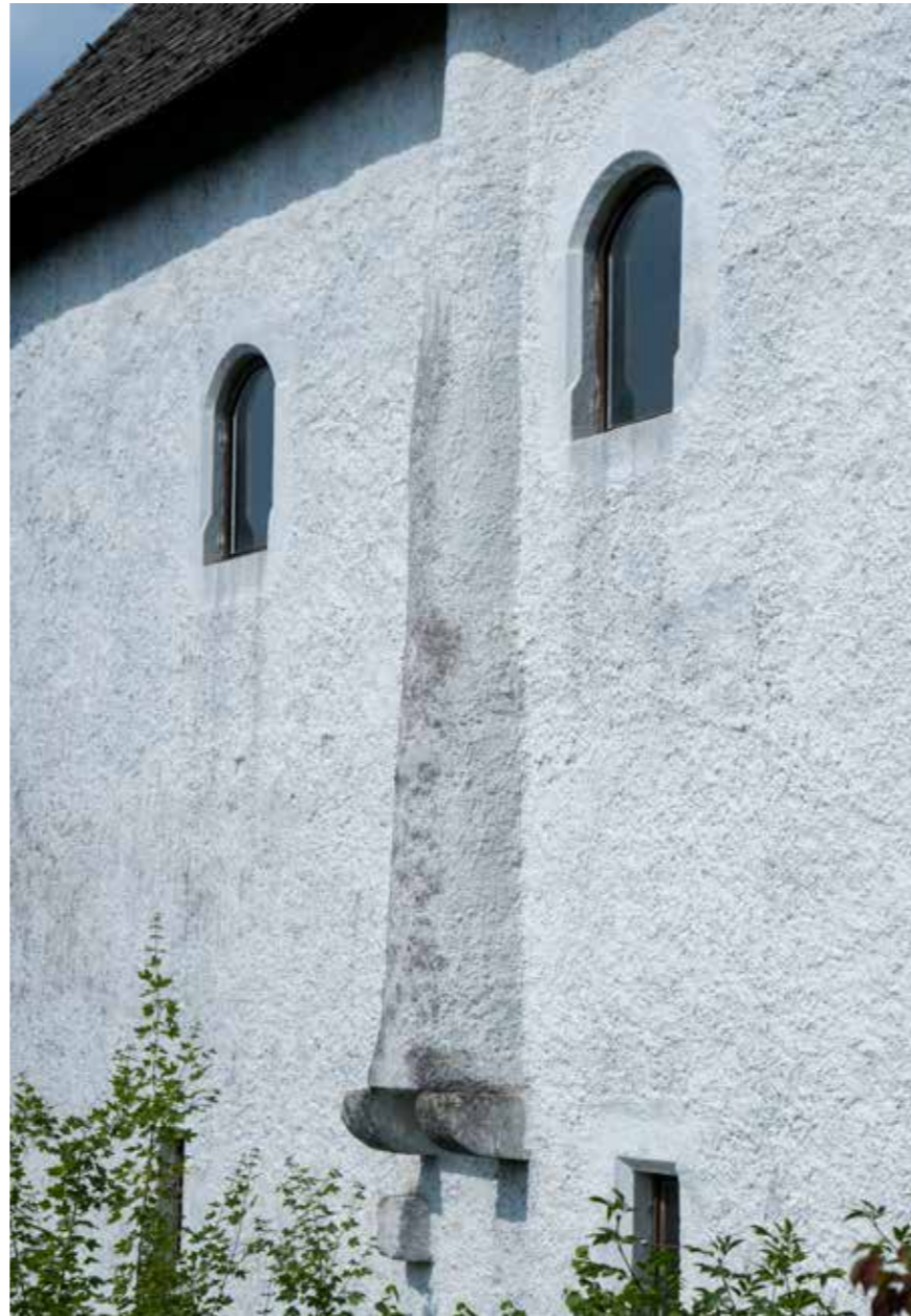
Dimnjak na zapadnom pročelju Žitnice
