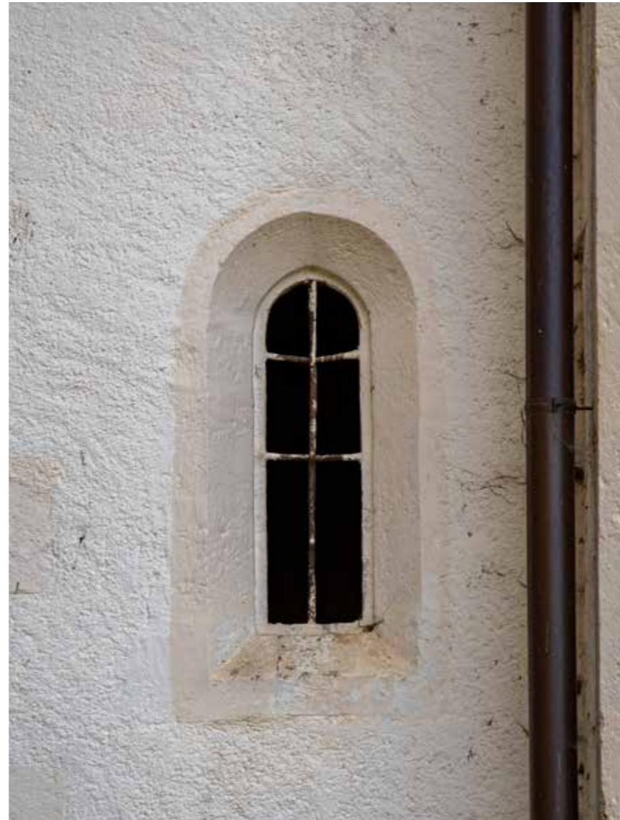
Prozor na sjevernom zidu
