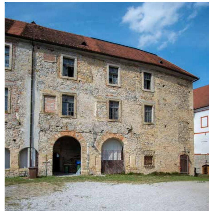
Južno pročelje sjevernog krila uz branič-kulu
