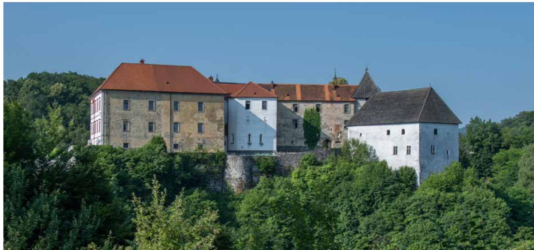
Pogled na kapelu sa sjevera
