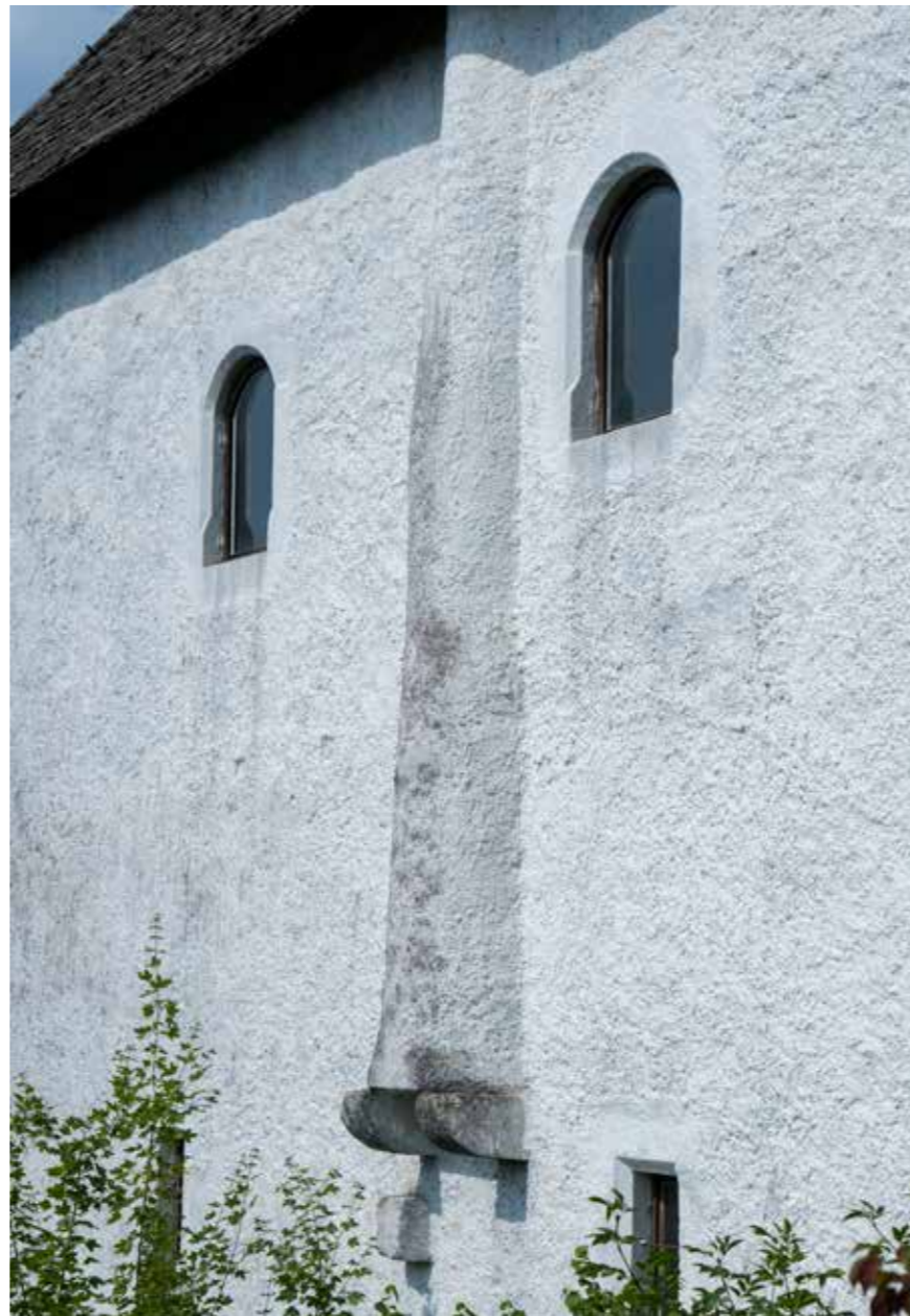
Dimnjak na zapadnom pročelju Žitnice
