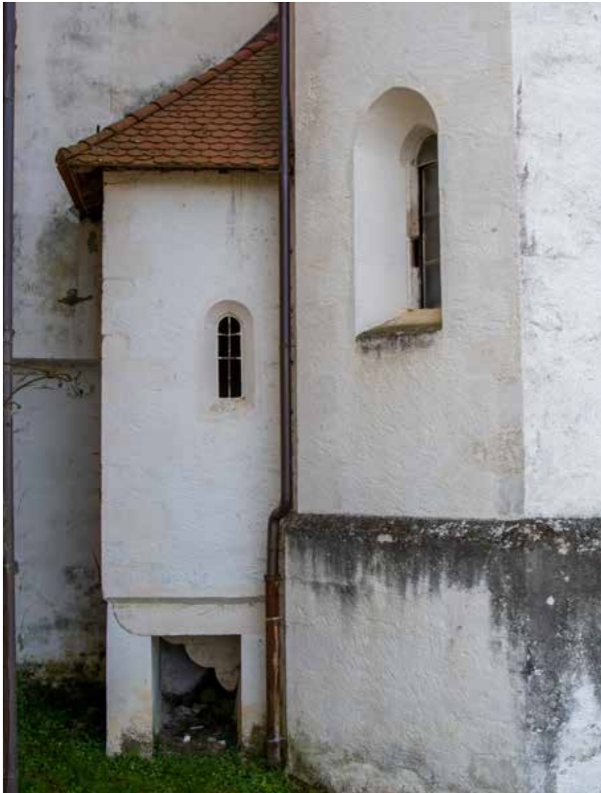
Apsida i sjeveroistočni zid kapele
