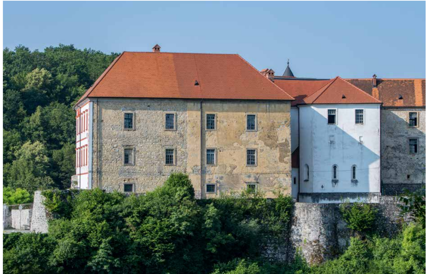
Sjeverno pročelje sjevernog krila
