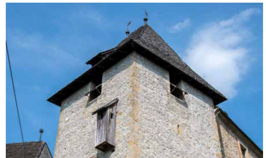
Pogled na sjeverno pročelje Dio zapadnog pročelja
