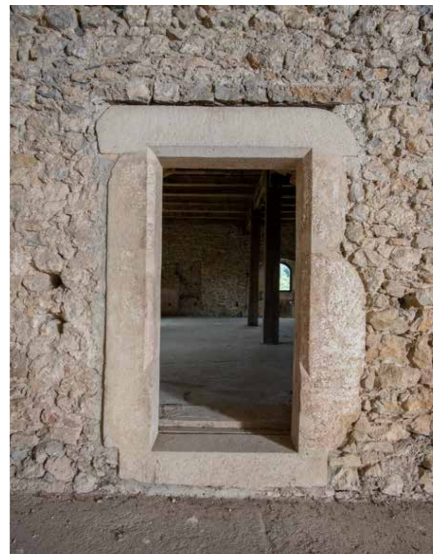
Prvi kat predvorja, pogled prema sjeveru
