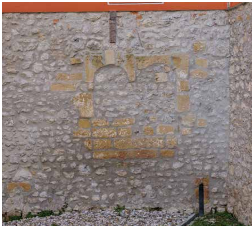
Romanička bifora i strijelnica na zapadnom pročelju istočnog krila
