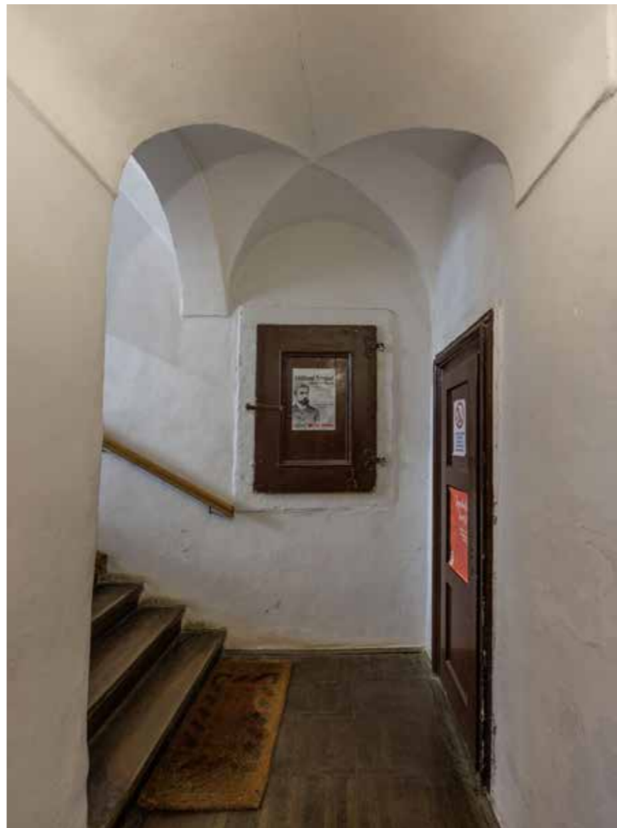
Podest baroknog stubišta između prizemlja i prvog kata
