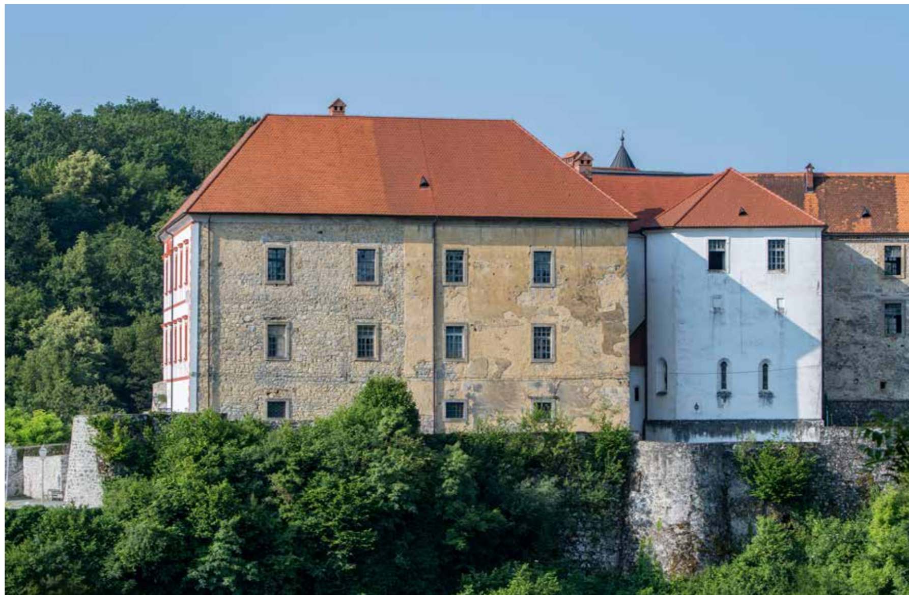
Sjeverno pročelje sjevernog krila
