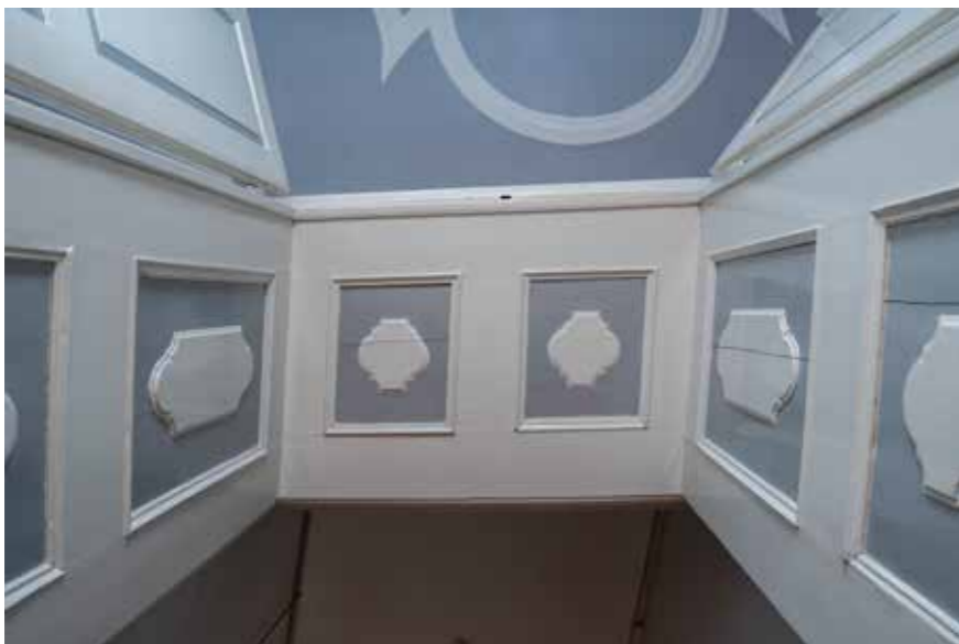
Strop prostorije na drugom katu Trške kule Drvena obloga niše vrata južnog krila
