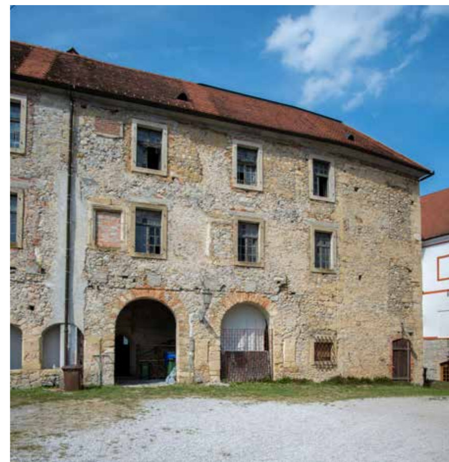
Južno pročelje sjevernog krila uz branič-kulu
