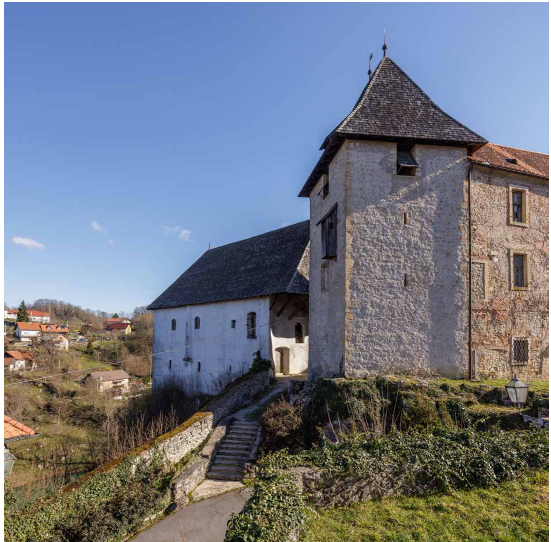
Pogled na južno i zapadno pročelje branič-kule
