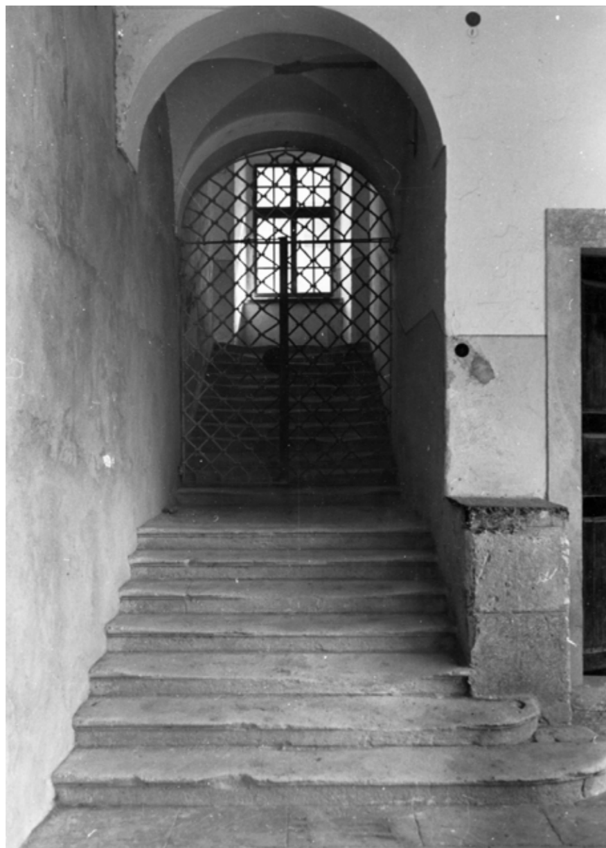
Barokno stubište sjevernog krila u prizemlju (MKM)
