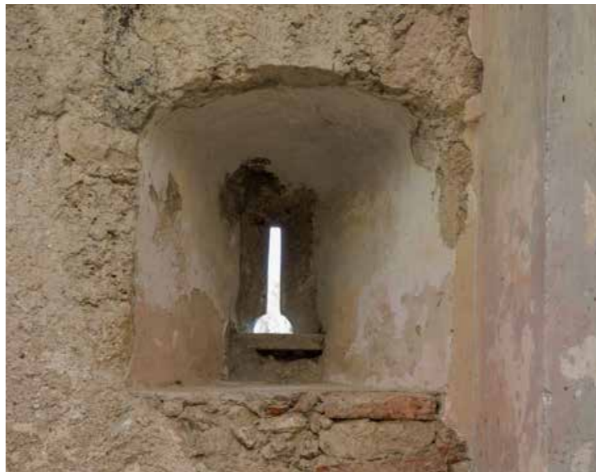
Niša puškarnice u kapeli
