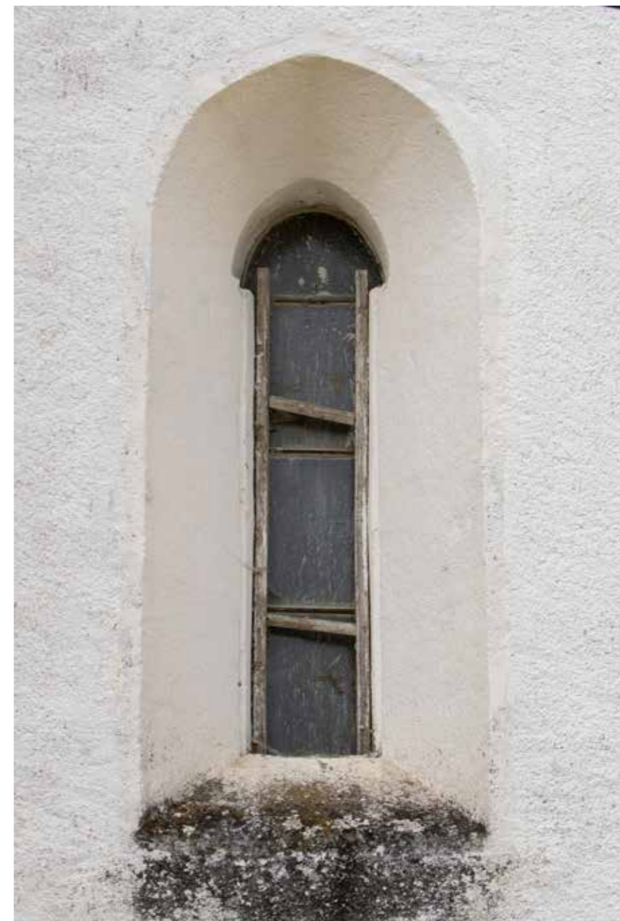
Gotički prozor na sjevernom pročelju
