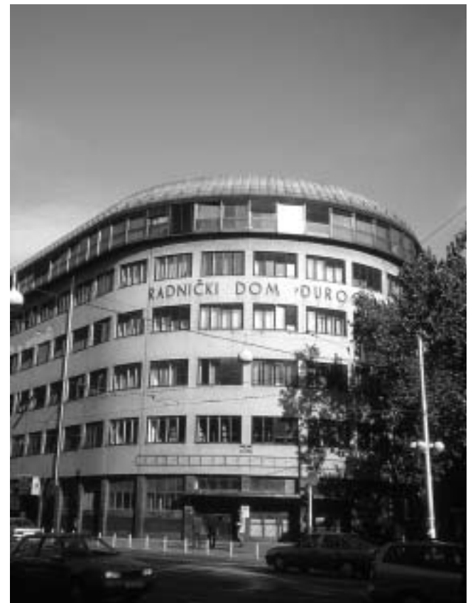
J. Korka, Đ. Krekić, Đ. Kiverov: Radnički dom (Dom sindikata) na Krešimirovu trgu u Zagrebu, 1937. Nadogradnja i novi krov, 70-ih godina.
