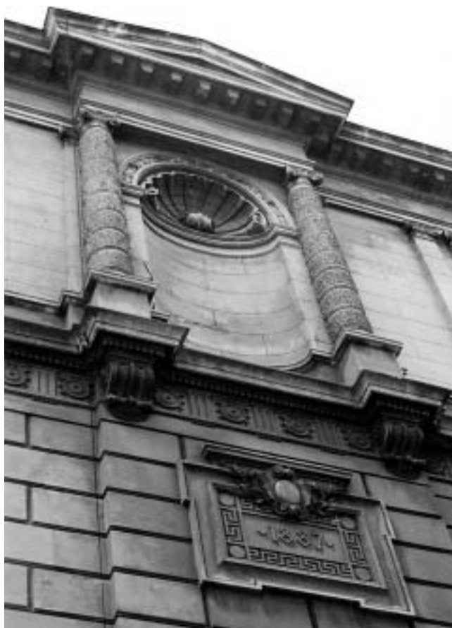
Carlo Conighi, Casa turca (sada poslovno-stambena kuća), 1906., Rijeka, Trninina 8.
