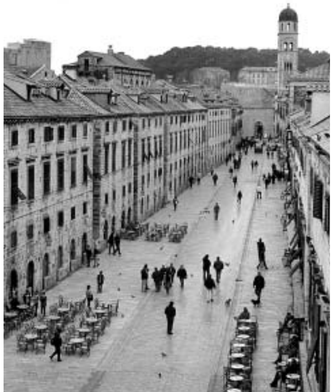
Placa, unificirana pročelja kuća, foto: Katarina Horvat-Levaj
