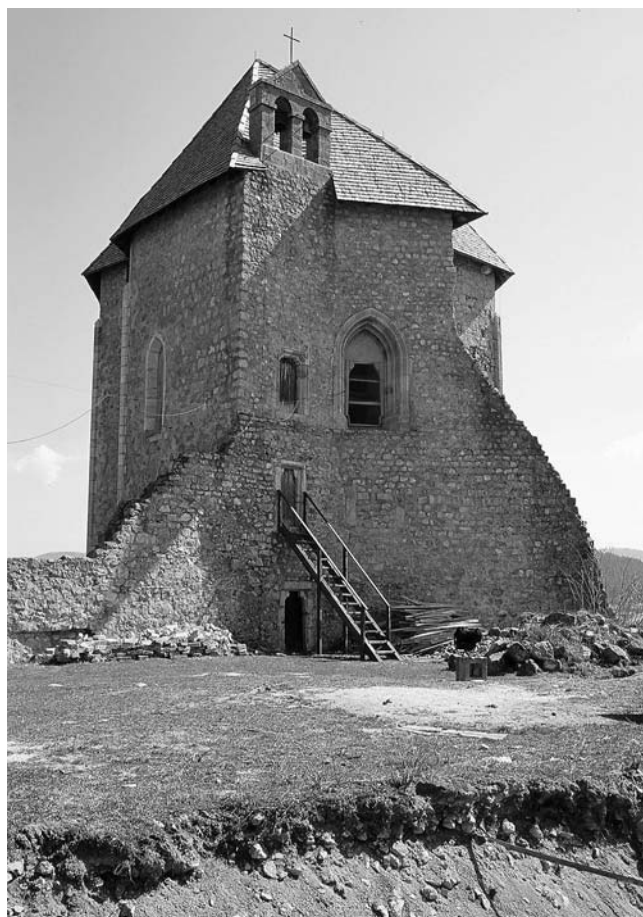
11. Brinje, Sokolac, pogled na zapadno pročelje kapele Sv. Trojstva
