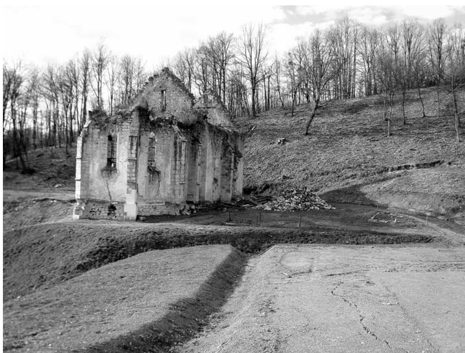
15. Zrin, kapela Sv. Marije Magdalene, pogled s istoka nakon probijanja pristupnog puta i raščišćavanja okoliša (HV)
