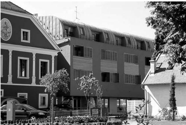
3. Zagreb, Kaptol 7, pogled na interpoliranu zgradu svećeničkog mirovnog doma
