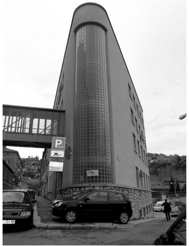
9. Državni arhiv Rijeka, Vodovodna ulica 2, Rijeka, stanje poslije adaptacije
