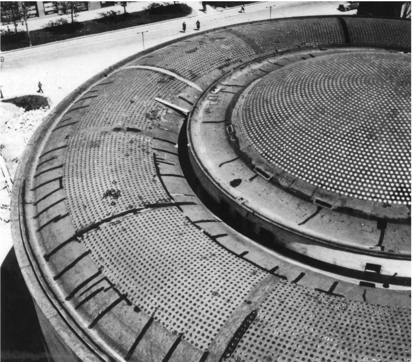
4. Plitka kupola središnje dvorane i svod prstenaste dvorane od armiranog betona i stakla. (Muzej grada Zagreba)
