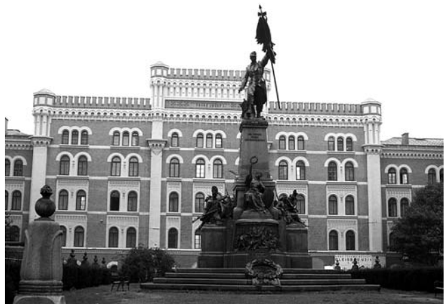
15. Obnovljena vojarna u Rossauu, Beč, 2005. Poslije 1918. vojarna je služila različitim svrhama i postupno propadala, a sedamdesetih godina proteklog stoljeća prijetilo joj je rušenje, no prevladalo je mišljenje da se zaštititi kao spomenik kulture. Devedesetih godina započela je sanacija i restauracija kompleksa, koji je napokon namijenjen uredima Ministarstva obrane i policije. Obnova je okončana 2005. godine.
