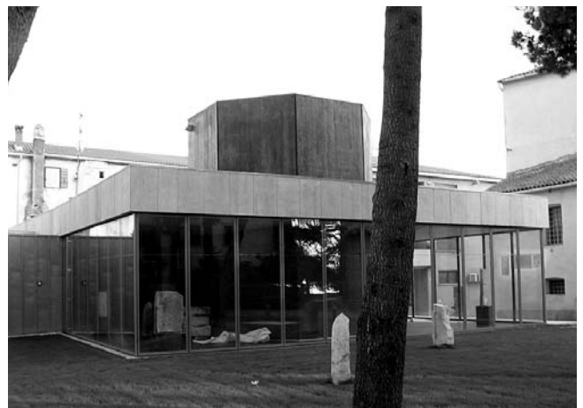
Zgrada muzeja sa strane parka, rujan 2006. (foto: J. Ziherl)
