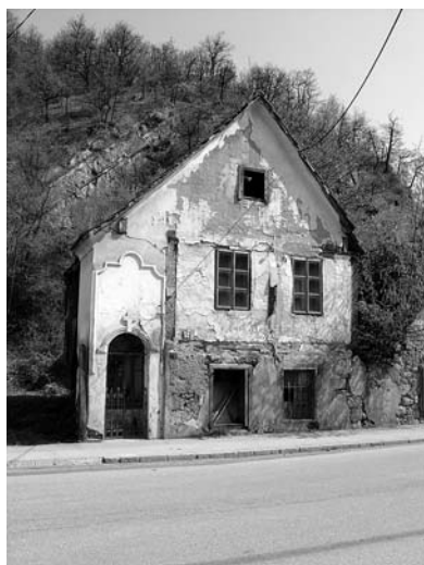
Samobor, propadanje starog građevnog fonda neposredno pod starim gradom
