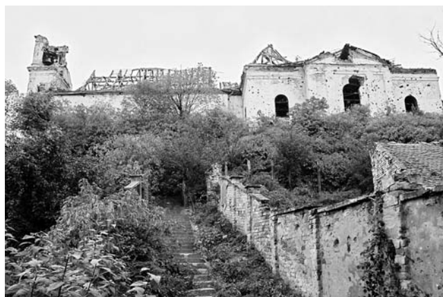
2. Vukovar, franjevačka crkva Sv. Filipa i Jakoba: razoreno stanje prije obnove (foto: Đ. Šimičić, HRZ, 1997.)
