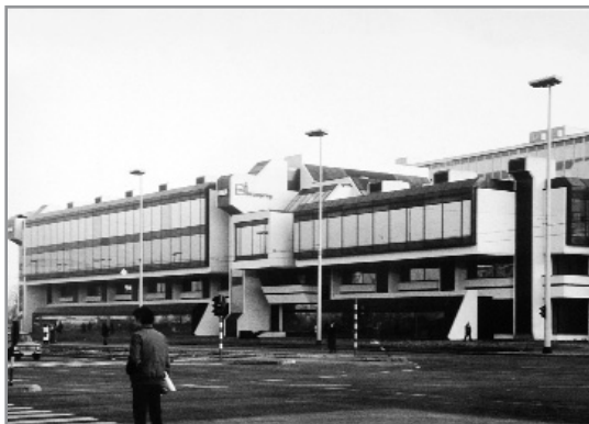
Vukovarska 78, poslovna zgrada INA (Duško Rakić, 1978.-1983.), sjeverno pročelje
