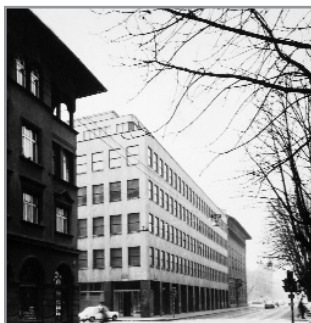
Gundulićeva 32-Hebrangova, Upravna zgrada gradskih komuna- lnih poduzeća (danas Elektra), (Juraž Denzler, 1935.)
