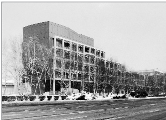
Avenija Dubrovnik, poslovna zgrada carina i Intereurope na Zagrebačkom velesajmu (Đivo Dražić, Edvin Šmit, 1990.-1991.), južno pročelje
