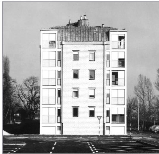
Borongaj, stambena zgrada Aero (Tomislav Odak, 1987.- 1990.) bočno pročelje
