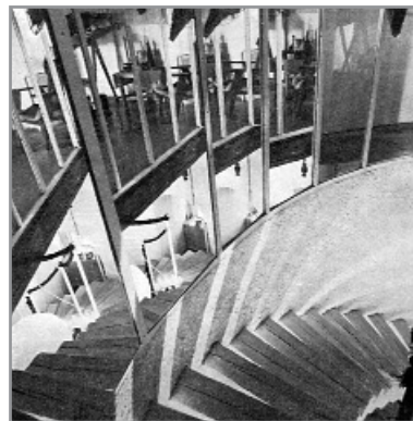
Stubište, pogled odozgo
