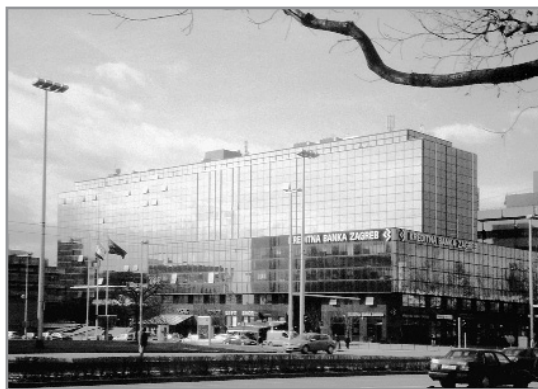
Miramarska 24, Hotel Internacional, obnovljeno pročelje (Mladen Turkulin, 2005.-2006.)
