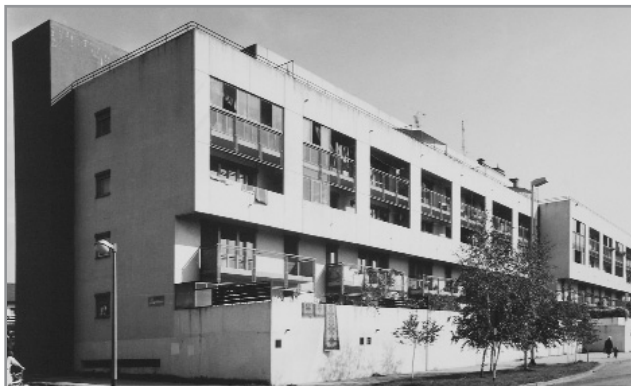
Grižanska ulica, stambena zgrada u naselju Klaka (Branko Kincl, 1978.-1981.), zapadno pročelje
