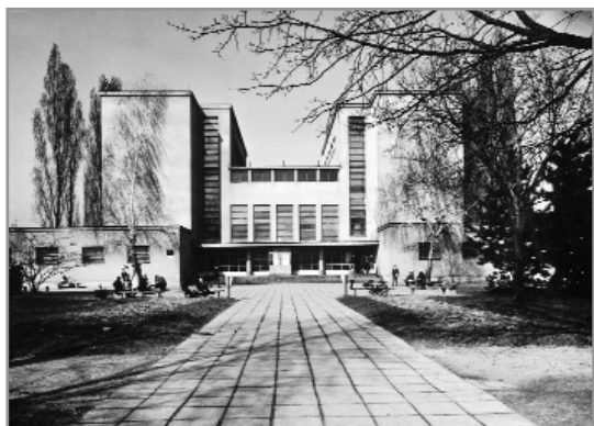
Škola na Jordanovcu (1930.), pročelje
