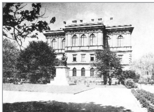
Zrinski trg 10, HAZU, južno pročelje (Friedrich von Schmidt, 1877.-1879.)
