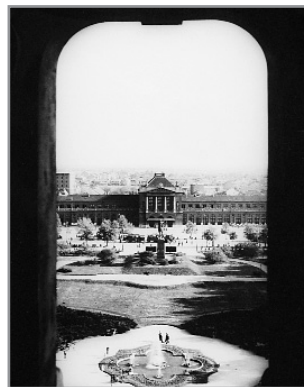
Glavni kolodvor, pogled sa zgrade Umjetničkog paviljona
