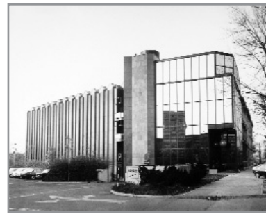
Kršnjavoga 7, Elektra Zagreb (Milan Šosterić, 1975.-1981.), istočno pročelje
