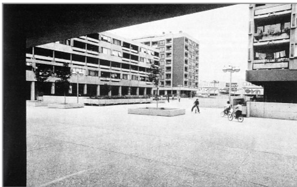
Trg između objekata ST-1 i ST-8, pogled prema sjeveru
