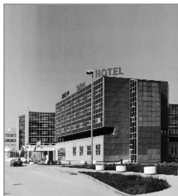
Ljubljanska avenija, Hotel "Holiday Inn" (danas druga namjena), (Višnja Ožanić, 1986.-1987.), dio južnog pročelja
