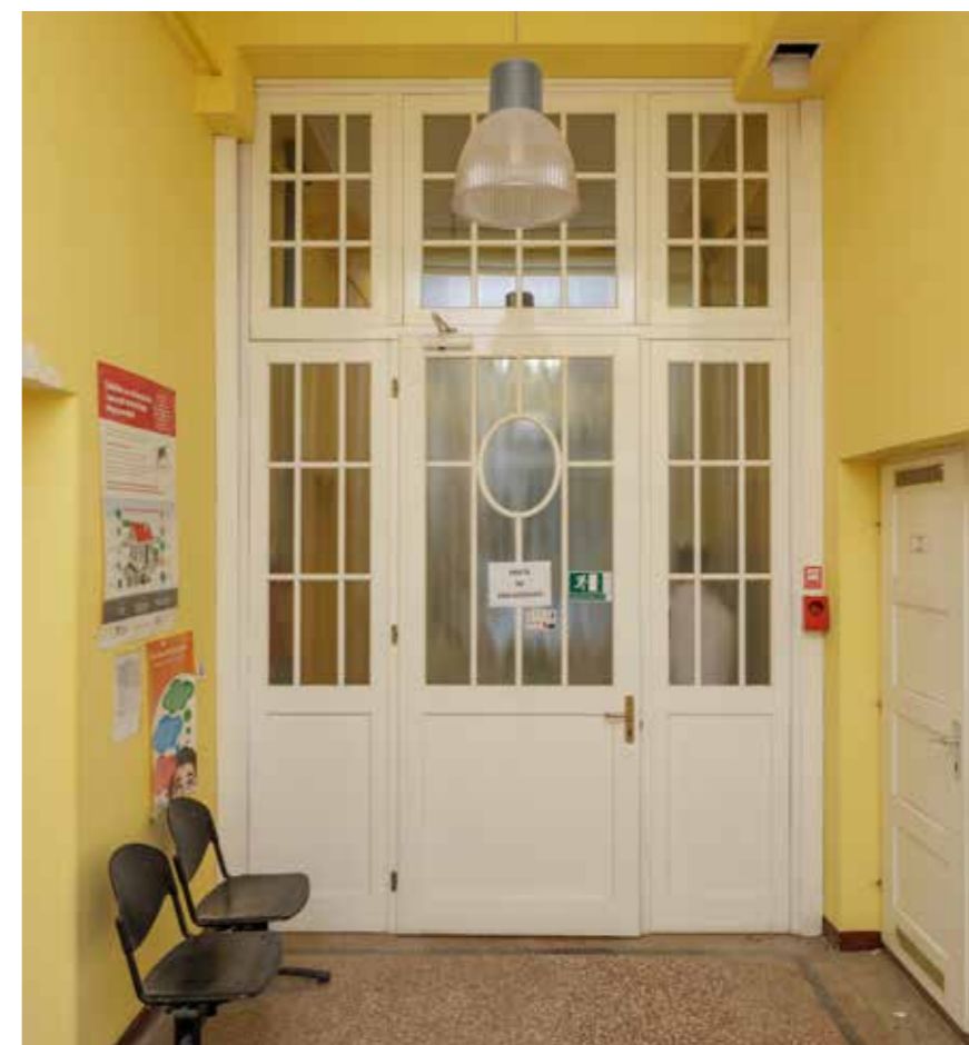
Pogled prema prostoru međukata stubišta prvog i drugog kata
