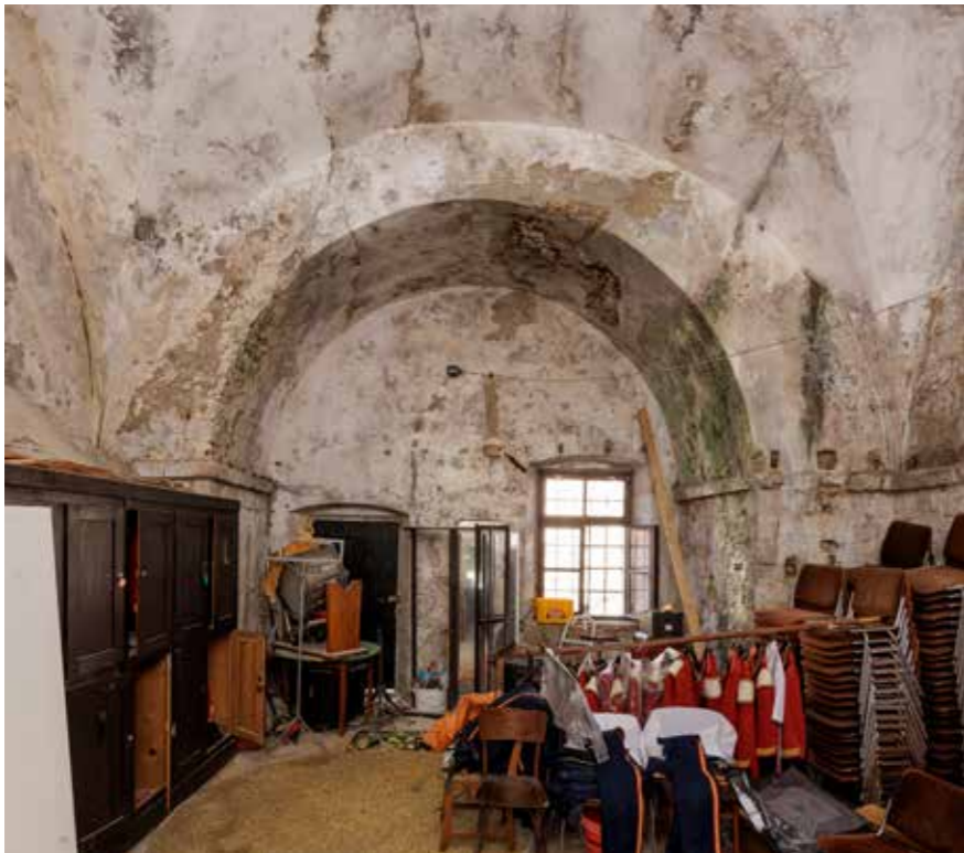
Bastion Sv. Spasitelja, prostorija nastala pregradnjom topovske dvorane
