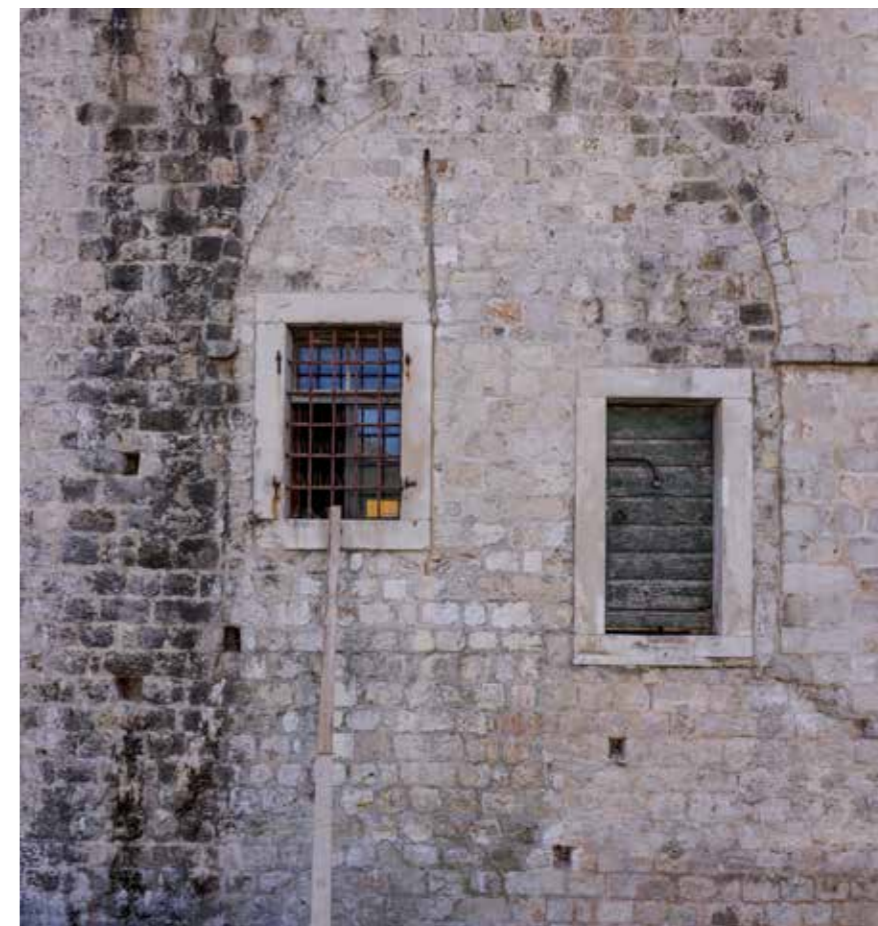
Zazidani lučni otvor na sjevernom pročelju
