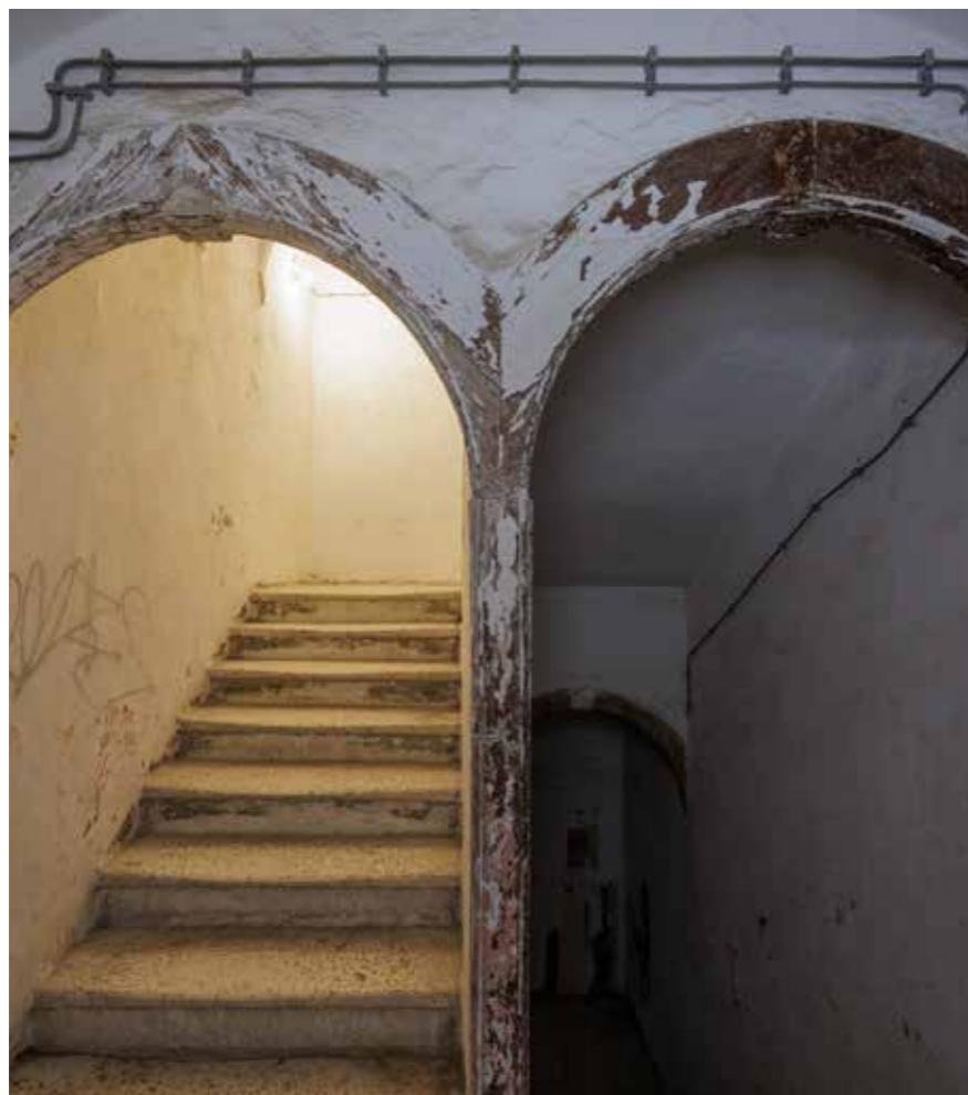
Detalji drvenih lukova u stubištu
