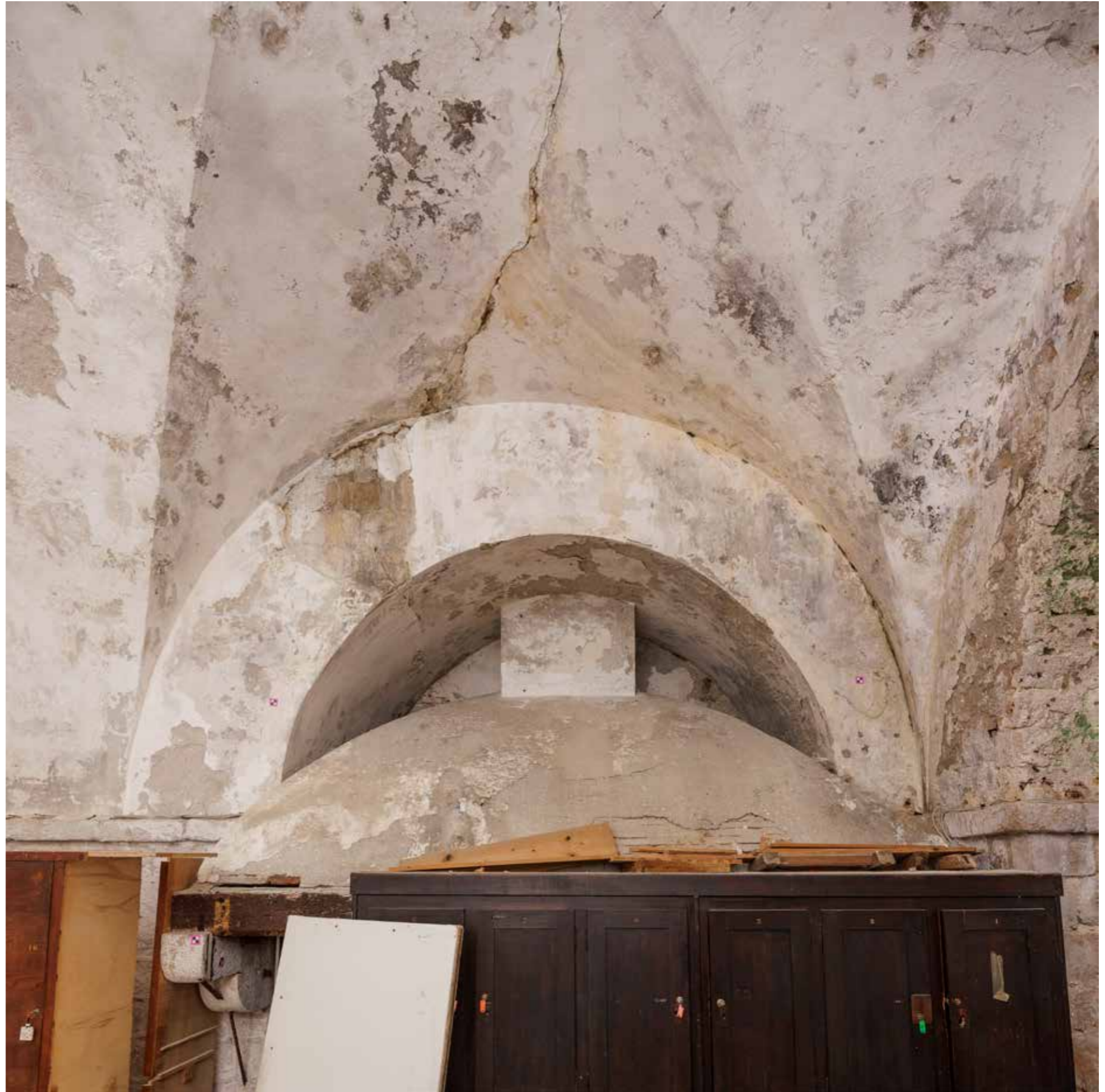
Detalj nape kamina
