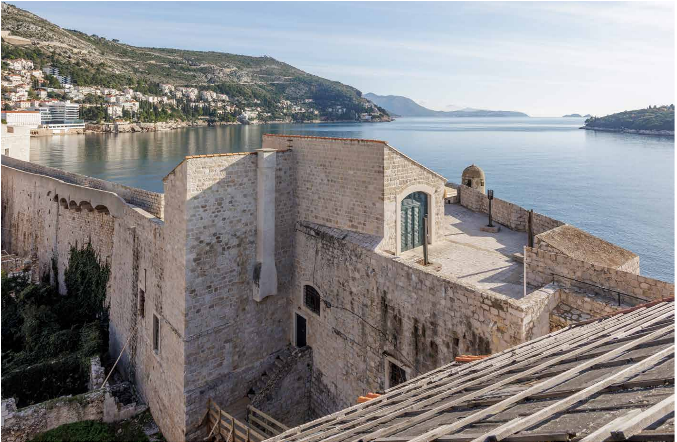
Pogled na bastion Sv. Spasitelja s dogradnjom iz 19. stoljeća
