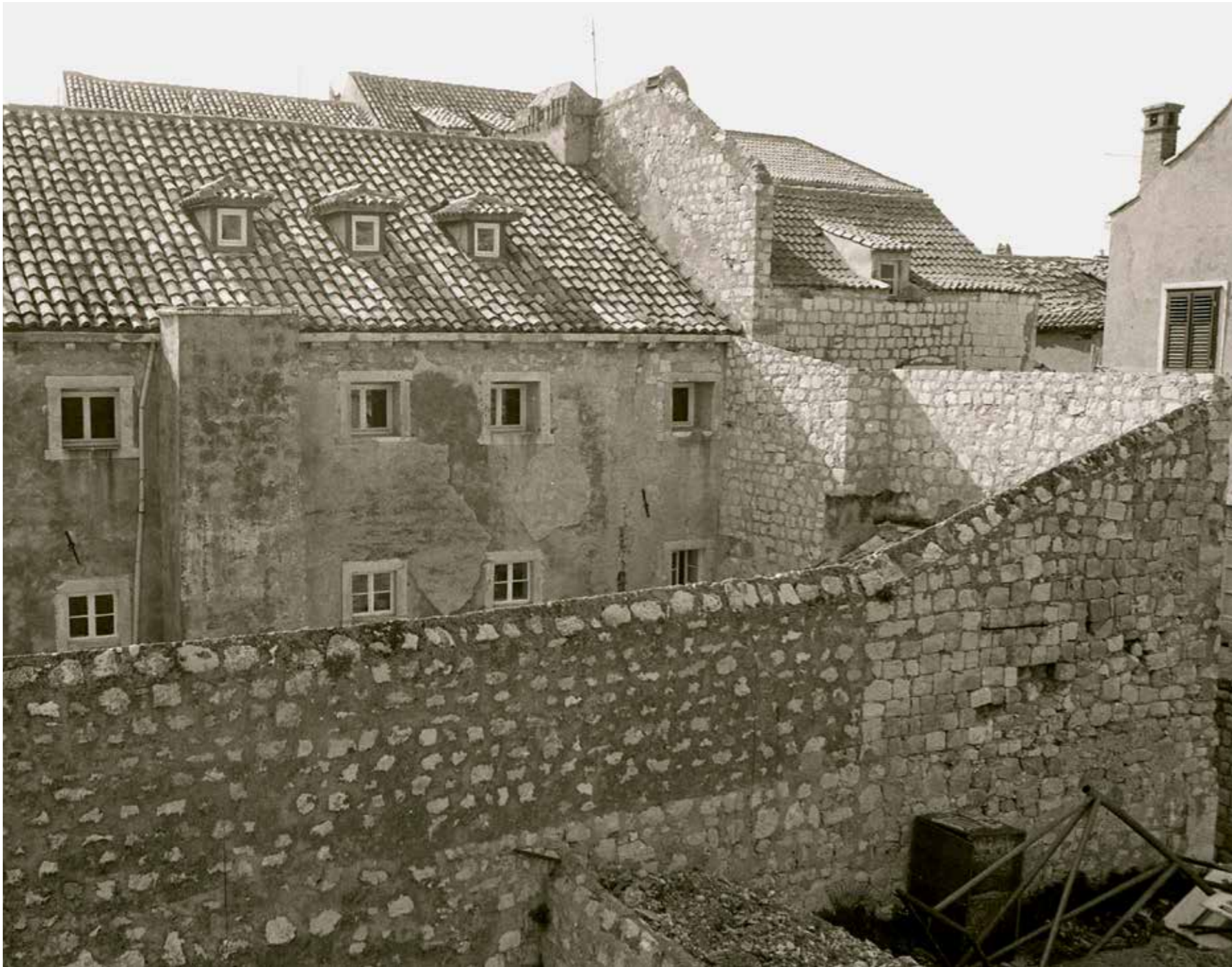
Zgrada zatvora neposredno nakon zatvaranja, 1984., fototeka Instituta za povijest umjetnosti, foto: Krešimir Tadić
