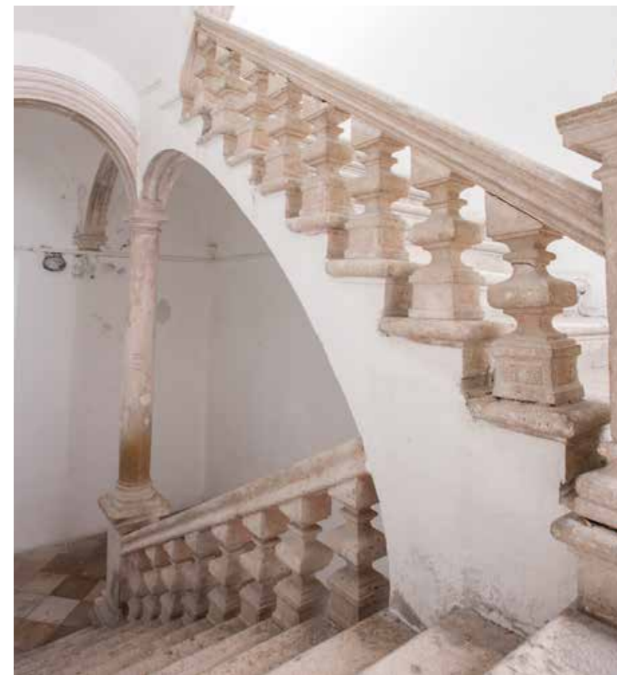
Palača u Ulici od Pustijerne 4, barokno stubište
