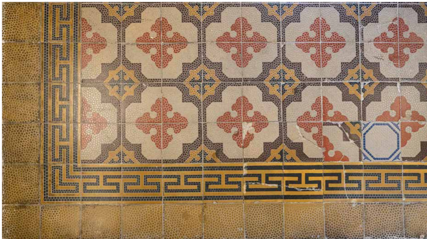
Pločice na stubišnom međupodestu između prvog i drugog kata
