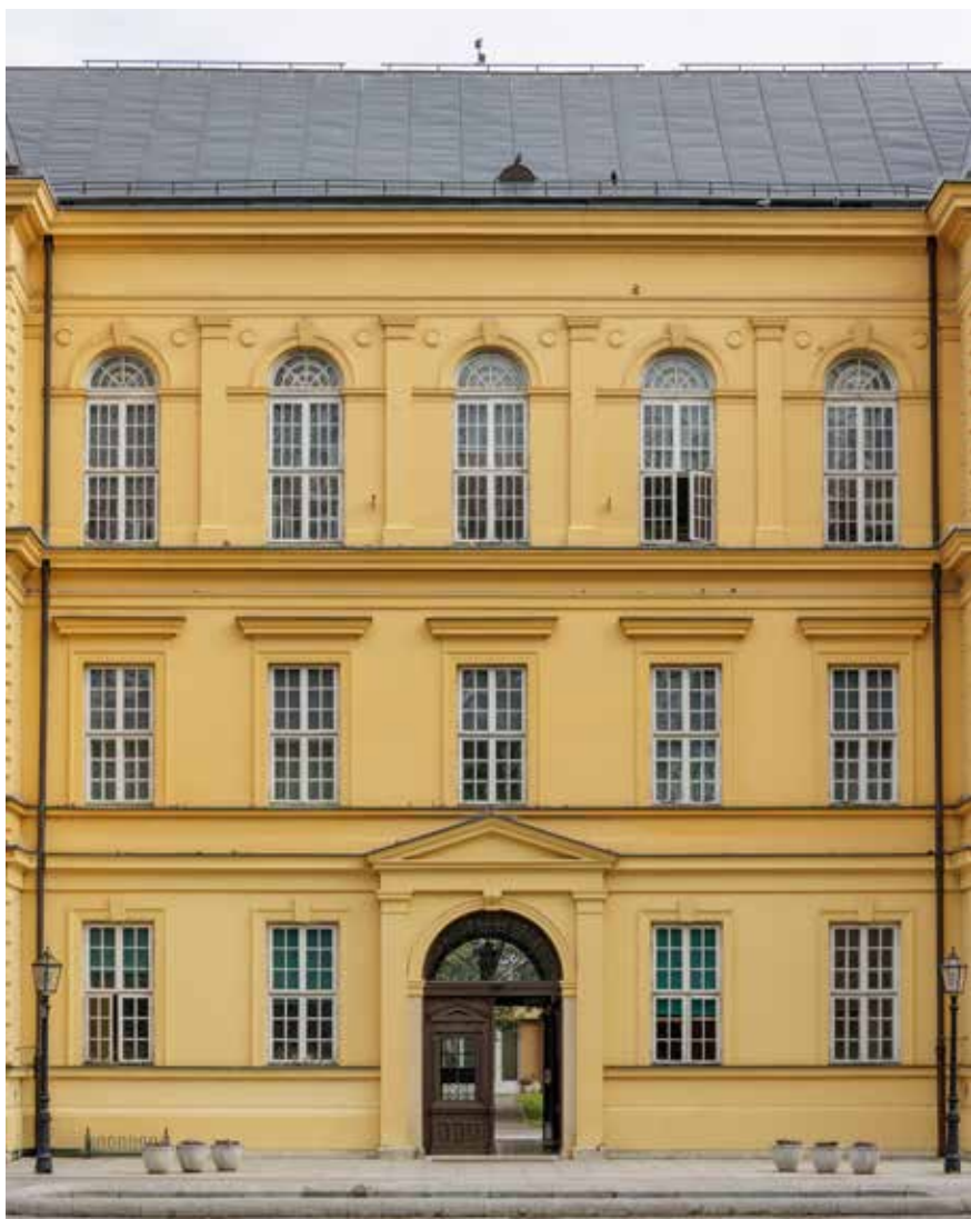
Središnji dio južnog pročelja
