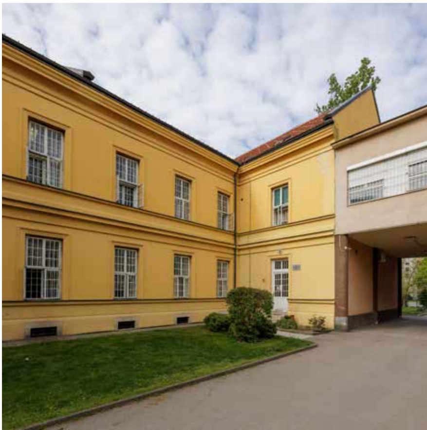
Spoj zapadnog krila i dogradnje
