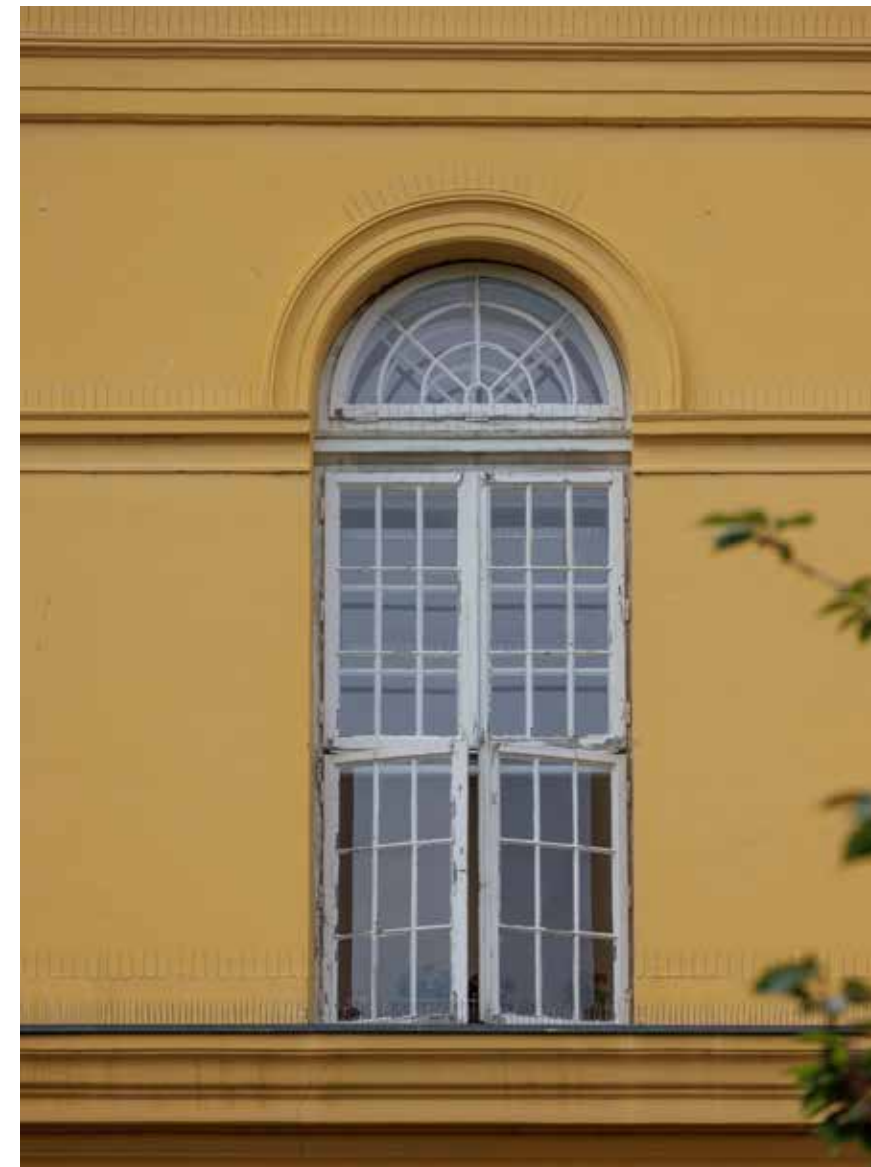
Prozor nekadašnje svečane dvorane na sjevernom pročelju
