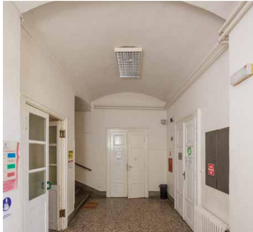
Hodnik ispred stubišta u bočnom istočnom krilu
