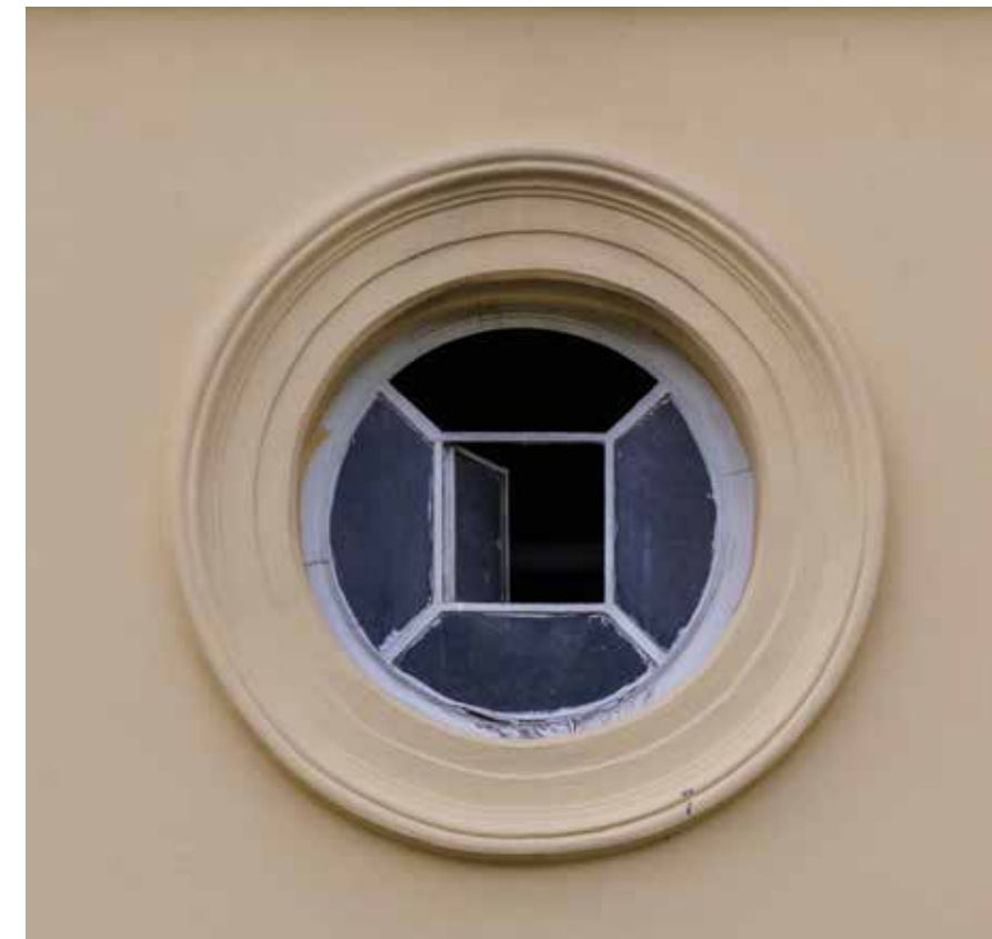
Okrugli prozor na sjevernom pročelju
