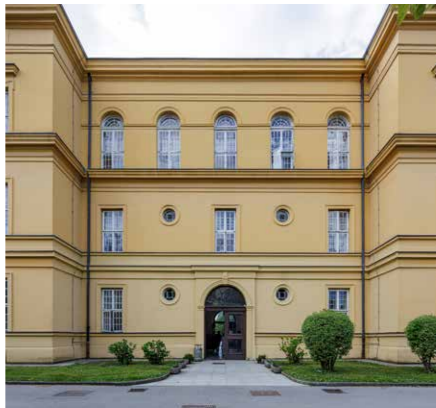
Sjeverno pročelje, središnji dio
