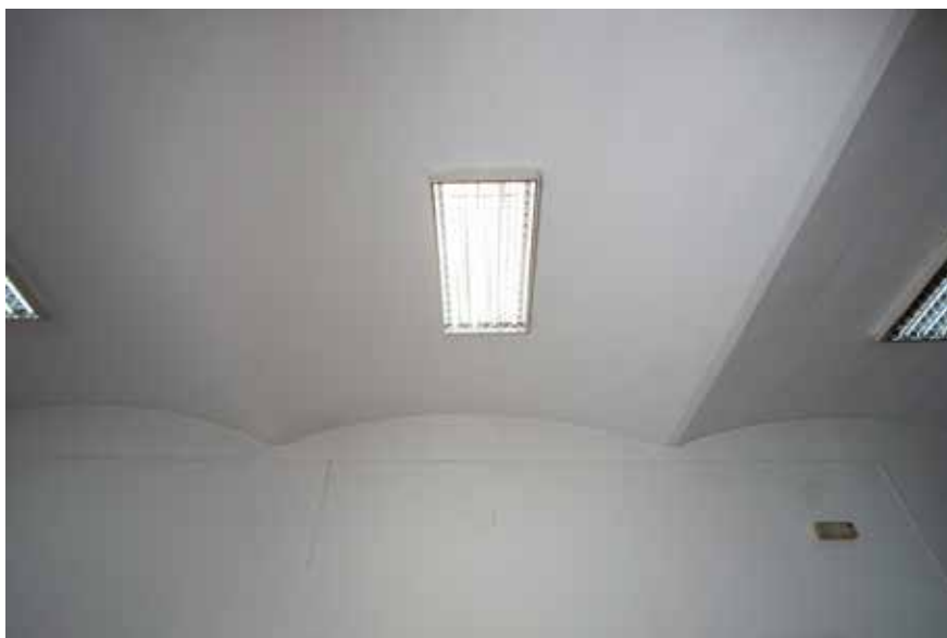
Svodovi u hodniku istočnog krila
