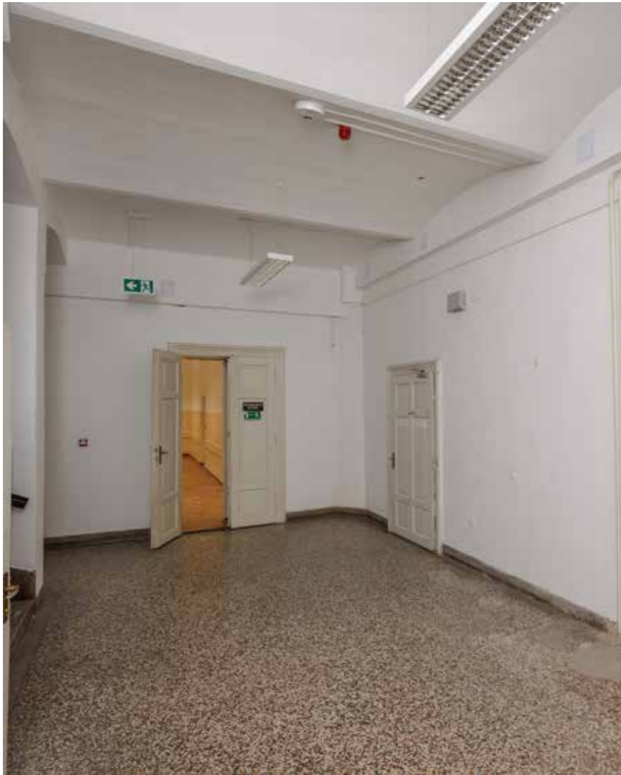
Pretprostor istočnog stubišta
