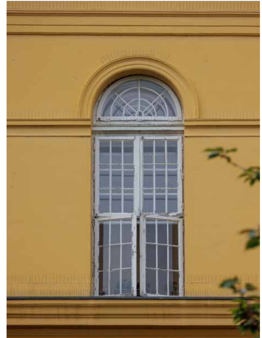
Prozor nekadašnje svečane dvorane na sjevernom pročelju
