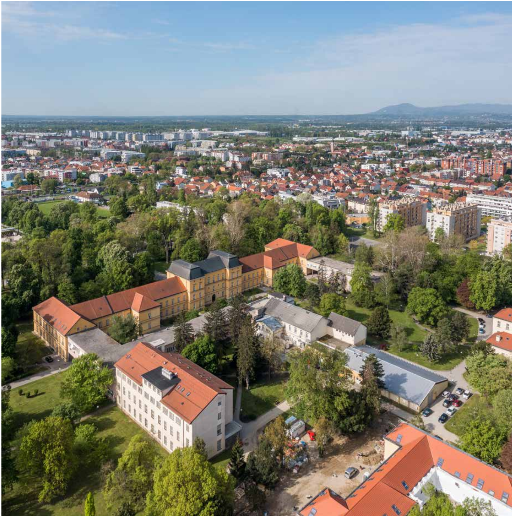
Pogled na bolnički kompleks s predimenzioniranom naknadno dograđenom zgradom u prednjem planu
