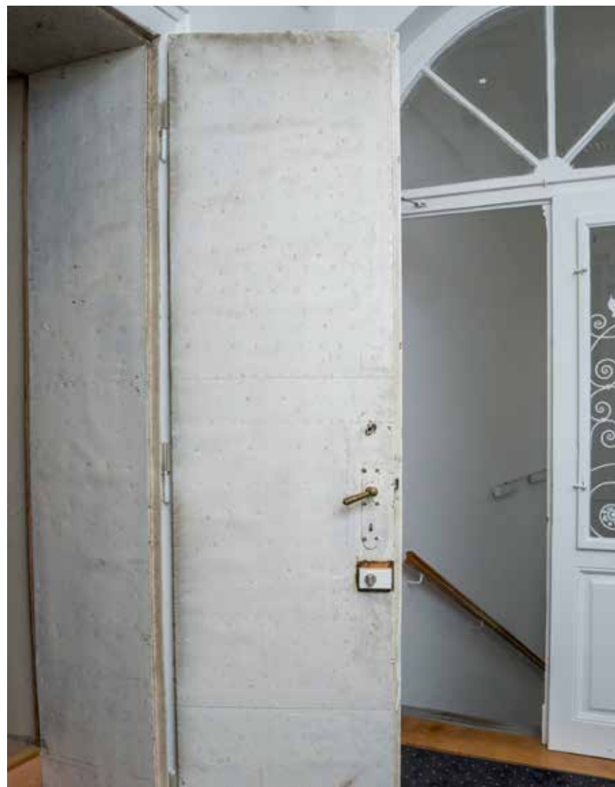
Vatrobrana vrata pema potkrovlju
