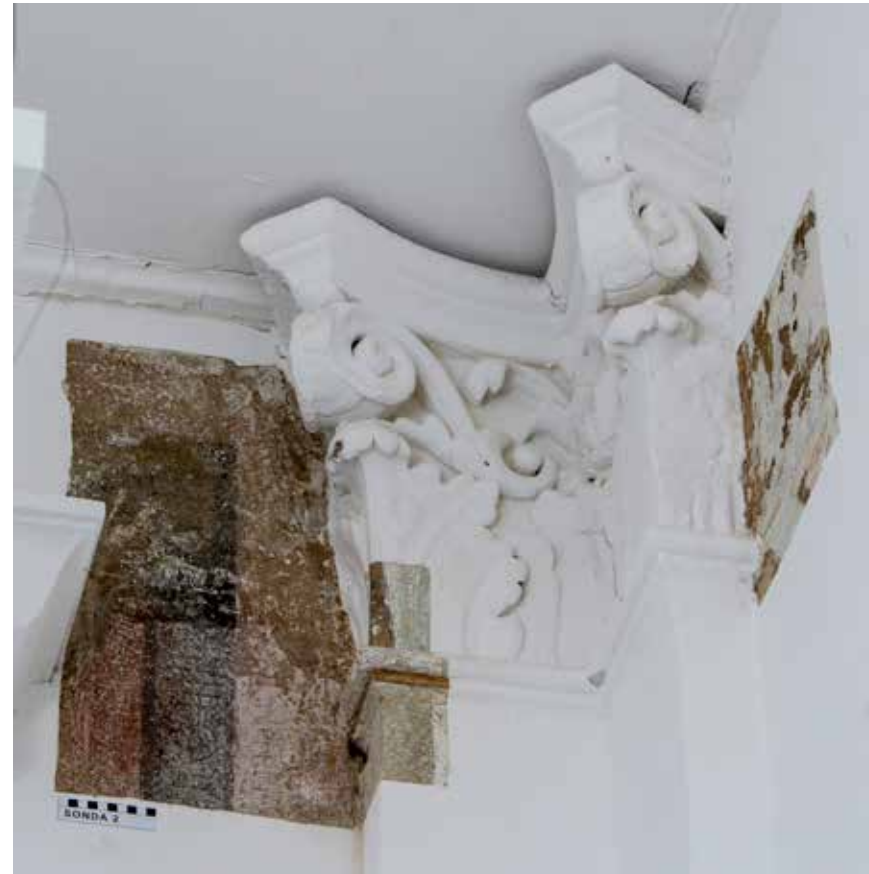
Oslici u svečanoj dvorani otkriveni restauratorskim sondiranjem
