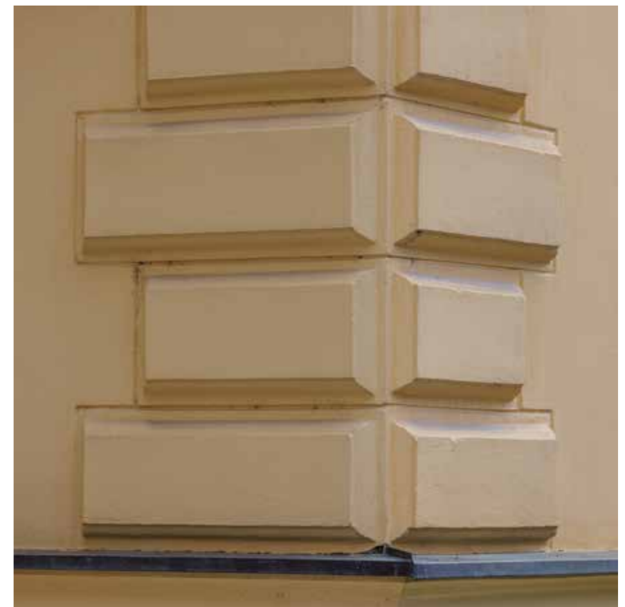
Obrada ugla na središnjem dijelu zgrade na jugu
