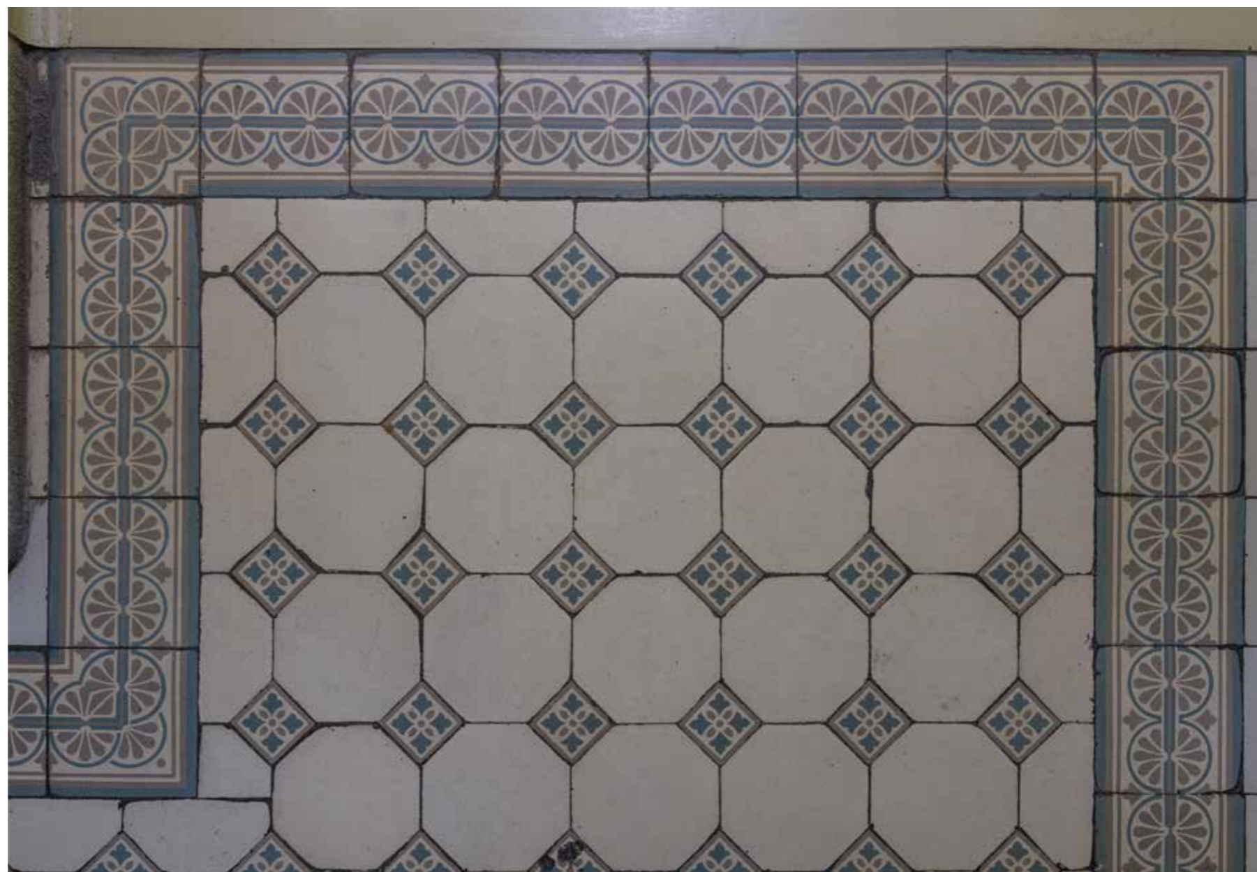
Popločenje podesta u stubištu
