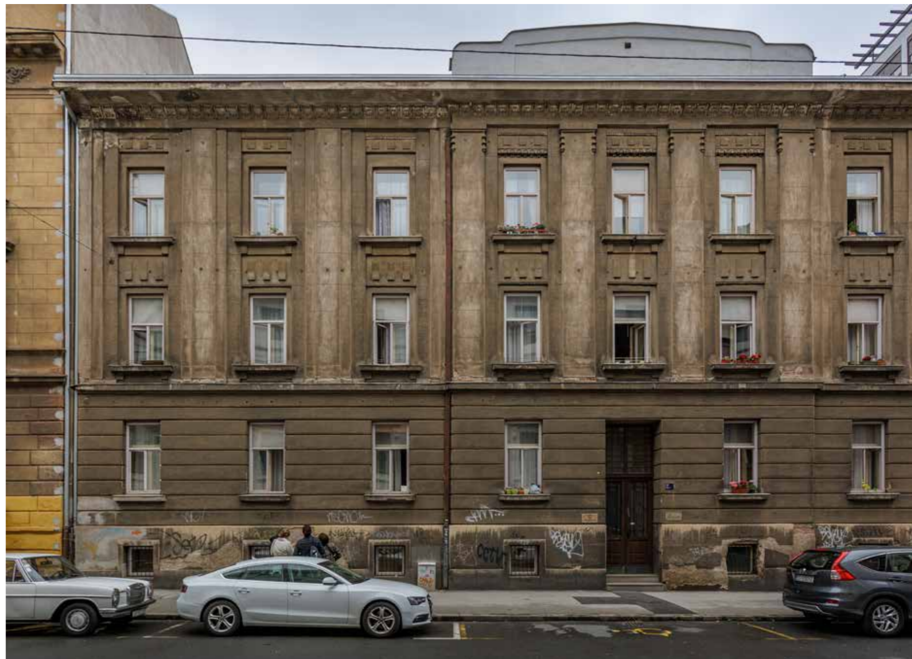
Južno ulično pročelje
