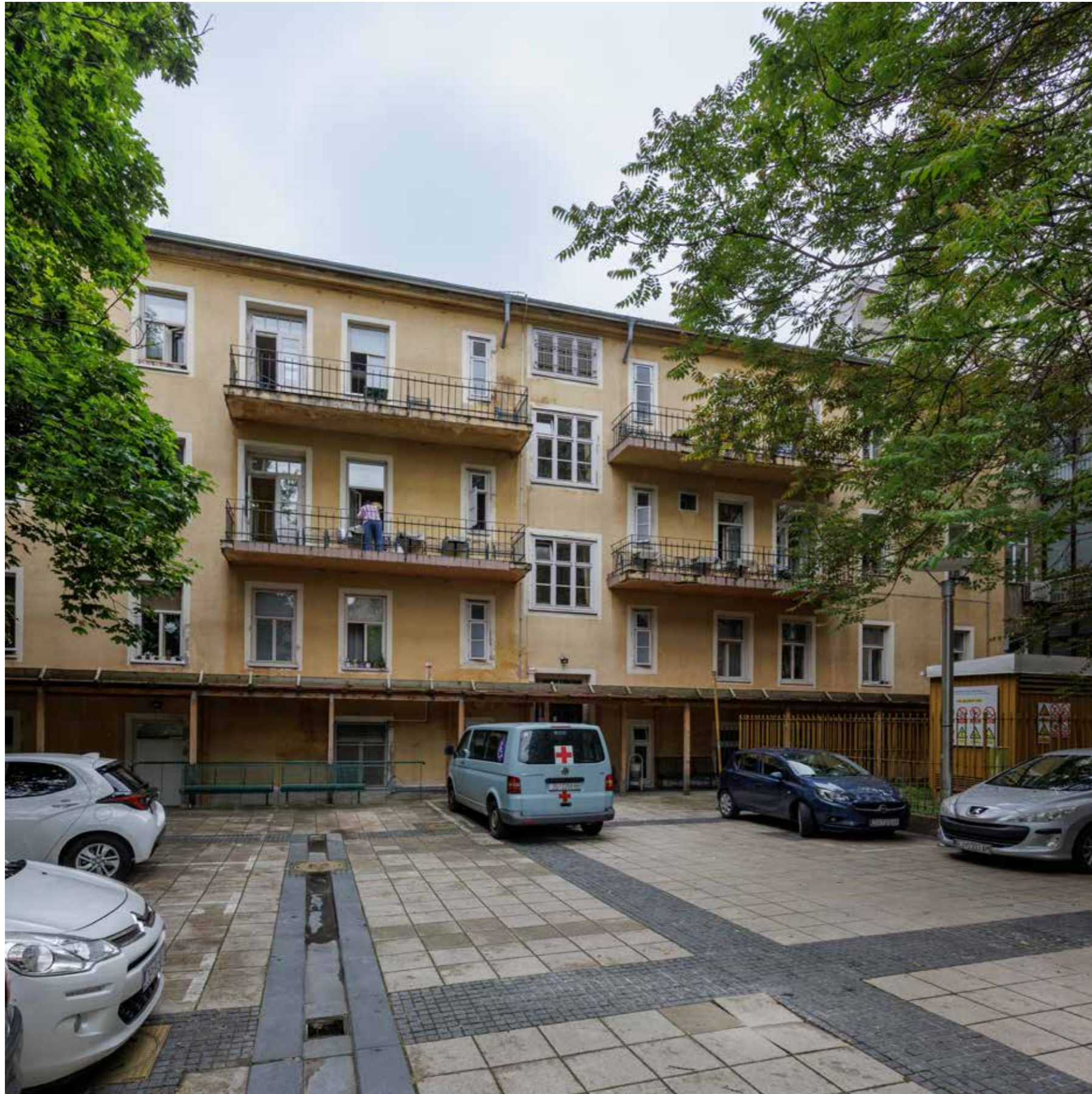
Sjeverno dvorišno pročelje s balkonima
