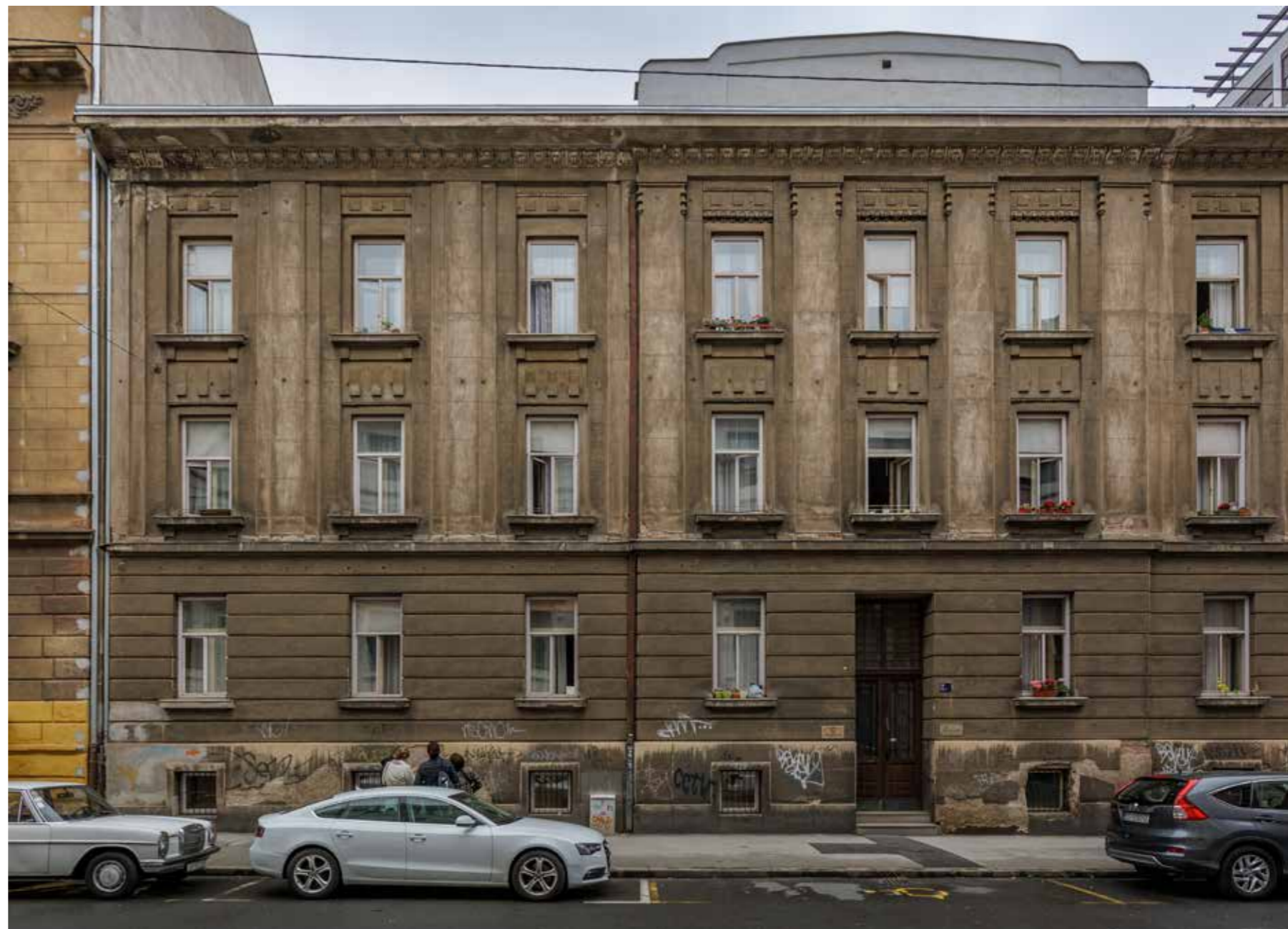
Južno ulično pročelje
