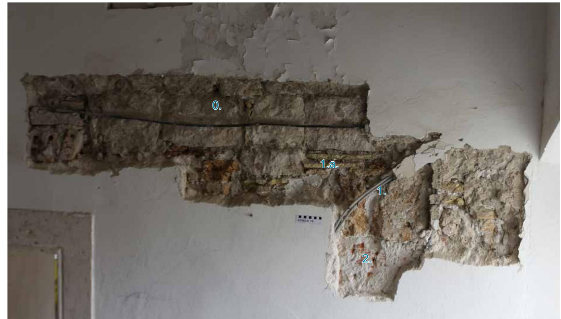
Sonda 16 otvorena je na zapadnom zidu hodnika zapadnog krila samostana (prostorija 2). Sondom većih dimenzija istražena je građa zida između zatečenog okvira vrata koja vode u susjednu prostoriju 4 i prozora na sjevernom zidu. Pronađena je raznovrsna opečna i kamena građa koja upućuje na veći broj preinaka i građevinskih zahvata sjevernog dijela zapadnog zida hodnika.
