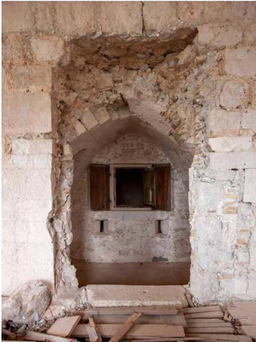
Zazidani otvor polukata s puškarnicama prema predvorju
