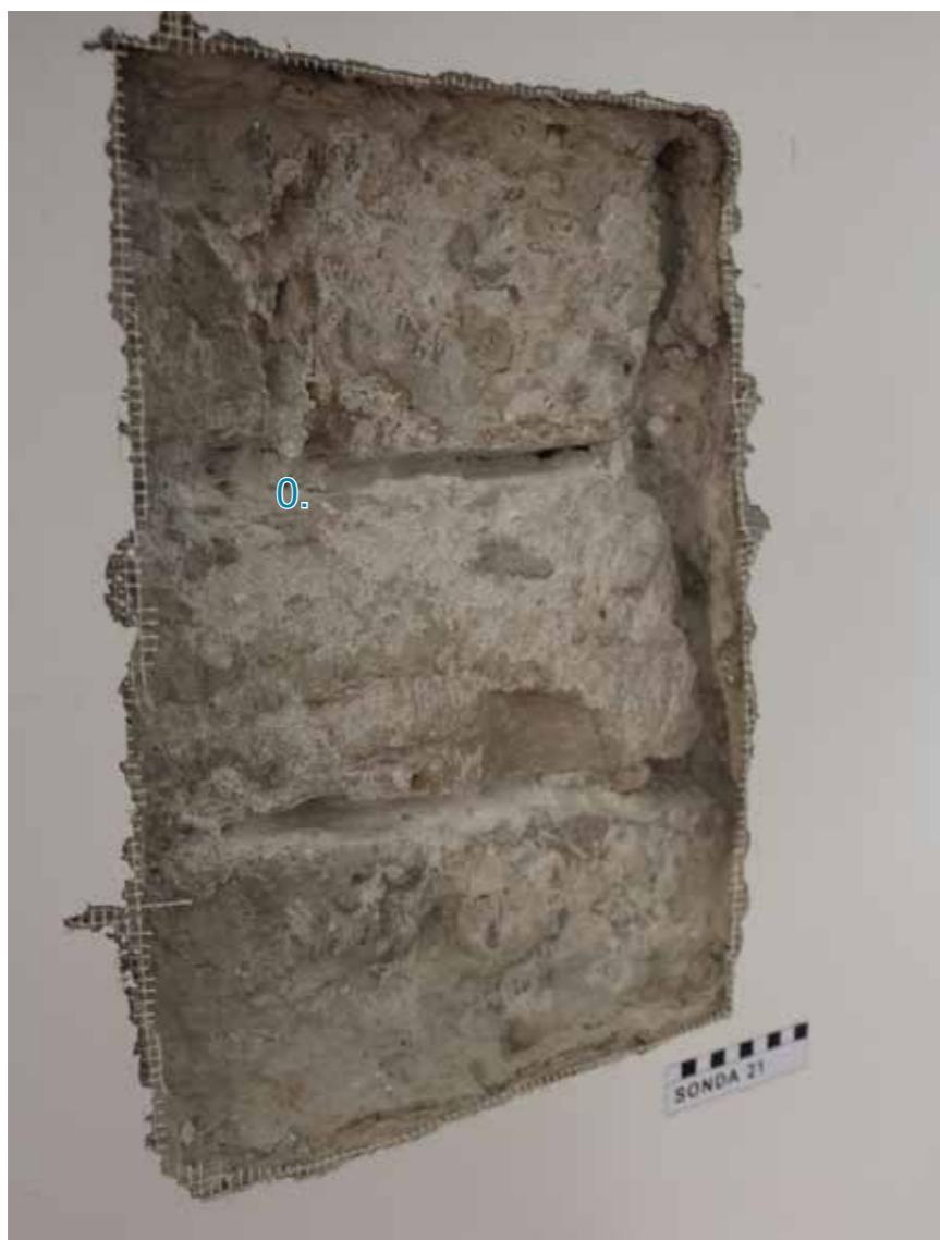
Sonda 21 otvorena je između prve i druge niše prozora na južnom zidu prostorije 8 u prizemlju. Izvedena je u svrhu istraživanja južnog dijela zapadnog krila samostana, s pretpostavkom da se trijem klaustra nastavlja do današnjega vanjskog zida južnog krila samostana.
