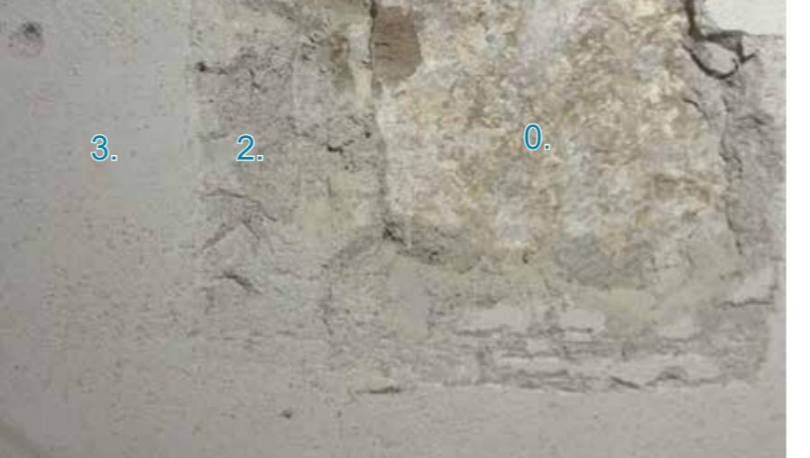
Sonda 10 otvorena je na istočnom zidu jugozapadne prostorije kata južnog krila samostana (prostorija 5). U sondi je pronađena kamena građa izvedena masivnim klesanicima grublje završne obrade i različitoga mineralnog podrijetla. Na površini je nalič vapnenog sastava bijele boje, a mjestimično su vidljivi tragovi patine nastali izravnim dje-lovanjem atmosferilija, što je karakteristično za pročelne zidove.
