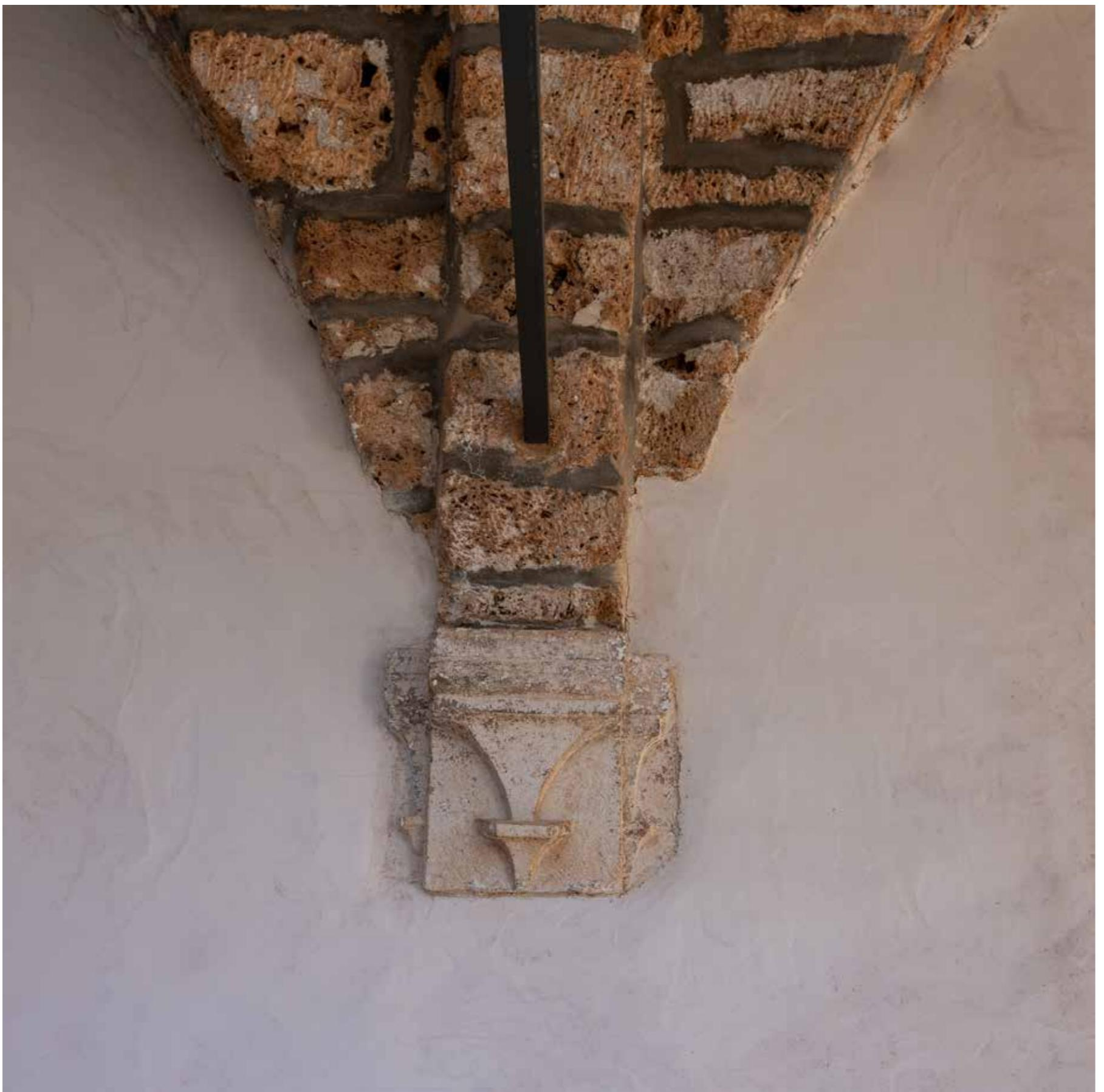
Debeo nanos cementne žbuke uz konzolu svoda u trijemu zapadnog krila i tamne cementne fuge
