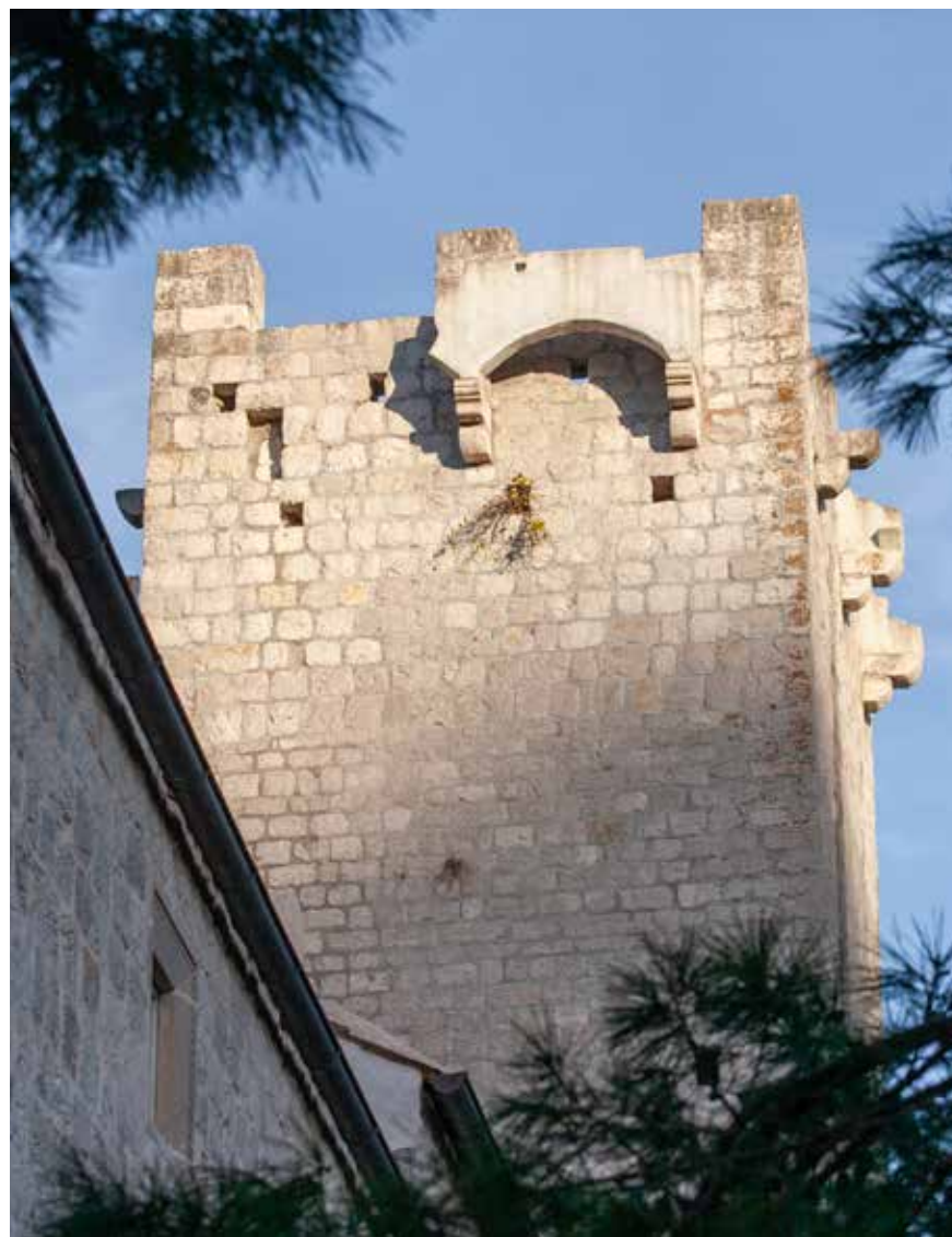
Jugoistočna kula, ostatci obrambenog kruništa (breteše)
