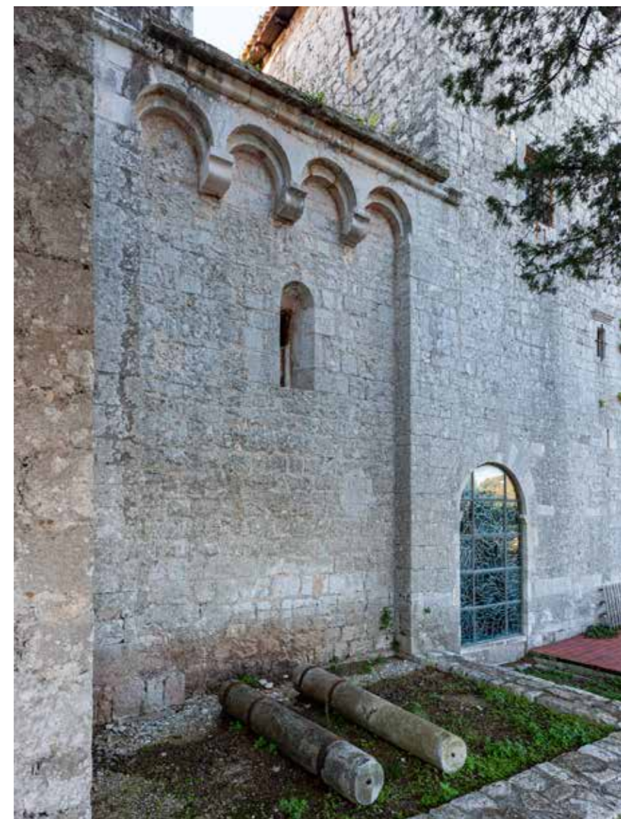
Sjeverno pročelje ulaznog prostora crkve
