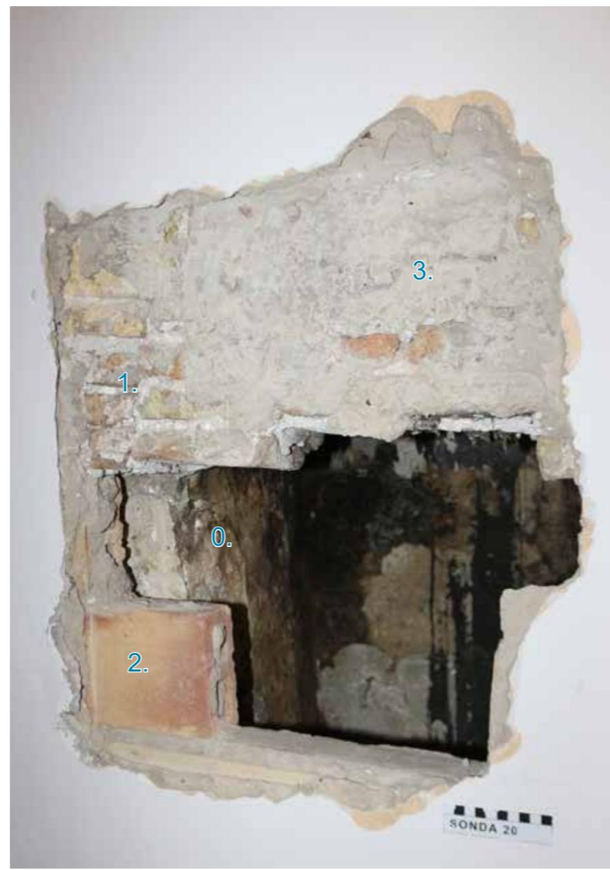
Sonda 20 otvorena je na istočnom zidu prostorije 8 u prizemlju. Izvedena je radi istraživanja kamenoga klesanog elementa lunete, vidljive na zapadnom zidu trijema.
