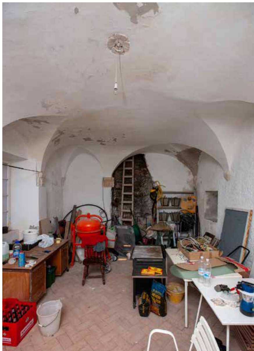
Južno krilo, nadsvođena prostorija u prizemlju
