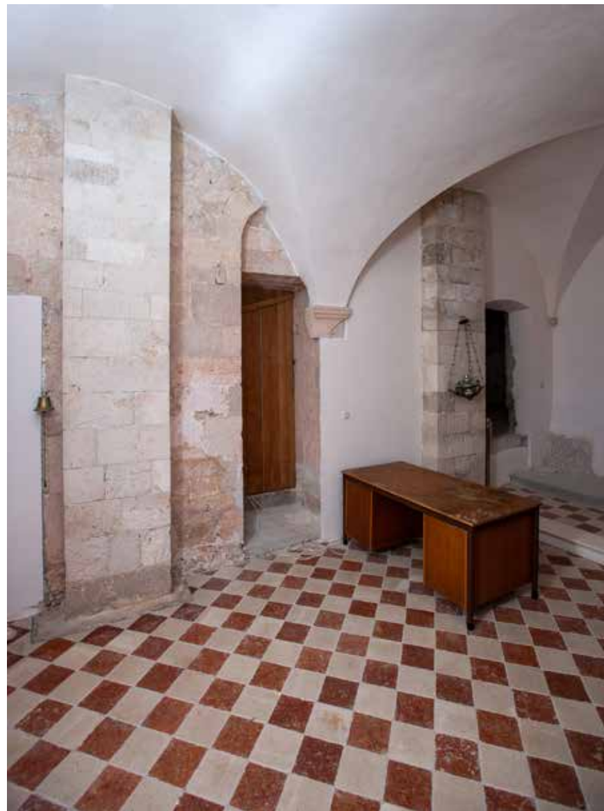
Sakristija, pogled na južno pročelje crkve
