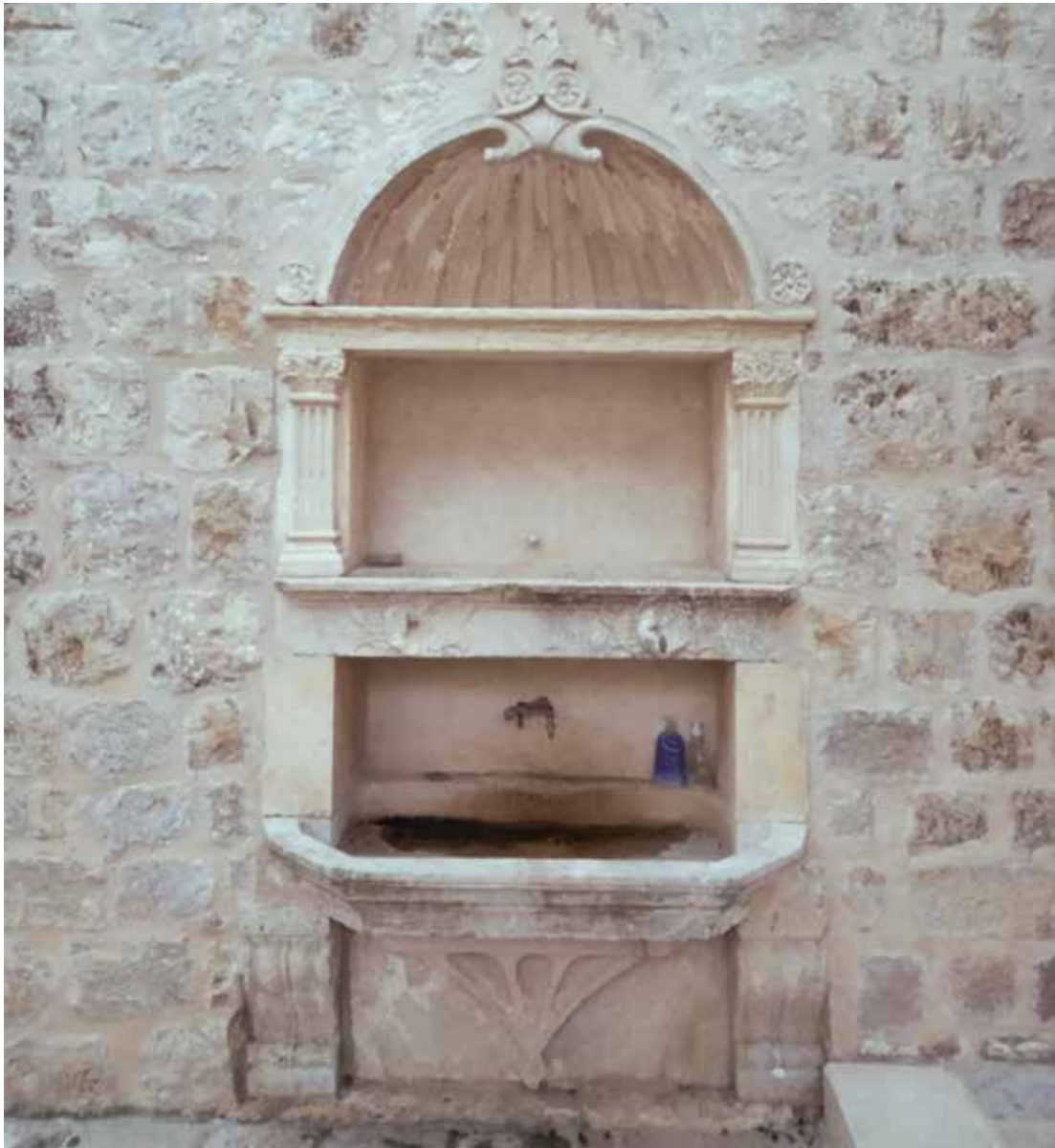
Južno krilo, sjeverno pročelje, naknadno ugrađeno pilo
