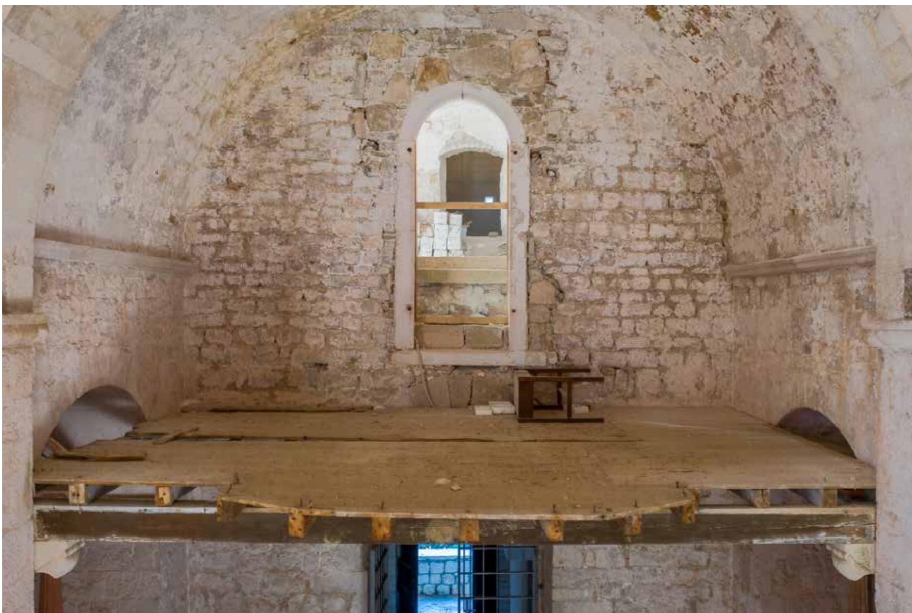
Pjevalište, stanje tijekom restauracije ograde
