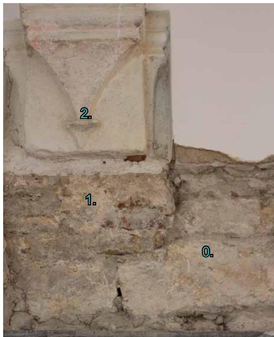
Dekorativni element konzole u impostu izведен je u kamenu, monolitno s plintom. Element je najvjerojatnije ugrađen u stariji zid, budući da su na spoju pronađene tavele izvedene skošeno u tri reda.
