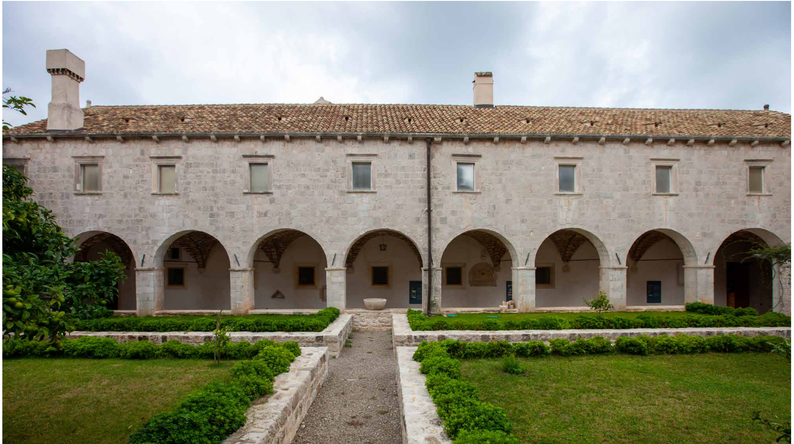
Zapadno krilo, istočno pročelje
