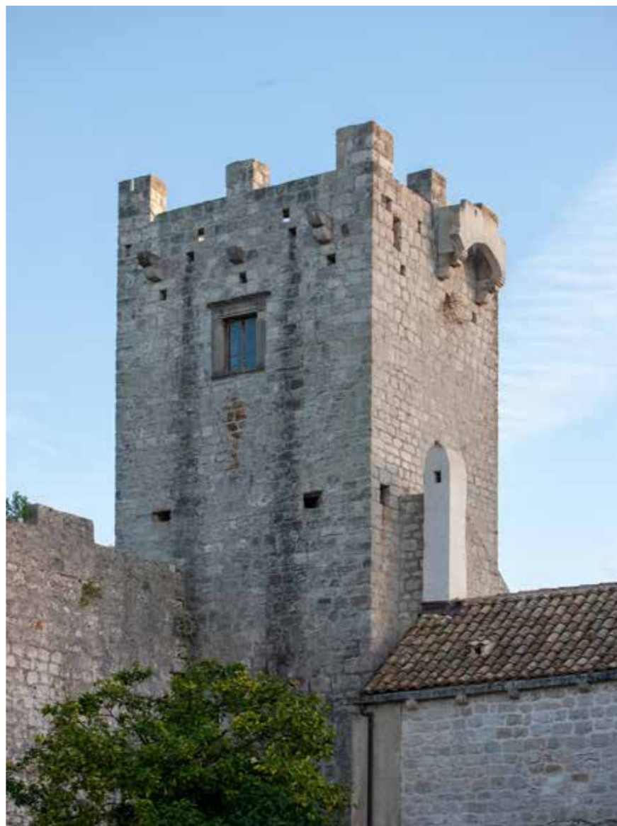
Jugoistočna kula, sjeverno i zapadno pročelje
