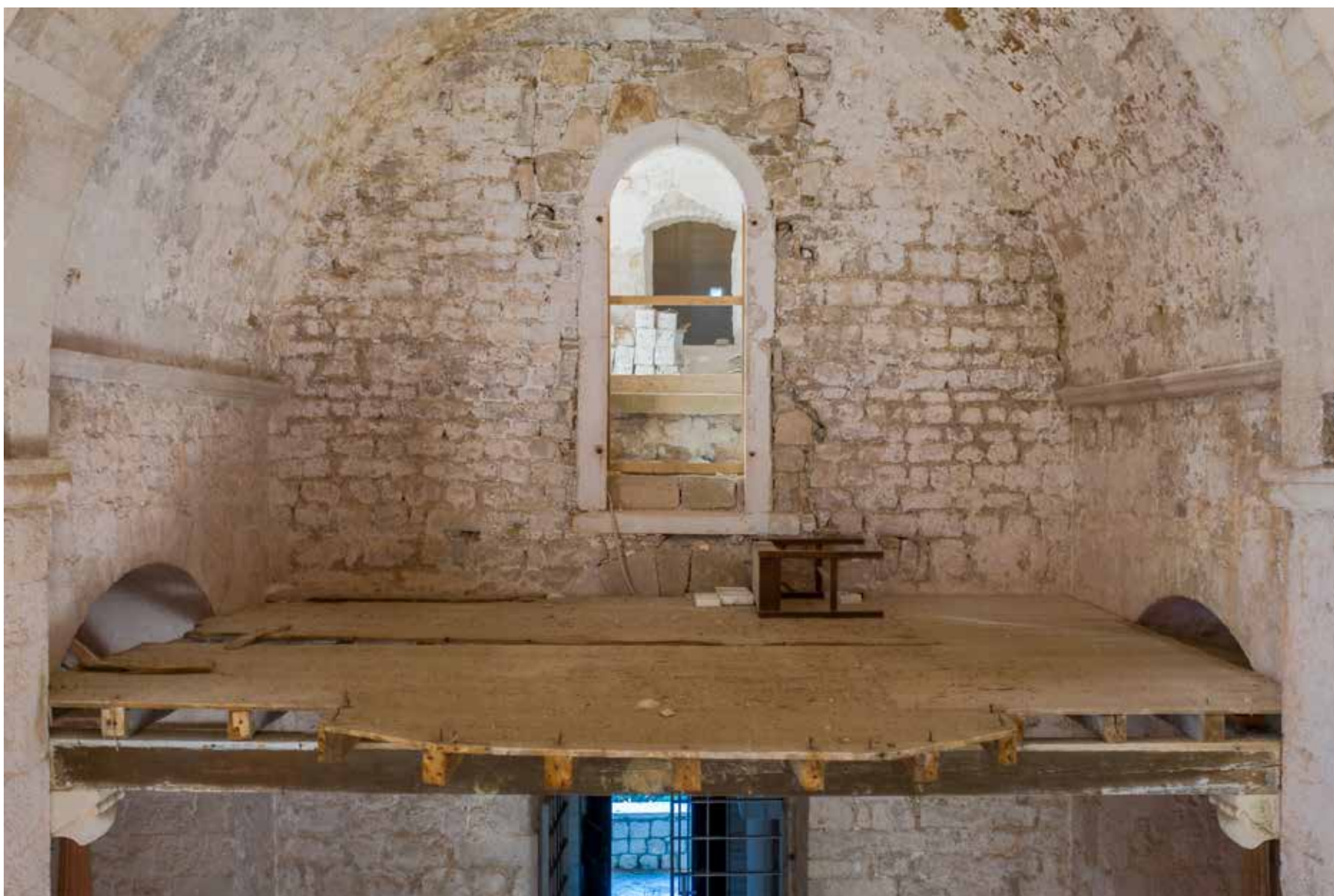
Pjevalište, stanje tijekom restauracije ograde
