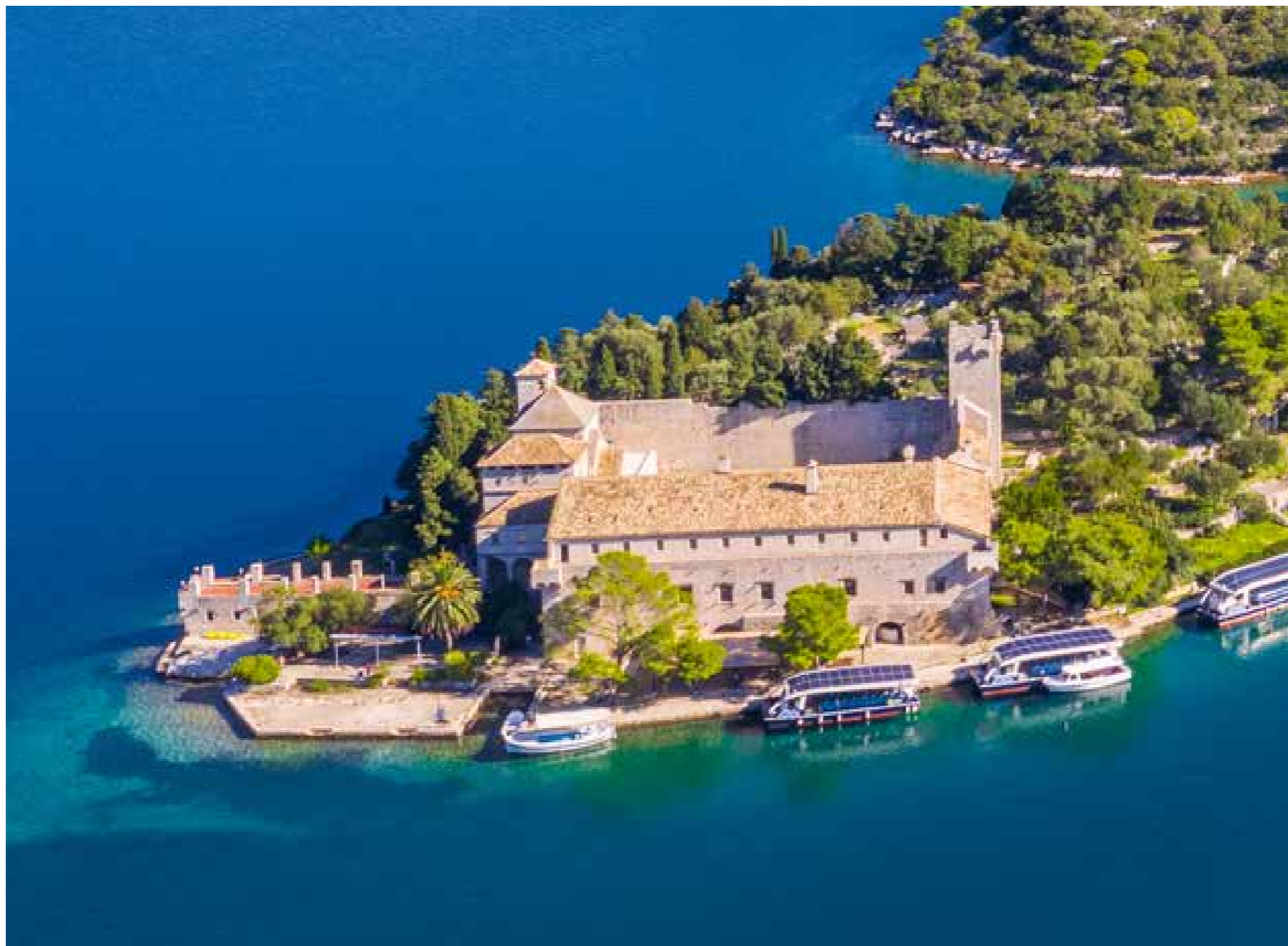
Zapadno krilo s terasom i ugaonim bretešama
