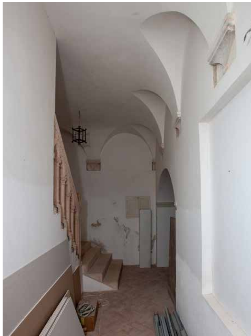
Svodovi uz stubište, detalji
