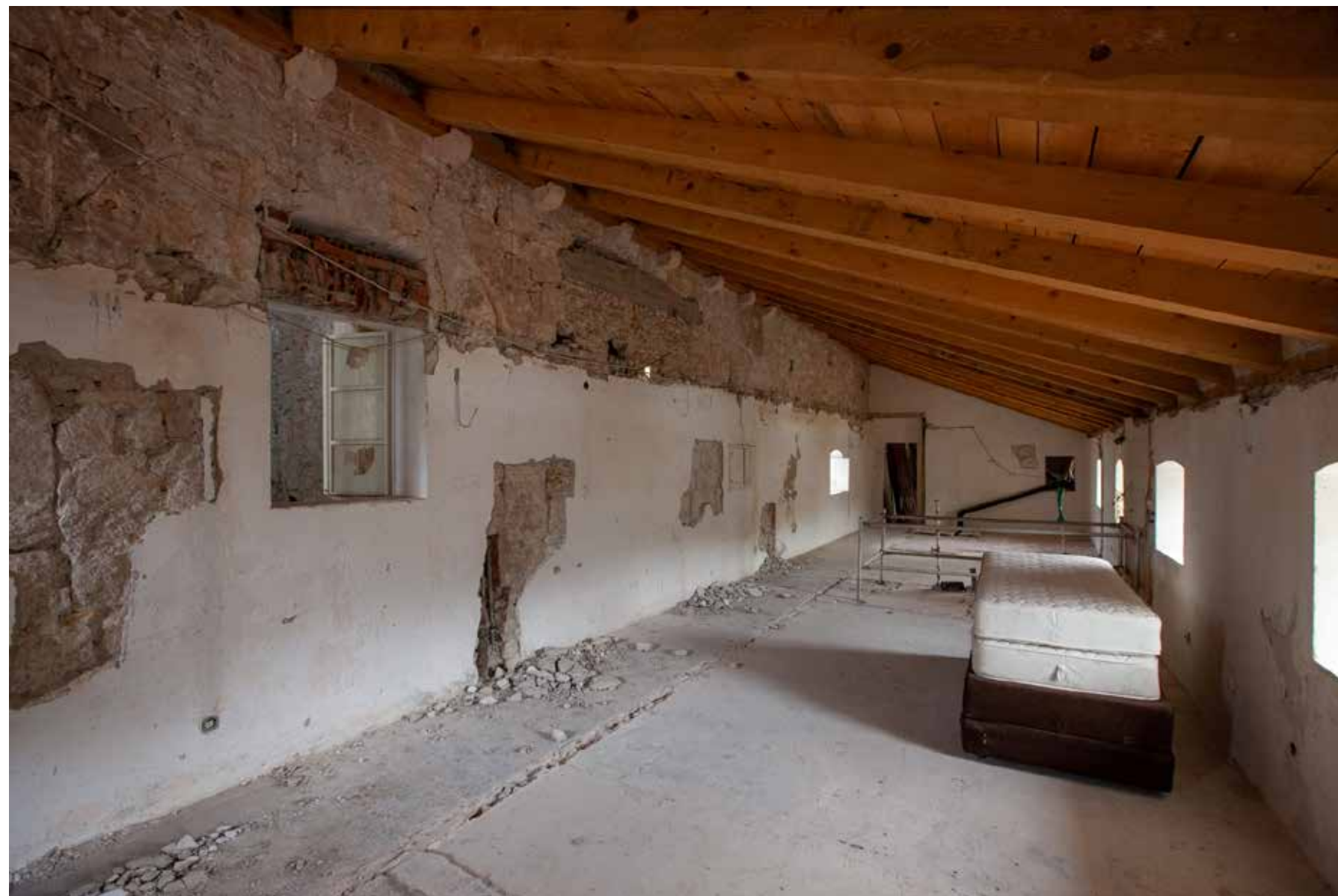
Natkriveni prostor pretpostavljene terase
